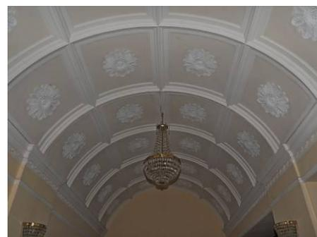
профилированные тяги и лепной фриз с порезкой в виде бегущей волны в верхней части стен по периметру помещения;
