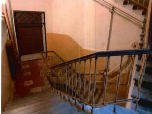
26-27. Лестничная клетка 2ЛК (17.11.2021).
