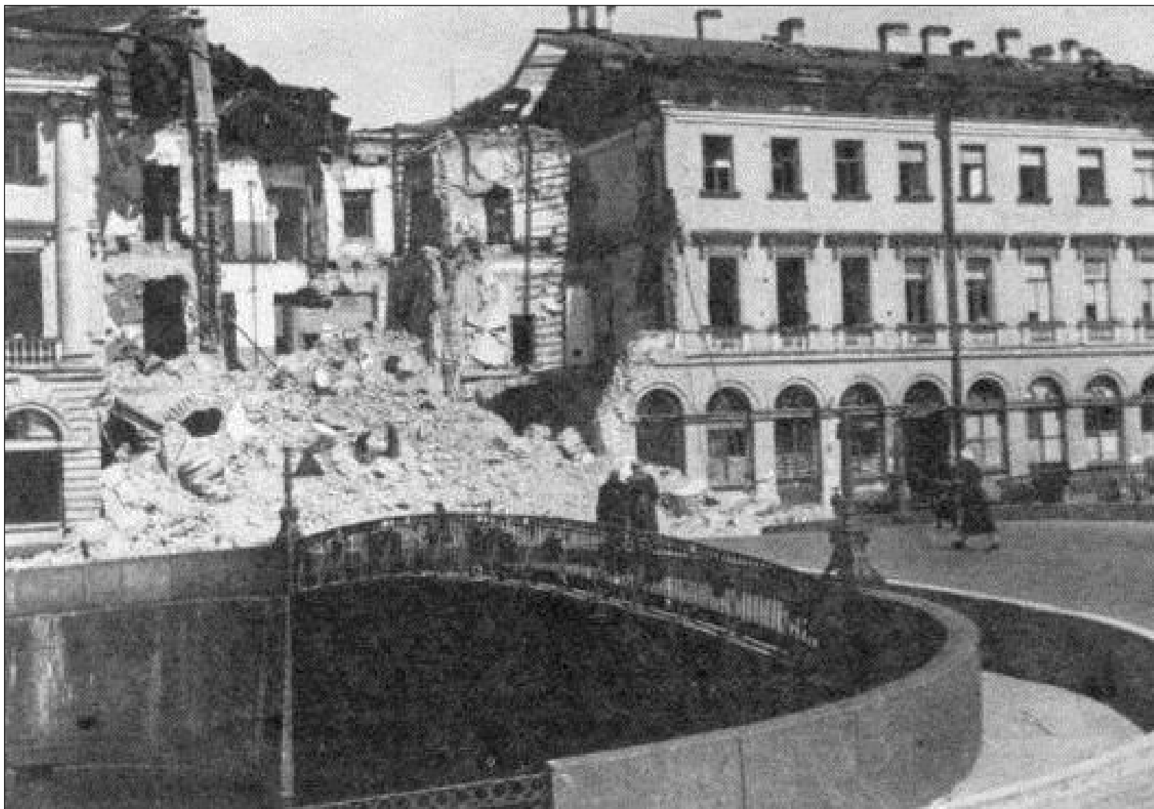
30. Разрушение «Дома Адамини». Фото. Ноябрь 1941 года. ЦГАКФФД.
