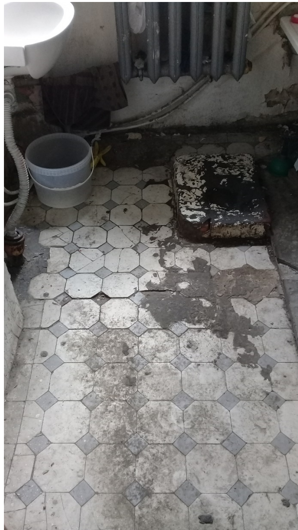
Фото 19. Метлахская напольная плитка в помещении ванной № 8.
