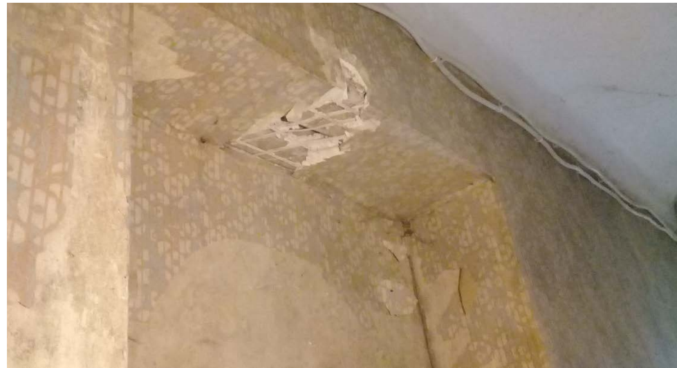
Фото 16. Ниша в помещении коридора № 7.
