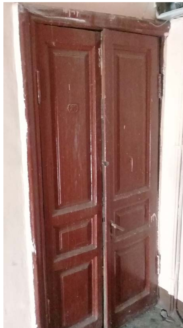
Фото 30. Филенчатое заполнение дверного проема. Вид с черной лестницы Л2.
