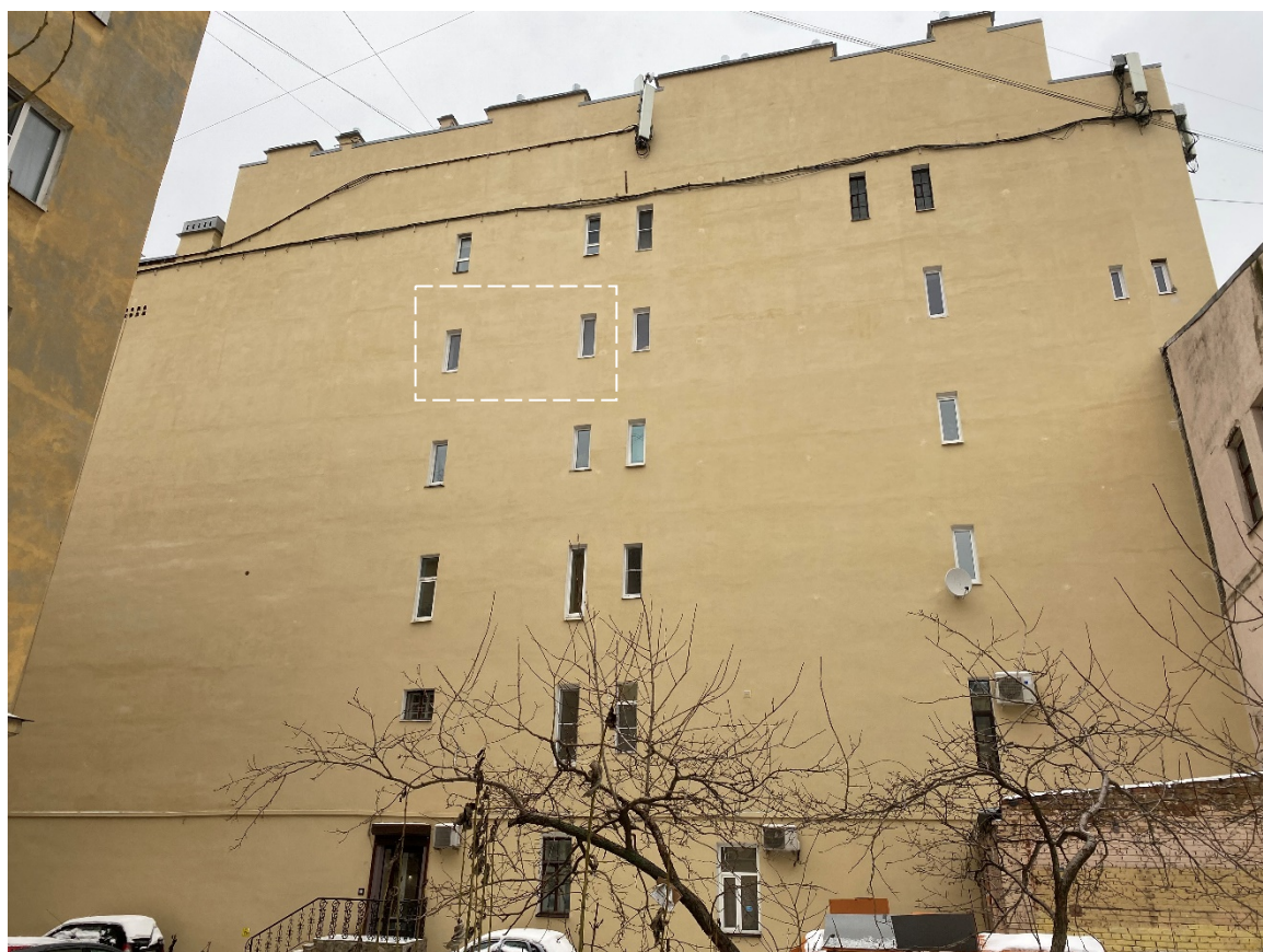
Фото 6. Фрагмент южного торцевого фасада с обозначением оконных проемов квартиры № 20 в уровне 5-го этажа.
