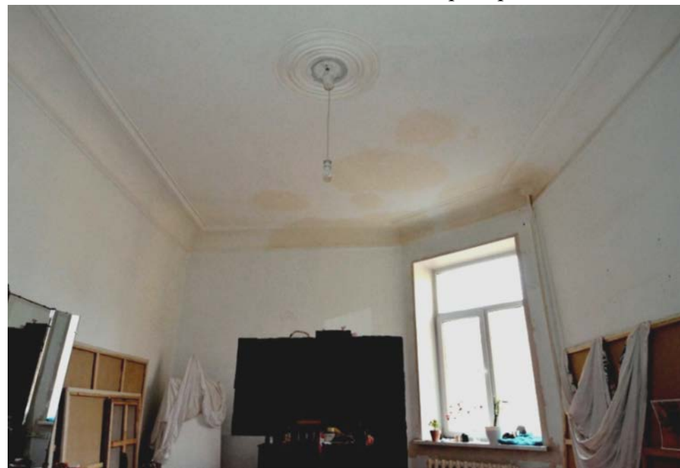
Фото 17. Помещение комнаты № 5 (по техпаспорту).
