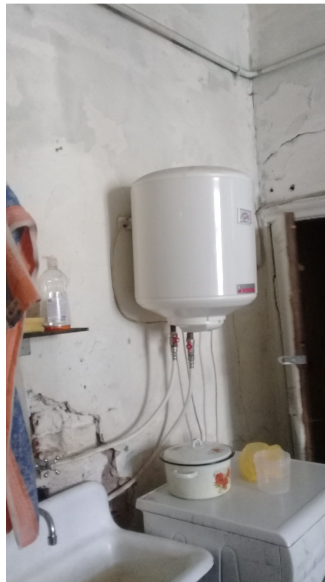
Фото 28. Фрагмент помещения кухни № 12.
