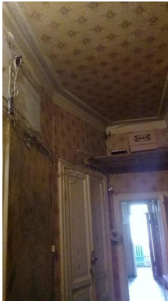
Фото 10. Общий вид помещения коридора № 1 (по техпаспорту).
