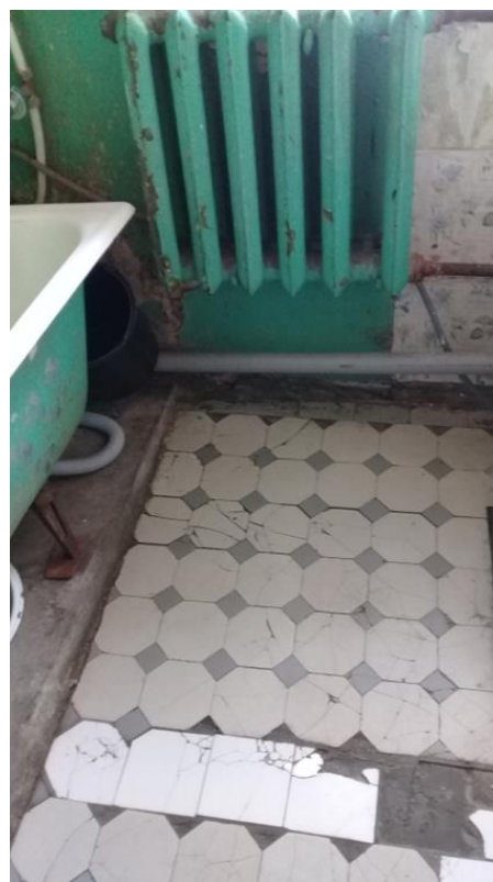
Фото 21. Напольное покрытие из метлахской плитки в ванной № 6.
