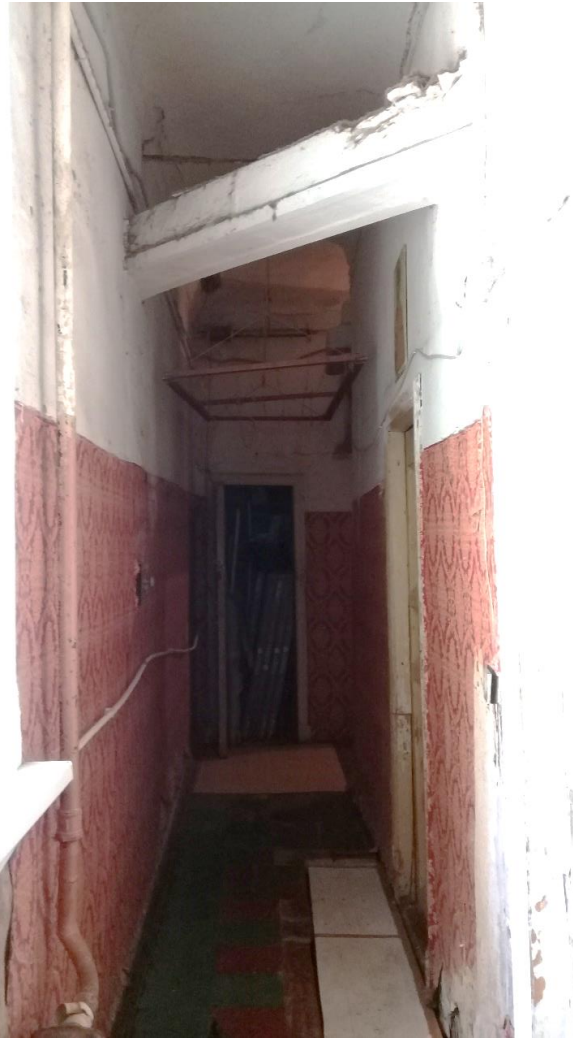
Фото 26. Фрагмент помещения коридора № 5 (на полу участка вскрытий).
