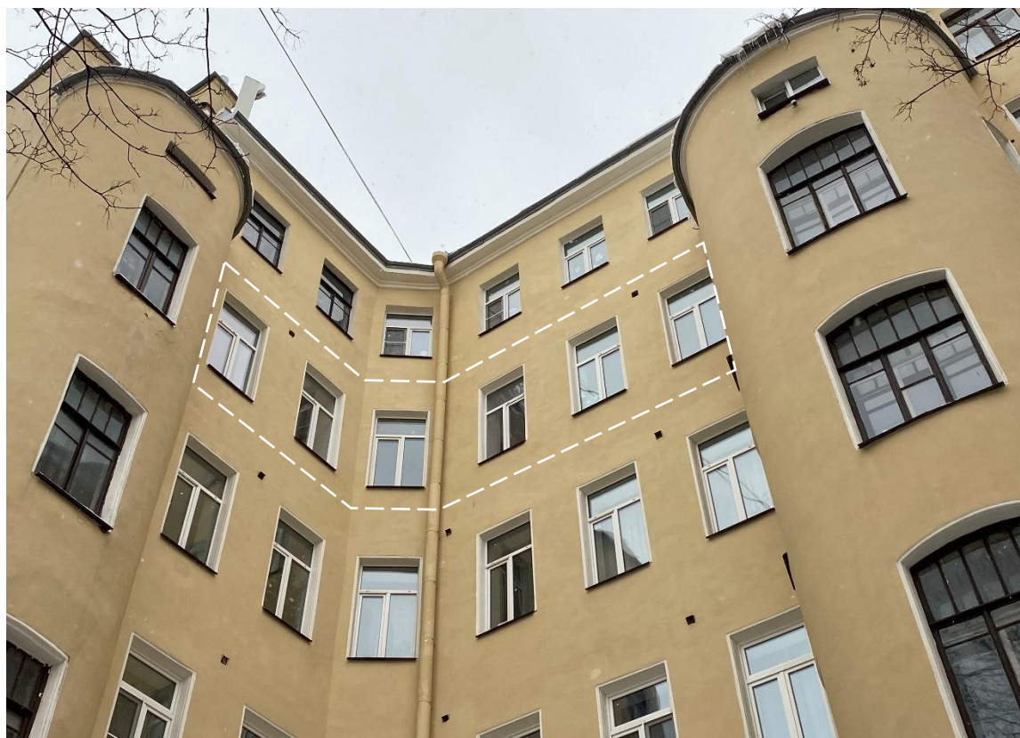
Фото 6. Фрагмент дворового корпуса с обозначением оконных проемов в уровне 5-го этажа, в границах квартиры № 30. Вид с северо-востока.
