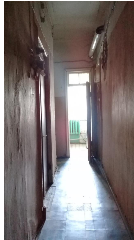
Фото 11. Общий вид помещения коридора № 5 (по техпаспорту).
