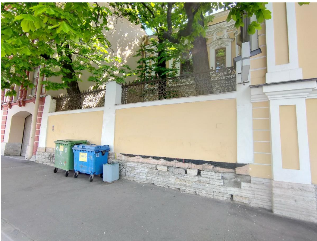
3. «Ограда с воротами», входящие в состав объекта культурного наследия федерального значения «Дом Дубяньских (Зиновьева Н.В., Карловой Н.Ф.), наб. р. Фонтанки, д.46. Общий вид с запада. Фото 15.05.2023г.
