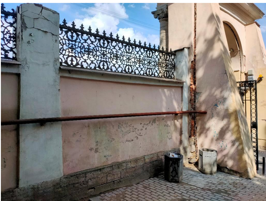
6. «Ограда с воротами», входящие в состав объекта культурного наследия федерального значения «Дом Дубянских (Зиновьева Н.В., Карловой Н.Ф.), наб. р. Фонтанки, д.46. Восточная часть ограды. Фрагмент. Фото 15.05.2023г.
