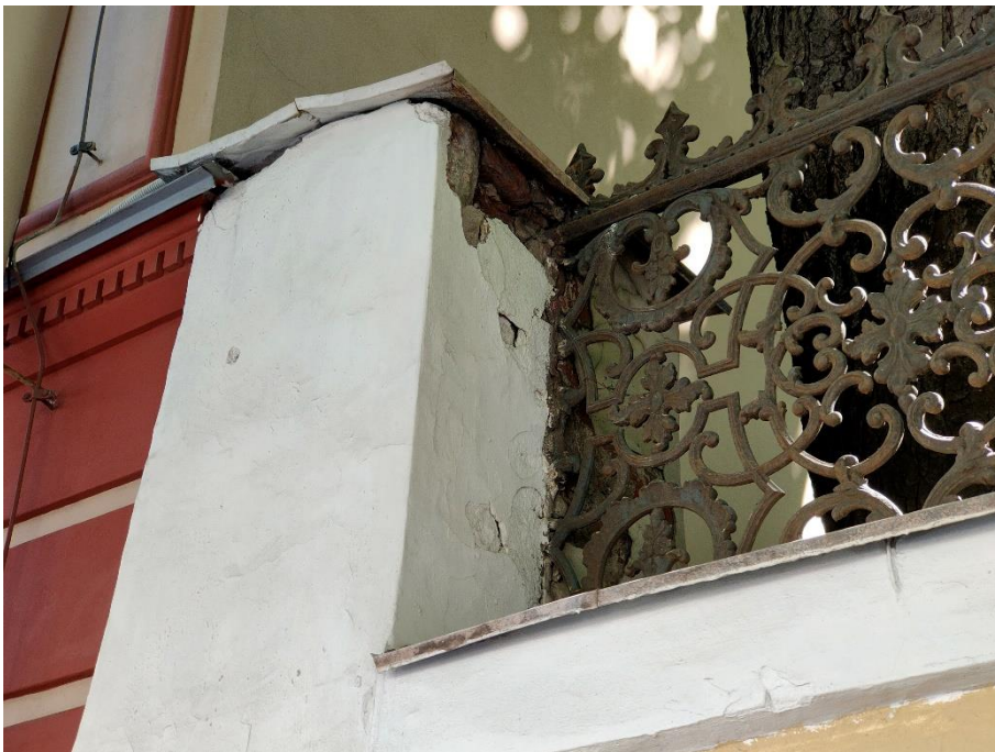
22. «Ограда с воротами», входящие в состав объекта культурного наследия федерального значения «Дом Дубяньских (Зиновьева Н.В., Карловой Н.Ф.), наб. р. Фонтанки, д.46. Западная часть ограды. Фрагмент. Фото 15.05.2023г.
