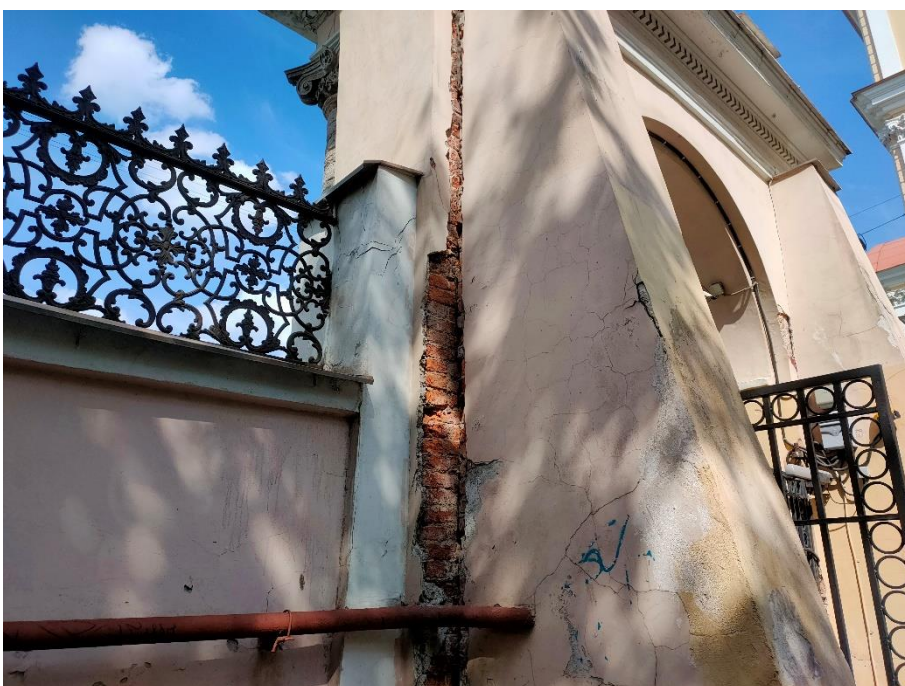
8. «Ограда с воротами», входящие в состав объекта культурного наследия федерального значения «Дом Дубянских (Зиновьева Н.В., Карловой Н.Ф.)», наб. р. Фонтанки, д.46. Восточная часть ограды. Фрагмент. Фото 15.05.2023г.
