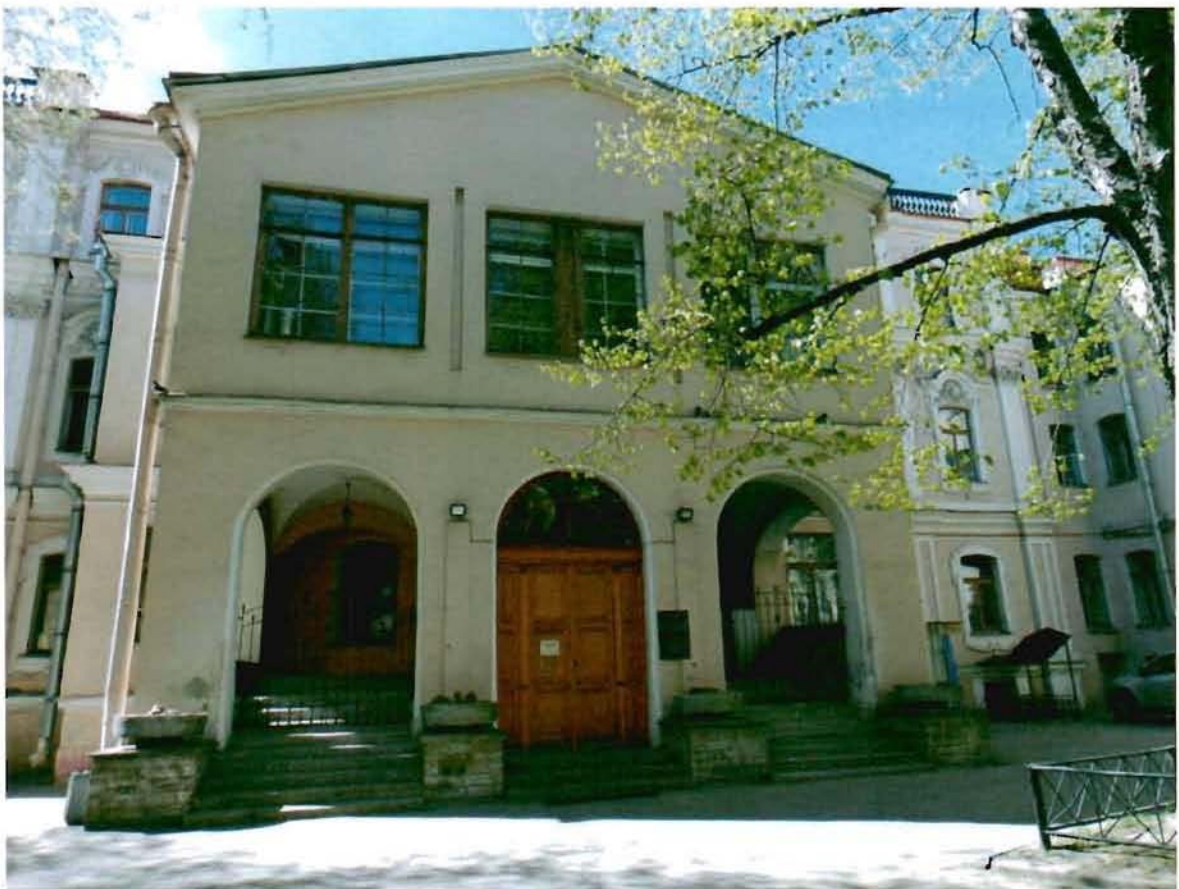
4. Юго-восточный дворовый фасад
