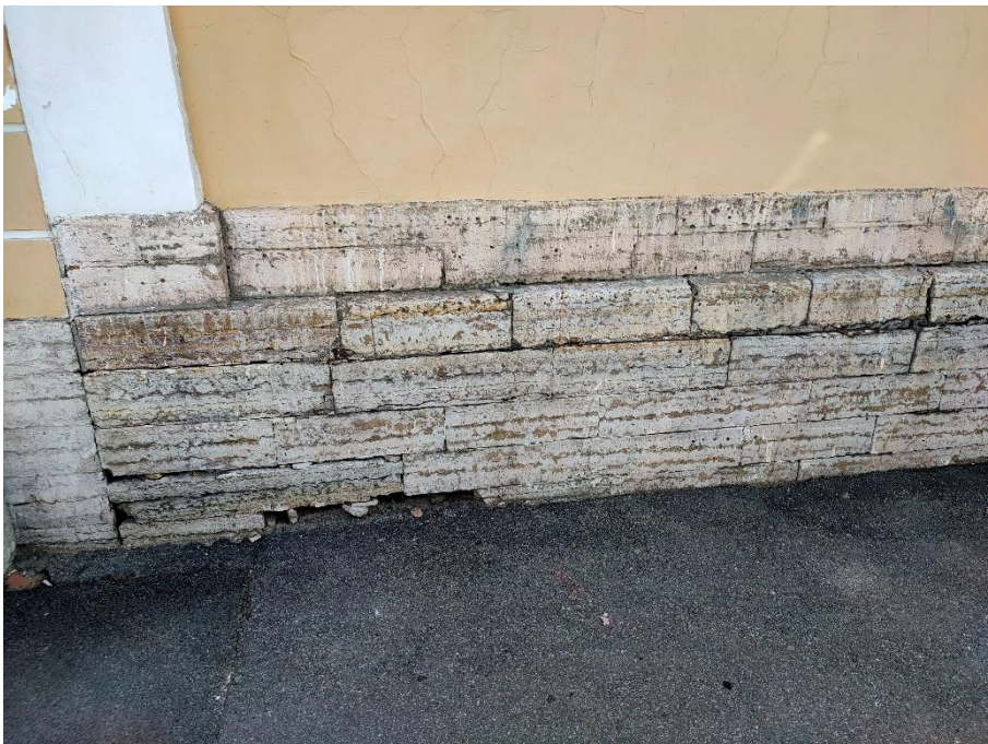
26. «Ограда с воротами», входящие в состав объекта культурного наследия федерального значения «Дом Дубяньских (Зиновьева Н.В., Карловой Н.Ф.)», наб. р. Фонтанки, д.46. Западная часть ограды. Фрагмент. Фото 15.05.2023г.
