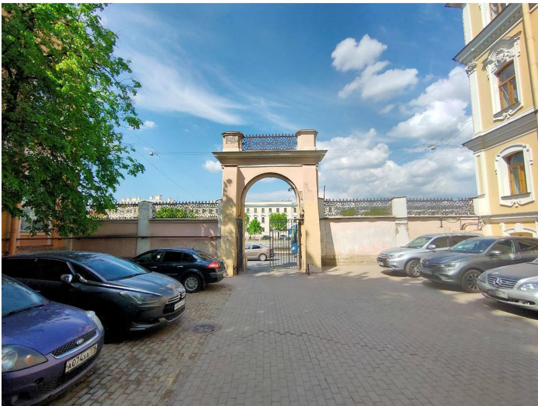
2. «Ограда с воротами», входящие в состав объекта культурного наследия федерального значения «Дом Дубяньских (Зиновьева Н.В., Карловой Н.Ф.), наб. р. Фонтанки, д.46. Общий вид с востока. Фото 15.05.2023г.
