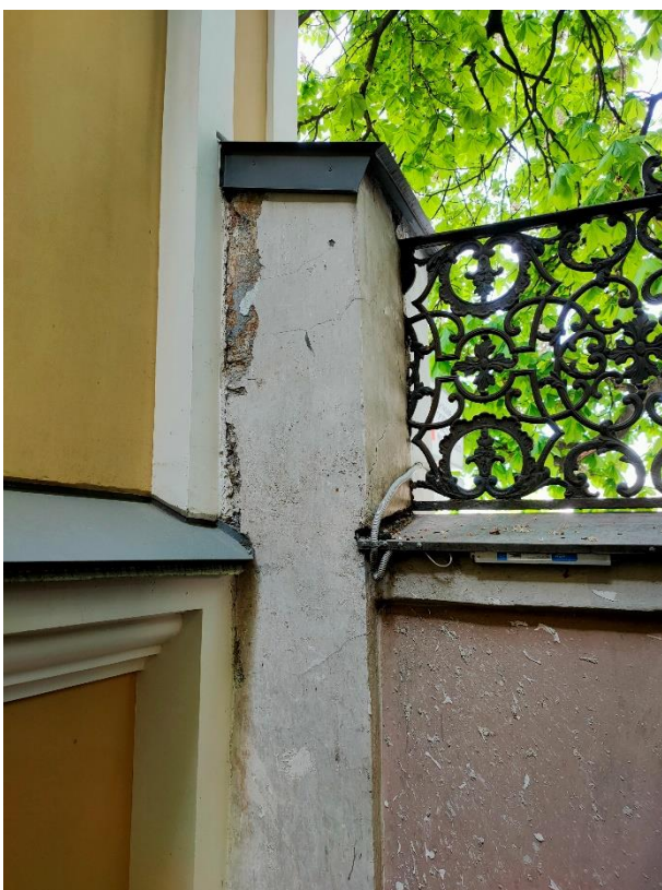
20. «Ограда с воротами», входящие в состав объекта культурного наследия федерального значения «Дом Дубяньских (Зиновьева Н.В., Карловой Н.Ф.), наб. р. Фонтанки, д.46. Восточная часть ограды. Фрагмент. Фото 15.05.2023г.
