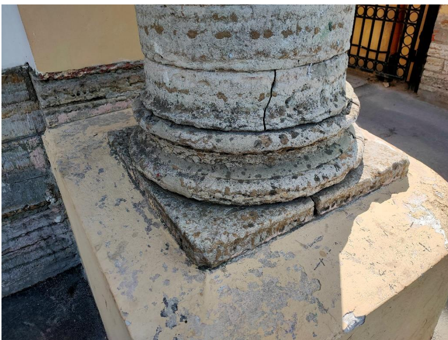
28. «Ограда с воротами», входящие в состав объекта культурного наследия федерального значения «Дом Дубяньских (Зиновьева Н.В., Карловой Н.Ф.), наб. р. Фонтанки, д.46. Западная часть ограды. Фрагмент. Фото 15.05.2023г.
