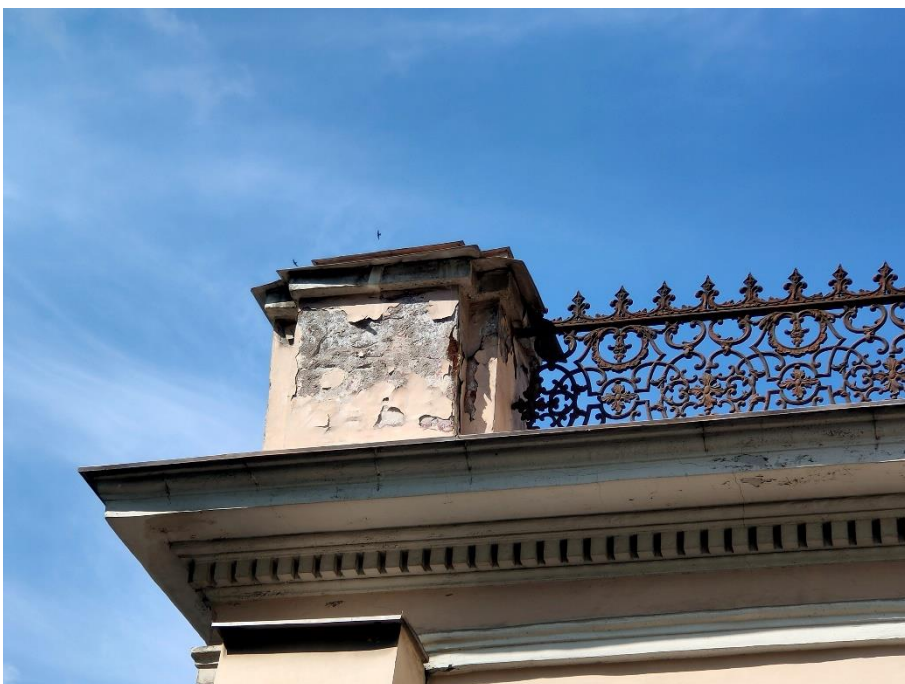
11. «Ограда с воротами», входящие в состав объекта культурного наследия федерального значения «Дом Дубяньских (Зиновьева Н.В., Карловой Н.Ф.), наб. р. Фонтанки, д.46. Восточная часть ограды. Фрагмент. Фото 15.05.2023г.
