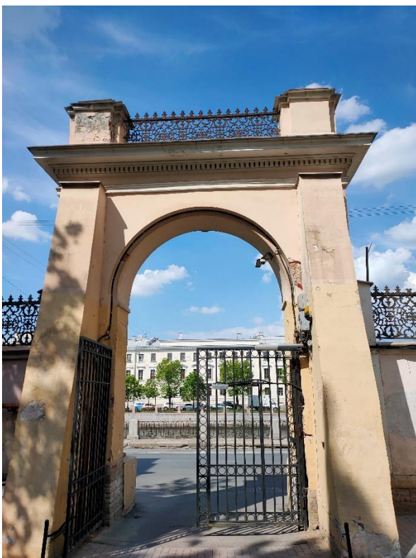
9. «Ограда с воротами», входящие в состав объекта культурного наследия федерального значения «Дом Дубяньских (Зиновьева Н.В., Карловой Н.Ф.), наб. р. Фонтанки, д.46. Восточная часть ограды. Фрагмент. Фото 15.05.2023г.
