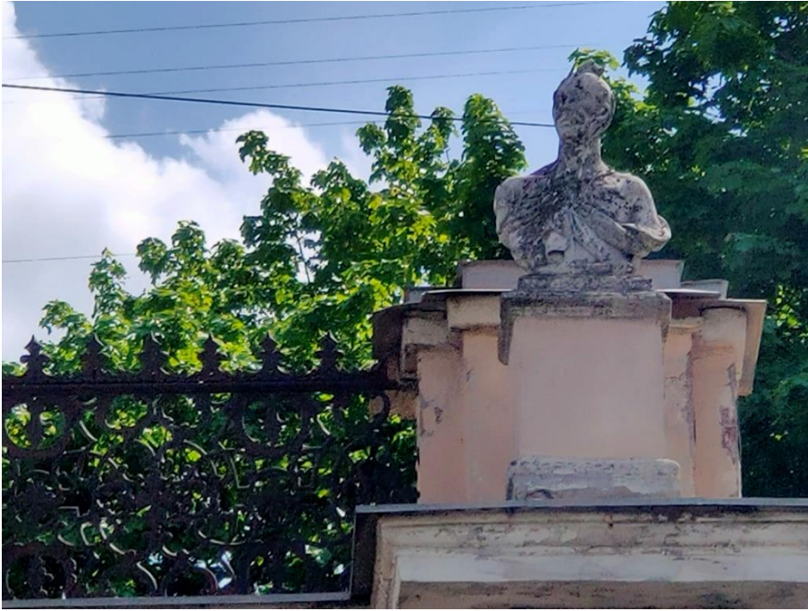
35. «Ограда с воротами», входящие в состав объекта культурного наследия федерального значения «Дом Дубянских (Зиновьева Н.В., Карловой Н.Ф.)», наб. р. Фонтанки, д.46. Западная часть ограды. Фрагмент. Фото 15.05.2023г.
