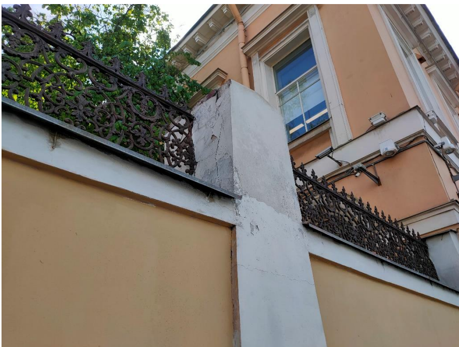
31. «Ограда с воротами», входящие в состав объекта культурного наследия федерального значения «Дом Дубянских (Зиновьева Н.В., Карловой Н.Ф.)», наб. р. Фонтанки, д.46. Западная часть ограды. Фрагмент. Фото 15.05.2023г.
