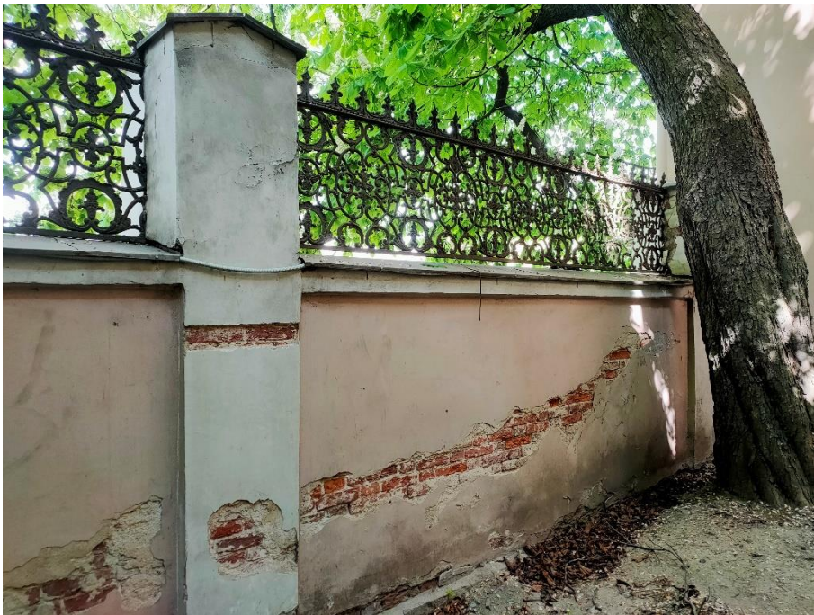
17. «Ограда с воротами», входящие в состав объекта культурного наследия федерального значения «Дом Дубяньских (Зиновьева Н.В., Карловой Н.Ф.), наб. р. Фонтанки, д.46. Восточная часть ограды. Фрагмент. Фото 15.05.2023г.
