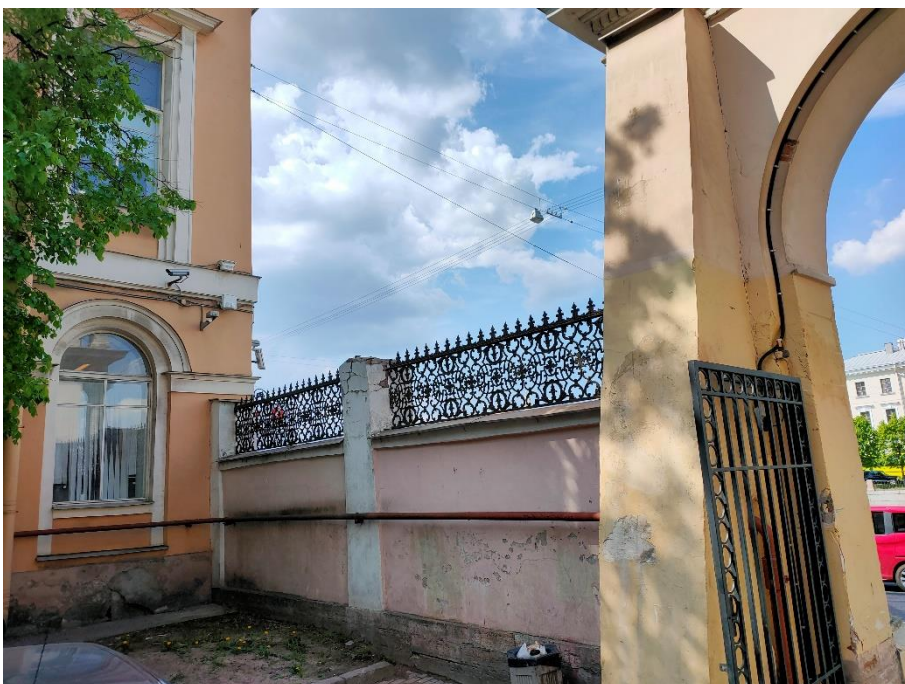
5. «Ограда с воротами», входящие в состав объекта культурного наследия федерального значения «Дом Дубянских (Зиновьева Н.В., Карловой Н.Ф.), наб. р. Фонтанки, д.46. Восточная часть ограды. Фрагмент. Фото 15.05.2023г.
