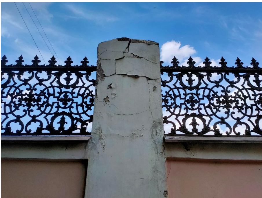
7. «Ограда с воротами», входящие в состав объекта культурного наследия федерального значения «Дом Дубянских (Зиновьева Н.В., Карловой Н.Ф.)», наб. р. Фонтанки, д.46. Восточная часть ограды. Фрагмент. Фото 15.05.2023г.
