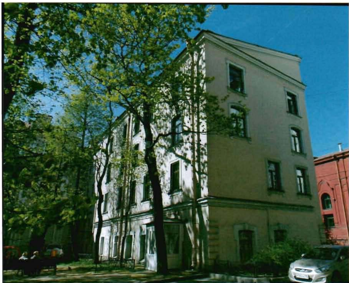
28. Дворовый флигель со стороны южного и восточного фасадов
