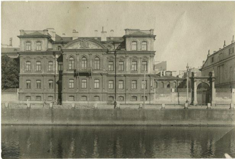
15. Вид на фасад дома б. гр. Карловой на Фонтанке, дом № 46. 1927 г. Фотография. Автор снимка: Л.Г. Андреевский. ГМИ СПб. КП -233635. Инв. № П-А-3611-ф.
