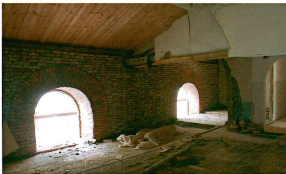
Фото №4. Помещение 2-го этажа.
