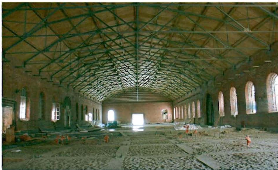
Фото №3. Помещение 1-го этажа.
