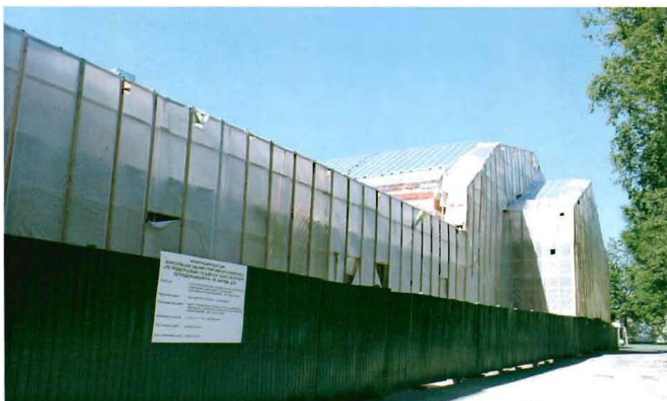
Фото №2 Северный фасад, вид со стороны северной части внутреннего двора.
