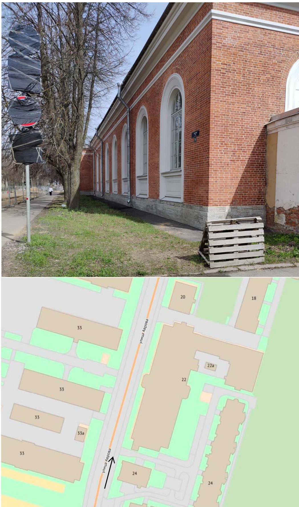
Фото 5. Вид на западный фасад здания с юго-западной стороны. Дата съемки 1.04.2023 г.
