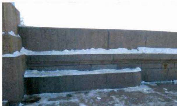
ступени лестниц из крупноразмерных профилированных гранитных блоков;
