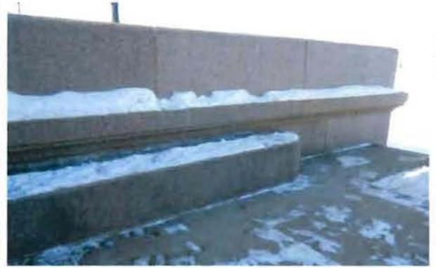
тетива лестниц из профилированных крупноразмерных блоков гранитных блоков;
