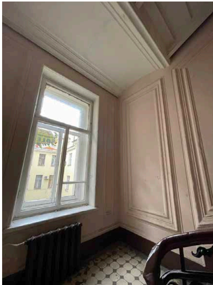
201. Общий вид оконного проема лестничной площадки между шестым и мансардным этажами.
