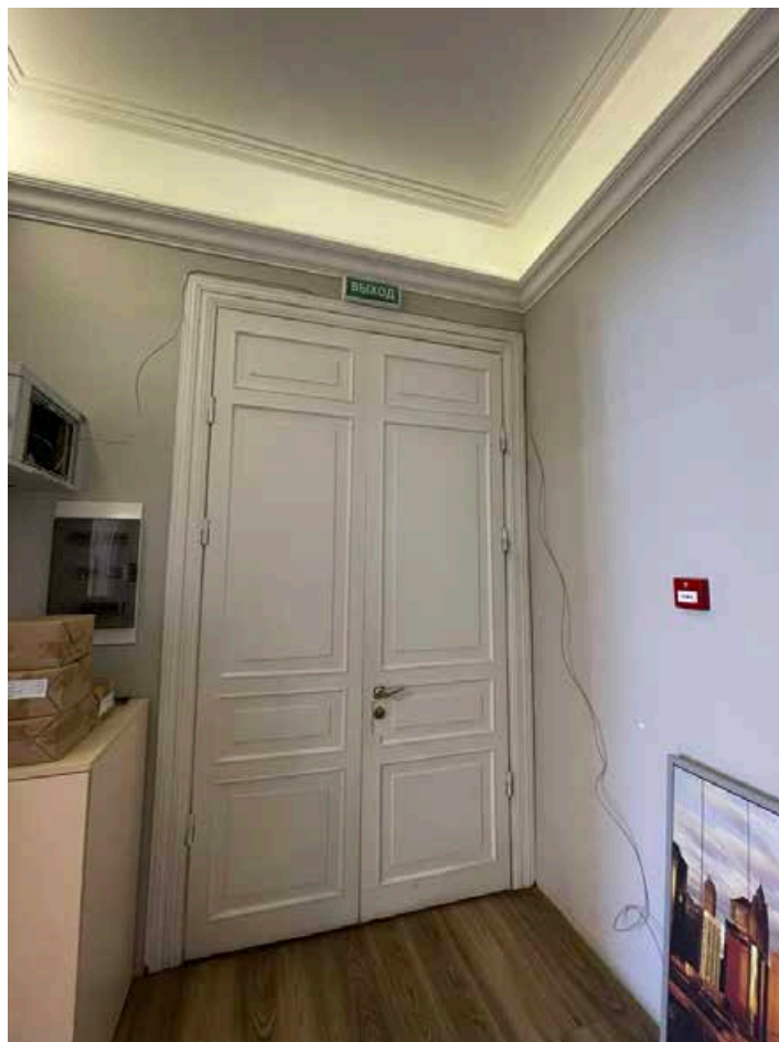
67. Дверной проем помещения 12-Н(1). Выход на лестничную площадку. Заполнение деревянное двустворчатое. Каждая створка делится на 4 филенки.
