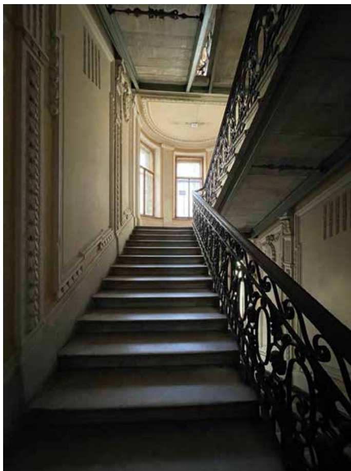
80. Общий вид лестничного марша с четвертого этажа на пятый.
