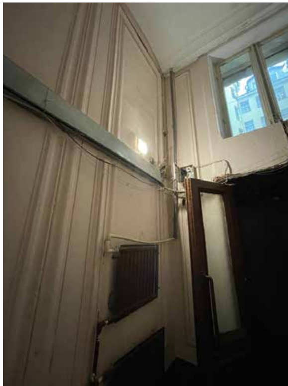
181. Оформление стен лестничной клетки профилированными панелями.
