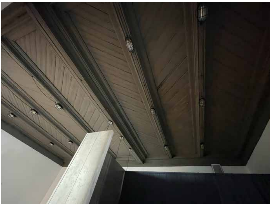
113. Плафон потолка помещения 23-Н(4): деревянный, поделенный деревянными профилированными балками на горизонтальные секции и обшитый вагонкой диагонально. Обшивка окрашена в коричневый цвет.
