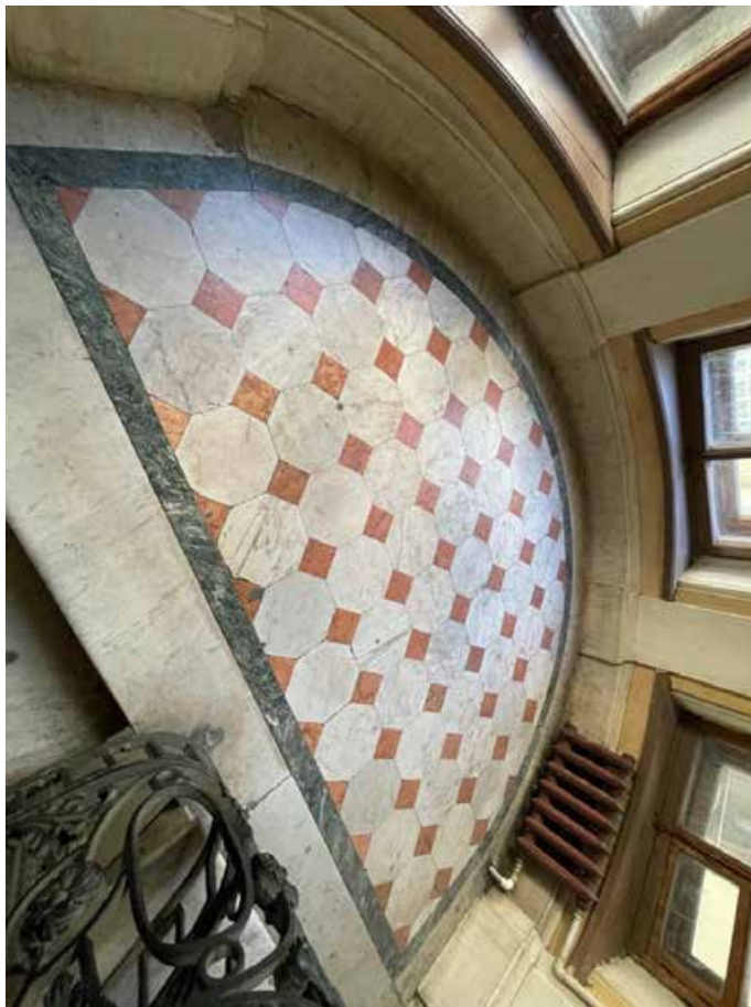
81. Оформление пола лестничной площадки между четвертым и пятым этажами аналогично оформлению лестничных площадок этажами ниже. Утраты напольного покрытия минимальные.
