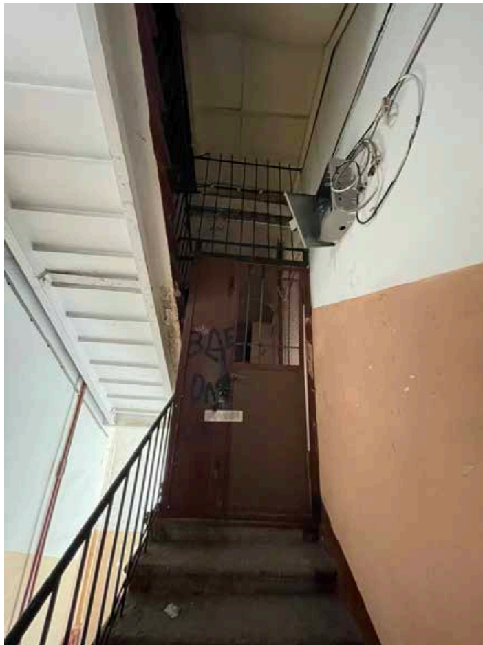
233. Общий вид лестничного пролета с мансардного этажа на крышу. Лестничная клетка западного фасада.
