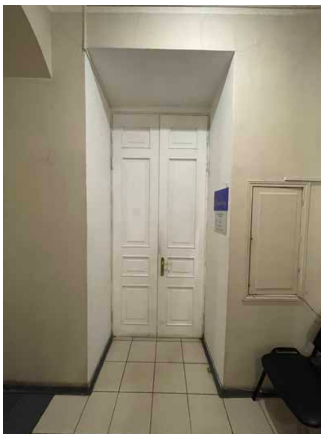
122. Дверной проем помещения 25(Н)-7. Заполнение деревянное двустворчатое, каждая створка поделена на 4 филенки.
