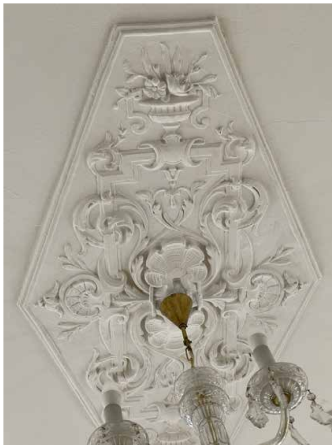
108. Розетка в центре потолка помещения 23-Н(8). Розетка шестиугольной формы с рокайльными и растительными мотивами.
