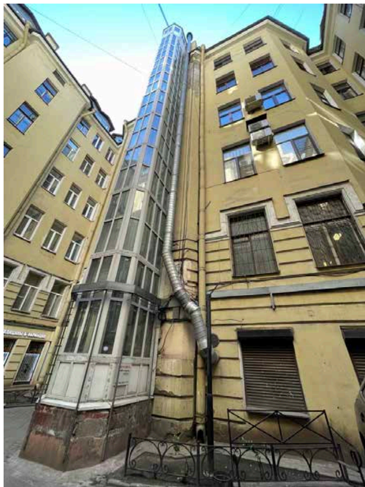
21. Общий вид западного фасада северного двора. Поздняя лифтовая шахта.
