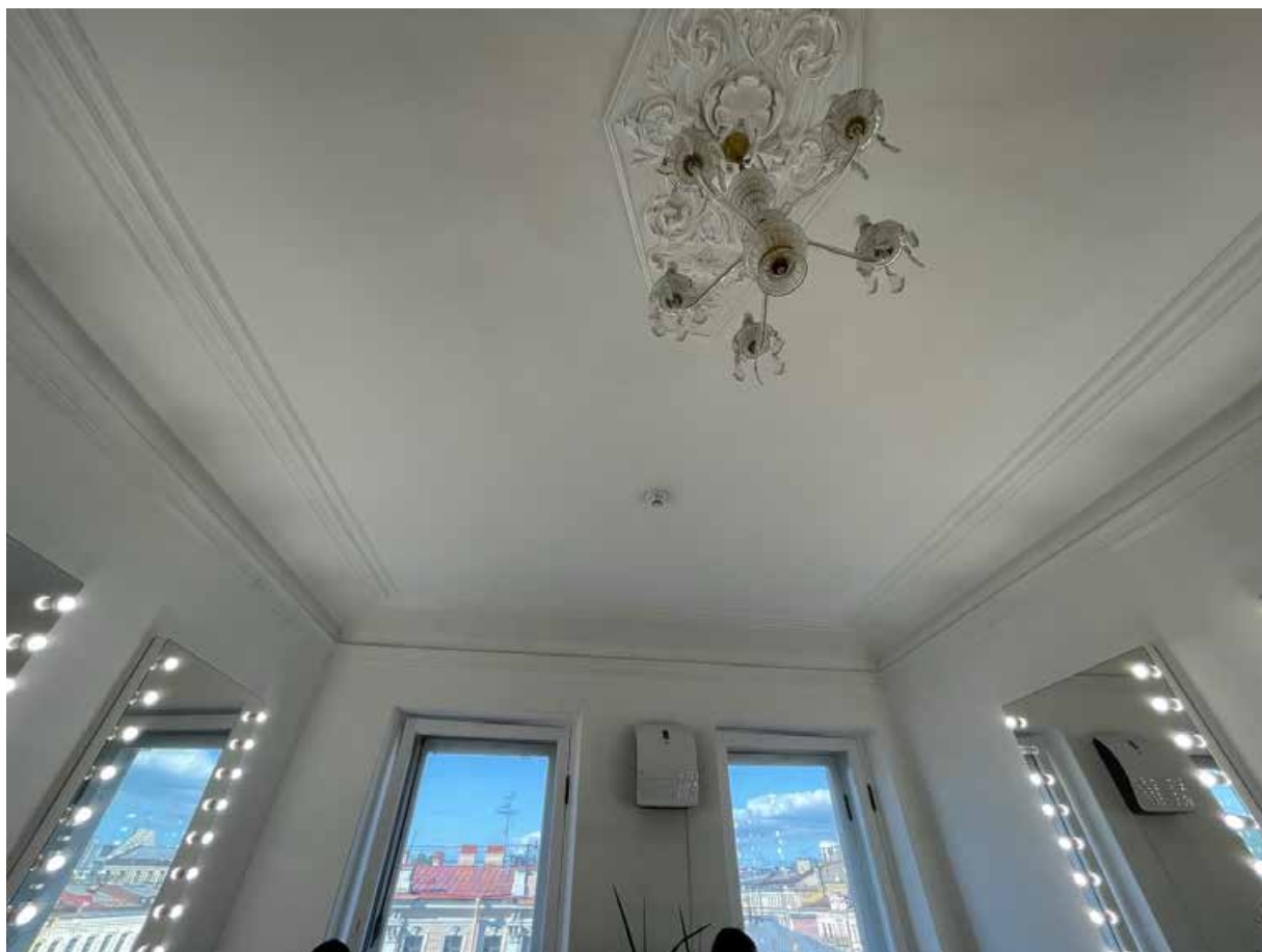
109. Общий вид оформления стены с оконными проемами в помещении 23-Н(8).
