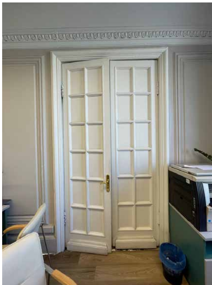
76. Дверной проем в помещение 12-Н(6). Проем оформлен профилированным наличником. Заполнение двустворчатое, каждая створка поделена на 12 равных филенок. Низ каждой створки оформлен фрагментарно декоративным профилированным плинтусом.
