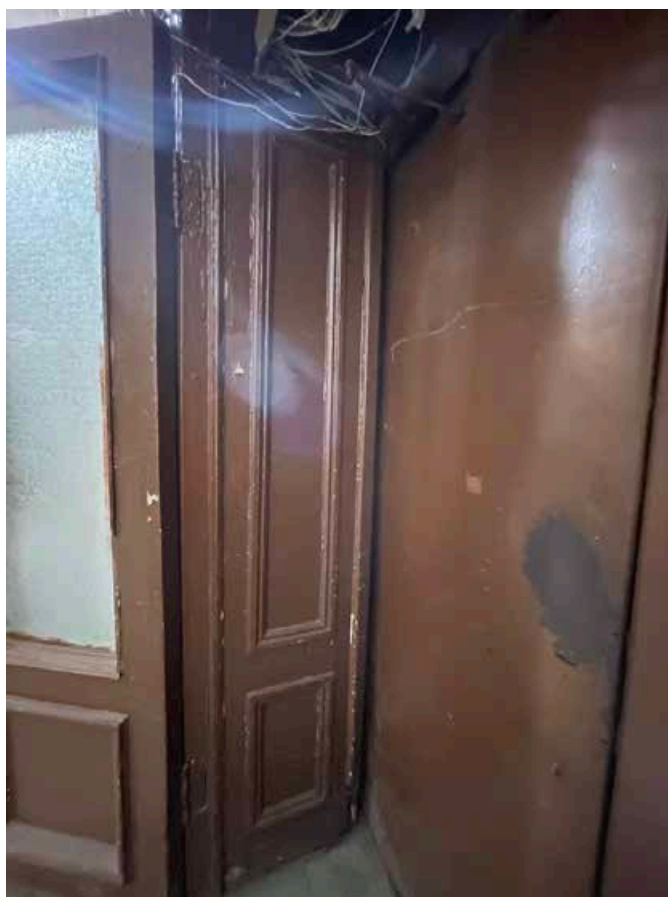
204. Профилированные панели деревянного тамбура входа в лестничную клетку.
