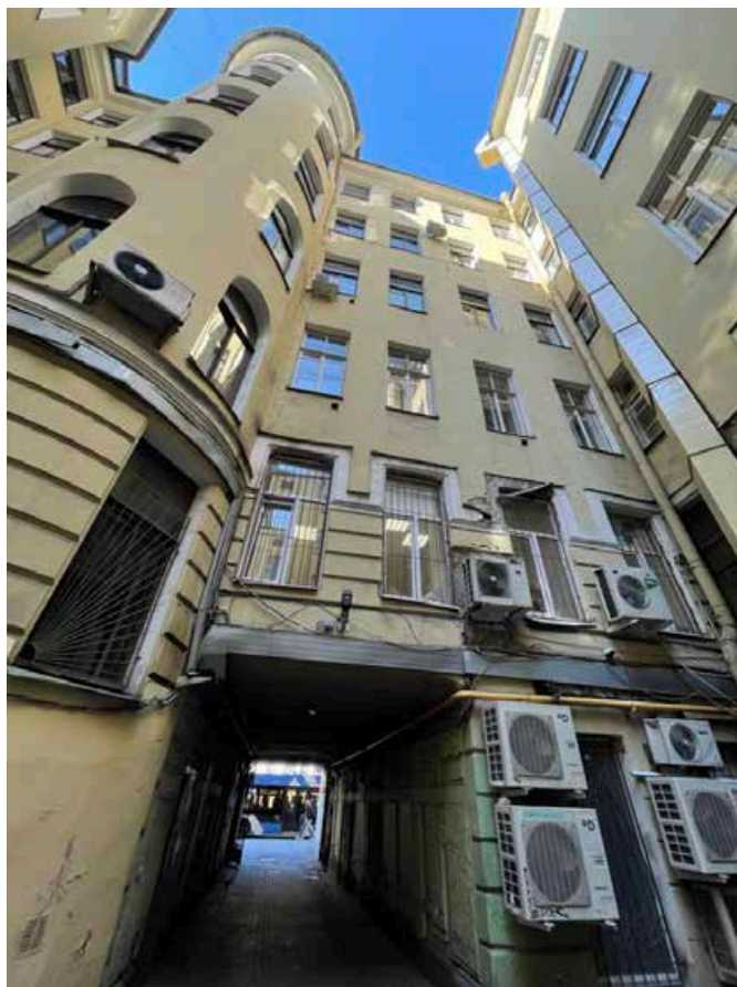
17. Общий вид северного фасада северного двора.
