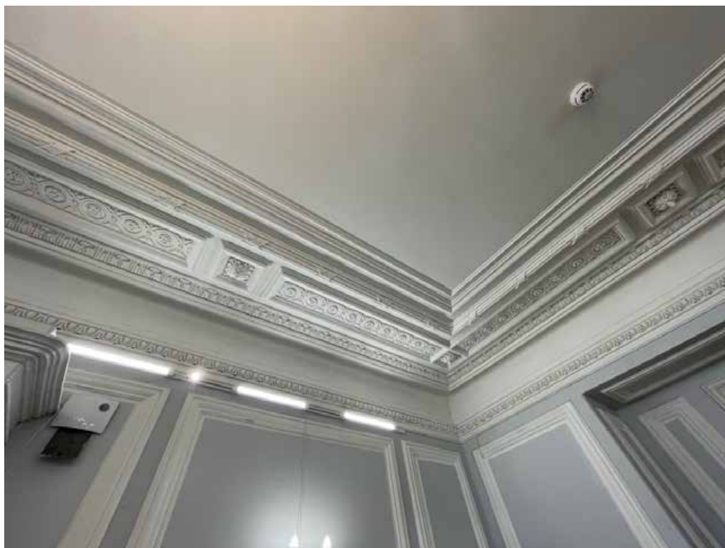
100. Фрагмент оформления плафона потолка помещения 23-Н(2) многоуровневым карнизом: овы, падуга, листья аканта, цветочными розетки, ленты и простые профилированные карнизы.
