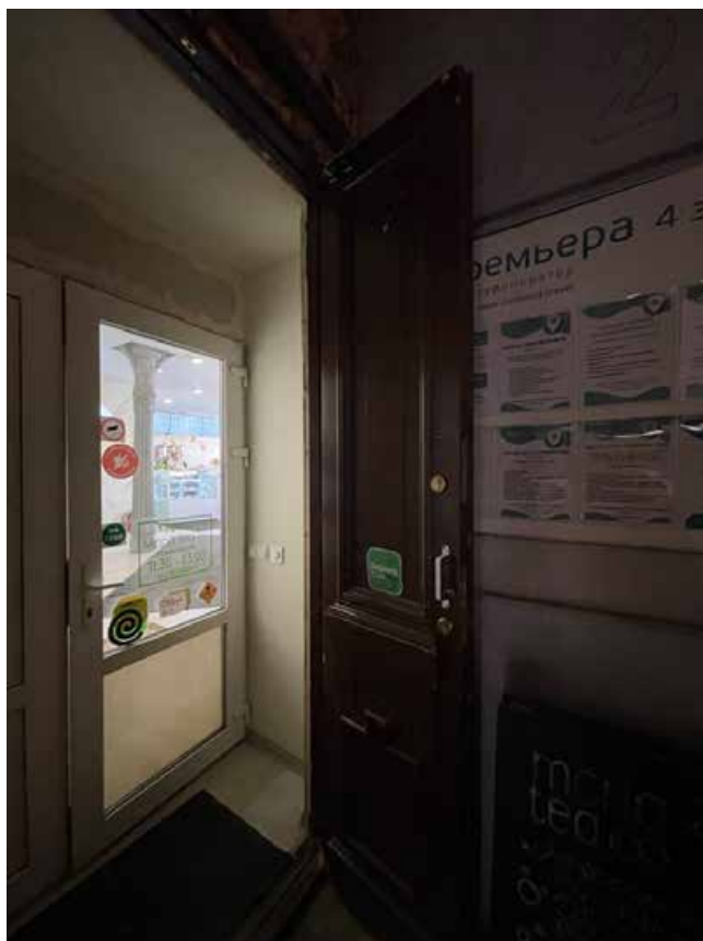
28. Дверной проем в помещение 3-Н(1). Двустворчатое филенчатое деревянное дверное заполнение, каждая створка делится на три филенки.
