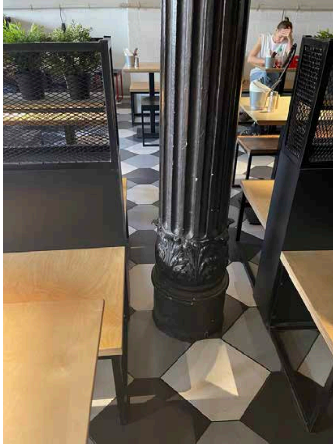
209. База колонны в помещении 2-Н(1).
