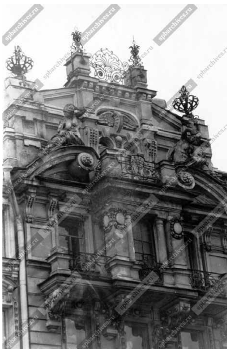
81. ЦГАКФФД СПб. Фотодокумент Ар 207557 Вид части фасада дома № 65 по Невскому проспекту. (Дом Рюль (Г. Г. Блокка), архитектор Я. Я. Фрейберг, 1980-е гг.
