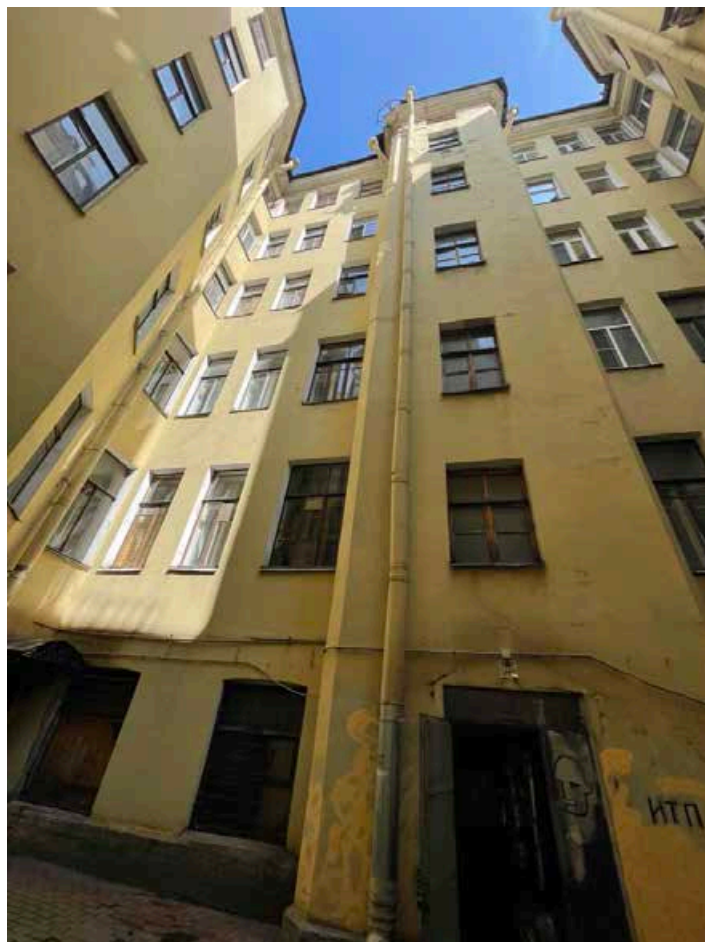
31. Общий вид северного фасада южного двора.
