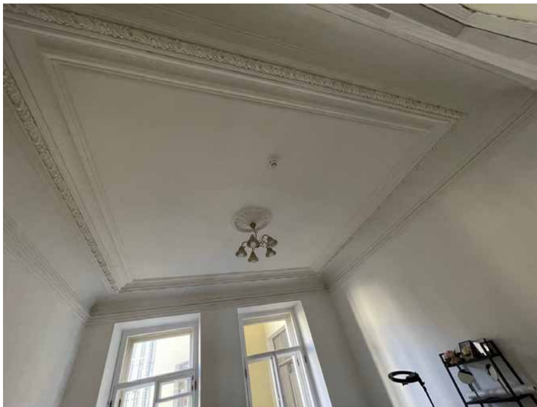
94. Общий вид оформления потолка помещения 23-Н(3): многоуровневый профилированный карниз с падугой и карнизом в виде гирлянды растительного мотива. Розетка в центре потолка поздняя.
