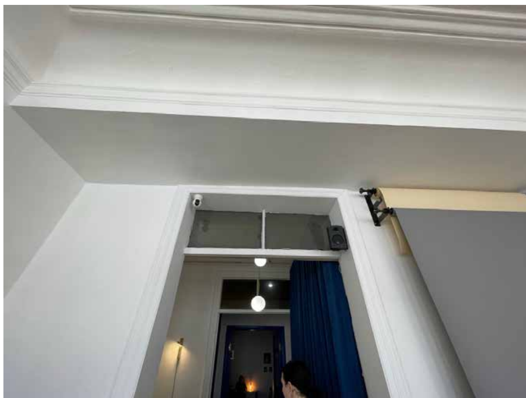
110. Оформление дверного проема (поздний) в помещении 23-Н(8). Заполнений не имеет, кроме остекленной фрамуги.
