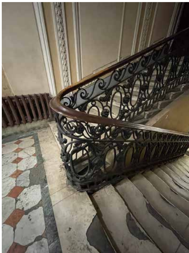
18. Общий вид металлического кованного ограждения лестничных маршей между первым и вторым этажами.
