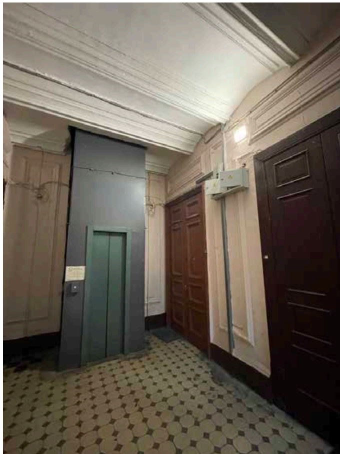
197. Общий вид лестничной площадки пятого этажа.
