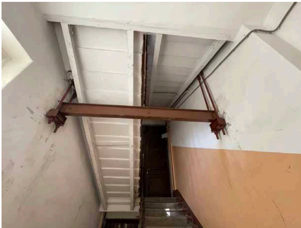
228. Металлическая конструкция усиления (предположительно выполнена после устройства лифта) на уровне шестого этажа лестничной клетки западного фасада.
