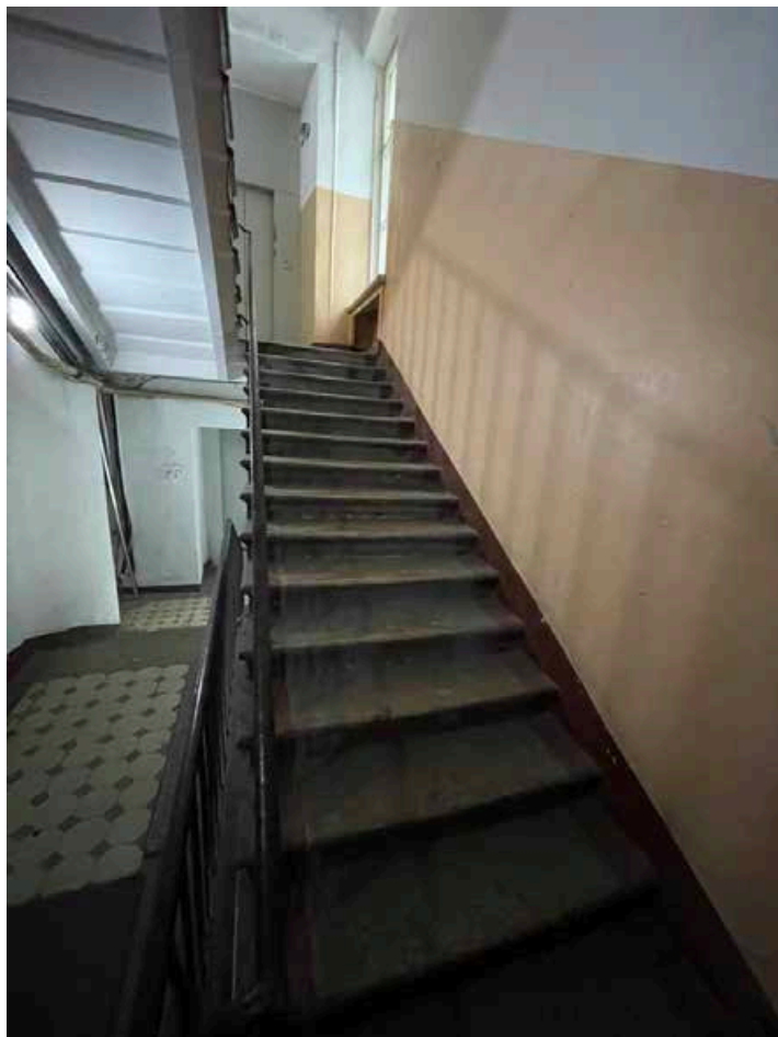
217. Лестничный марш со второго этажа на третий.
