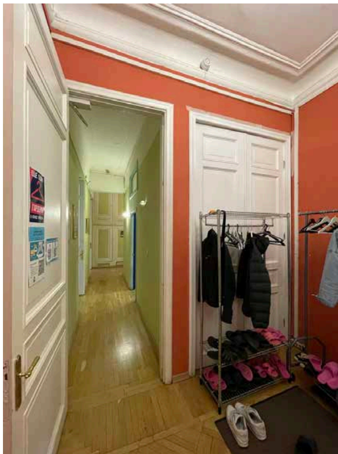
145. Общий вид помещения 26(Н)-6. Дверные проемы оформлены профилированными наличниками. Заполнения одностворчатое (в пом 26(Н)-6) и двустворчатое (в пом. 26(Н)-5). Каждая створка поделена на 3 филенки.
