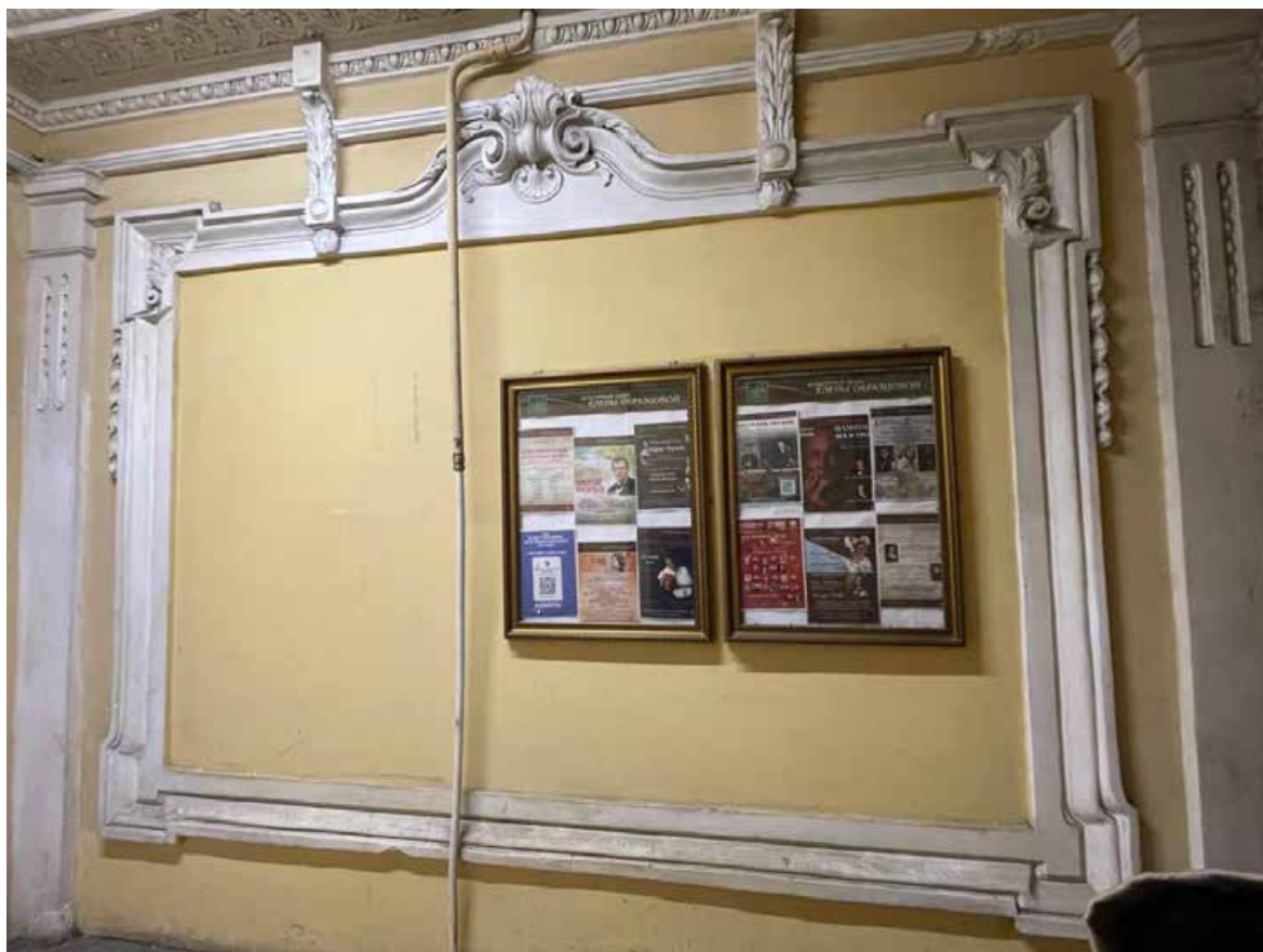
5. Оформление западной стены вестибюля профилированной панелью с картушем в виде волюты с акантом и ракушкой.
