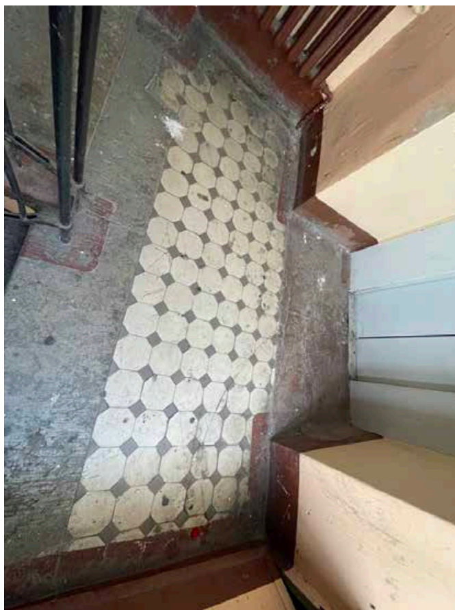
227. Покрытие лестничной площадки между пятым и шестым этажами аналогичной метлахской плиткой. Лестничная клетка западного фасада.
