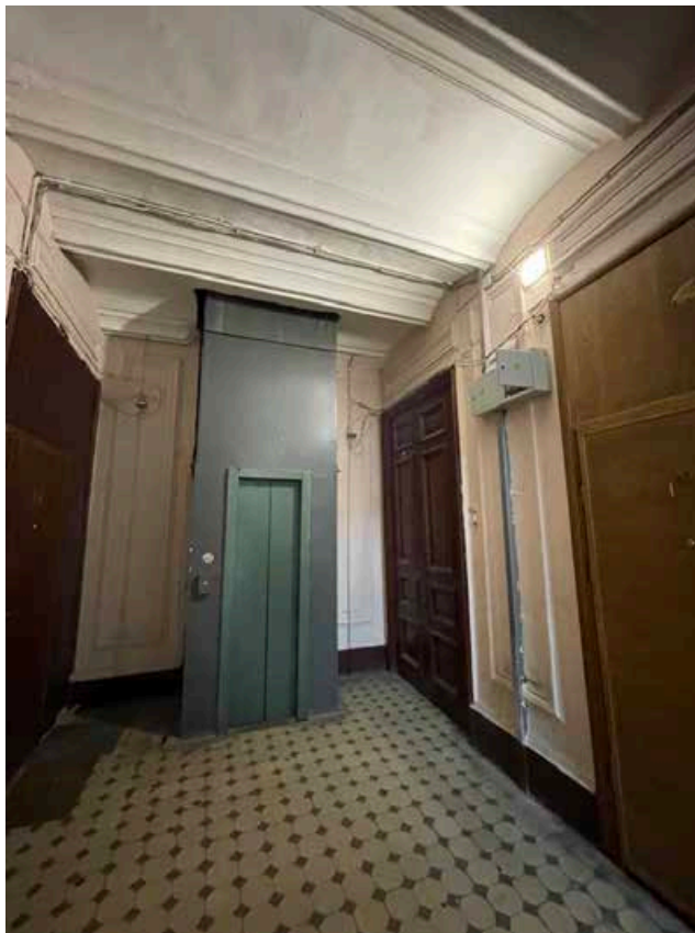
199. Общий вид лестничной площадки шестого этажа.
