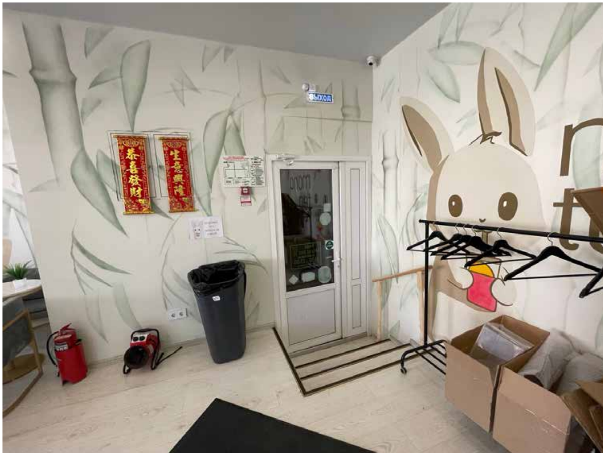
37. Второе дверное заполнение в помещении 3-Н(1) – позднее.
