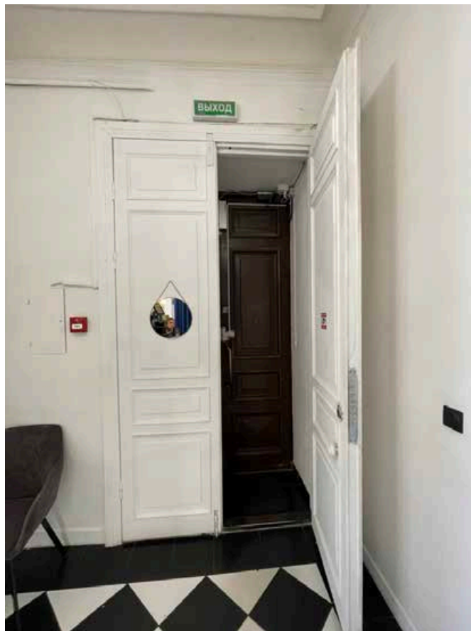
90. Дверной проем в помещении 23-Н(1), ведущий на лестничную клетку. Дверное заполнение двустворчатое деревянное, каждая створка делится на 4 филенки.
