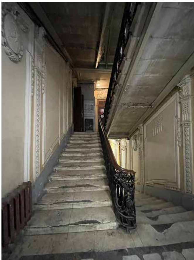
24. Общий вид лестничной клетки с площадки между первым и вторым этажами.
