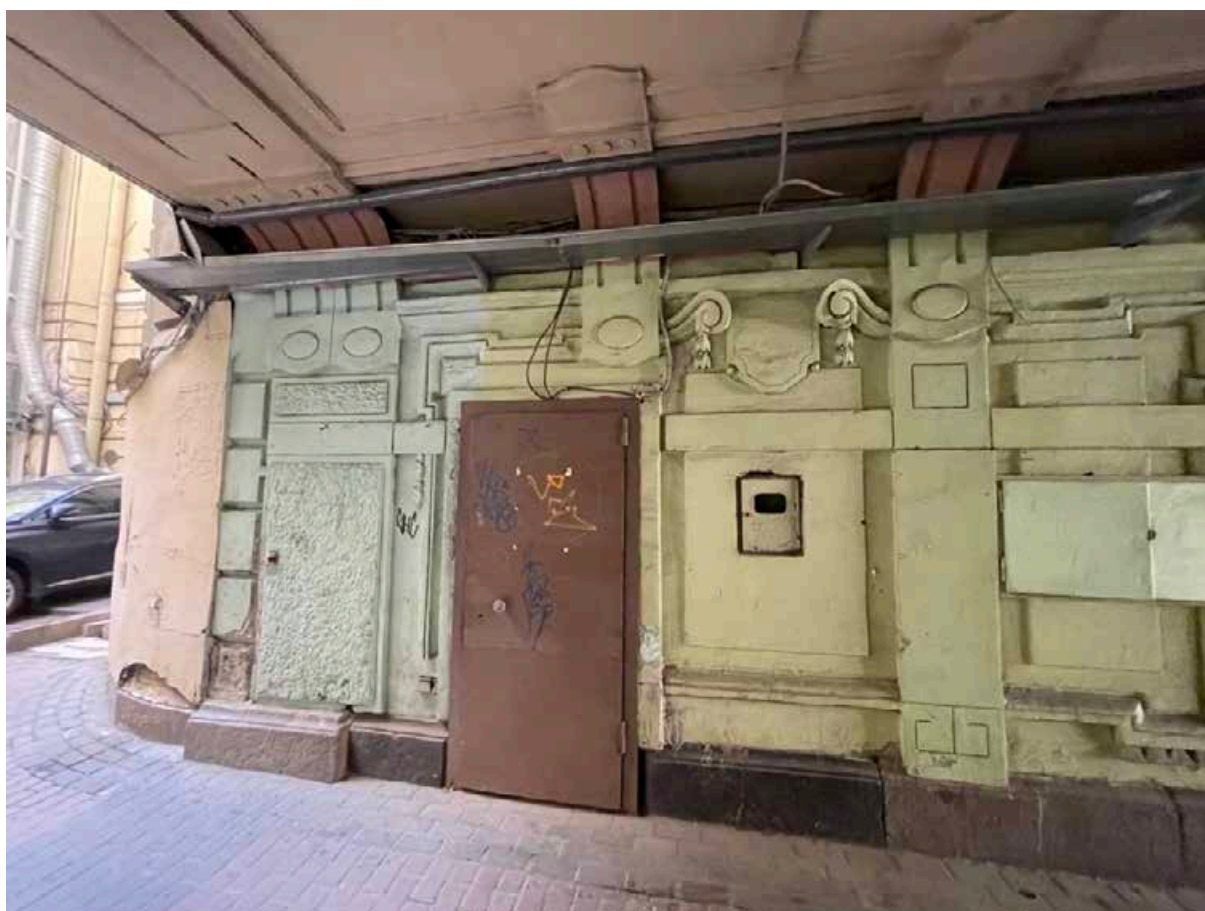
16. Дверной проем и декоративное оформление западной стены воротного проезда со стороны Невского проспекта (ближе ко двору).
