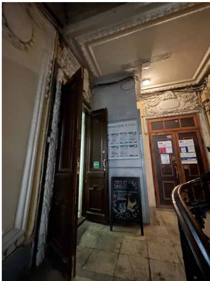
27. Общий вид площадки второго этажа лестничной клетки.
