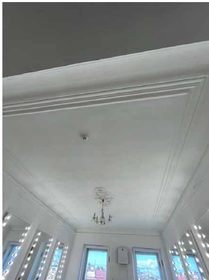
107. Общий вид оформления плафона потолка падугой и профилированным карнизом в помещении 23-Н(8).
