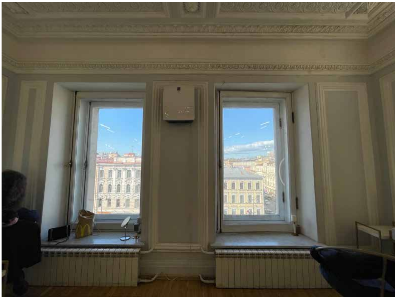
105. Общий вид оформления стен между оконными проемами в помещении 23-Н(2).
