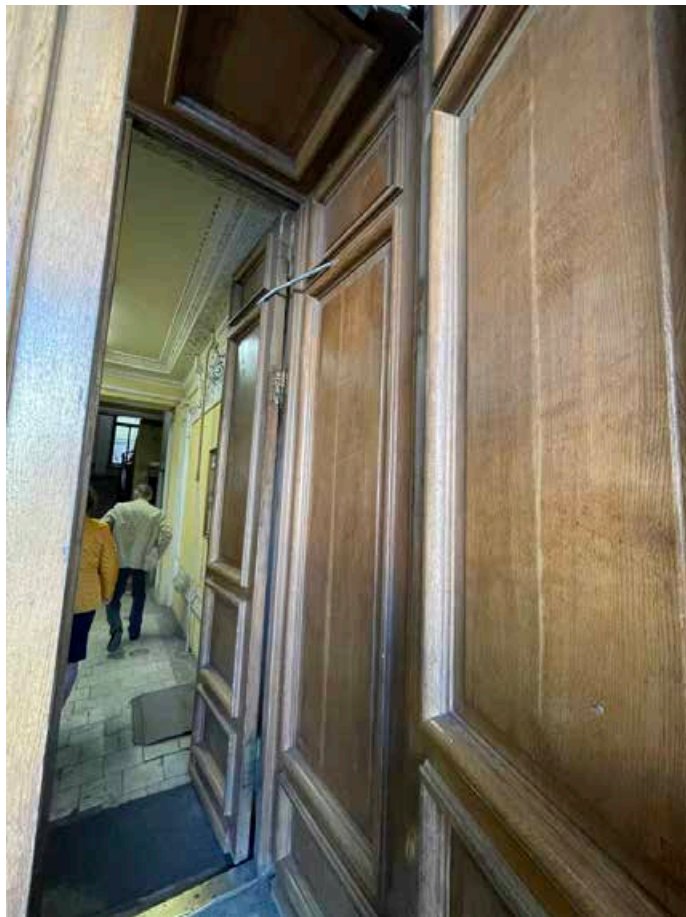
1. Общий вид тамбура главного входа в парадную со стороны Невского проспекта.
