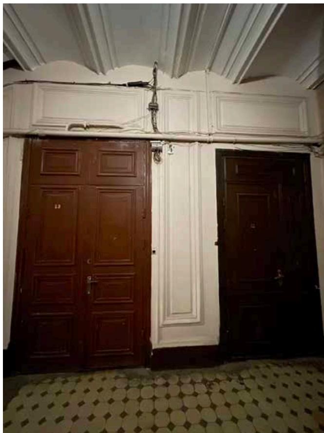
189. Дверные заполнения частично деревянные, частично металлические. Заполнения двустворчатые на 3 филенки каждая створка с глухой фрамугой, поделенной на 2 филенки.
