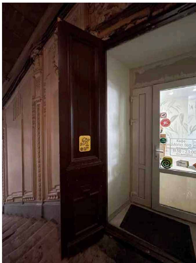
29. Дверной проем в помещение 3-Н(1). Двустворчатое филенчатое деревянное дверное заполнение, каждая створка делится на три филенки.
