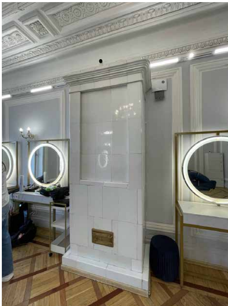
99. Печь изразцовая прямоугольная в плане в помещении 23-Н(2). Оформлена белыми глазурованными изразцами без рельефов. Завершается профилированным карнизом.
