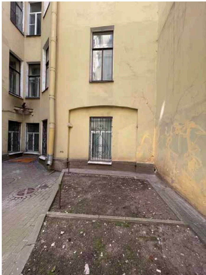
33. Ниша в стене восточного фасада южного двора. Цоколь отделан известняковой плитой.
