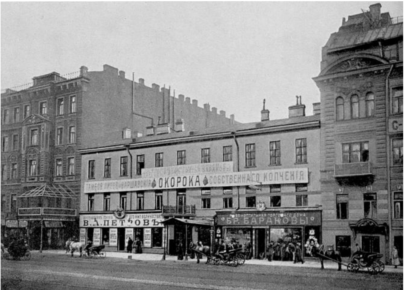
29. Общий вид фасада дома №65 по Невскому проспекту до перестройки.
