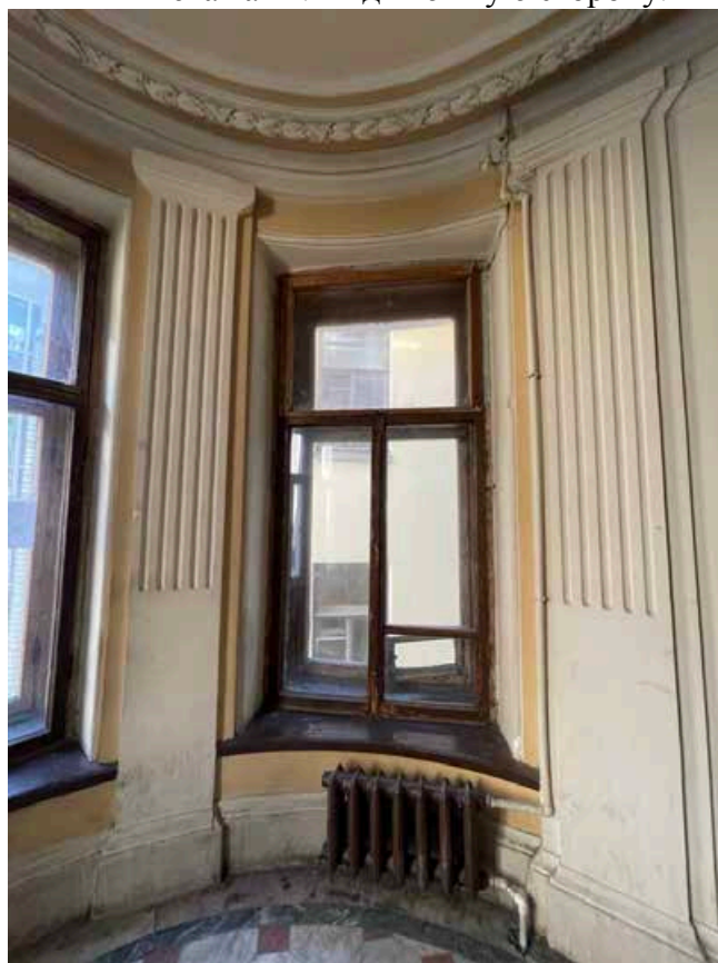
130. Оконный проем круглого ризалита лестничной клетки между пятым и шестым этажами. Вид в западную сторону.
