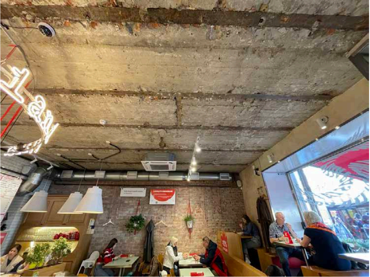
205. Общий вид перекрытия в помещении 1-Н(1).
