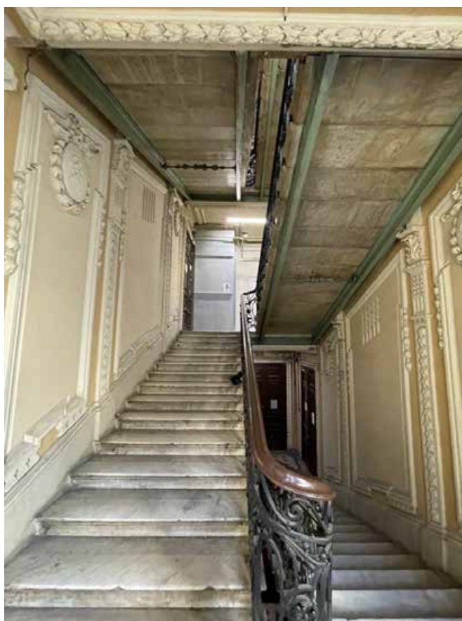
86. Общий вид лестничного марша с четвертого на пятый этаж.
