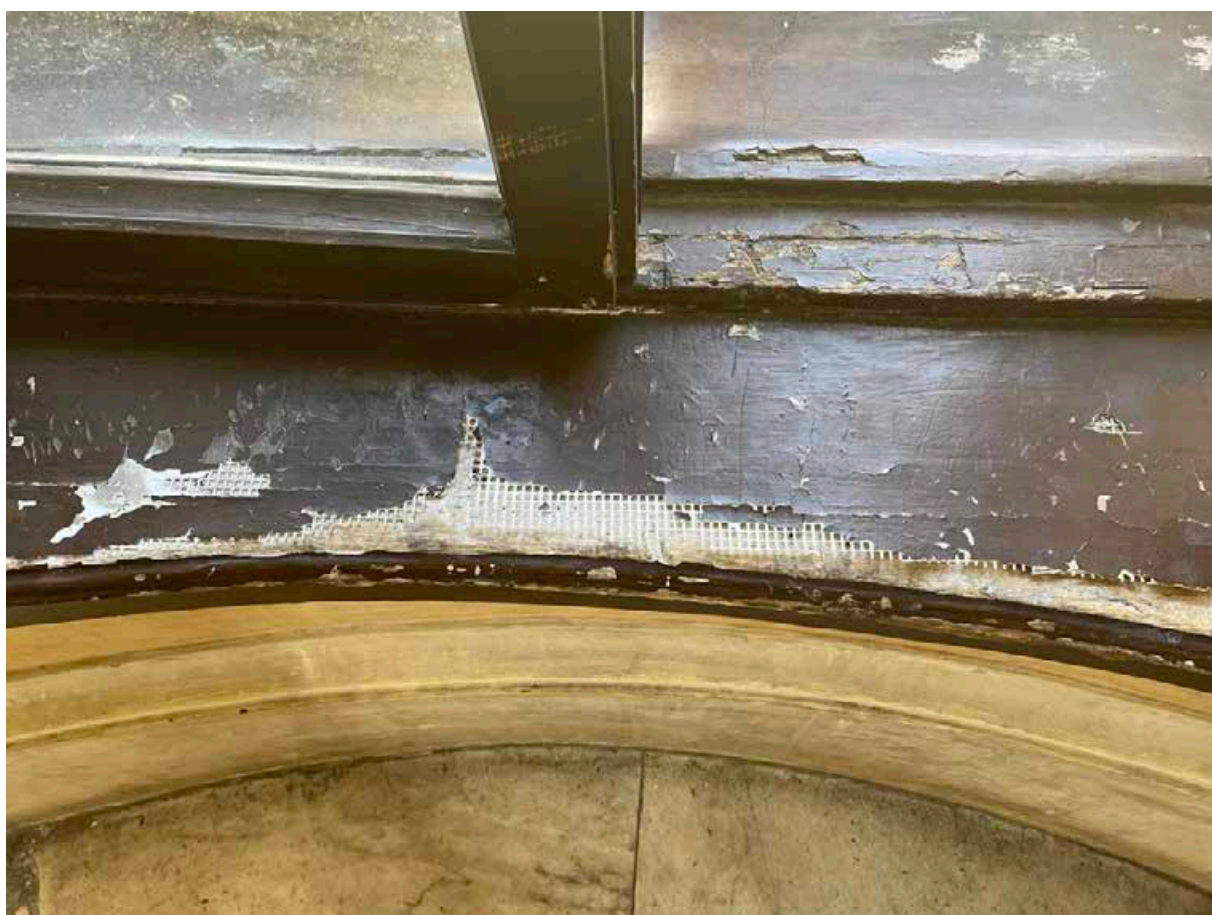
164. Поздняя окраска подоконных досок оконных проемов круглого ризалита лестничной площадки между шестым и мансардным этажами. Вид в восточную сторону.
