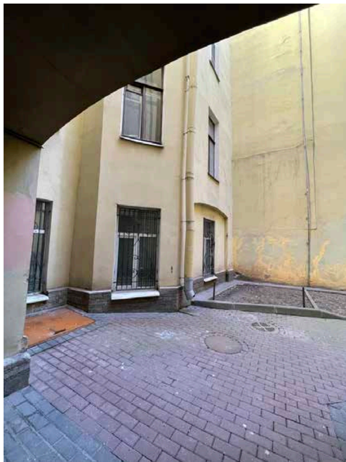
29. Фрагмент южного двора.
