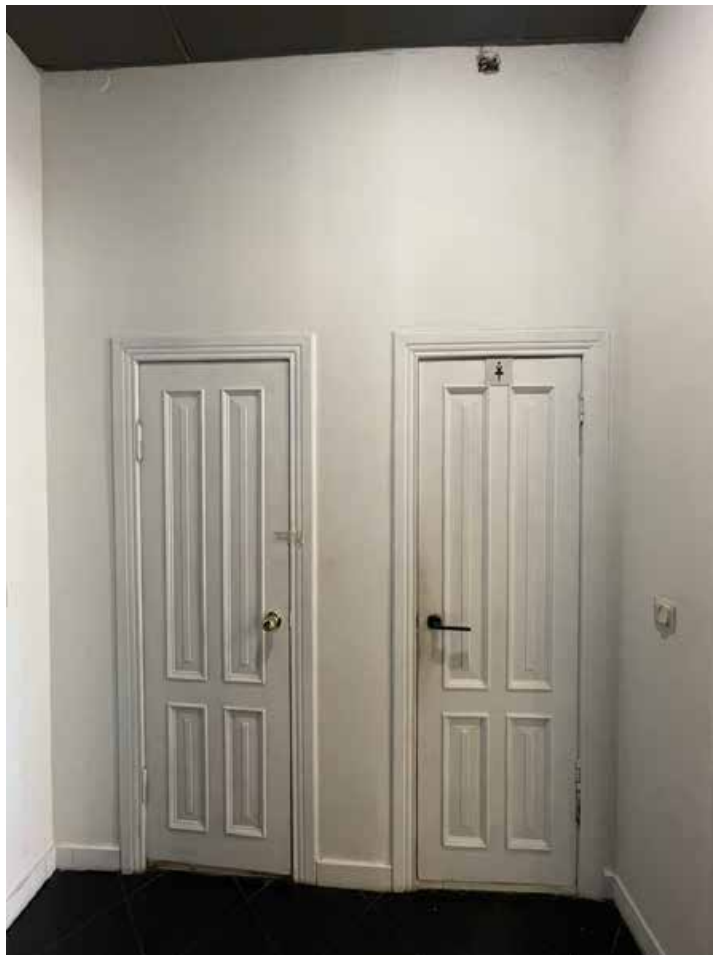
111. Дверные проемы в помещения 23-Н(6) и 23-Н(7). Проемы оформлены профилированными наличниками. Заполнения одностворчатые, поделены на 4 вертикальных филенки.
