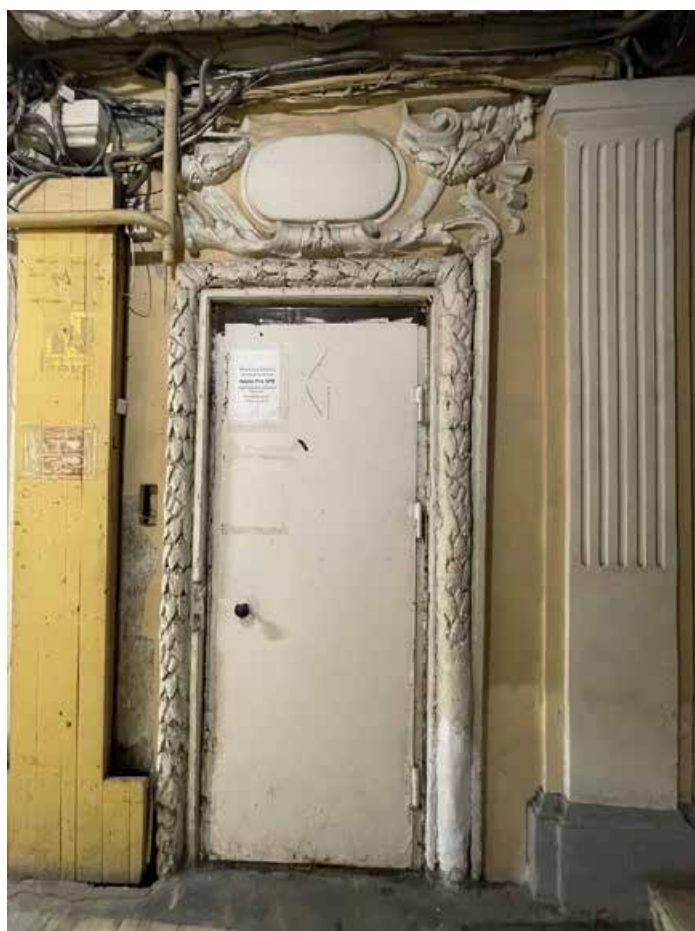
12. Общий вид оформления дверного проема в восточной стене лестничной клетки.
