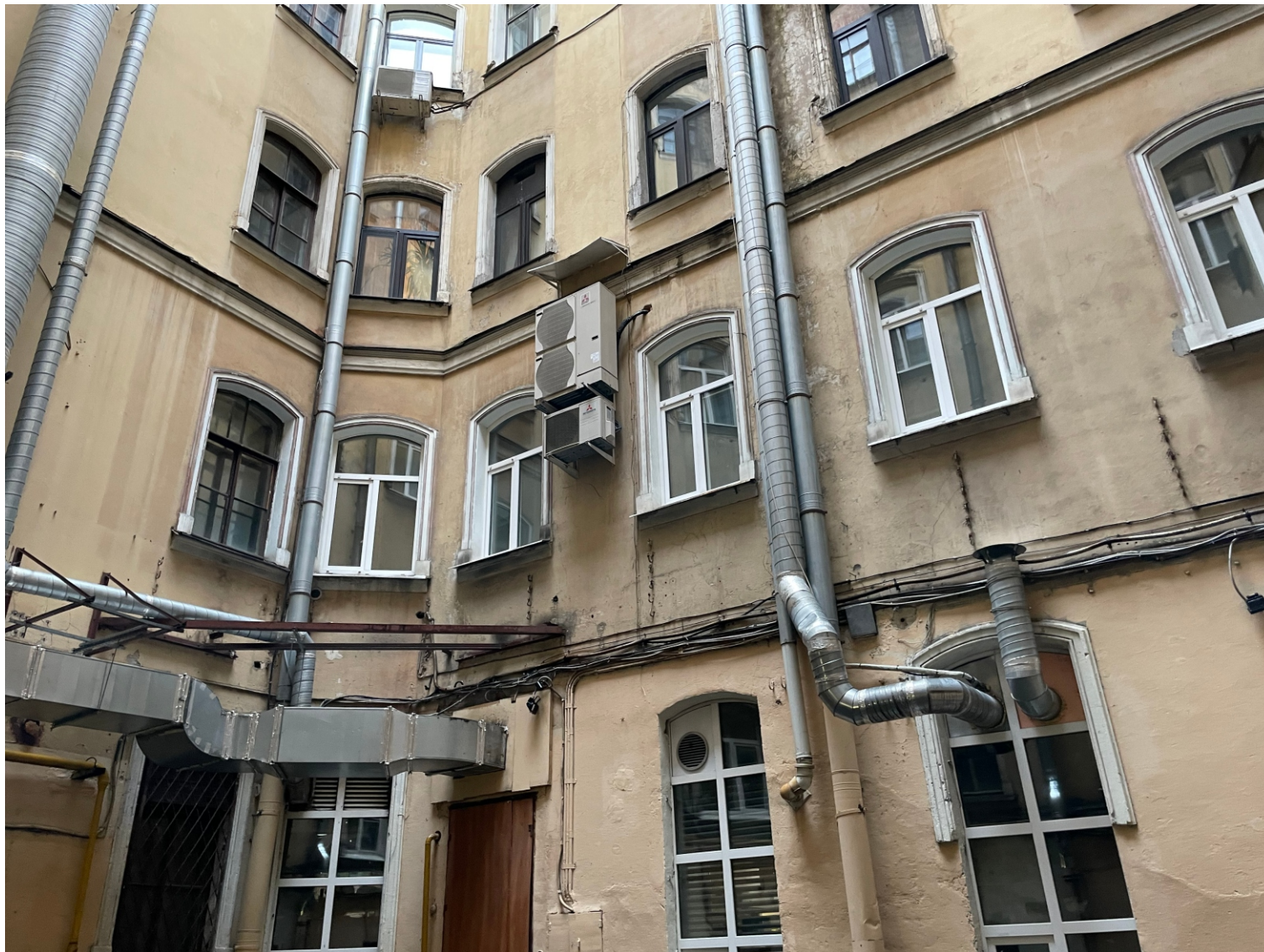
10. «Дом Г.Г.Елисева». Санкт-Петербург, ул. Ломоносова, д.14, литера А. 2-й двор. Фрагмент дворового фасада. Фото: 01.02.2023.
