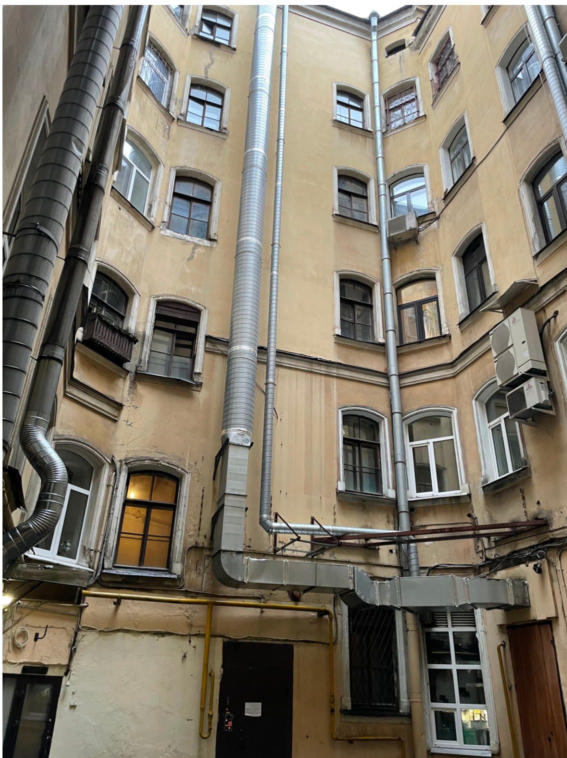
11. «Дом Г.Г.Елисеева». Санкт-Петербург, ул. Ломоносова, д.14, литера А. 2-й двор. Фрагмент дворового фасада. Фото: 01.02.2023.
