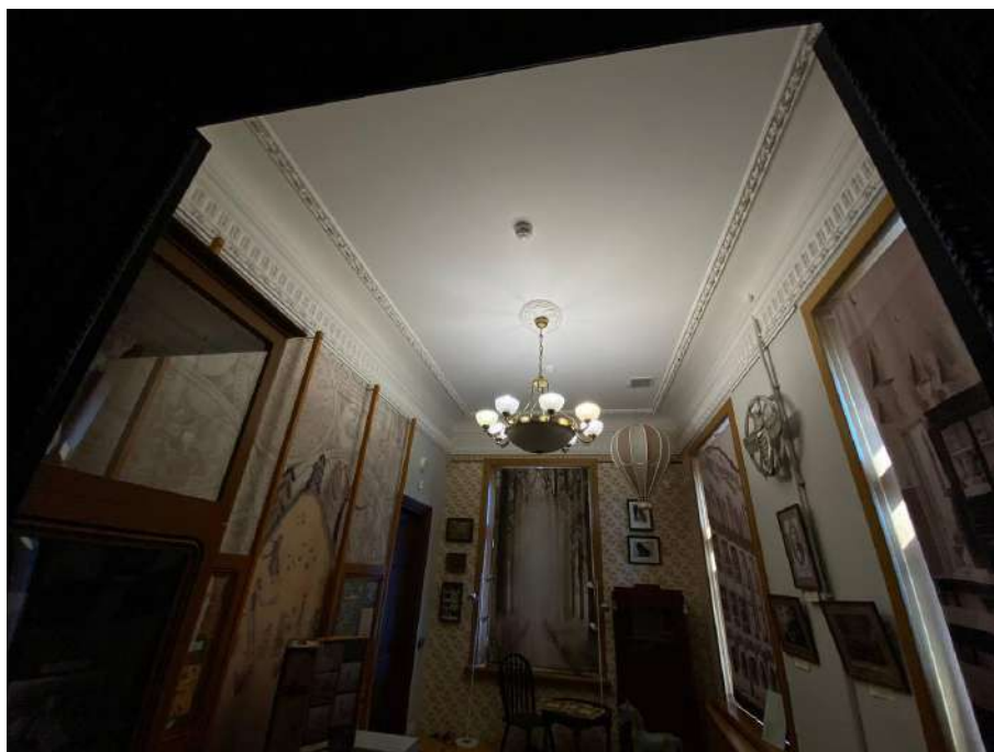
Фото №35. 2 этаж, помещение 212.
