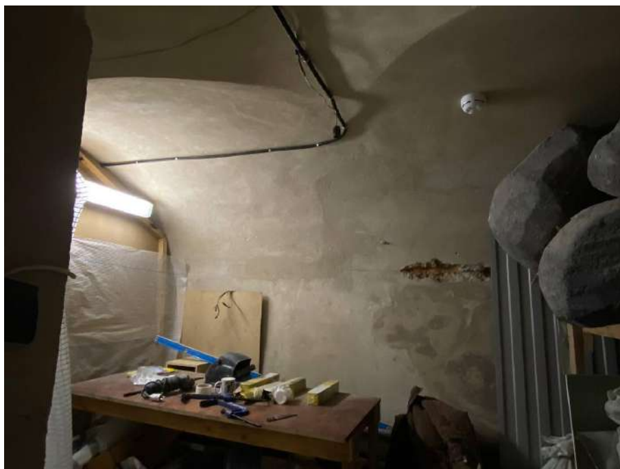
Фото №7. Подвал, помещение 0.18.
