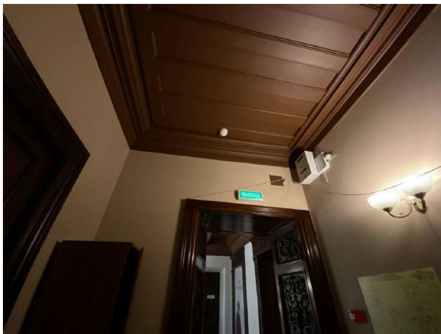
Фото №23. 1 этаж, помещение 115.1.
