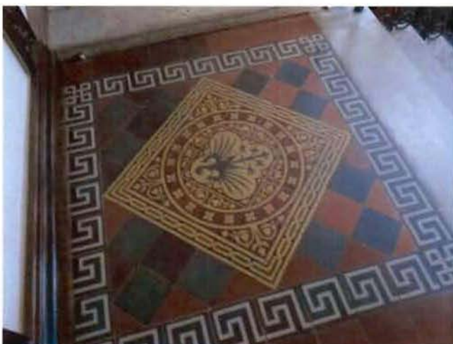
5. Покрытие пола верхнего уровня вестибюля.
