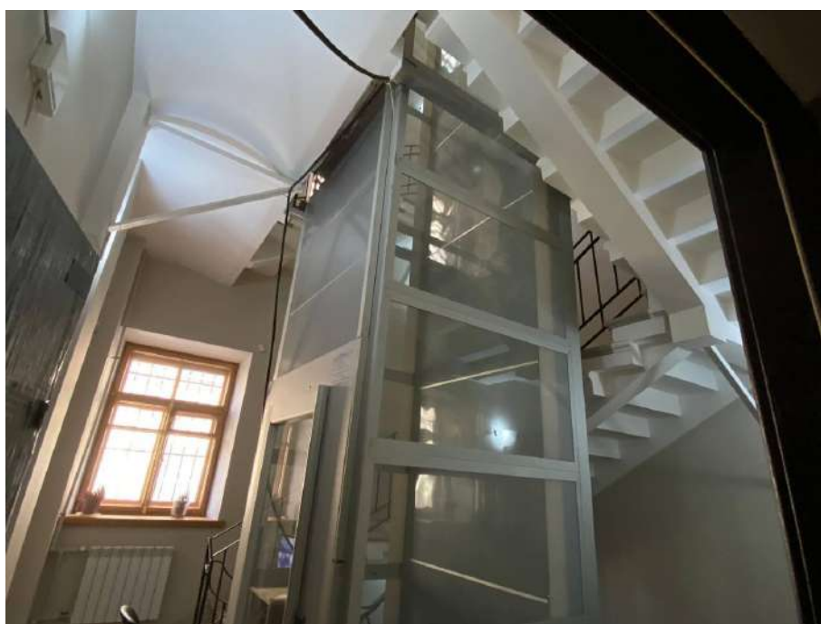
Фото №18. 1 этаж, помещение 104, лестница на 2 этаж.
