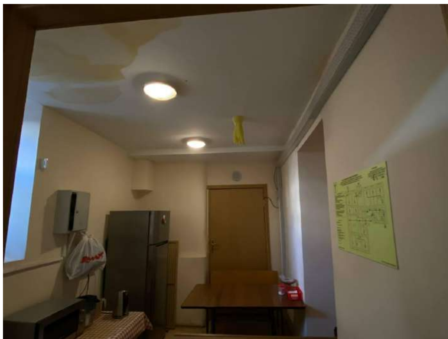
Фото №15. Подвал, помещение 0.14, дверь в помещение 0.16.
