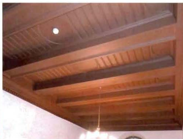
8. Оформление потолка над лестничной клеткой.
