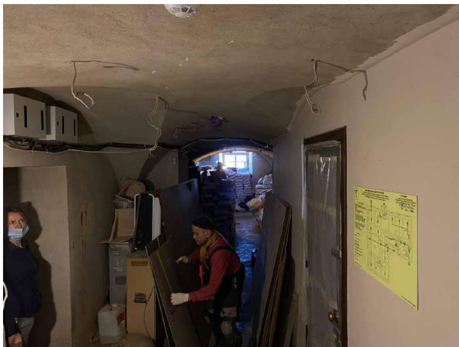
Фото №5. Подвал, помещение 0.17.
