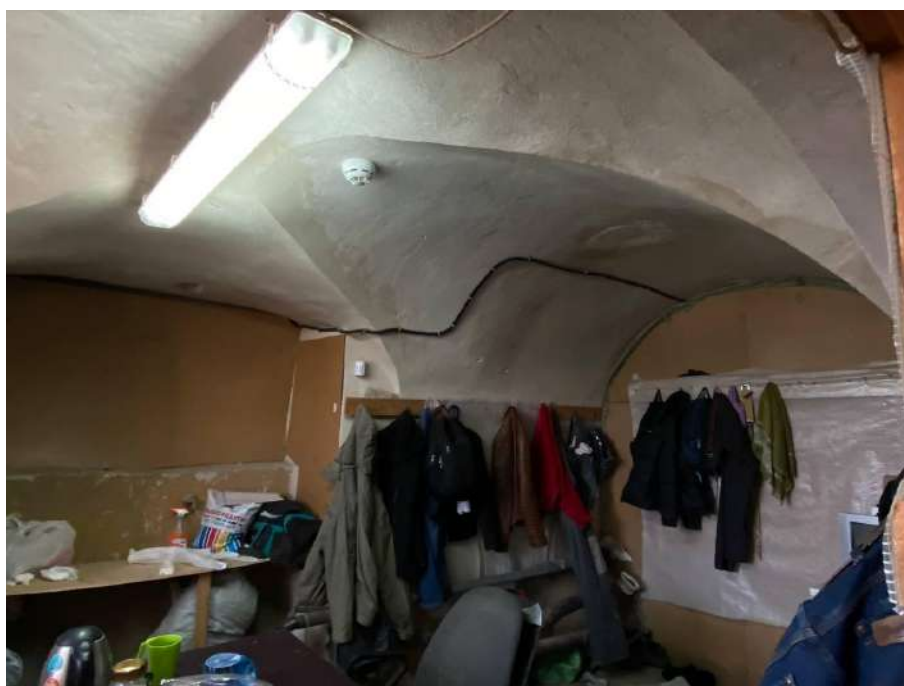
Фото №8. Подвал, помещение 0.6.
