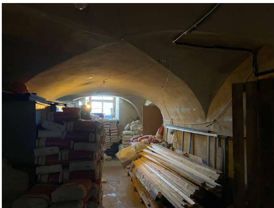
Фото №6. Подвал, помещение 0.5.
