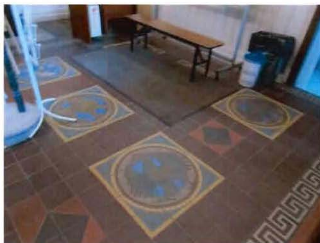
6. Покрытие пола нижнего уровня вестибюля.
