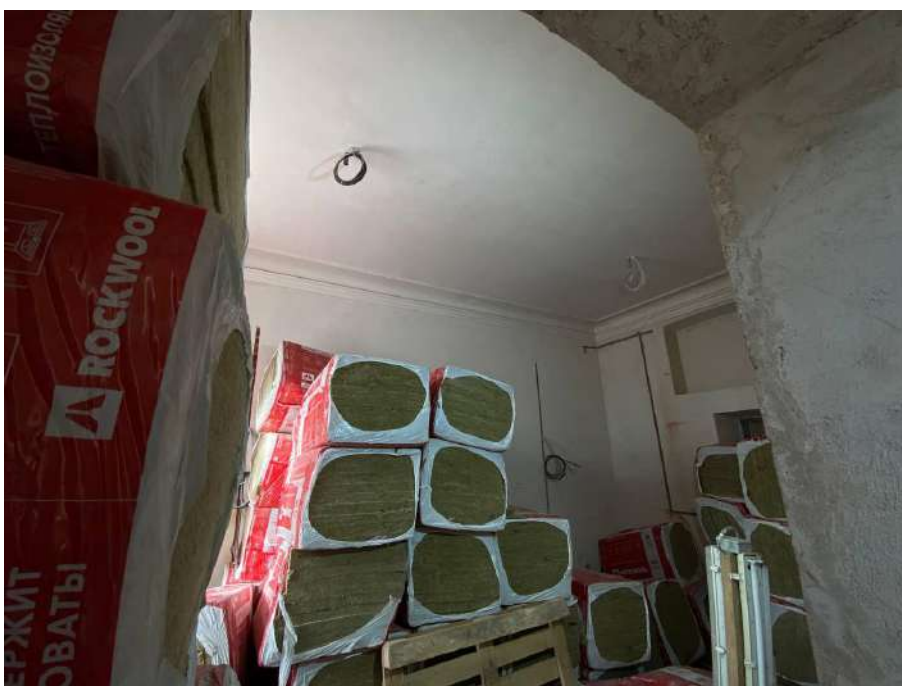
Фото №30. 1 этаж, помещение 102.
