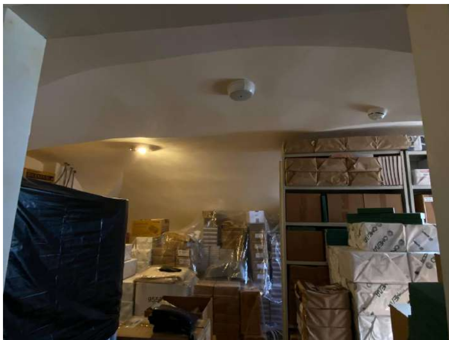
Фото №13. Подвал, помещение 0.12.
