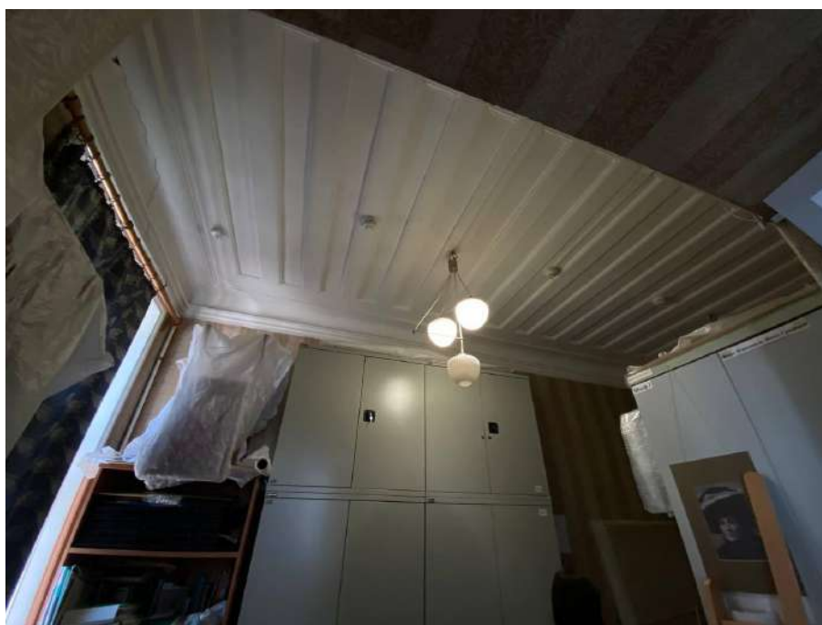
Фото №26. 1 этаж, помещение 113.
