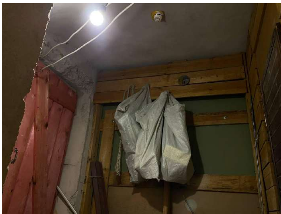
Фото №10. Подвал, помещение 0.19.
