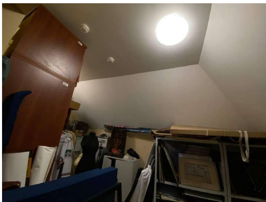
Фото №46. 3 этаж, помещение 317.
