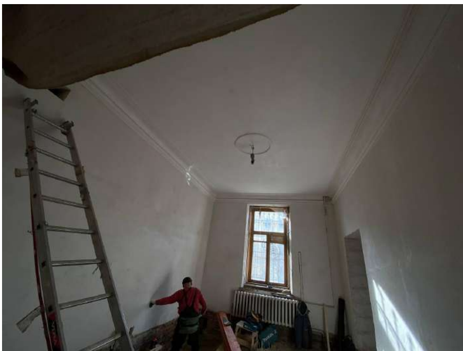
Фото №29. 1 этаж, помещение 103.
