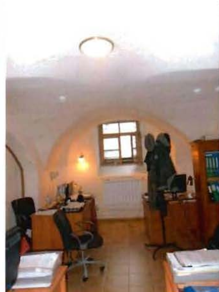
4. Свод цокольного этажа.
