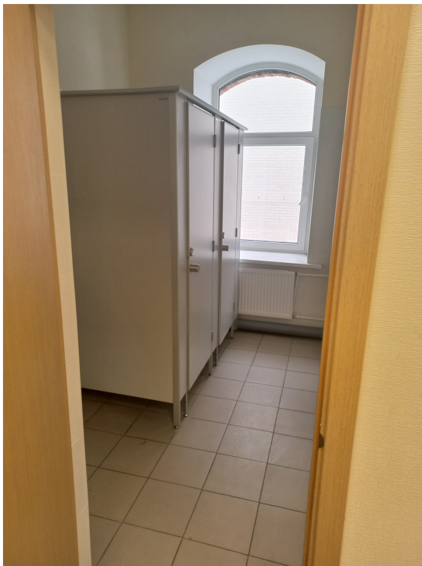
Фото 6. Санузел, помещение 3 по проектной экспликацией.
