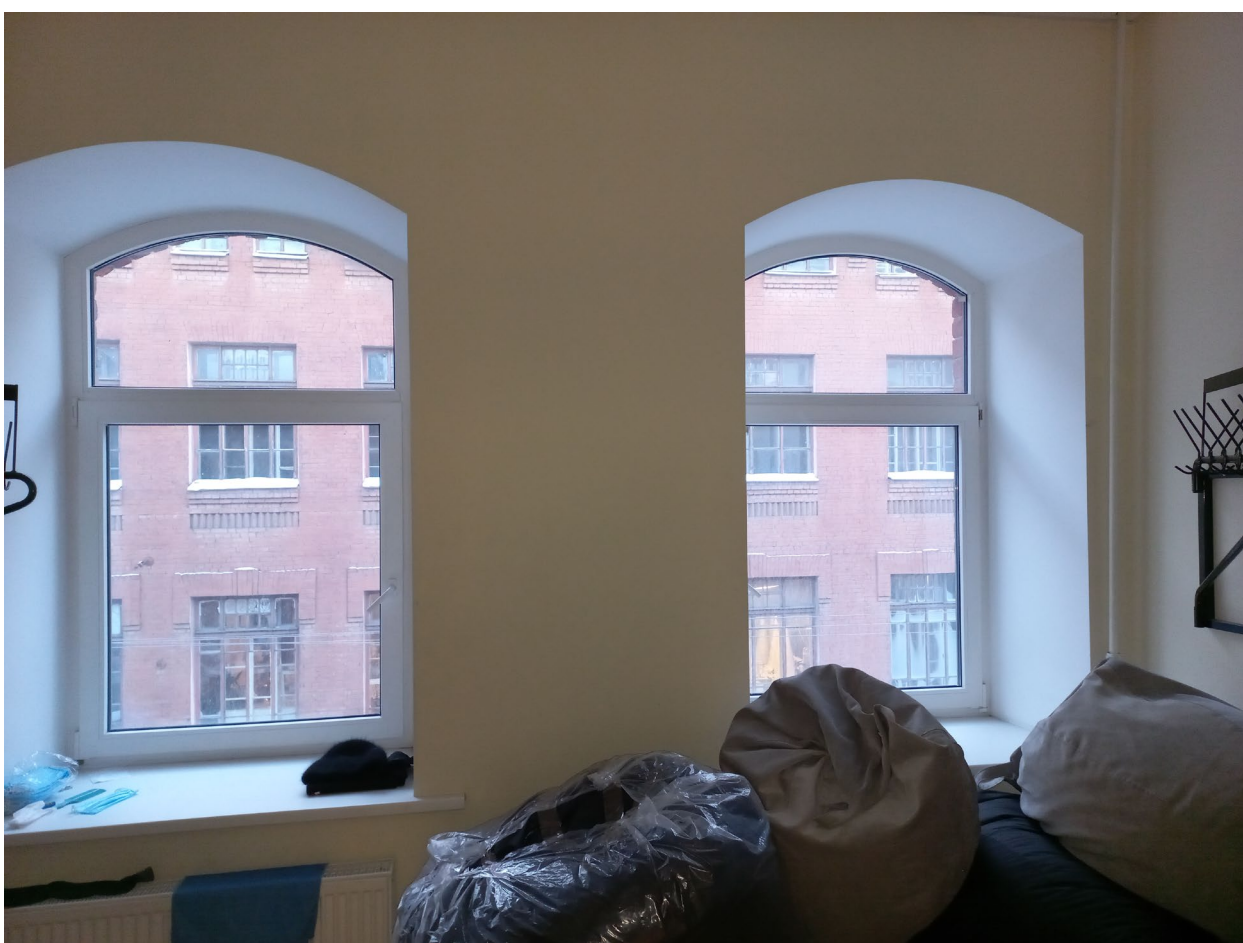
Фото 17. Раздевалка, помещение 8 по проектной экспликации.
