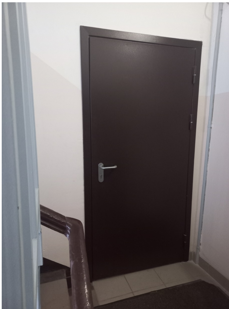
Фото 5. Существующий вход в помещения.
