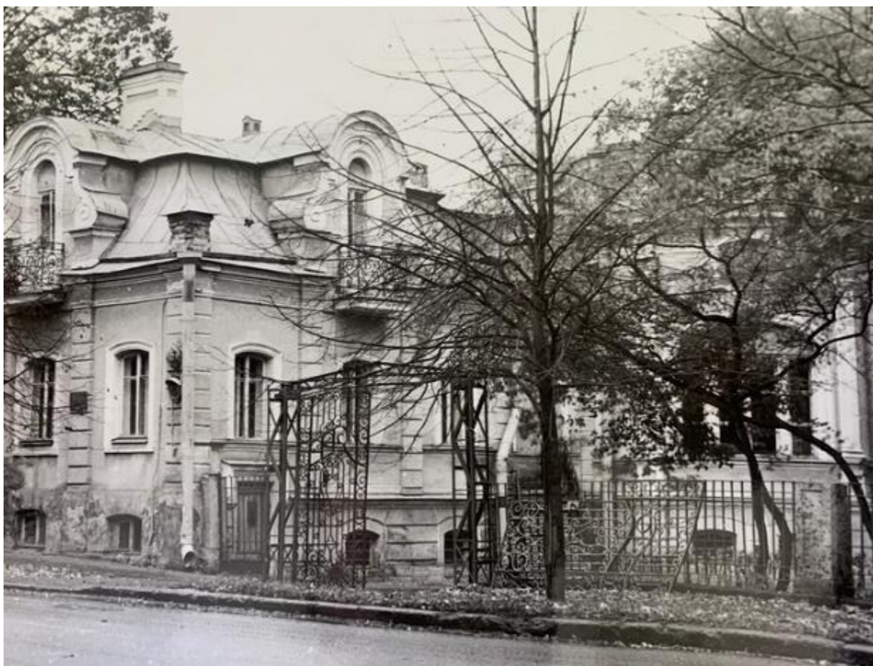
9. Ворота к югу от здания дачи. Фотография 1978 г. Архив КГИОП. Фототека. № 80449
