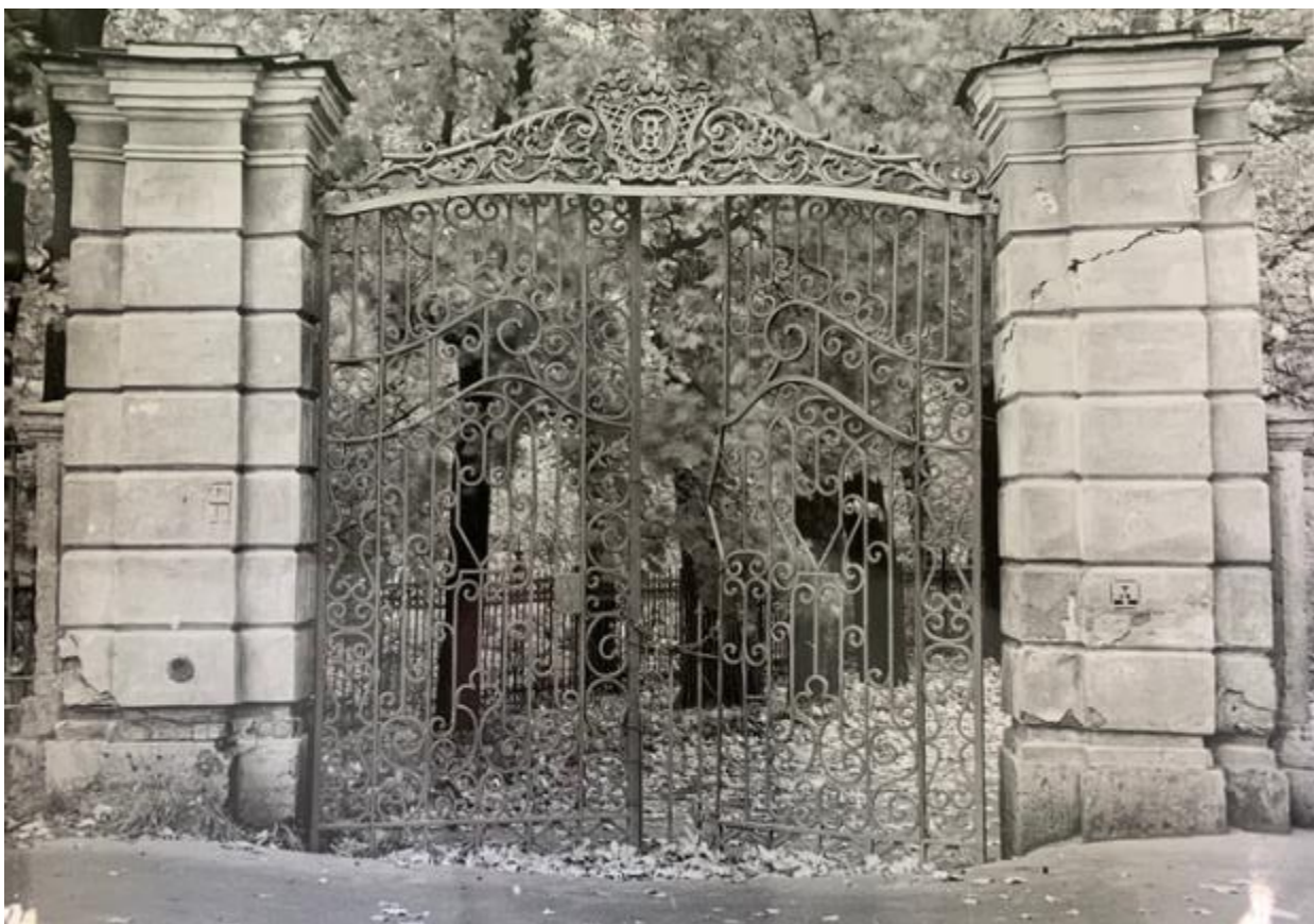
7. Ворота в северной части участка. Фотография 1978 г. Архив КГИОП. Фототека. № 80450
