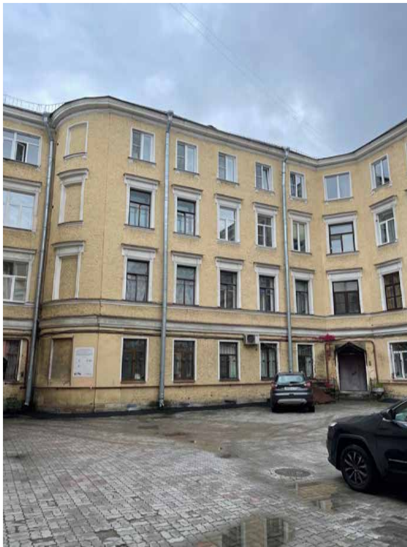
21. Дворовый корпус, первый двор (фрагмент). Выявленный объект культурного наследия «Дом Ю. Н. Адельсон», расположенный по адресу: г. Санкт-Петербург, Гороховая ул, дом 33, литера А
