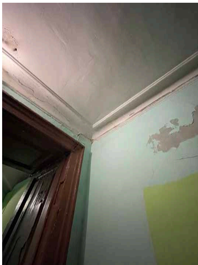
45. Профилированный карниз парадной. Выявленный объект культурного наследия «Дом Ю. Н. Адельсон», расположенный по адресу: г. Санкт-Петербург, Гороховая ул, дом 33, литера А
