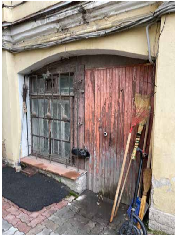
19. Дверной проем дворового фасада лицевого корпуса в световых осях 3, 4. Выявленный объект культурного наследия «Дом Ю. Н. Адельсон», расположенный по адресу: г. Санкт-Петербург, Гороховая ул, дом 33, литера А
