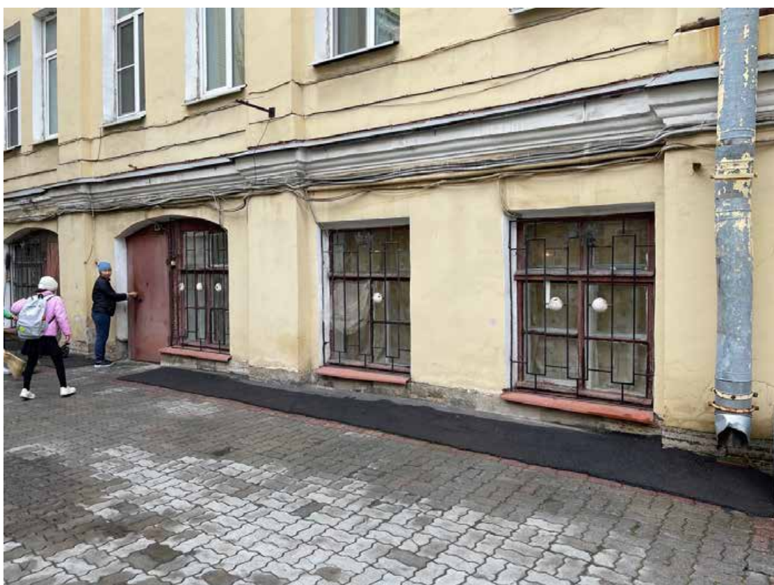
18. Дворовый фасад лицевого корпуса в световых осях 5–8 в уровне 1 этажа. Выявленный объект культурного наследия «Дом Ю. Н. Адельсон», расположенный по адресу: г. Санкт-Петербург, Гороховая ул, дом 33, литера А
