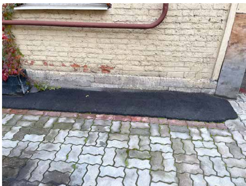
26. Дворовый корпус, первый двор (фрагмент цоколя). Выявленный объект культурного наследия «Дом Ю. Н. Адельсон», расположенный по адресу: г. Санкт-Петербург, Гороховая ул, дом 33, литера А
