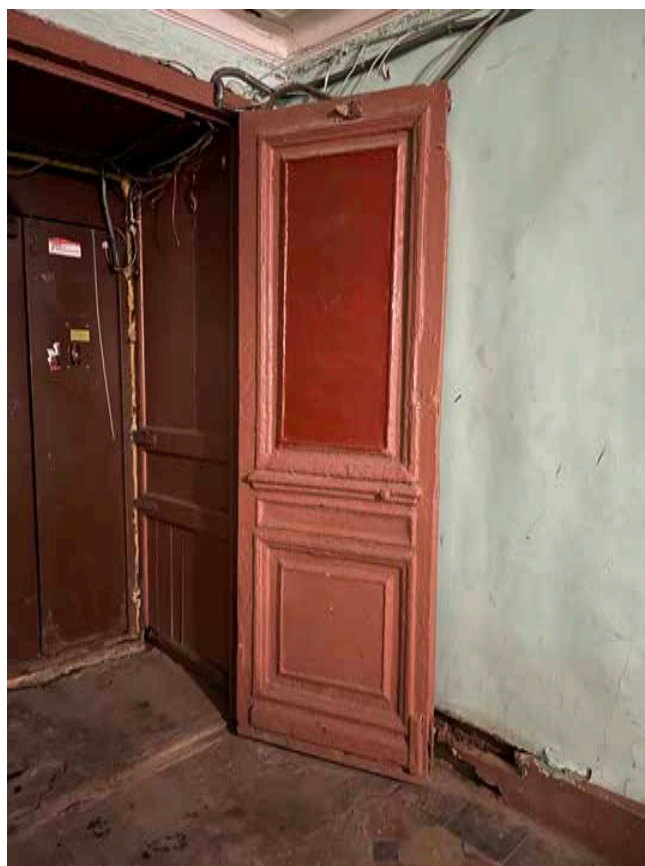
43. Деревянное дверное заполнение парадной. Выявленный объект культурного наследия «Дом Ю. Н. Адельсон», расположенный по адресу: г. Санкт-Петербург, Гороховая ул, дом 33, литера А
