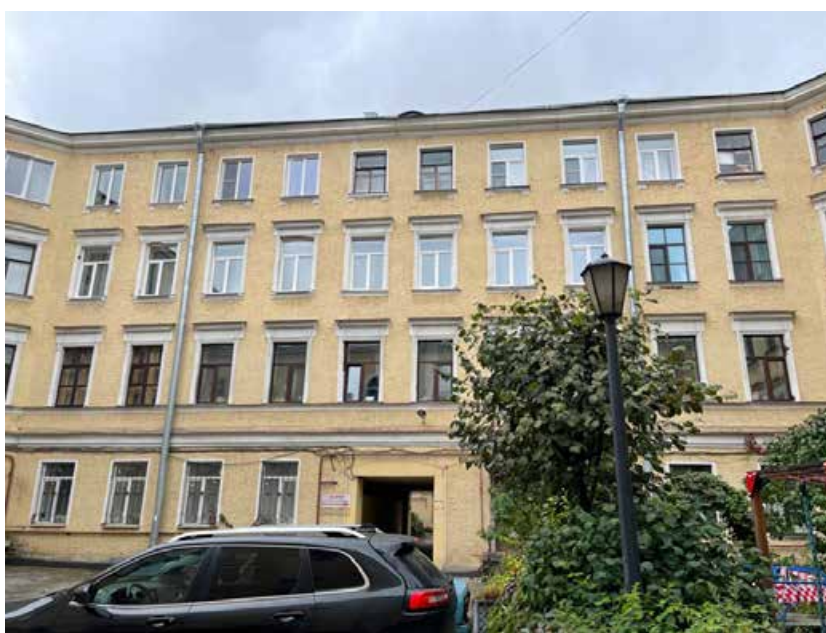
22. Дворовый корпус, первый двор (фрагмент). Выявленный объект культурного наследия «Дом Ю. Н. Адельсон», расположенный по адресу: г. Санкт-Петербург, Гороховая ул, дом 33, литера А
