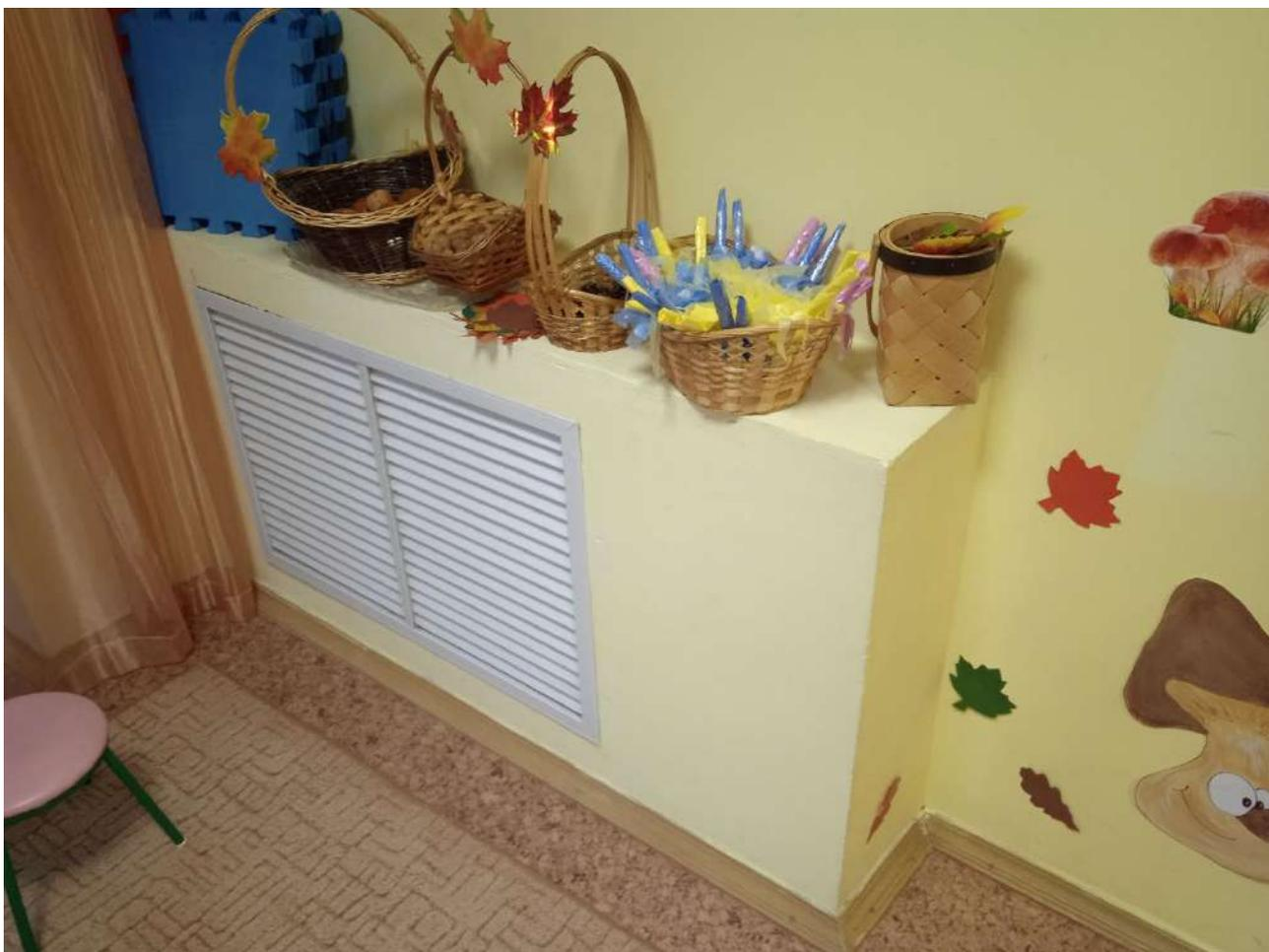
*Фото 61. Помещение 3 Защитный короб радиаторов отопления.*
