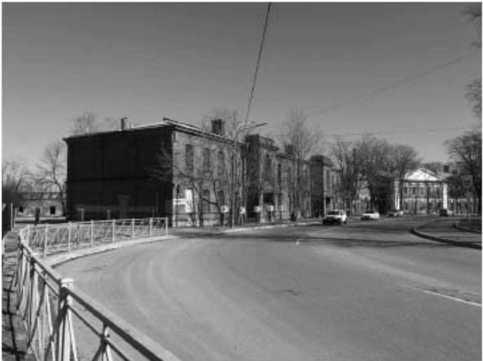
4. Вид на объект культурного наследия «Жилой дом», улица Восстания, дом 17, литера А. Направление съемки северо-восток.
