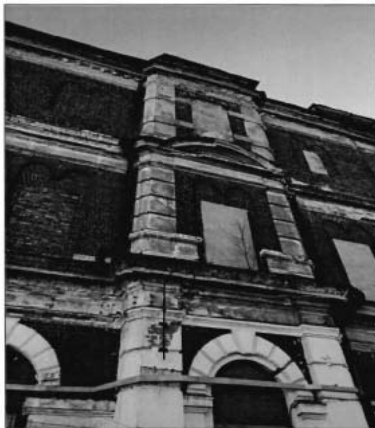
10. Фрагмент западного фасада. Вид с территории объекта.
