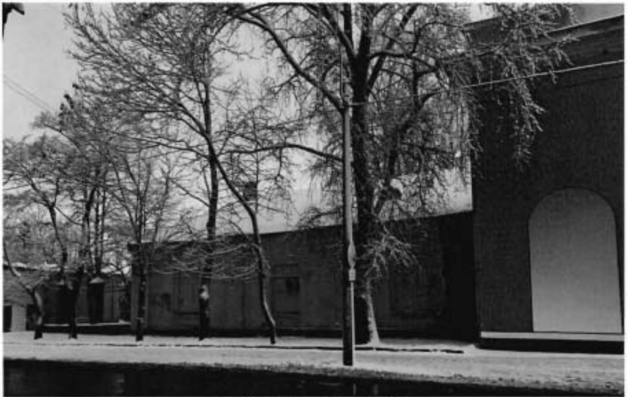
Фото 3. Часть южного фасада.
