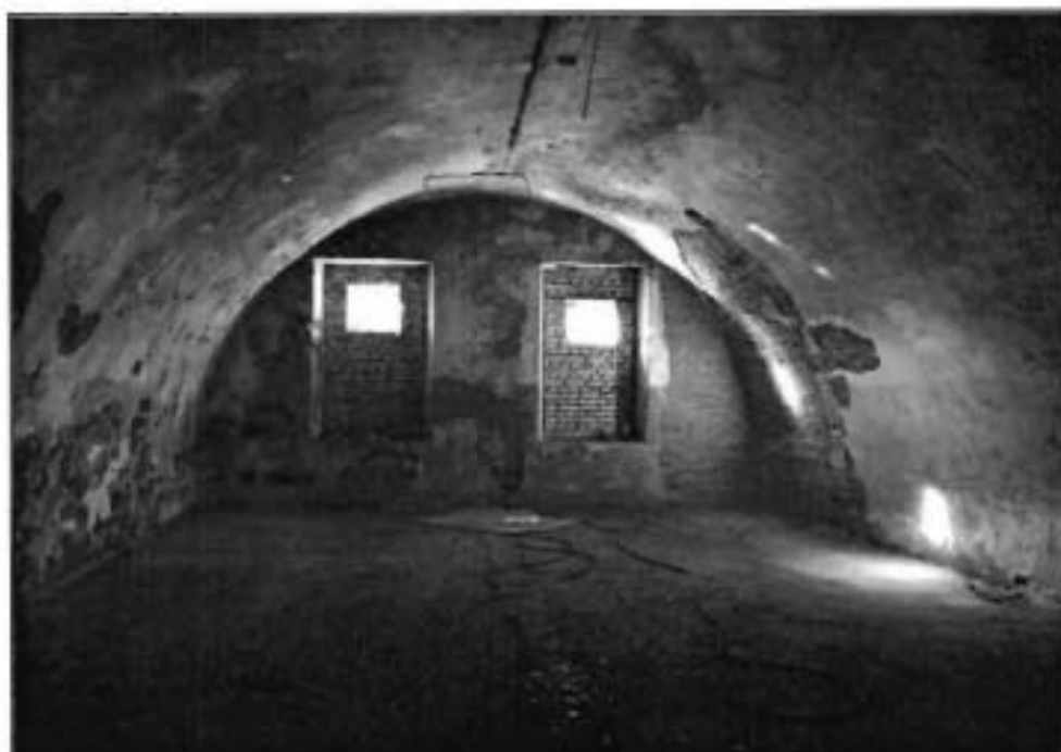
5. Своды основного объема здания.
