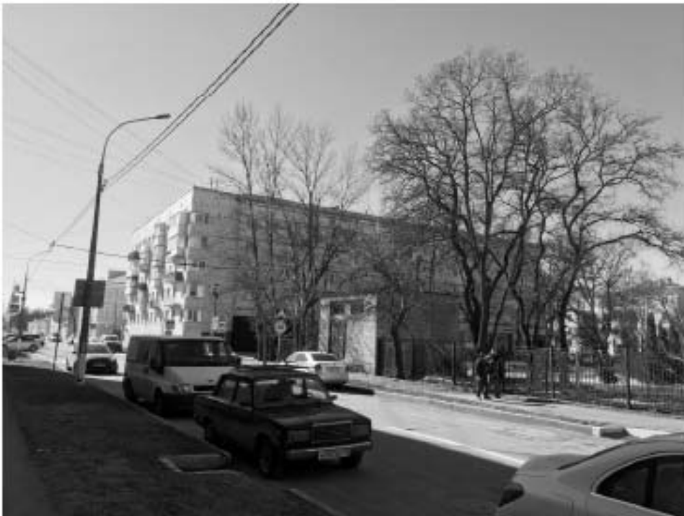
16. Общий вид ул. К. Маркса. Направление съемки юго-запад.
