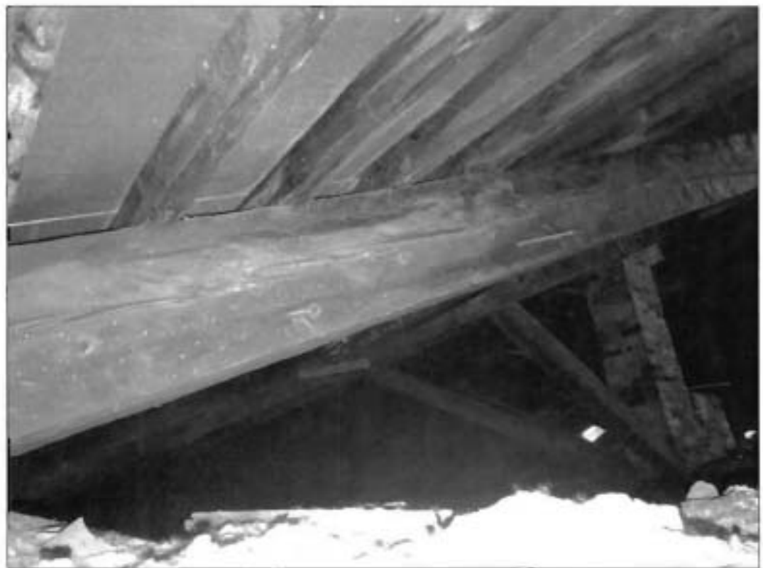
8. Фрагмент стропильной системы.
