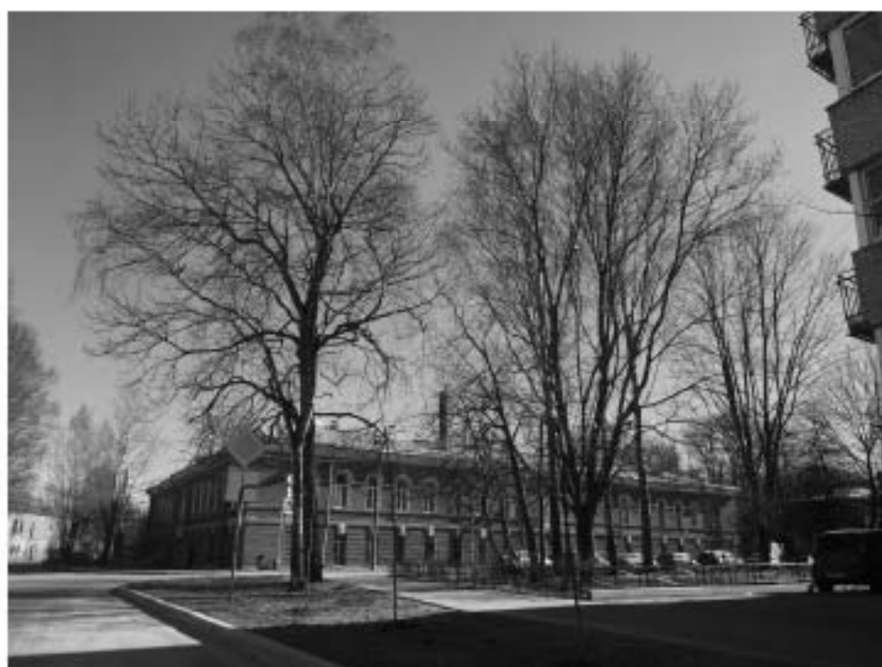
36. Вид объекта культурного наследия «Госпиталь Военно-Морской», улица Мануильского, дом 2, лит. А. Направление съемки юго-восток.
