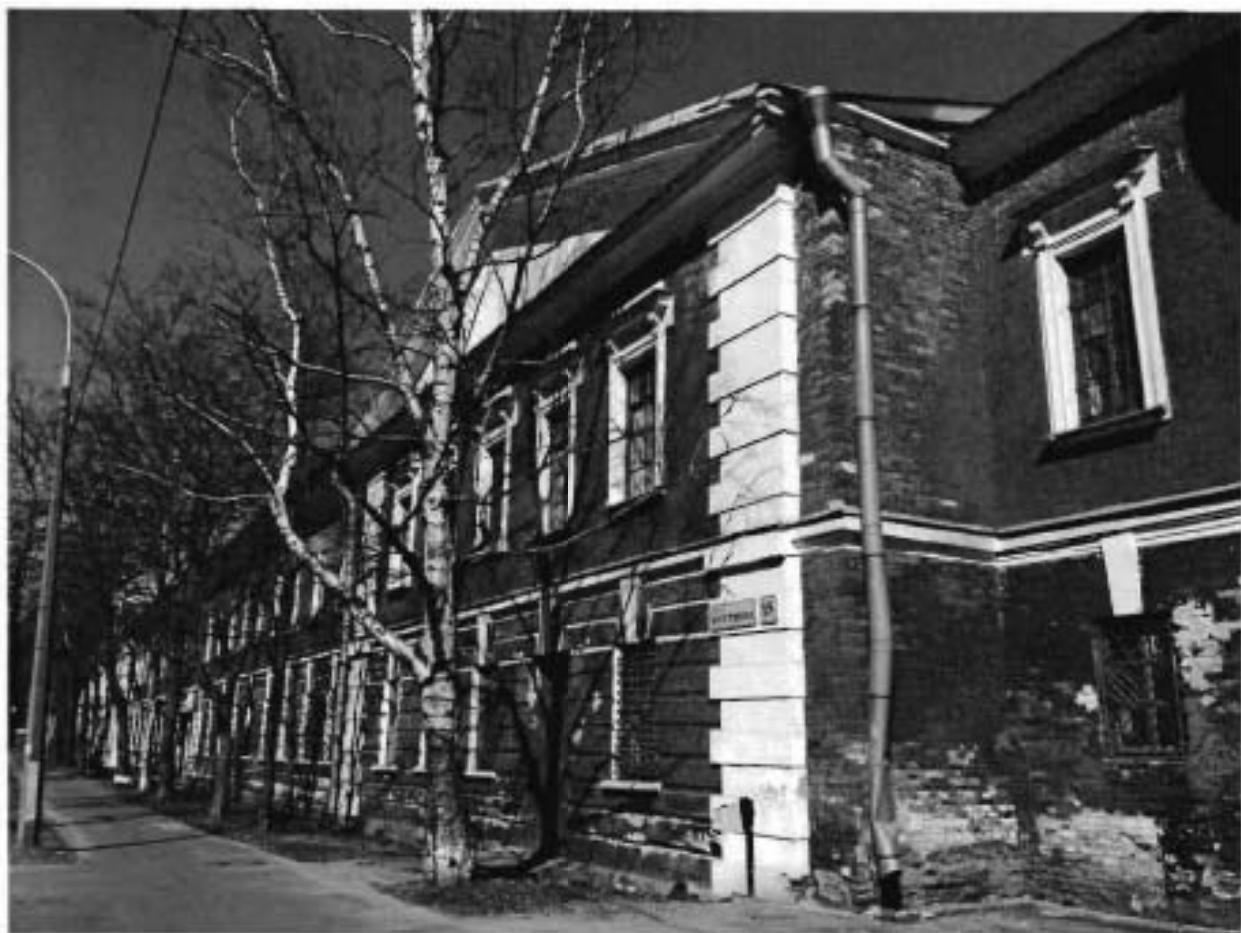
Фото 7. Часть южного фасада.
