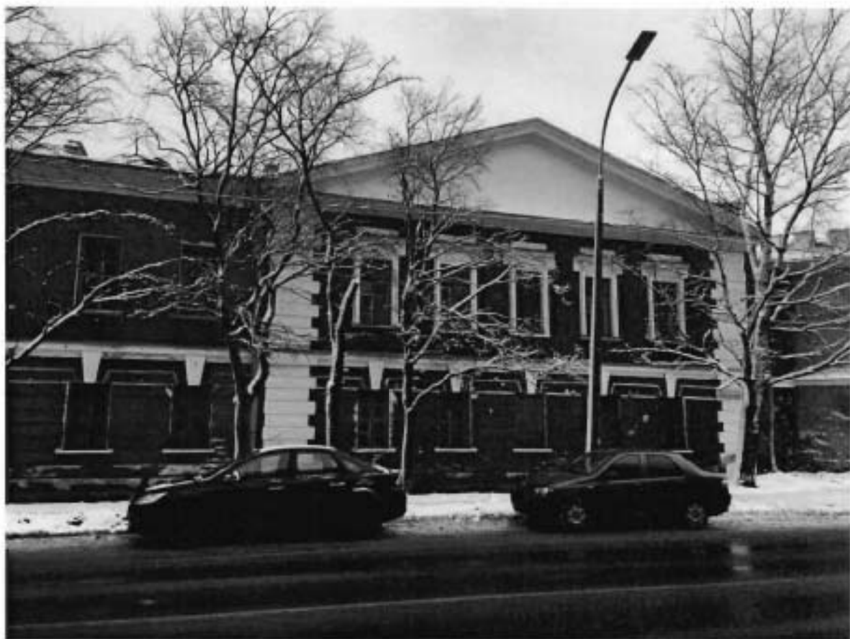
Фото 9. Часть южного фасада.
