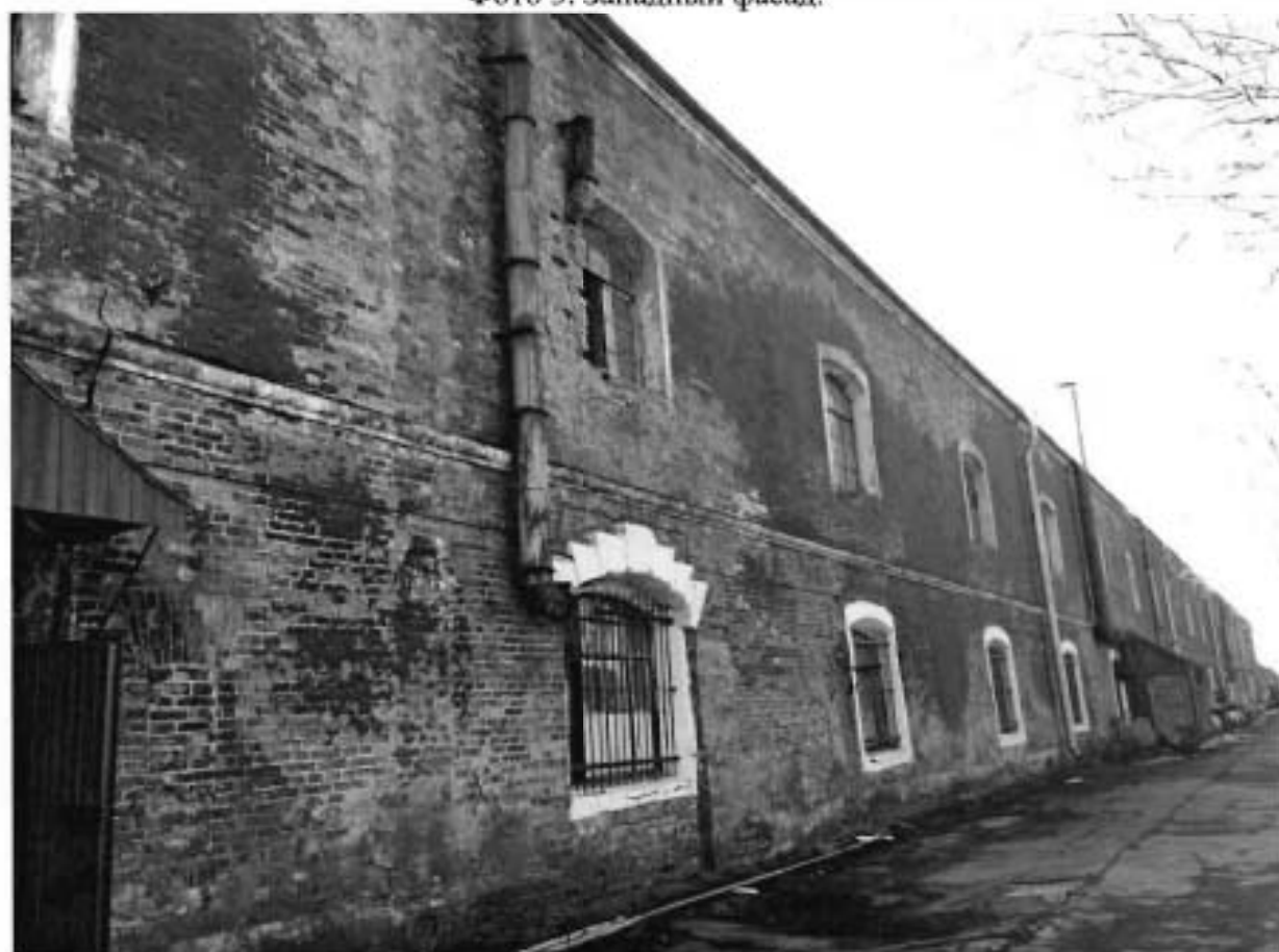
Фото 4. Часть северного фасада.
