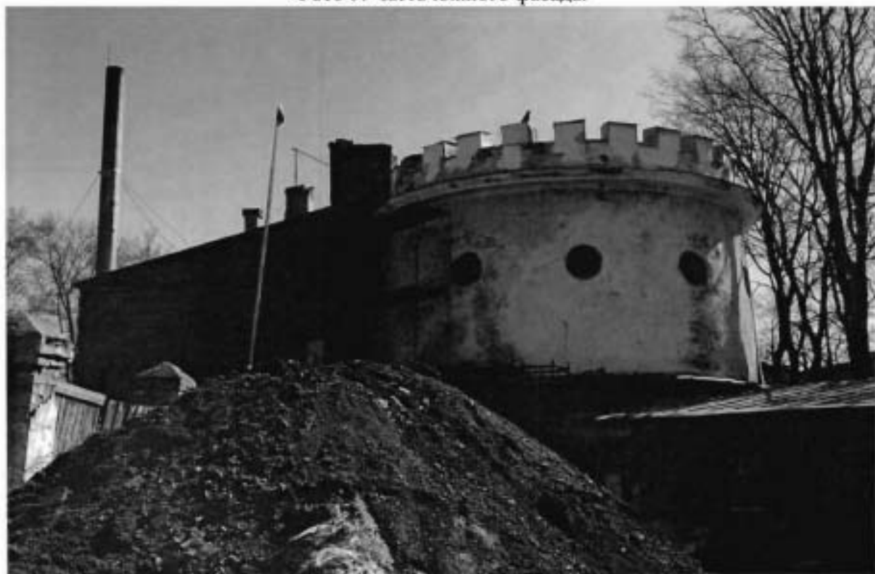
Фото 10. Часть западного фасада. Западная башенная пристройка.
