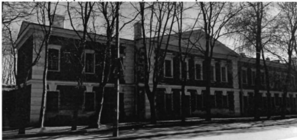
Фото 1. Часть южного фасада.
