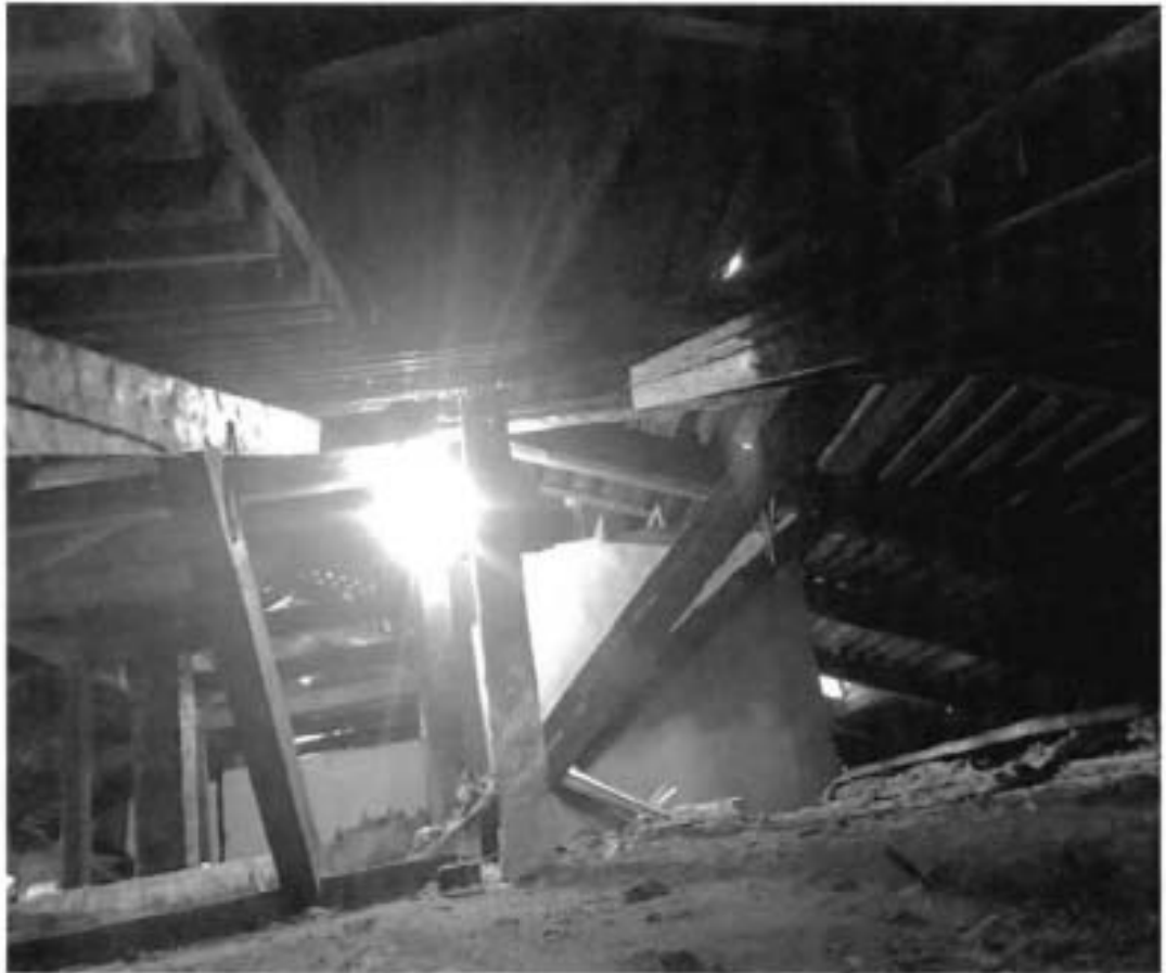
7. Фрагмент стропильной системы.
