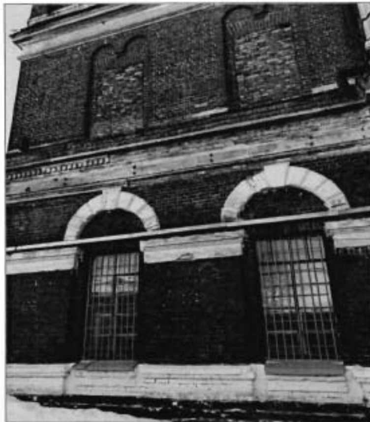
9. Фрагмент западного фасада. Вид с территории объекта.
