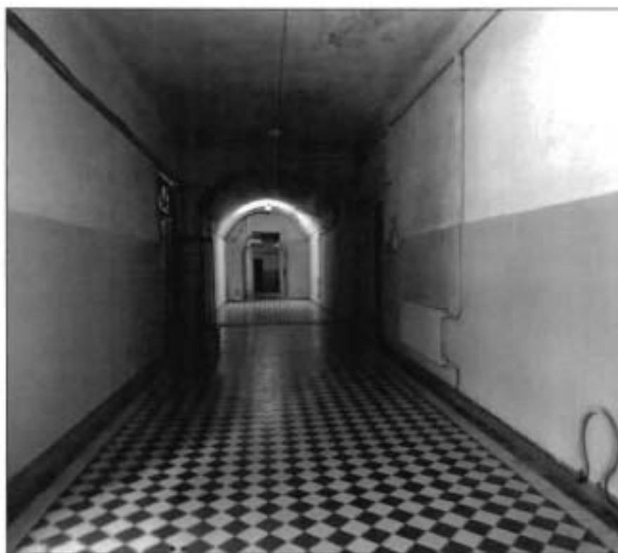
6. Интерьер помещения в уровне первого этажа.
