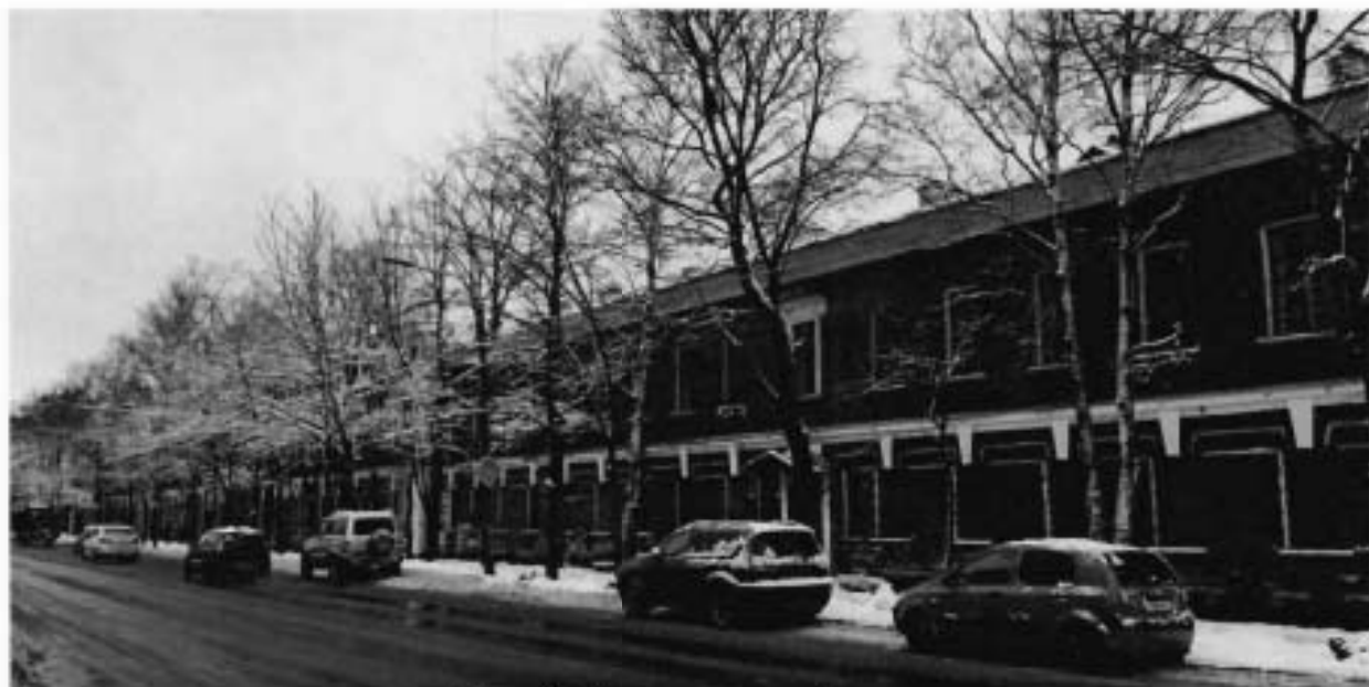
Фото 6. Часть южного фасада.
