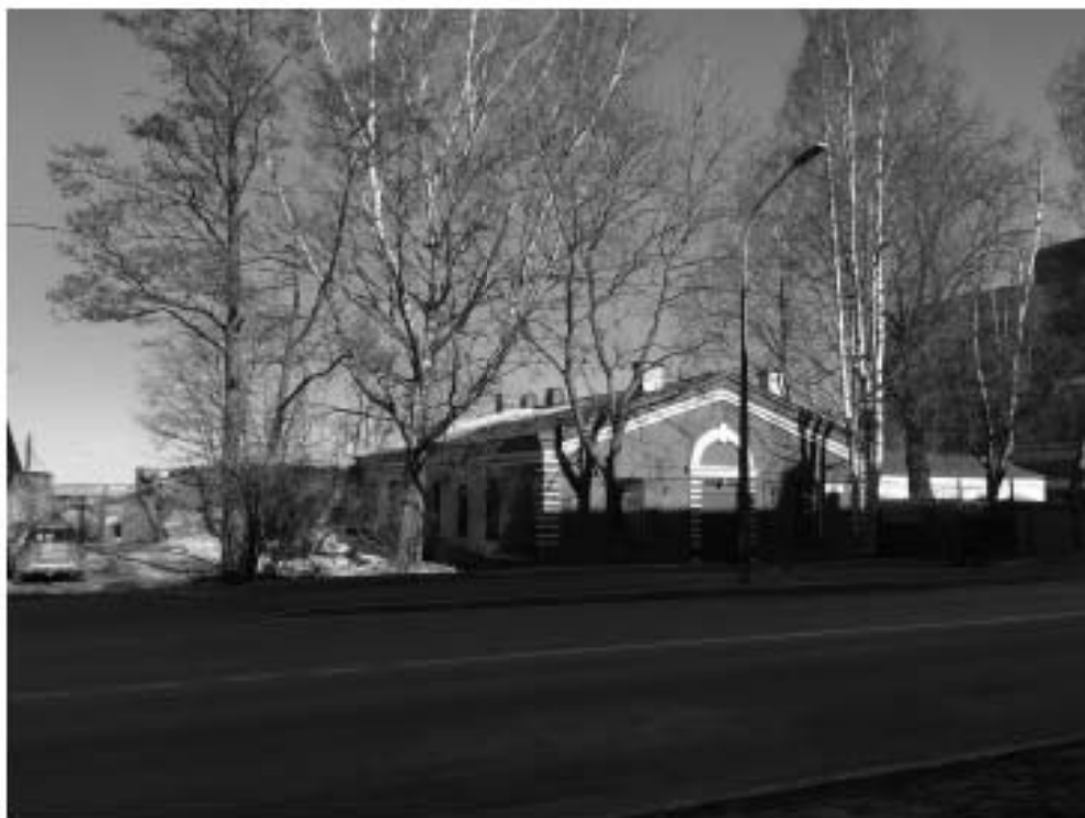
33. Вид объекта культурного наследия «Стена оборонительная», улица Восстания. Направление съемки северо-восток.
