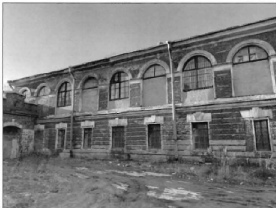
1. Вид на лицевой фасад с дворовой территории объекта культурного наследия.
