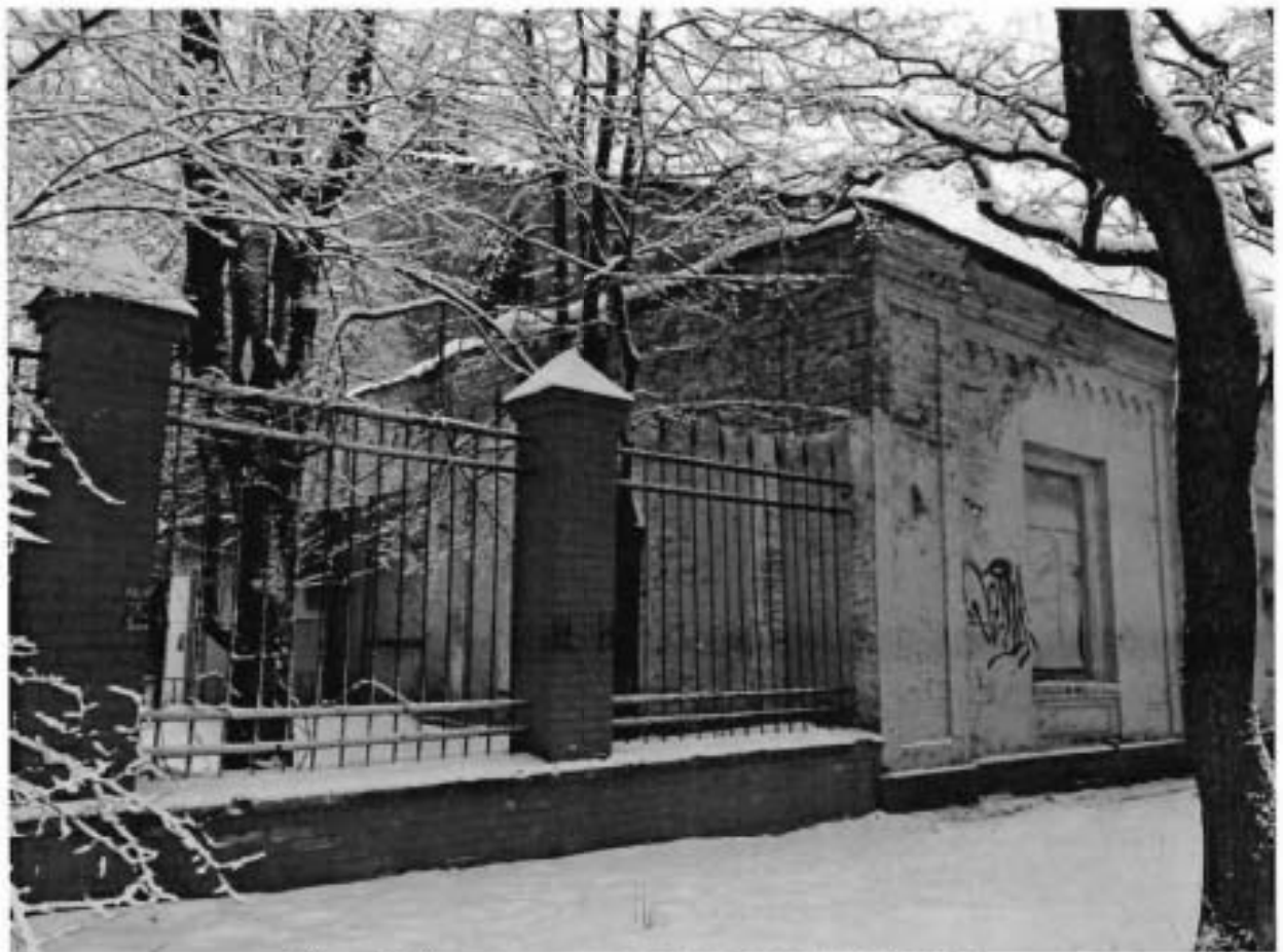
Фото 4. Часть южного и часть западного фасада.
