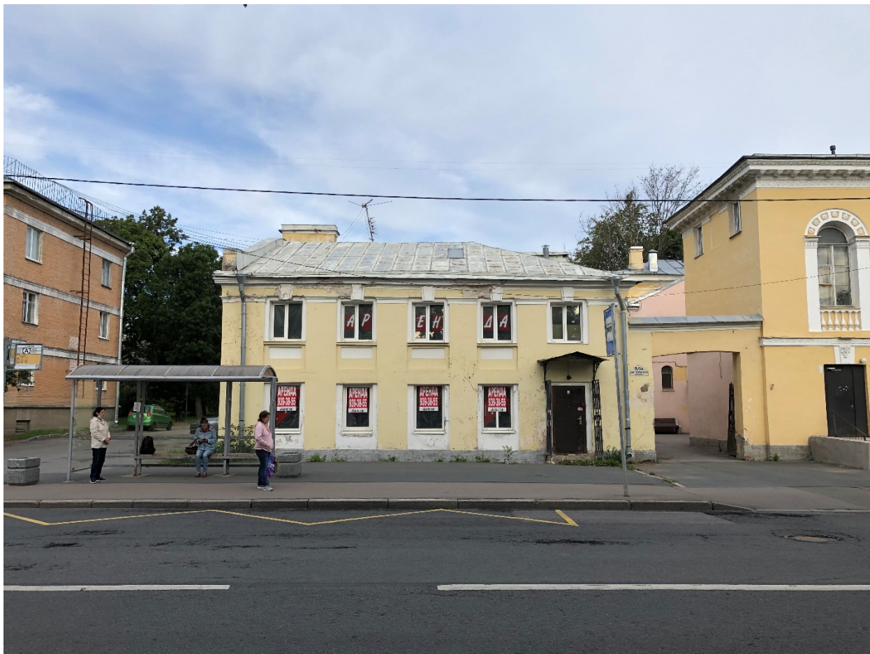
Фото 2. Общий вид лицевого восточного фасада флигеля. Вид с востока.
