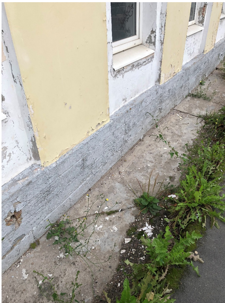
Фото 3. Бетонная отмостка со стороны восточного фасада флигеля.
