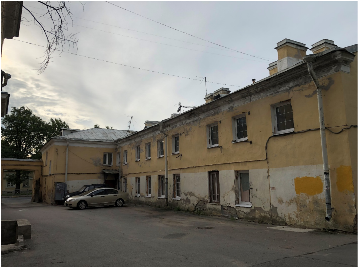
Фото 14. Общий вид северного дворового фасада флигеля. Вид с северо-запада.
