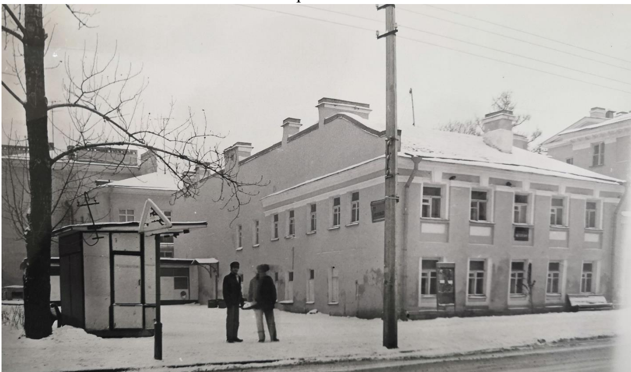
Илл. 13. Флигель жилого дома. Вид на южный и восточный фасады. 1989 г. // Архив КГИОП. П. 215. Пр-1. Часть 2
