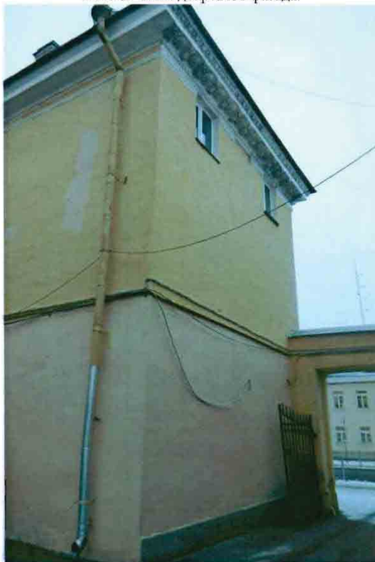
Фото 4. Часть дворового фасада.
