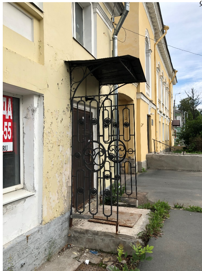
Фото 7. Общий вид позднего кованного металлического ограждения крыльца восточного лицевого фасада. Вид с юго-востока.
