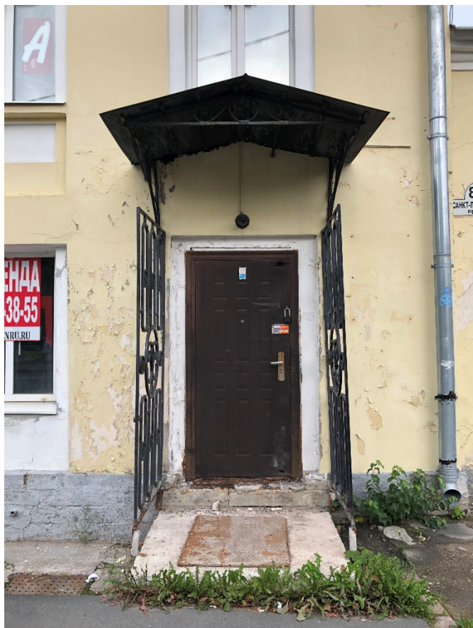
Фото 6. Общий вид крыльца и козырька восточного лицевого фасада. Вид с востока.
