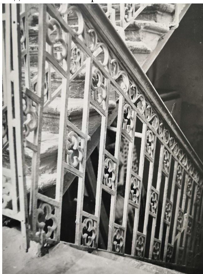
Илл. 19. Флигель жилого дома. Кованное ограждение лестницы главного входа между I и II этажом. 1989 г. // Архив КГИОП. П. 215. Пр-1. Часть 2
