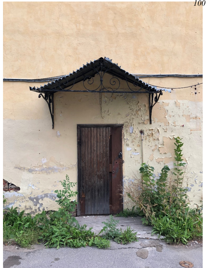
Фото 10. Дверное заполнение и кованый металлический козырек южного дворового фасада флигеля. Вид с юга.
