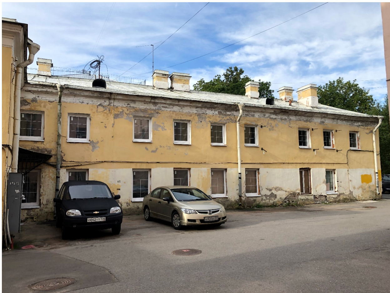
Фото 15. Фрагмент северного дворового фасада флигеля. Вид с севера.
