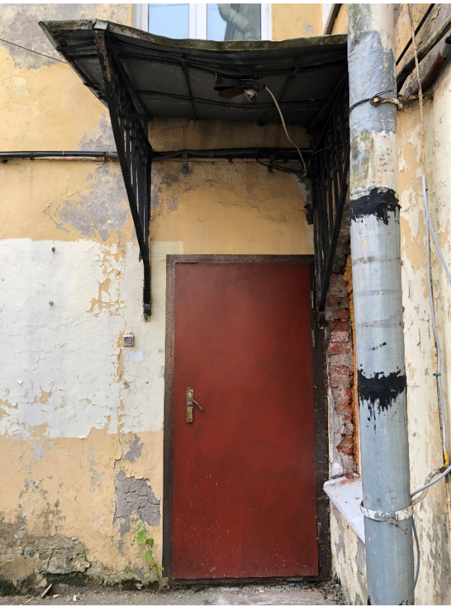
Фото 17. Современное дверное заполнение и кованый металлический козырек западного дворового фасада флигеля. Вид с запада.
