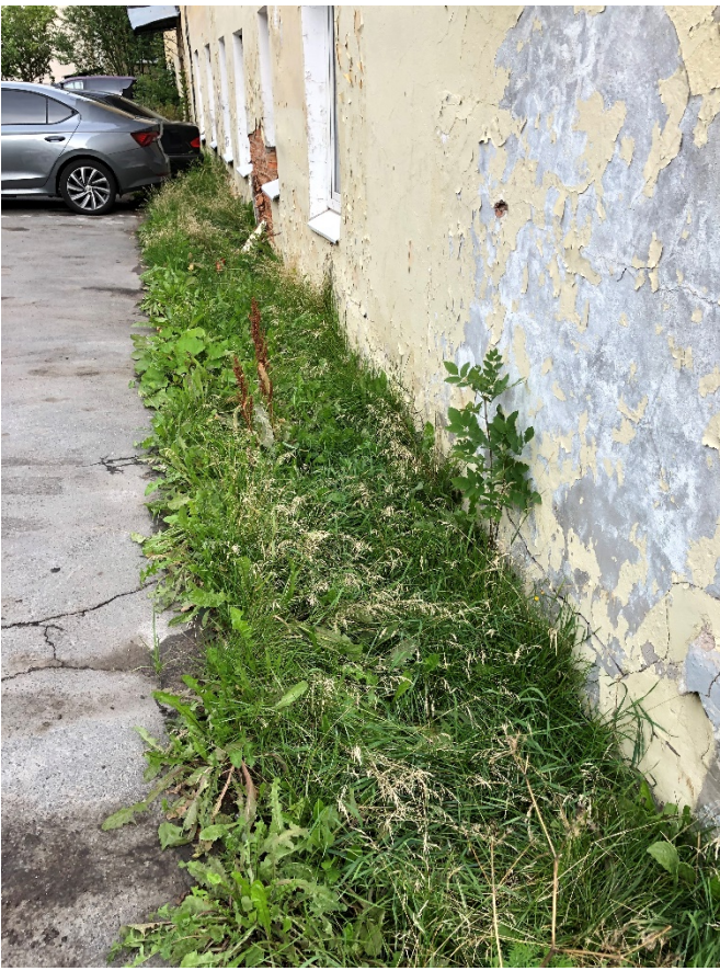
Фото 9. Общее состояние отмостки южного дворового фасада флигеля. Вид с востока.
