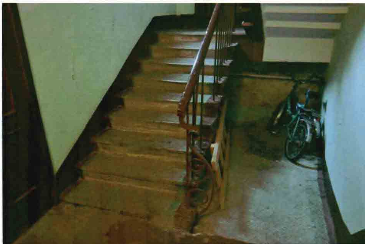
Фото 6. Лестница в первом подъезде.
