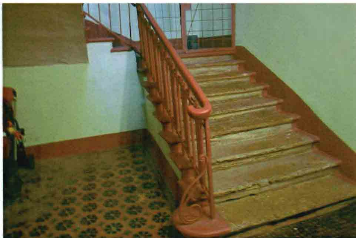
Фото 8. Лестница в третьем подъезде.
