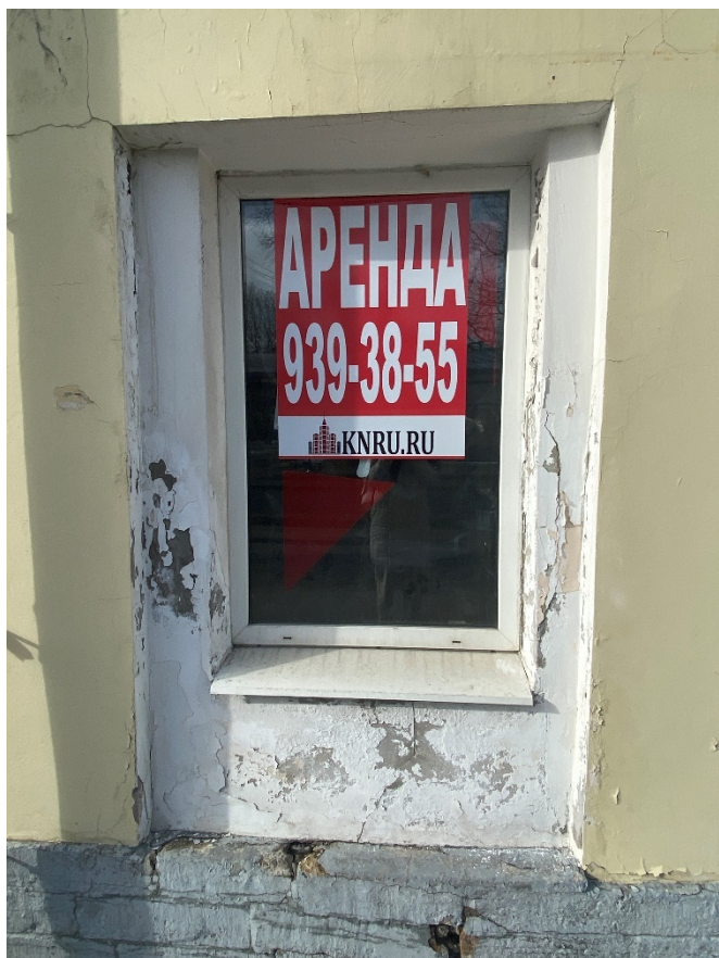
Фото 4. Современное оконное заполнение восточного фасада в уровне 1-го этажа. Вид с востока.
