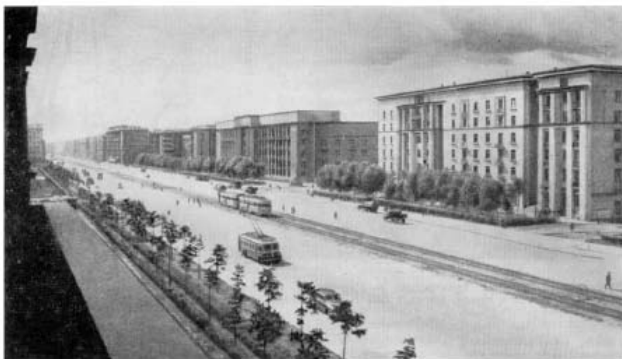
Илл. 20. Застройка Московского проспекта. 1954 г. https://pastvu.com/p/692298
