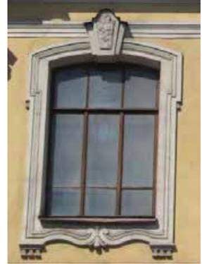
оформление оконных проемов 5-го этажа – профилированные раскрепованные штукатурные наличники, трехчастные замковые камни;
