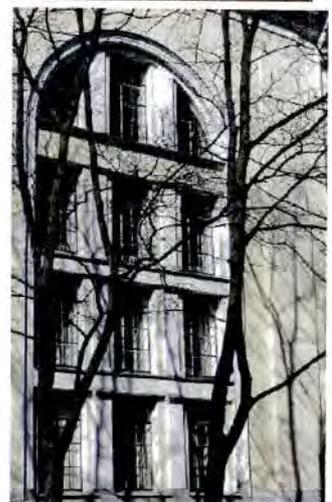
исторические оконные проемы основного объема здания и башен – местоположение, конфигурация (прямоугольные и с полуциркульными завершениями), габариты;
