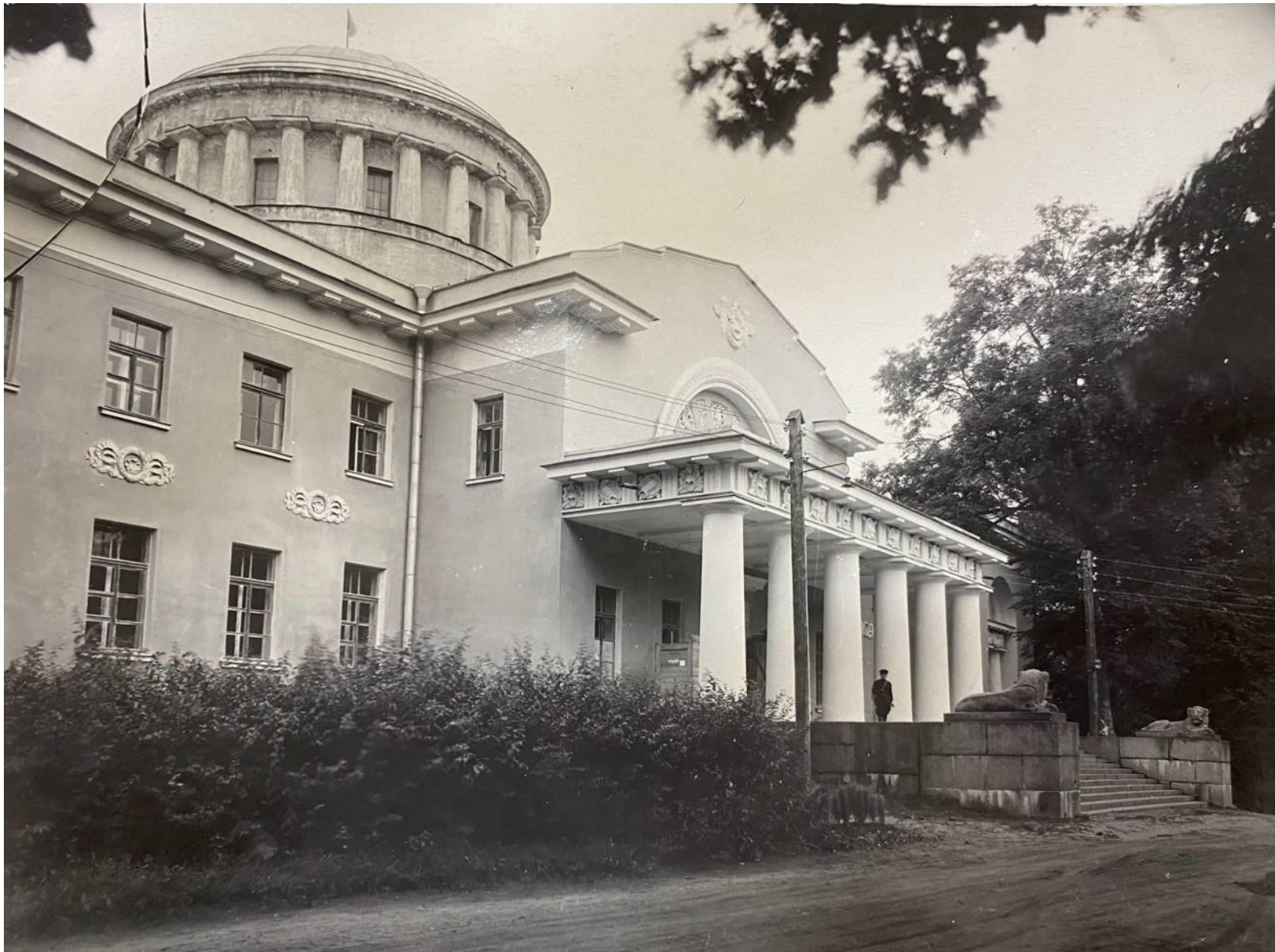
38. Шуваловский парк. Большой дворец. Главный фасад. Вид с северо-востока. Дата: 1953 г. // Архив КГИОП, № 45203.
