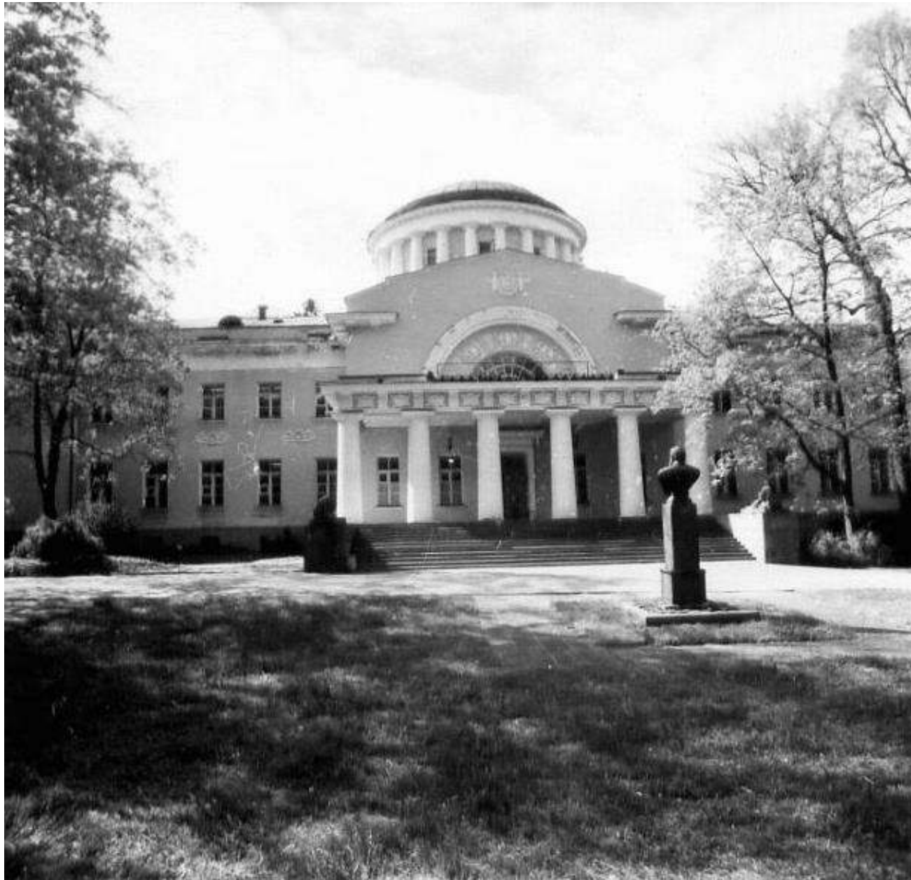
42. Большой дворец в Шуваловском парке - Всероссийский НИИ токов высокой частоты им. В.П. Вологодина. Главный корпус. Дата: 1970-е гг. // https://www.citywalls.ru/photo87743.html
