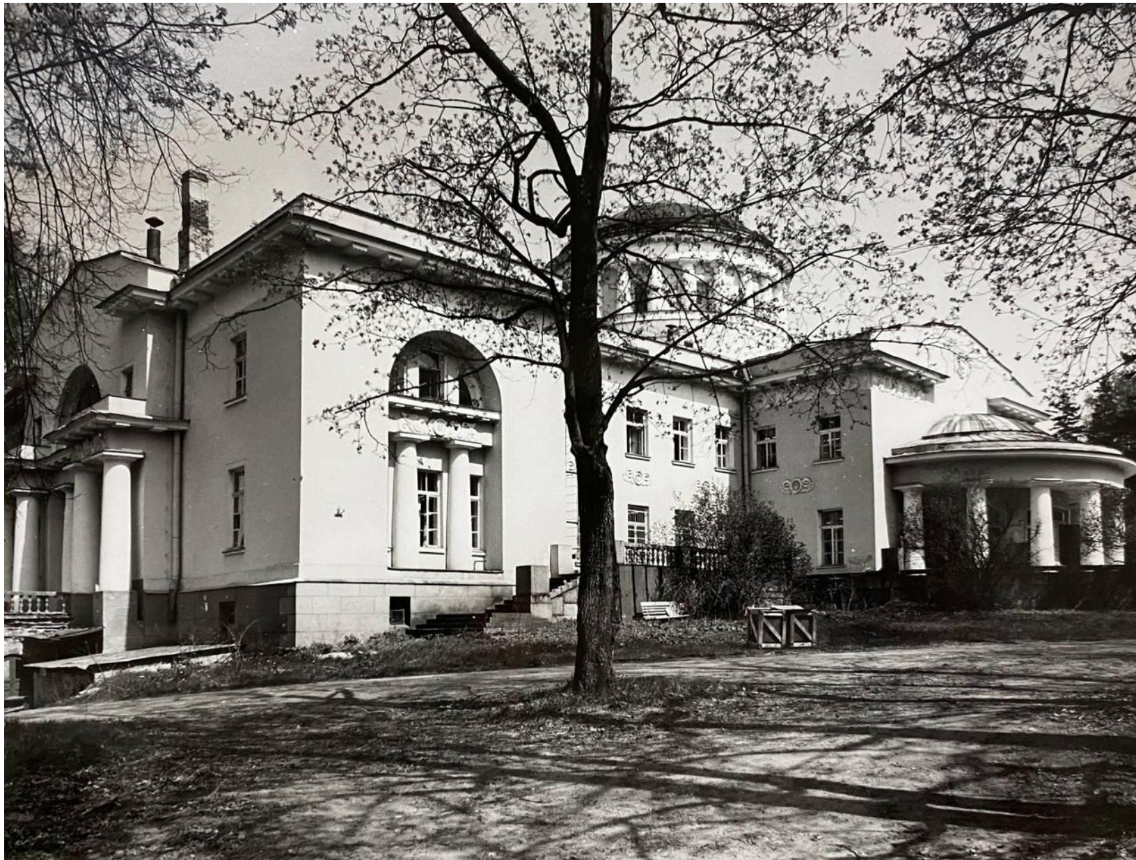
53. Ансамбль усадьбы Шуваловых (Е.А. Воронцовой-Дашковой). Большой дворец. Южный фасад. Вид с юго-запада. Дата: 1985 г. Автор: В.И. Шлакан // Архив КГИОП, № 55297/1-Н.
