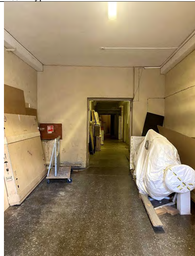
46. Фрагмент пом. 1-Н (51) объекта культурного наследия в уровне 1-го этажа.
