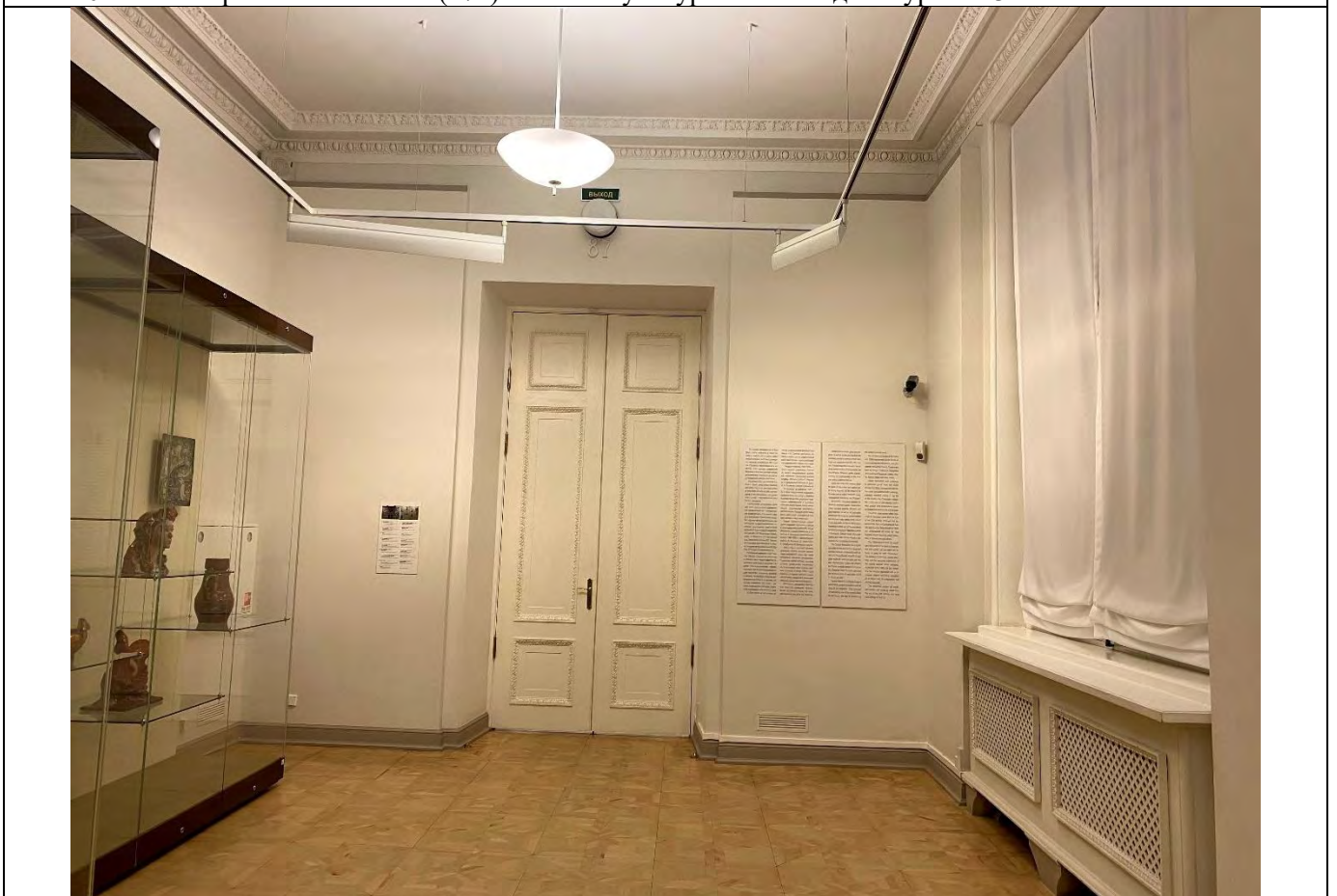
105. Фрагмент пом. 1-Н (174) объекта культурного наследия в уровне 3-го этажа.
