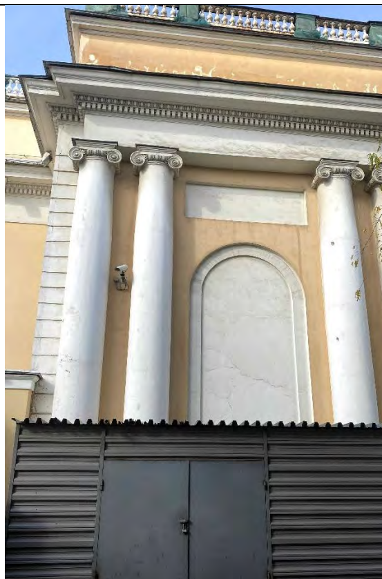
11. Боковой ризалит в южной части восточного лицевого фасада объекта культурного наследия.
