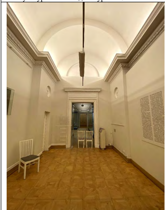
81. Фрагмент пом. 1-Н (182) объекта культурного наследия в уровне 3-го этажа.
