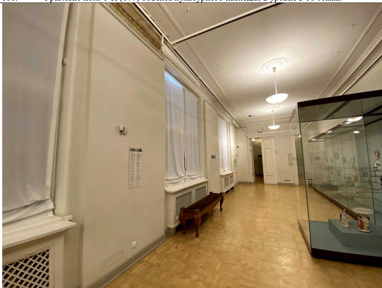
107. Фрагмент пом. 1-Н (178) объекта культурного наследия в уровне 3-го этажа.
