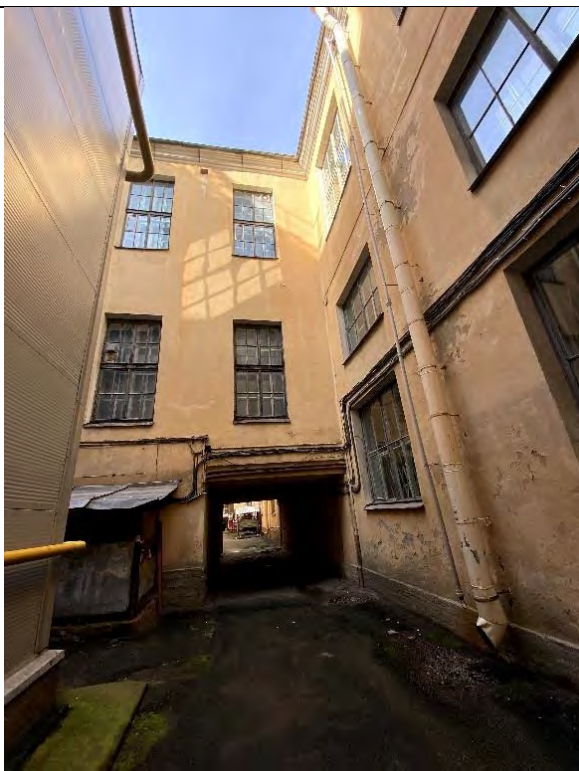
16.Общий вид воротного проезда, соединяющего два северных двора объекта культурного наследия. Вид из северо-восточного двора.
