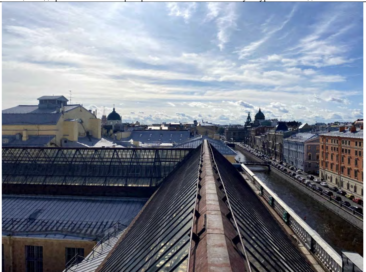
21. Фрагмент крыши и светового фонаря северной части объекта культурного наследия.
