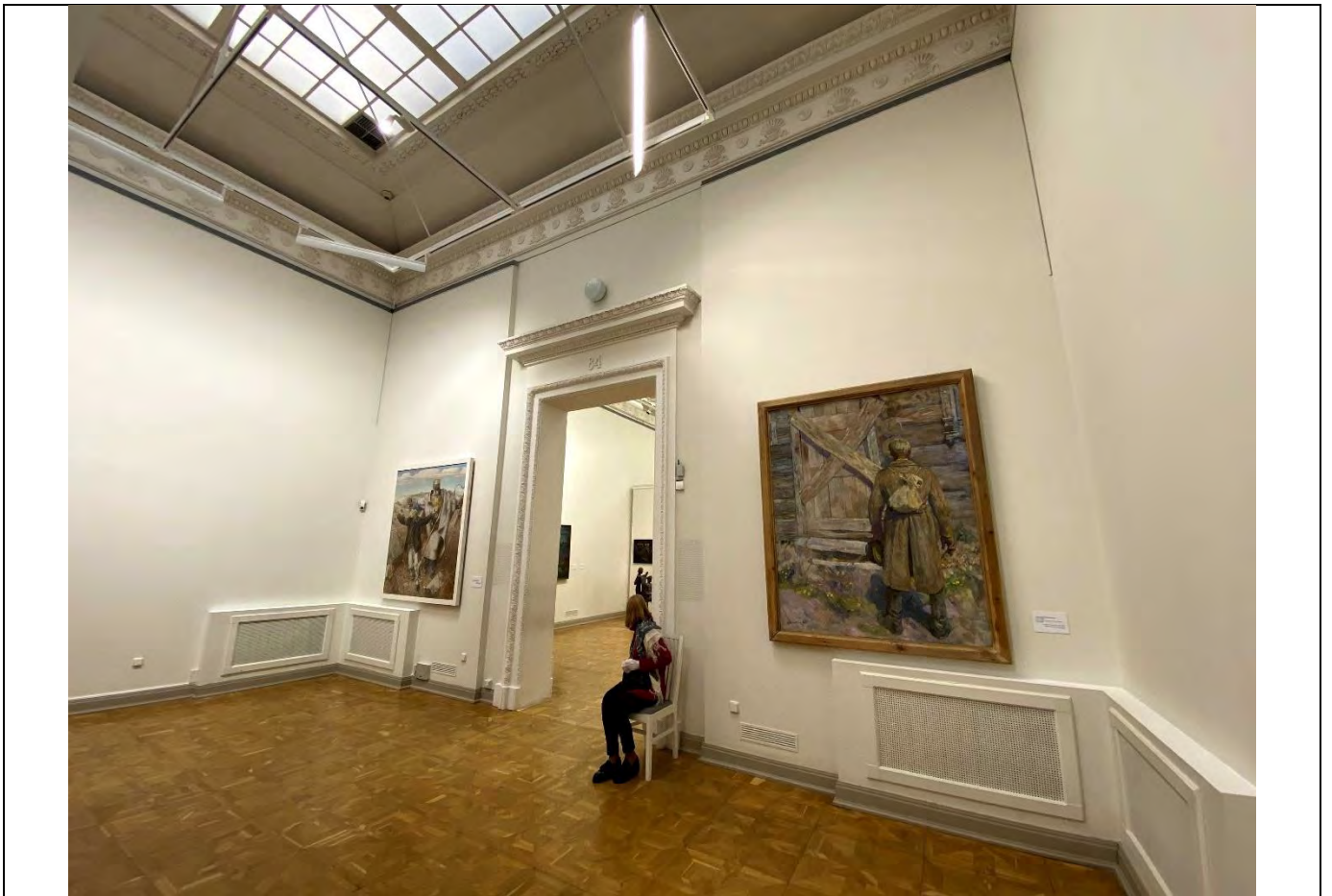
112. Фрагмент пом. 1-Н (152) объекта культурного наследия в уровне 3-го этажа.
