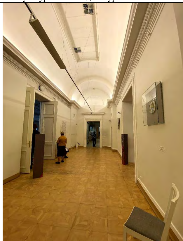
82. Фрагмент пом. 1-Н (182) объекта культурного наследия в уровне 3-го этажа.
