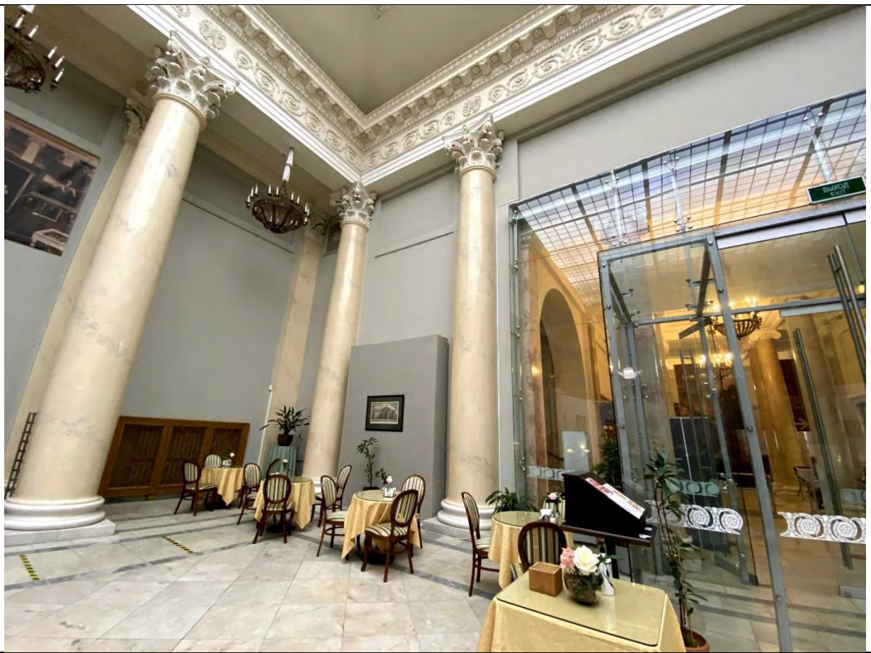
37. Фрагмент пом. 1-Н (8) объекта культурного наследия в уровне 1-го этажа.
