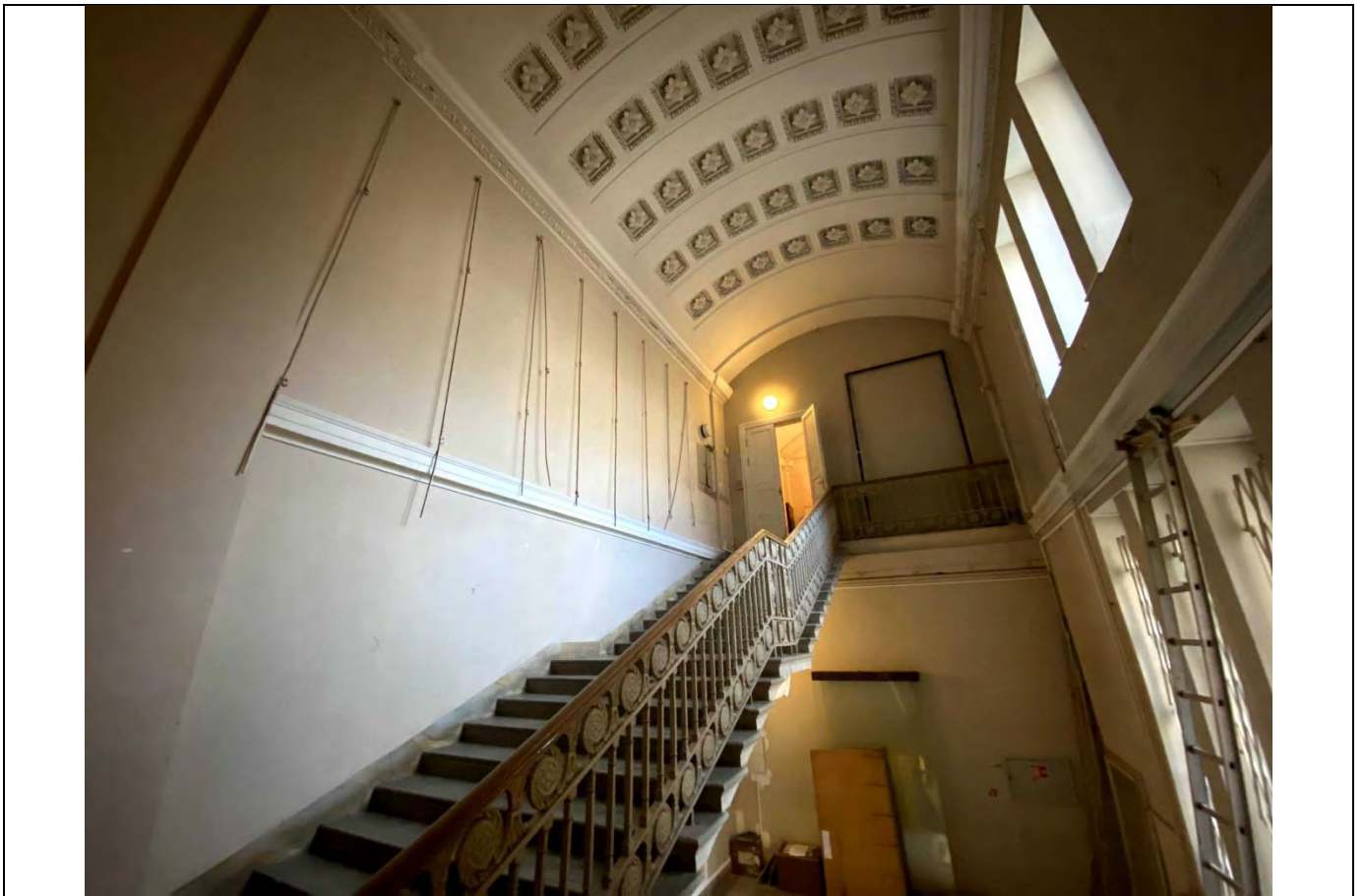
120. Фрагмент лестницы в пом. 1-Н (210) объекта культурного наследия в уровне 2-го этажа.
