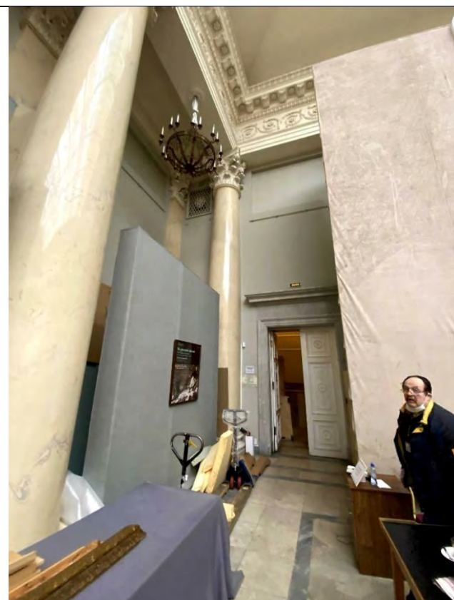
40. Фрагмент пом. 1-Н (8) объекта культурного наследия в уровне 1-го этажа.
