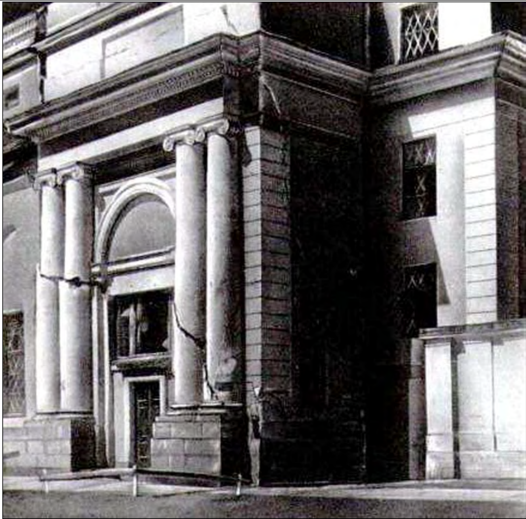
17. Фрагмент фасада корпуса Бенуа по Инженерной улице с разрушениями вследствие попадания фашистских снарядов и бомб. Фотография военного времени.
