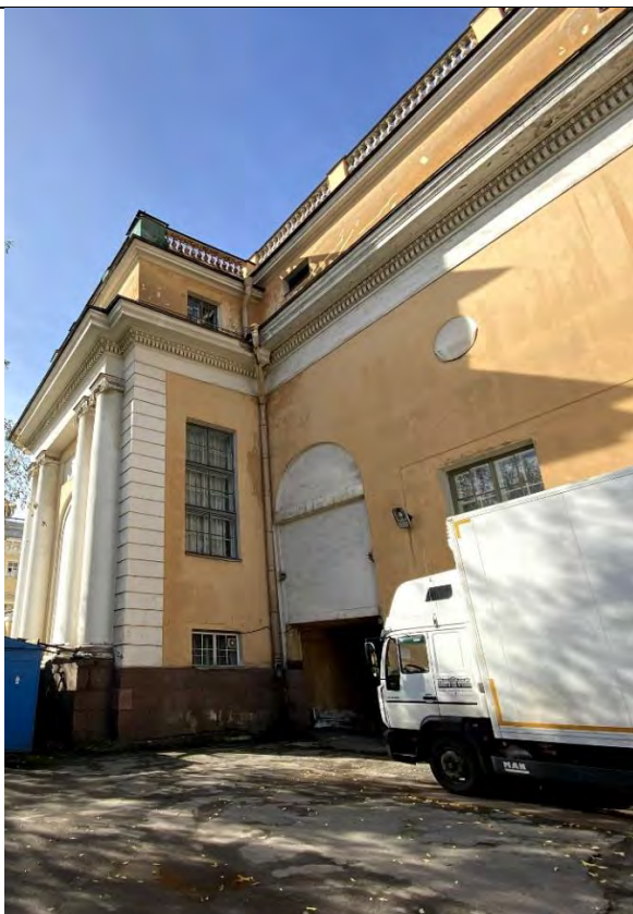
10. Фрагмент южной части восточного лицевого фасада объекта культурного наследия.
