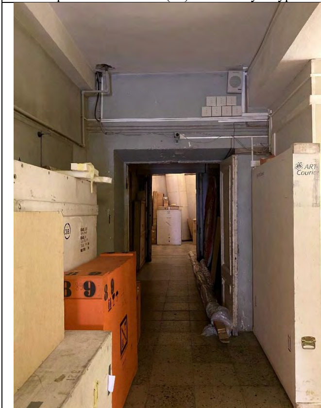
45. Фрагмент пом. 1-Н (40) объекта культурного наследия в уровне 1-го этажа.
