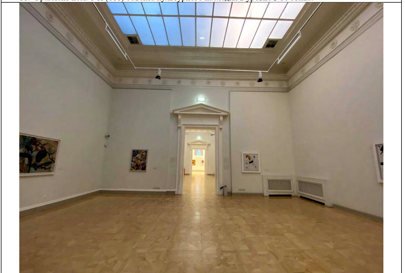
87. Фрагмент пом. 1-Н (165) объекта культурного наследия в уровне 3-го этажа.
