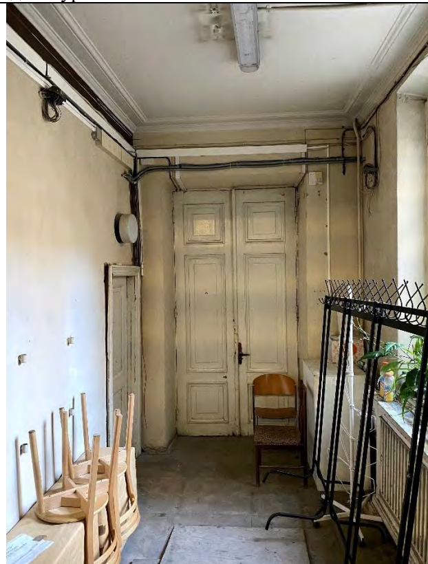
34. Фрагмент пом. 1-Н (25) объекта культурного наследия в уровне 1-го этажа.
