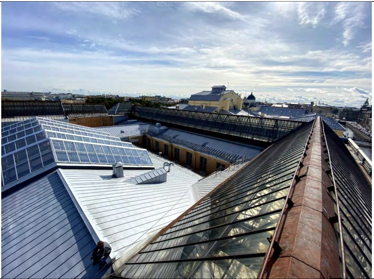
20. Общий вид крыши и световых фонарей южной части объекта культурного наследия.
