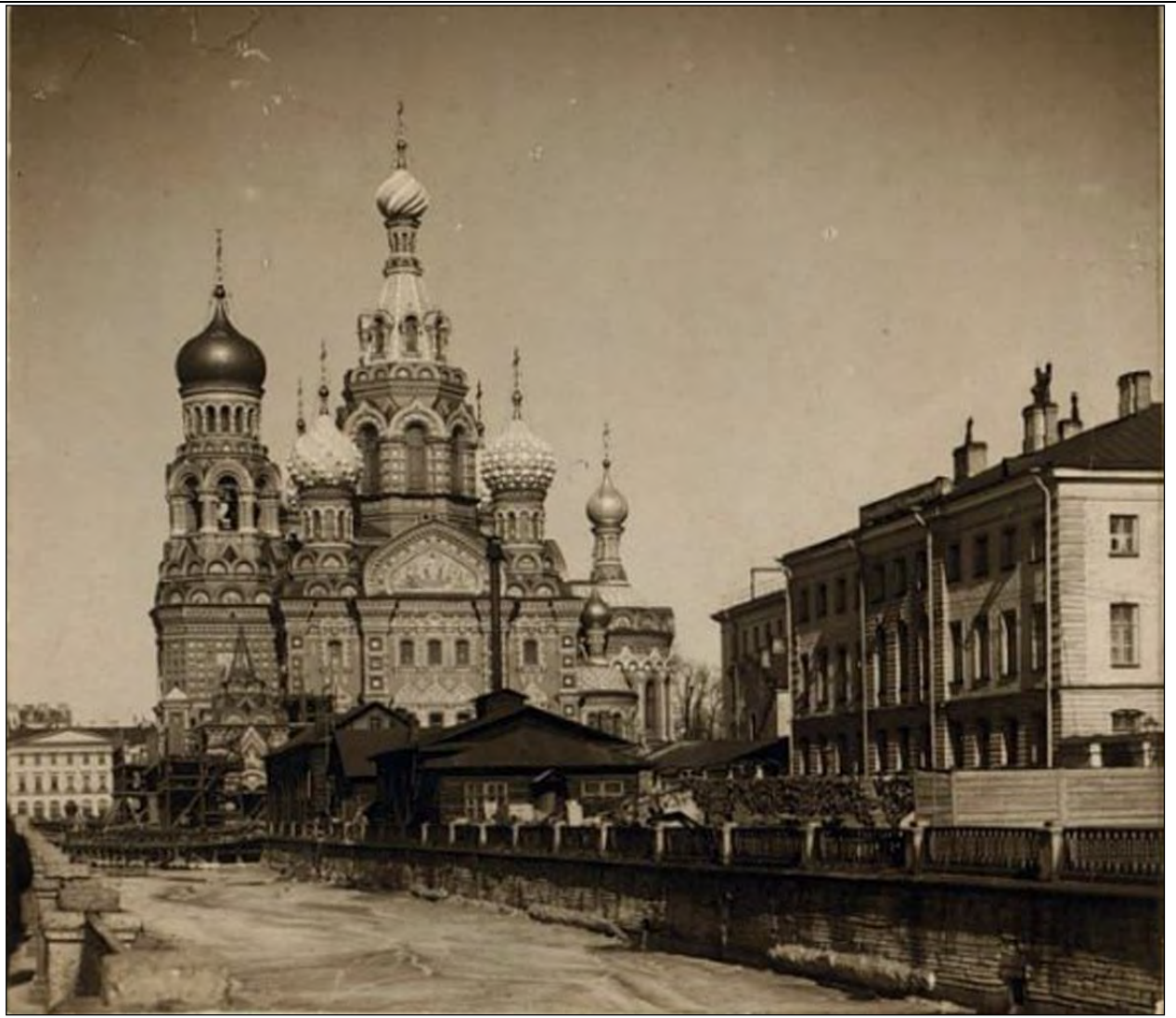
13. Набережная Екатерининского канала (ныне канала Грибоедова). Справа — здание Государственной типографии. Фотография 1910-х гг.
