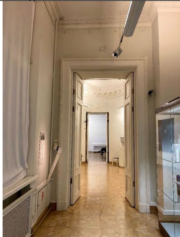
78. Фрагмент пом. 1-Н (187) объекта культурного наследия в уровне 3-го этажа.
