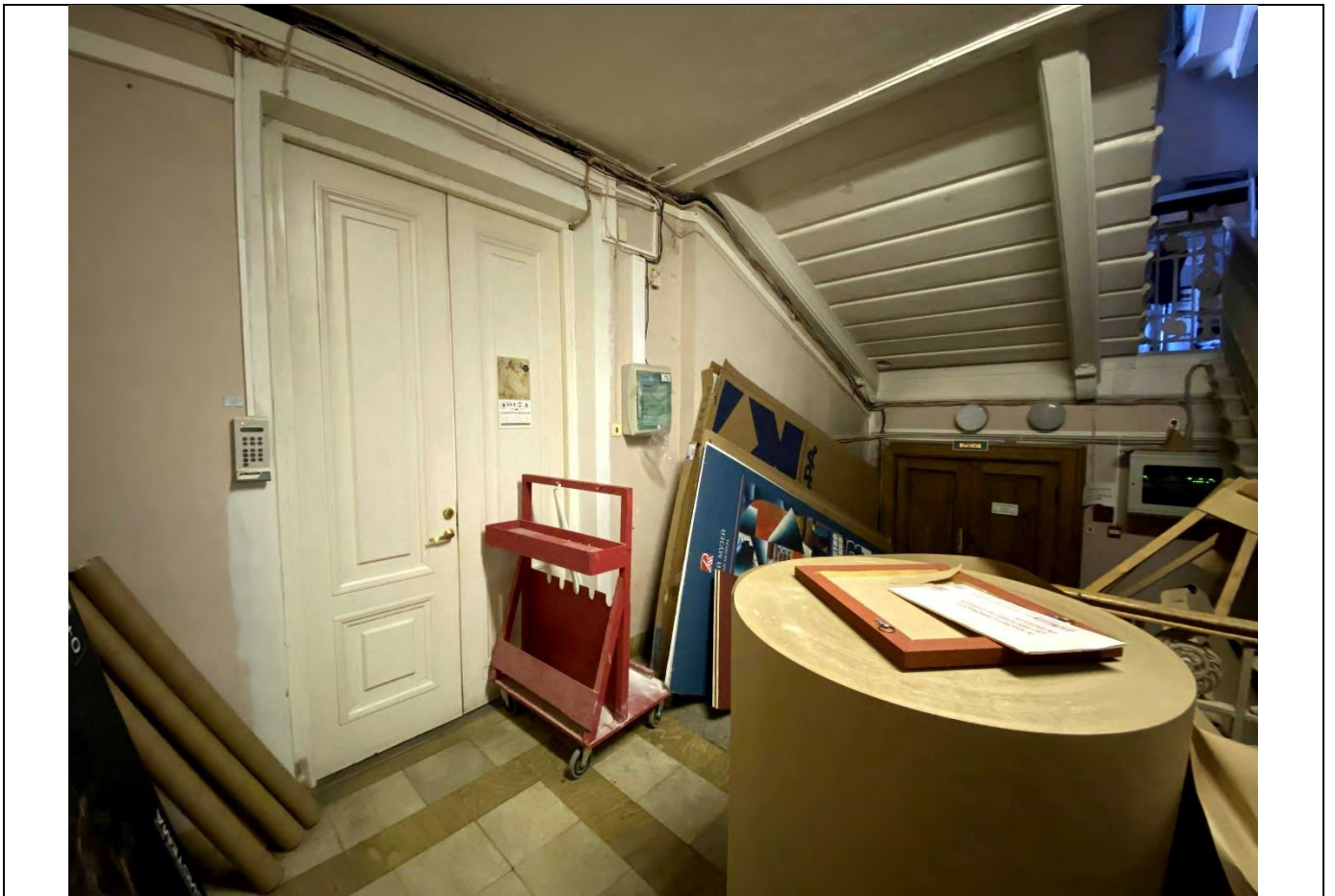
42. Фрагмент пом. 1-Н (34) объекта культурного наследия в уровне 1-го этажа.
