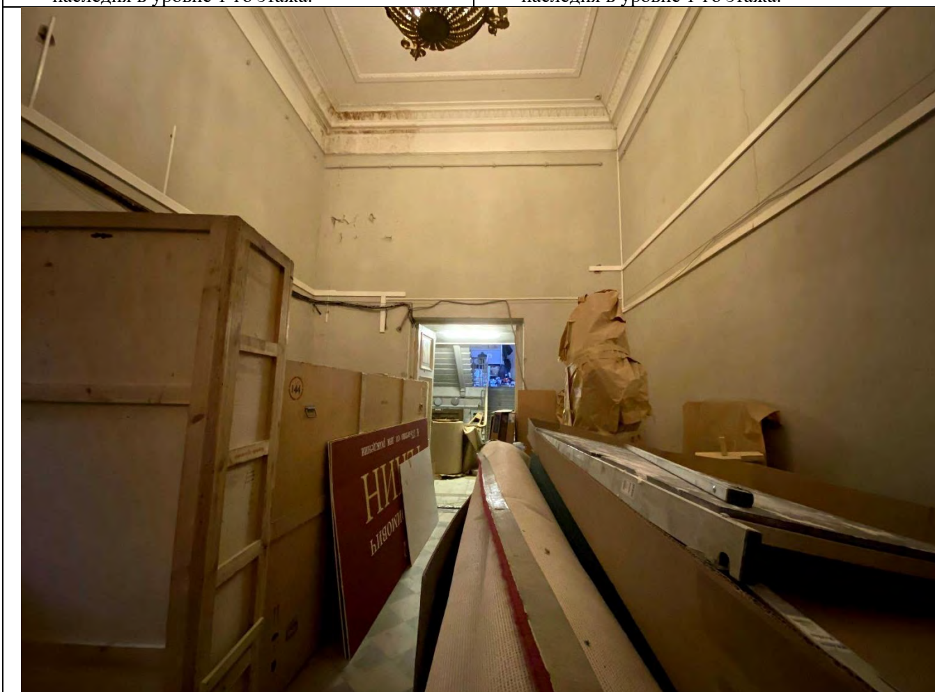
41. Фрагмент пом. 1-Н (37) объекта культурного наследия в уровне 1-го этажа.
