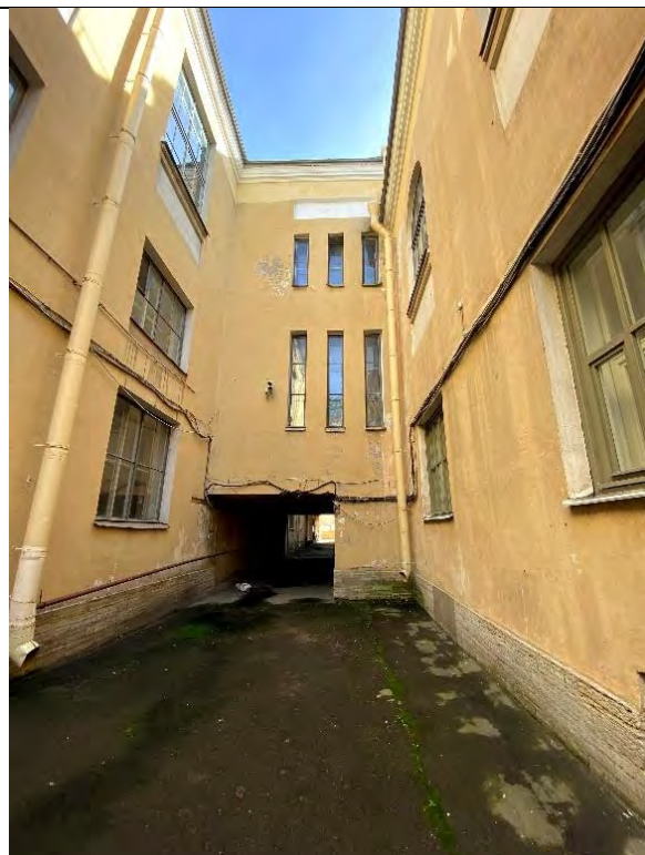
17.Общий вид воротного проезда, соединяющего два северных двора объекта культурного наследия. Вид из северо-западного двора.
