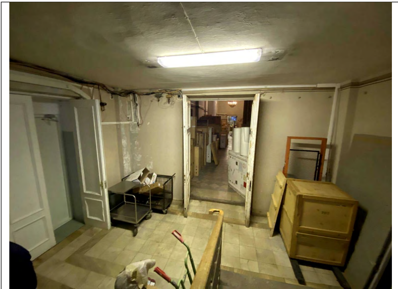
44. Фрагмент пом. 1-Н (61) объекта культурного наследия в уровне 1-го этажа.
