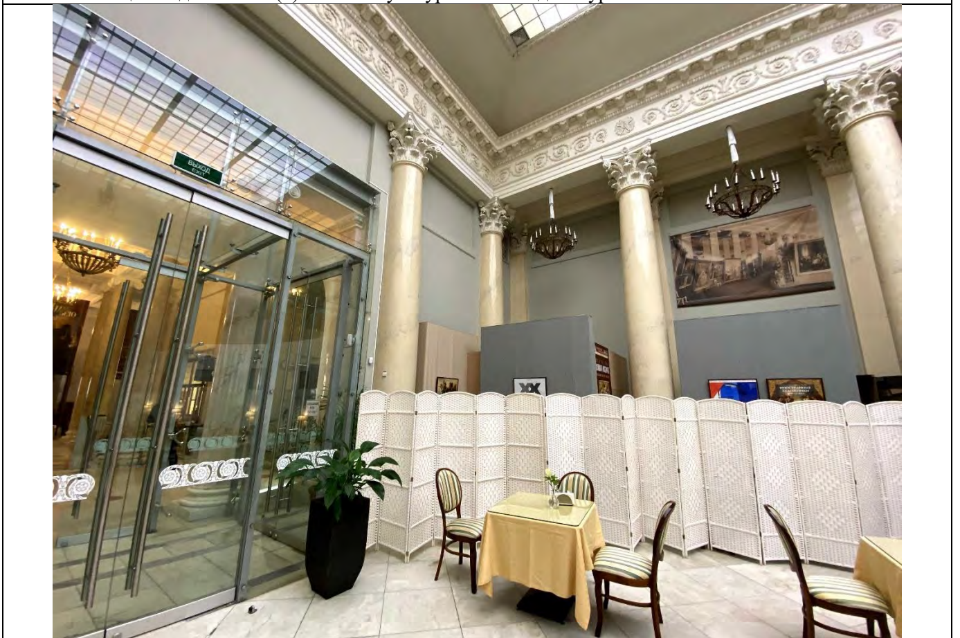
36. Фрагмент пом. 1-Н (8) объекта культурного наследия в уровне 1-го этажа.
