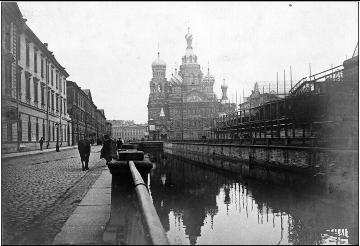
14. Набережная Екатерининского канала (ныне канала Грибоедова). Справа — корпус Бенуа (Дворец искусств) в процессе строительства. Фотография сделана в мае 1916 г. французским министром Альбером Тома.
