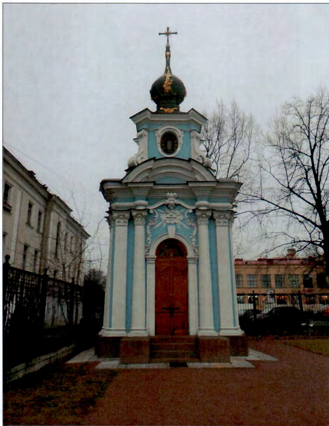
42. «Часовня». Южный фасад.
