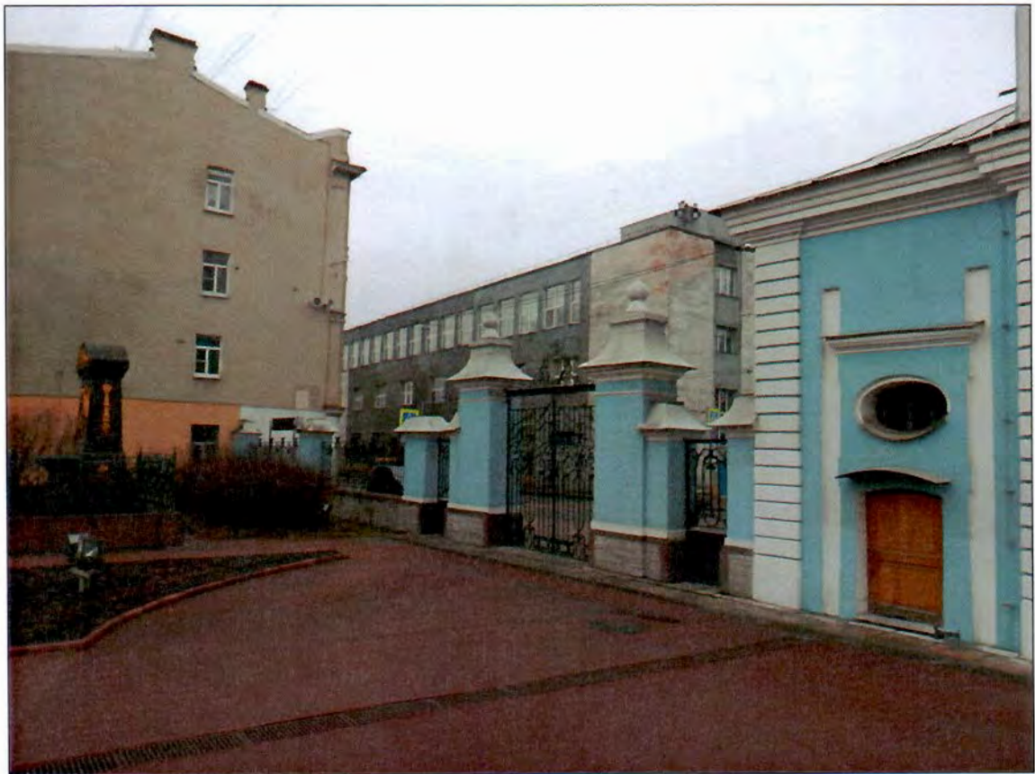
14. Вид на южную часть ограды из сада.
