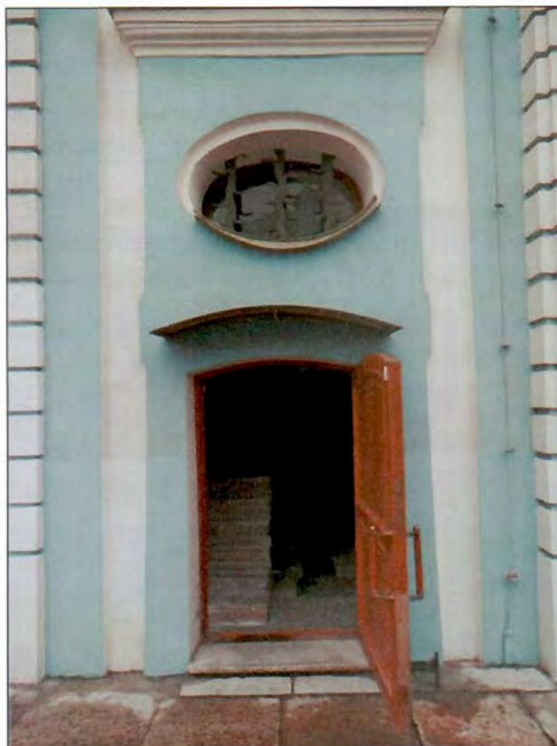
2. «Колокольня». Восточный фасад. Фрагмент.
