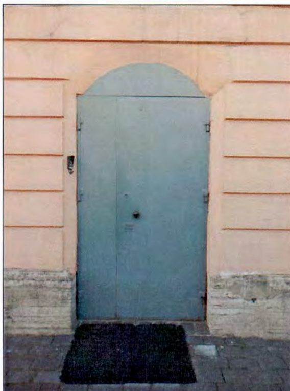
47. «Юбилейный домик». Дверной проем.
