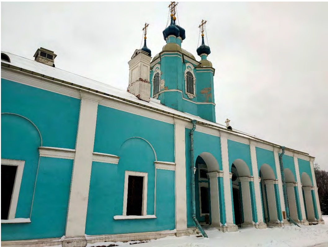
2. «Собор Сампсониевский», расположенный по адресу: г. Санкт-Петербург, Большой Сампсониевский пр., д. 41, лит. А. Южный фасад. Общий вид. Фото 17.11.2022г.
