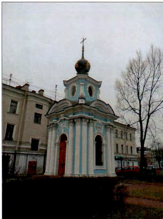
43. «Часовня». Вид с юго-востока.
