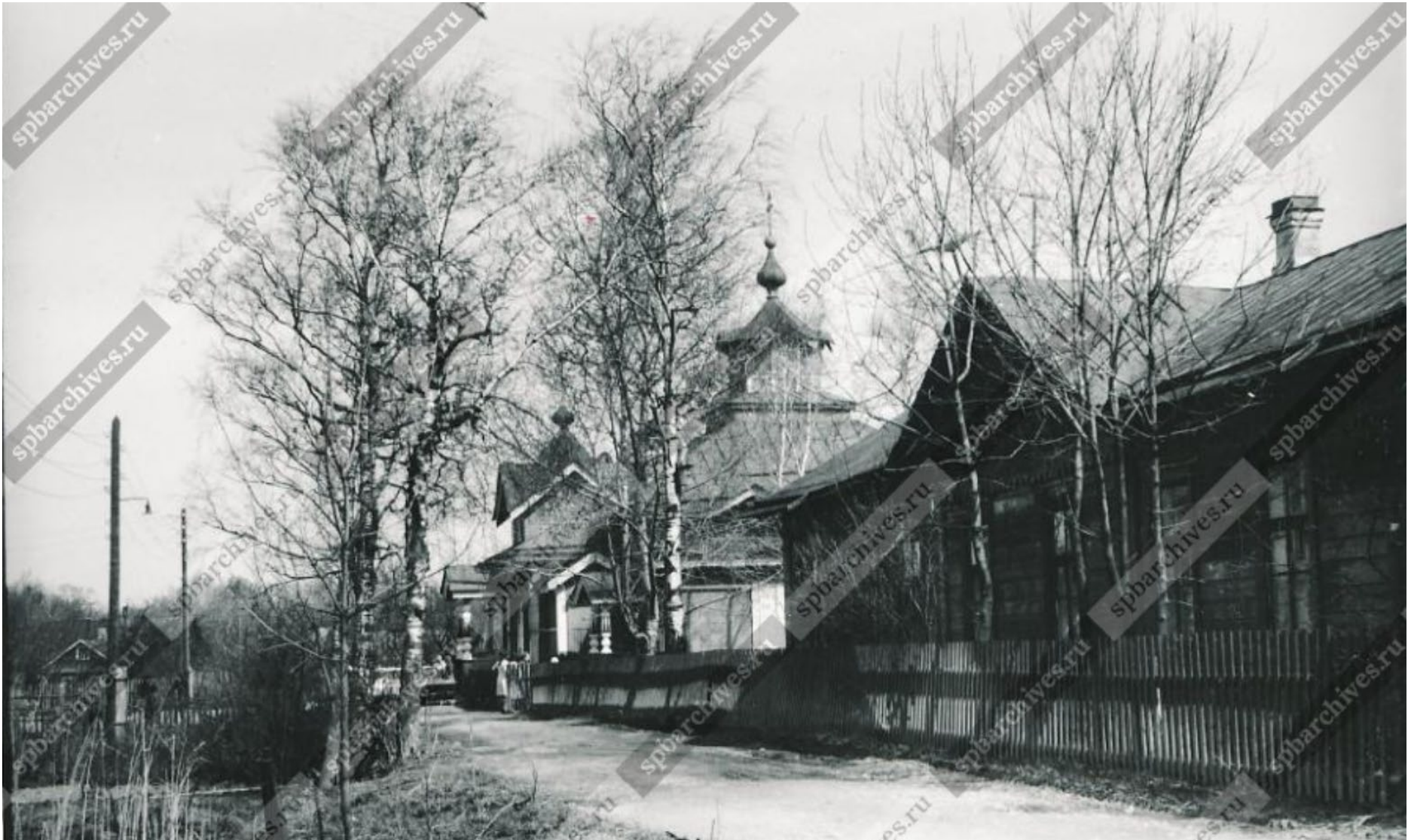
Илл. 36. Перспектива улицы Юрия Пасторова в сторону переулка Щуппа в Красном Селе. Справа церковь Святого Благоверного князя Александра Невского по адресу переулок Щуппа, 10 (архитектор В.А.Колянковский, 1890 год). Дата съемки: май 1979 г. // ЦГАКФФД СПб. Архивный шифр: Ар 230512.
