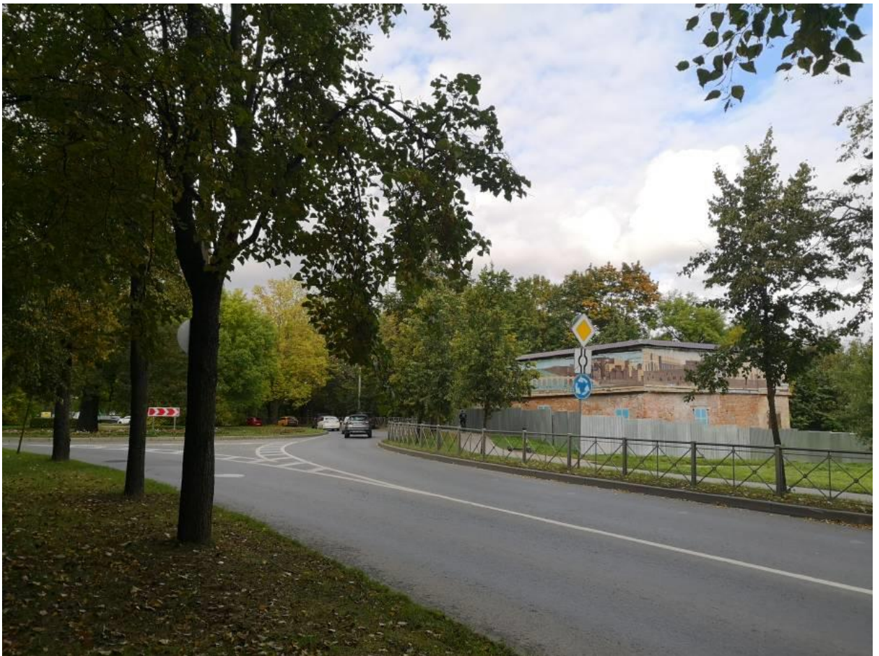
Фото 2. Вид на участок №7 по адресу: Санкт-Петербург, Павловское шоссе, д.40 литера А с юго-запада.
