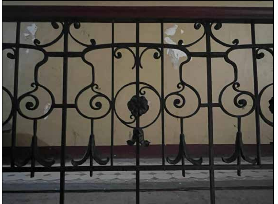
12. Парадная лестница 1 ЛК. Фрагменты интерьера.
