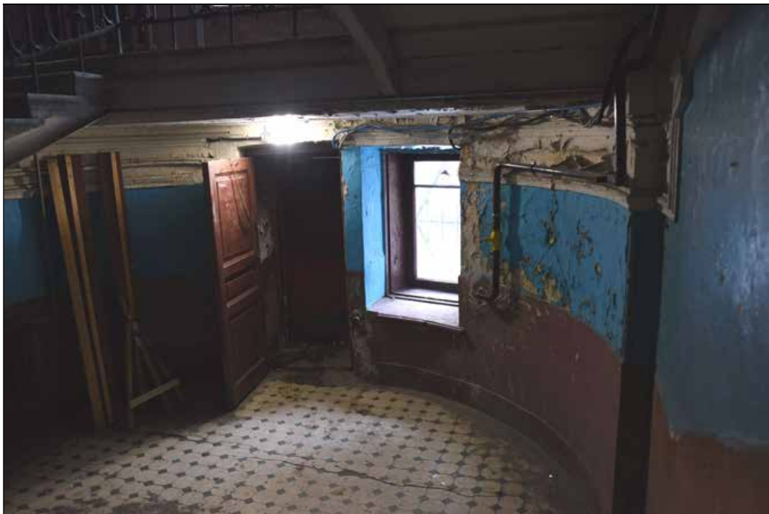
17. Парадная лестница 3 ЛК. Фрагменты интерьера.
