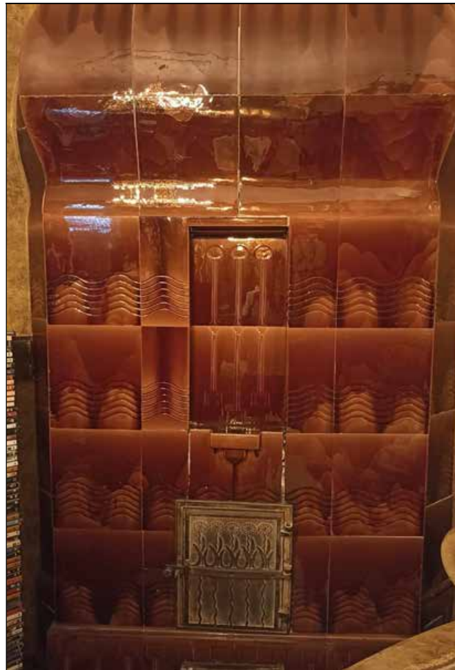
36. Дом А.Д. Барановской. Квартира №51. Печь.
