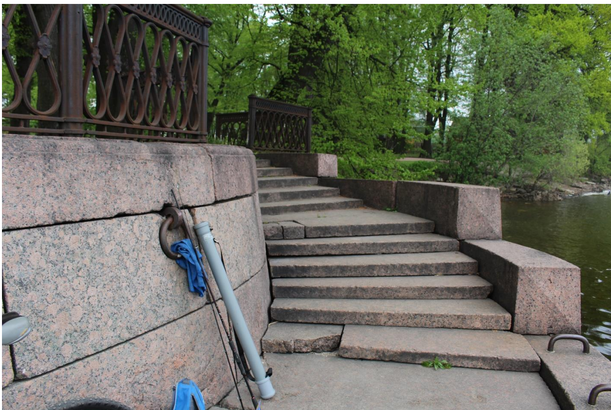
Фото 11. Вид на восточную одномаршевую поворотную лестницу объекта культурного наследия регионального значения «Пристань с оградой».
