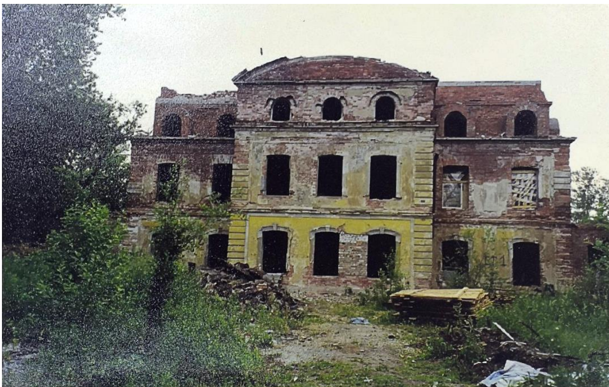
Илл. 23. Вид на главный фасад дома № 20 лит. Б на Крестовском проспекте. 1999 г. (источник: архив КГИОП П. 621-2 Н-4594).
