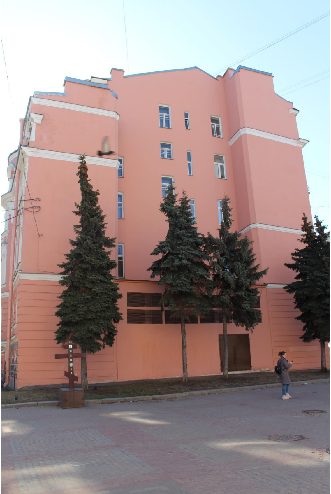
Фото 3. Вид на западный фасад.
