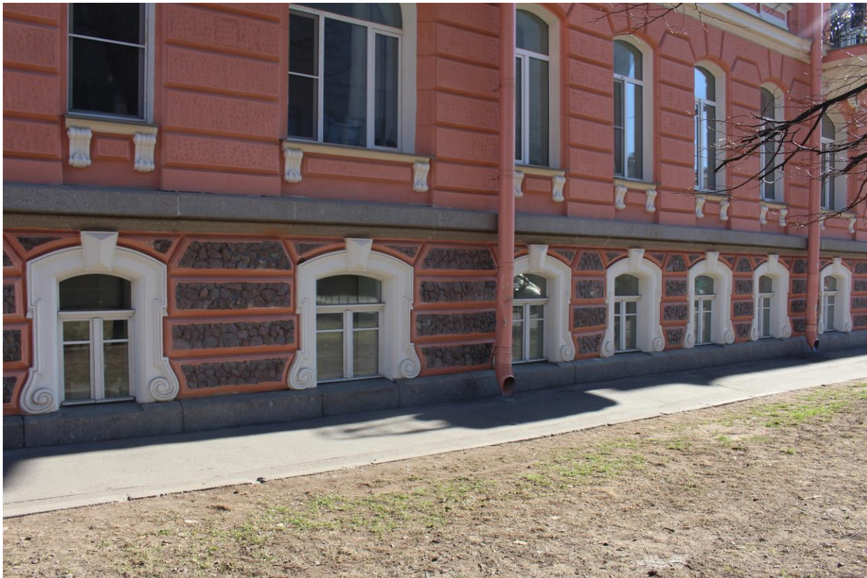
Фото 2. Фрагмент южного фасада, вид на оконные проемы помещения 11-Н.
