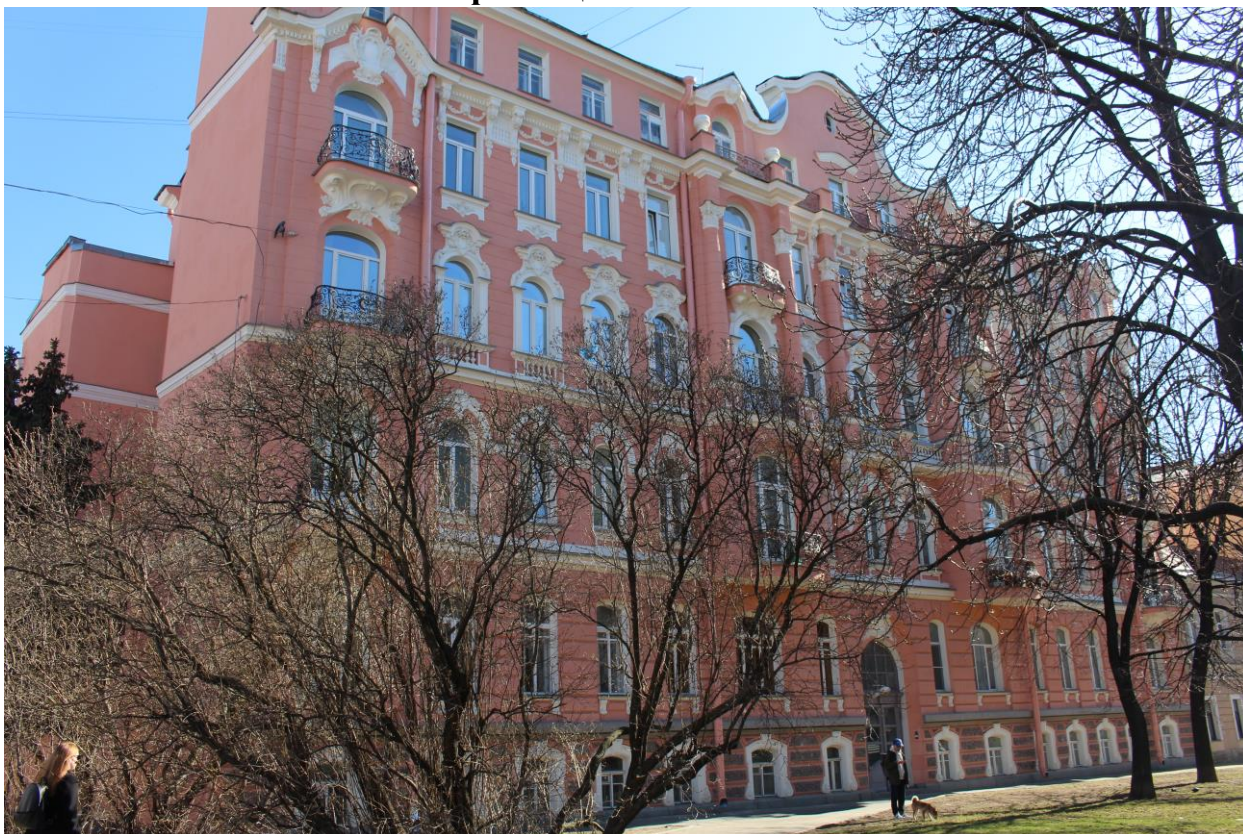
Фото 1. Общий вид выявленного объекта культурного наследия «Дом С.И. Пенякова».
