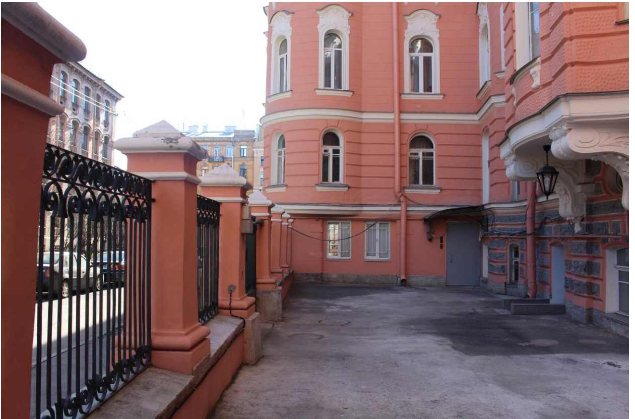
Фото 7. Вид на площадку за оградой курдонера.
