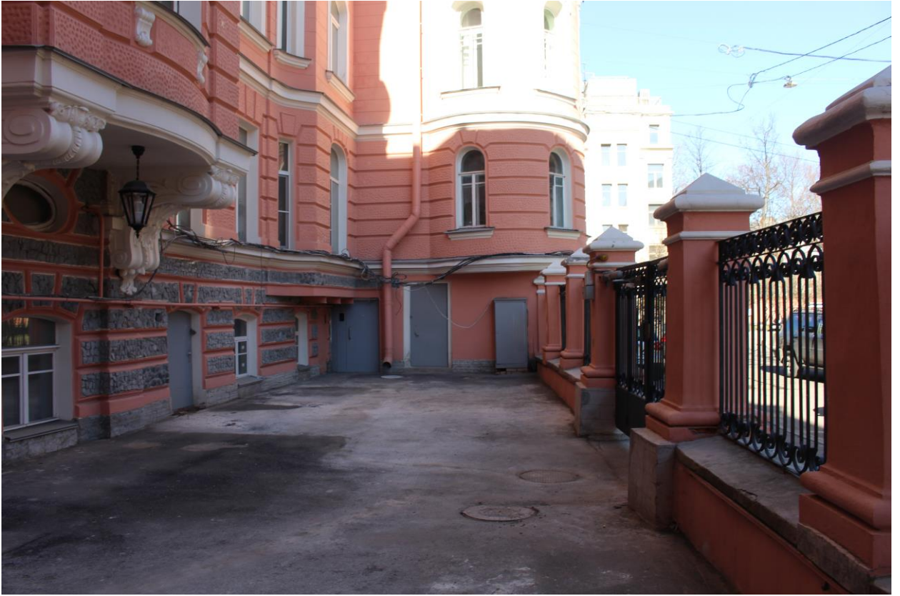
Фото 6. Вид на площадку за оградой курдонера.
