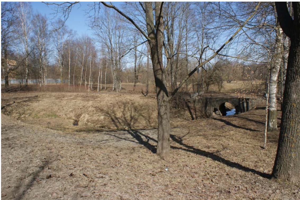
Фото 7. Объект культурного наследия федерального значения «Мосты гранитные через ручей (два)». Вид с юго-западной стороны. Съемка 14.04.2023 г. Трушковский В.Э.
