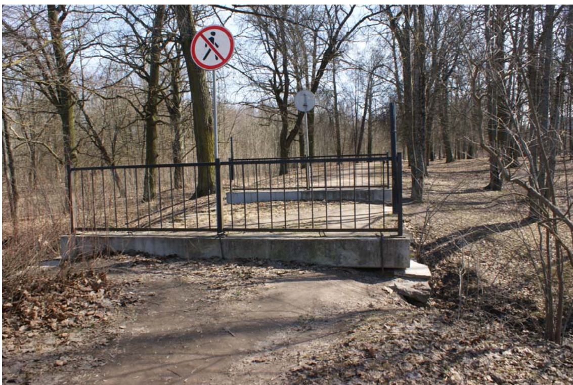
Фото 2. Объект культурного наследия федерального значения «Мосты гранитные через ручей (два)». Вид с северо-западной стороны. Съемка 14.04.2023 г. Трушковский В.Э.
