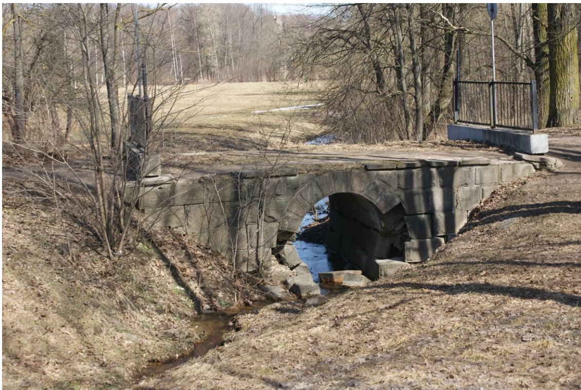
Фото 3. Объект культурного наследия федерального значения «Мосты гранитные через ручей (два)». Вид с западной стороны. Съемка 14.04.2023 г. Трушковский В.Э
