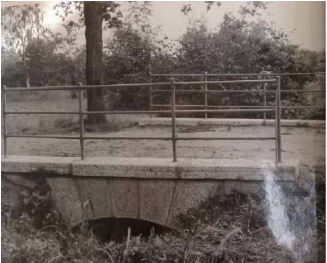
Илл.10. Отдельный парк. Мост на дубовой аллее у караульного помещения. Восстановление по состоянию на 28 июля 1956 г. Фото Цыплакова. Архив КГИОП.
