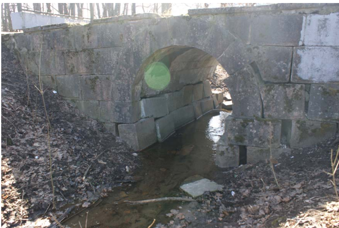
Фото 6. Объект культурного наследия федерального значения «Мосты гранитные через ручей (два)». Северо-восточная сторона моста. Съемка 14.04.2023 г. Трушковский В.Э.
