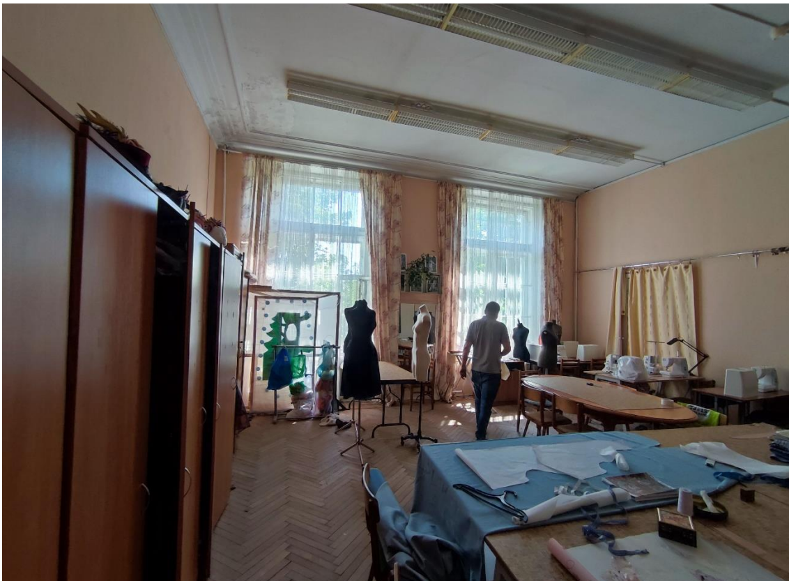
85. Объект культурного наследия регионального значения «Женская гимназия», по адресу: Санкт-Петербург, город Пушкин, Пушкинская улица, дом 28/21, литера А. Общий вид пом. 6-Н (5) в уровне 4-го этажа.
