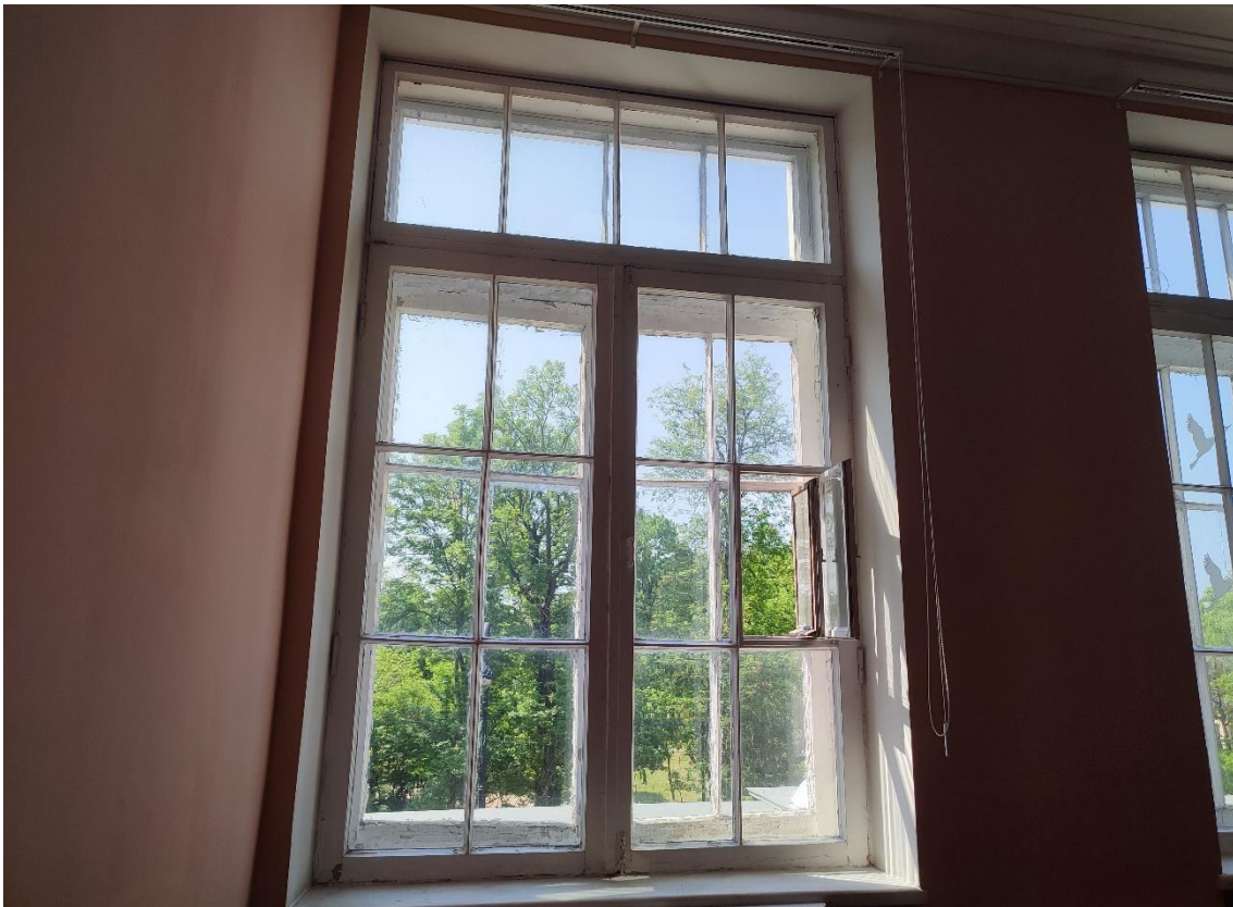
66. Объект культурного наследия регионального значения «Женская гимназия», по адресу: Санкт-Петербург, город Пушкин, Пушкинская улица, дом 28/21, литера А. Оконное заполнение в пом. 5-Н (7) в уровне 3-го этажа.
