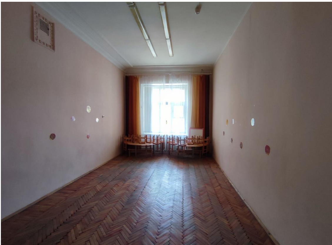
34. Объект культурного наследия регионального значения «Женская гимназия», по адресу: Санкт-Петербург, город Пушкин, Пушкинская улица, дом 28/21, литера А. Общий вид пом. 4-Н (15) в уровне 2-го этажа.
