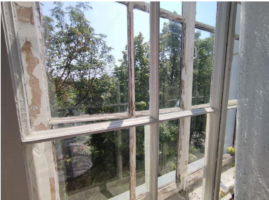
88. Объект культурного наследия регионального значения «Женская гимназия», по адресу: Санкт-Петербург, город Пушкин, Пушкинская улица, дом 28/21, литера А. Оконное заполнение в пом. 6-Н (4) в уровне 4-го этажа.
