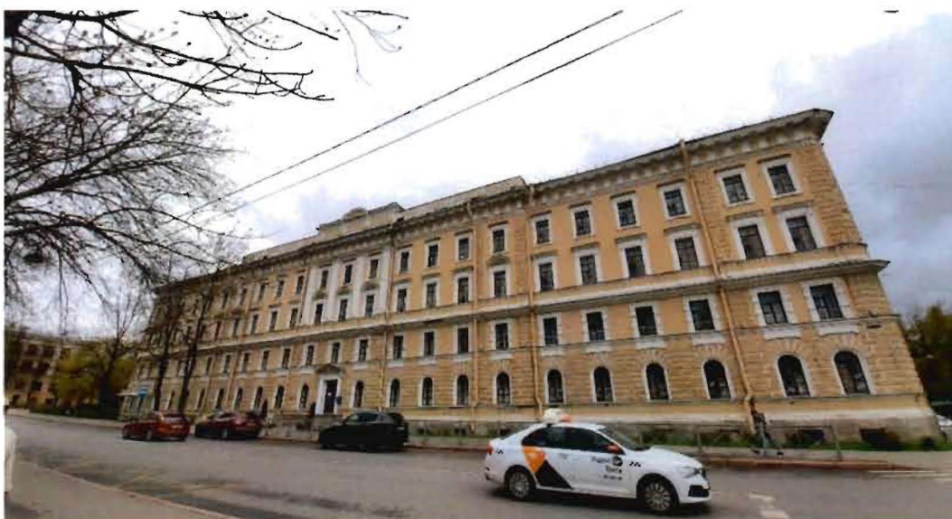
11. Общий вид на юго-западный фасад части объекта культурного наследия — здания, расположенного по адресу: Санкт-Петербург, город Пушкин, Пушкинская улица, дом 32/24, литера А
