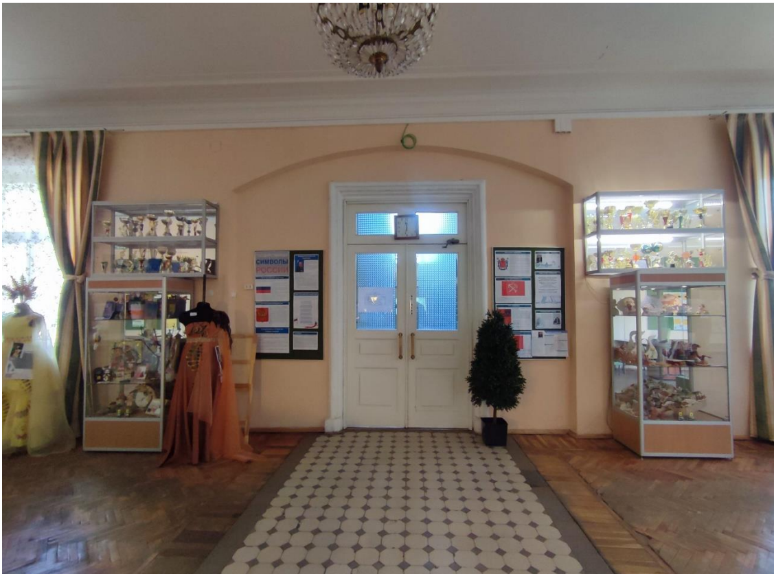
30. Объект культурного наследия регионального значения «Женская гимназия», по адресу: Санкт-Петербург, город Пушкин, Пушкинская улица, дом 28/21, литера А. Фрагмент пом. 4-Н (1) в уровне 2-го этажа. Заполнение дверного проема центральной лестничной клетки.
