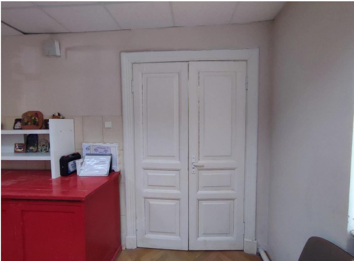
18. Объект культурного наследия регионального значения «Женская гимназия», по адресу: Санкт-Петербург, город Пушкин, Пушкинская улица, дом 28/21, литера А. Дверное заполнение в пом. 2-Н (4) в уровне 1-го этажа.
