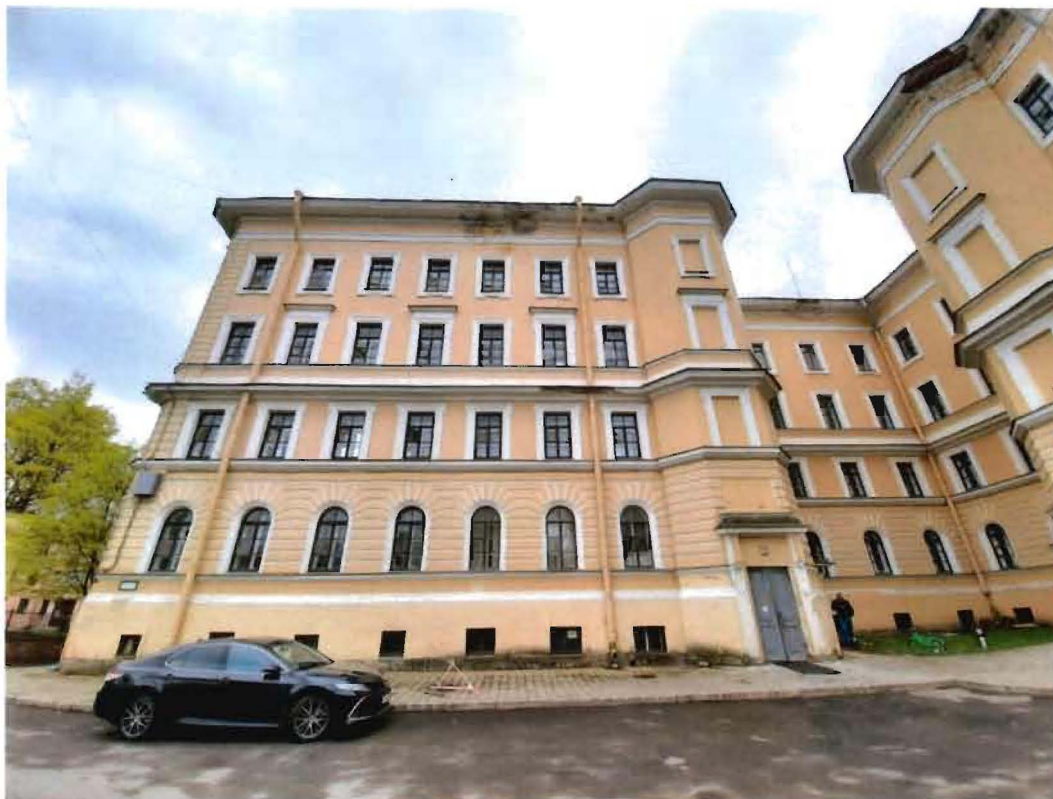
14. Фрагмент дворового фасада части объекта культурного наследия — здания, расположенного по адресу: Санкт-Петербург, город Пушкин, Пушкинская улица, дом 32/24, литера А
