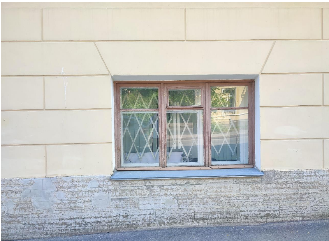
12. Объект культурного наследия регионального значения «Женская гимназия», по адресу: Санкт-Петербург, город Пушкин, Пушкинская улица, дом 28/21, литера А. Фрагмент северо-западного бокового фасада (2-я световая ось).
