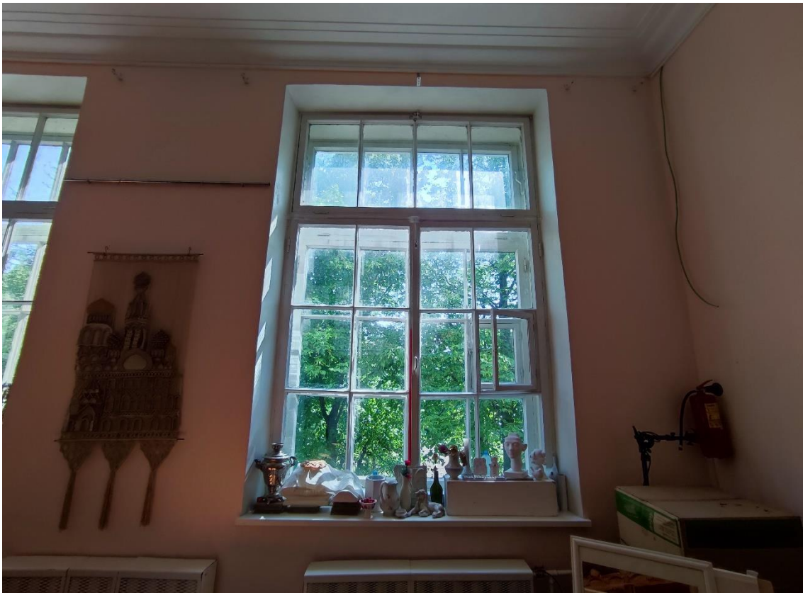
74. Объект культурного наследия регионального значения «Женская гимназия», по адресу: Санкт-Петербург, город Пушкин, Пушкинская улица, дом 28/21, литера А. Оконное заполнение в пом. 5-Н (4) в уровне 3-го этажа.
