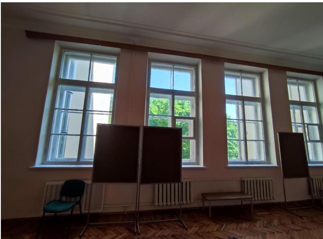
58. Объект культурного наследия регионального значения «Женская гимназия», по адресу: Санкт-Петербург, город Пушкин, Пушкинская улица, дом 28/21, литера А. Фрагмент пом. 5-Н (1) в уровне 3-го этажа.
