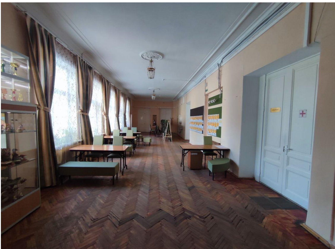
46. Объект культурного наследия регионального значения «Женская гимназия», по адресу: Санкт-Петербург, город Пушкин, Пушкинская улица, дом 28/21, литера А. Общий вид пом. 4-Н (1) в уровне 2-го этажа.
