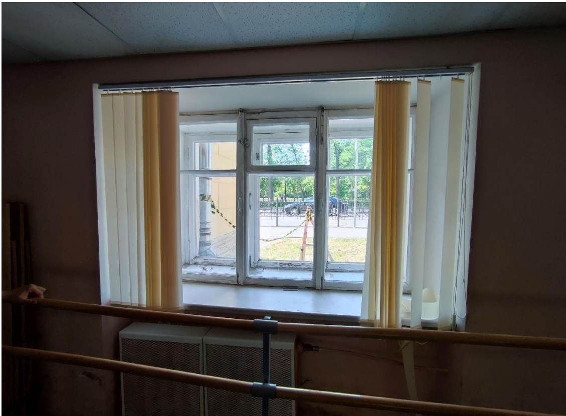
22. Объект культурного наследия регионального значения «Женская гимназия», по адресу: Санкт-Петербург, город Пушкин, Пушкинская улица, дом 28/21, литера А. Оконное заполнение в пом. 1-Н (19) в уровне 1-го этажа.
