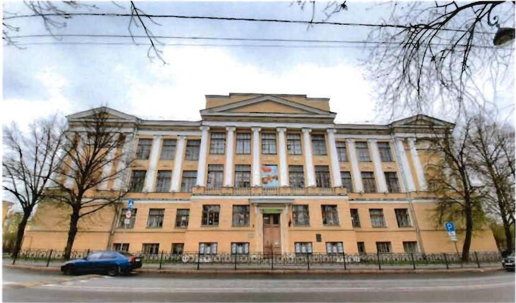
2. Общий вид на юго-западный фасад части объекта культурного наследия — здания, расположенного по адресу: Санкт-Петербург, город Пушкин, Пушкинская улица, дом 28/21, литера А
