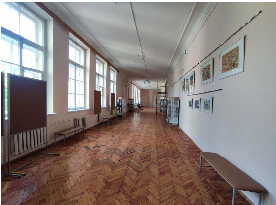
62. Объект культурного наследия регионального значения «Женская гимназия», по адресу: Санкт-Петербург, город Пушкин, Пушкинская улица, дом 28/21, литера А. Общий вид пом. 5-Н (1) в уровне 3-го этажа.
