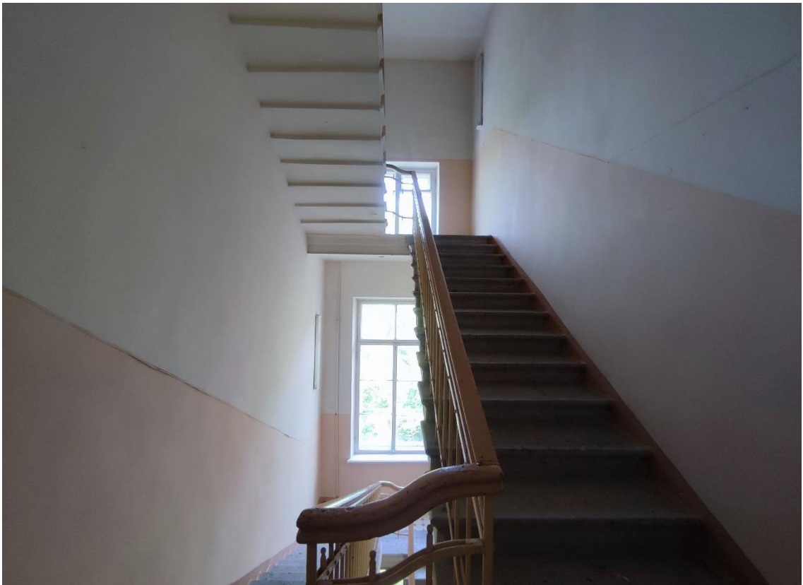
99. Объект культурного наследия регионального значения «Женская гимназия», по адресу: Санкт-Петербург, город Пушкин, Пушкинская улица, дом 28/21, литера А. Общий вид боковой лестничной клетки (пом. 6-Н (16)) в уровне 4-го этажа.
