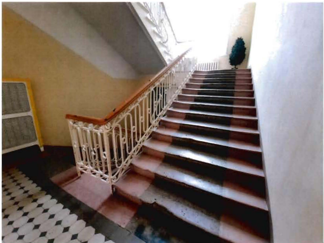
9. Центральная лестница части объекта культурного наследия — здания, расположенного по адресу: Санкт-Петербург, город Пушкин, Пушкинская улица, дом 28/21, литера А
