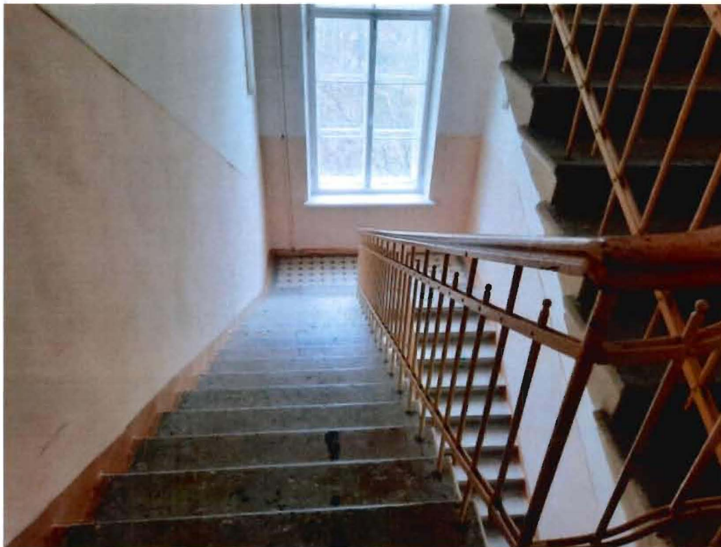
10. Боковая лестница части объекта культурного наследия — здания, расположенного по адресу: Санкт-Петербург, город Пушкин, Пушкинская улица, дом 28/21, литера А
