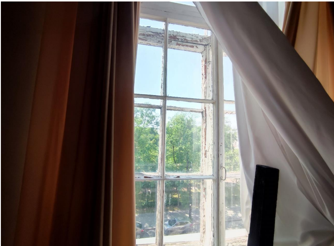
83. Объект культурного наследия регионального значения «Женская гимназия», по адресу: Санкт-Петербург, город Пушкин, Пушкинская улица, дом 28/21, литера А. Оконное заполнение в пом. 6-Н (7) в уровне 4-го этажа.
