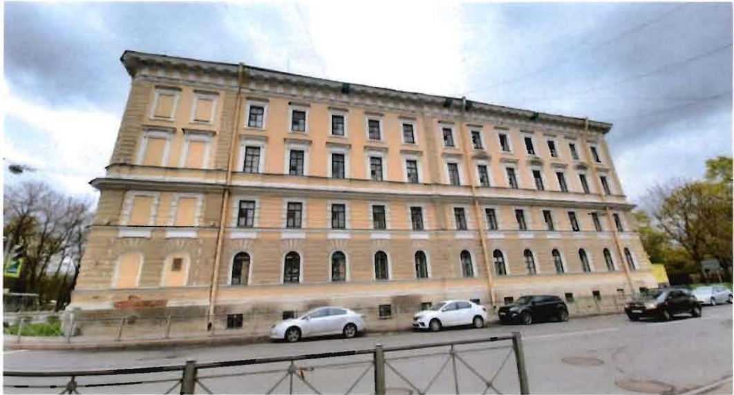
12. Общий вид на юго-восточный фасад части объекта культурного наследия — здания, расположенного по адресу: Санкт-Петербург, город Пушкин, Пушкинская улица, дом 32/24, литера А
