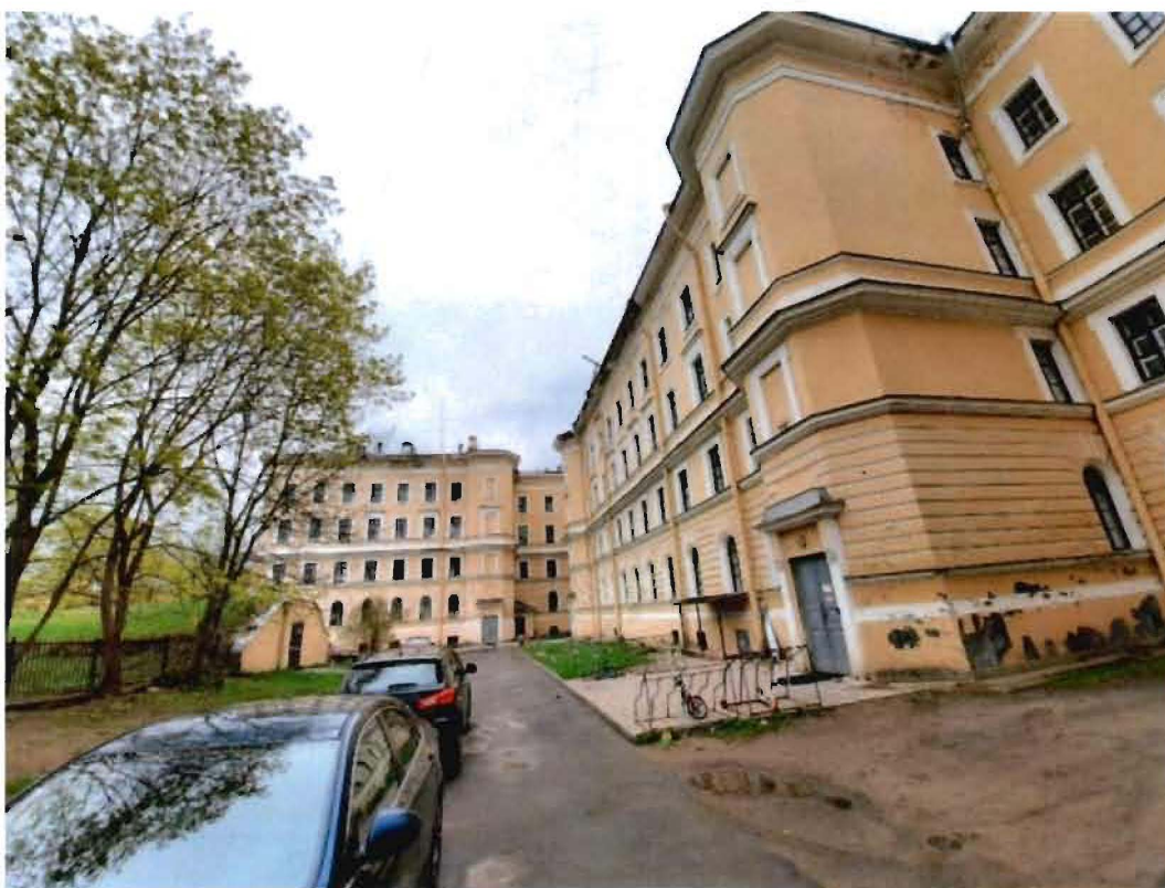
25. Вид с восточной стороны на фрагмент территории объекта культурного наследия у здания, расположенного по адресу: Санкт-Петербург, город Пушкин, Пушкинская улица, дом 32/24, литера А
