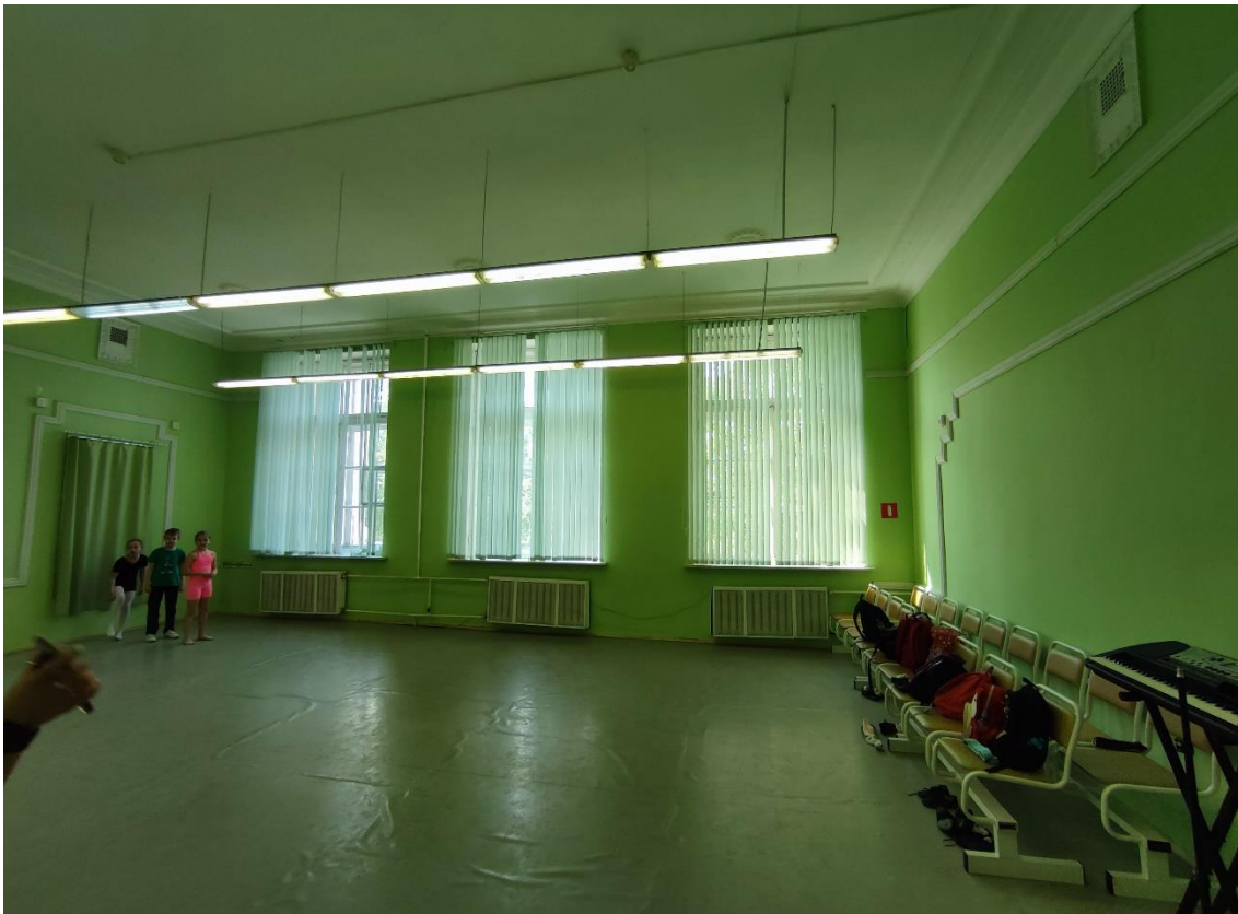
61. Объект культурного наследия регионального значения «Женская гимназия», по адресу: Санкт-Петербург, город Пушкин, Пушкинская улица, дом 28/21, литера А. Общий вид пом. 5-Н (9) в уровне 3-го этажа.
