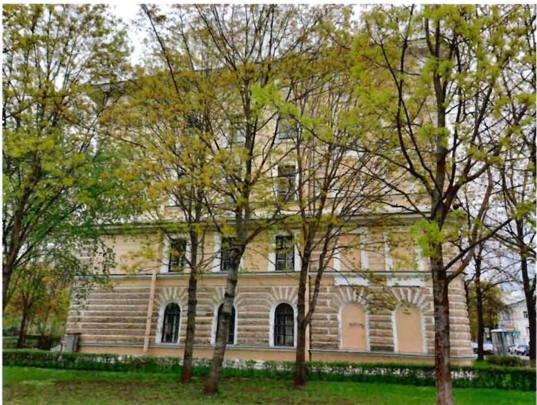
17. Общий вид на северо-западный фасад части объекта культурного наследия — здания, расположенного по адресу: Санкт-Петербург, город Пушкин, Пушкинская улица, дом 32/24, литера А
