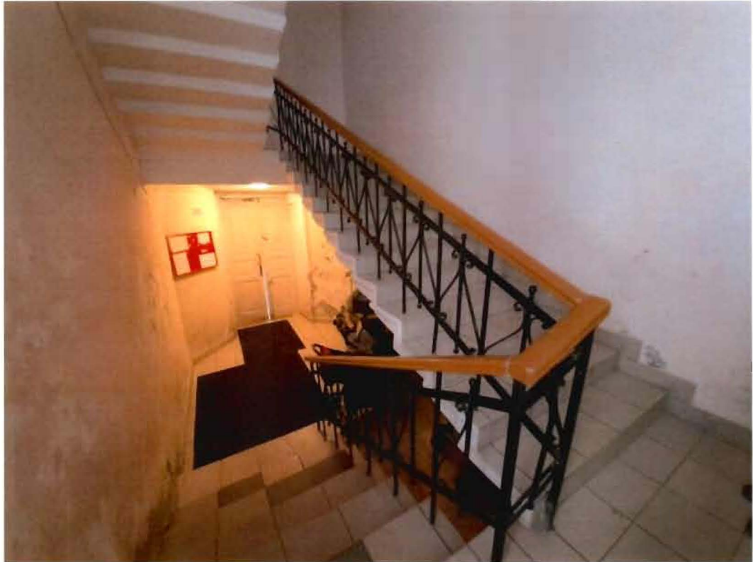
20. Лестница западной части части объекта культурного наследия — здания, расположенного по адресу: Санкт-Петербург, город Пушкин, Пушкинская улица, дом 32/24, литера А
