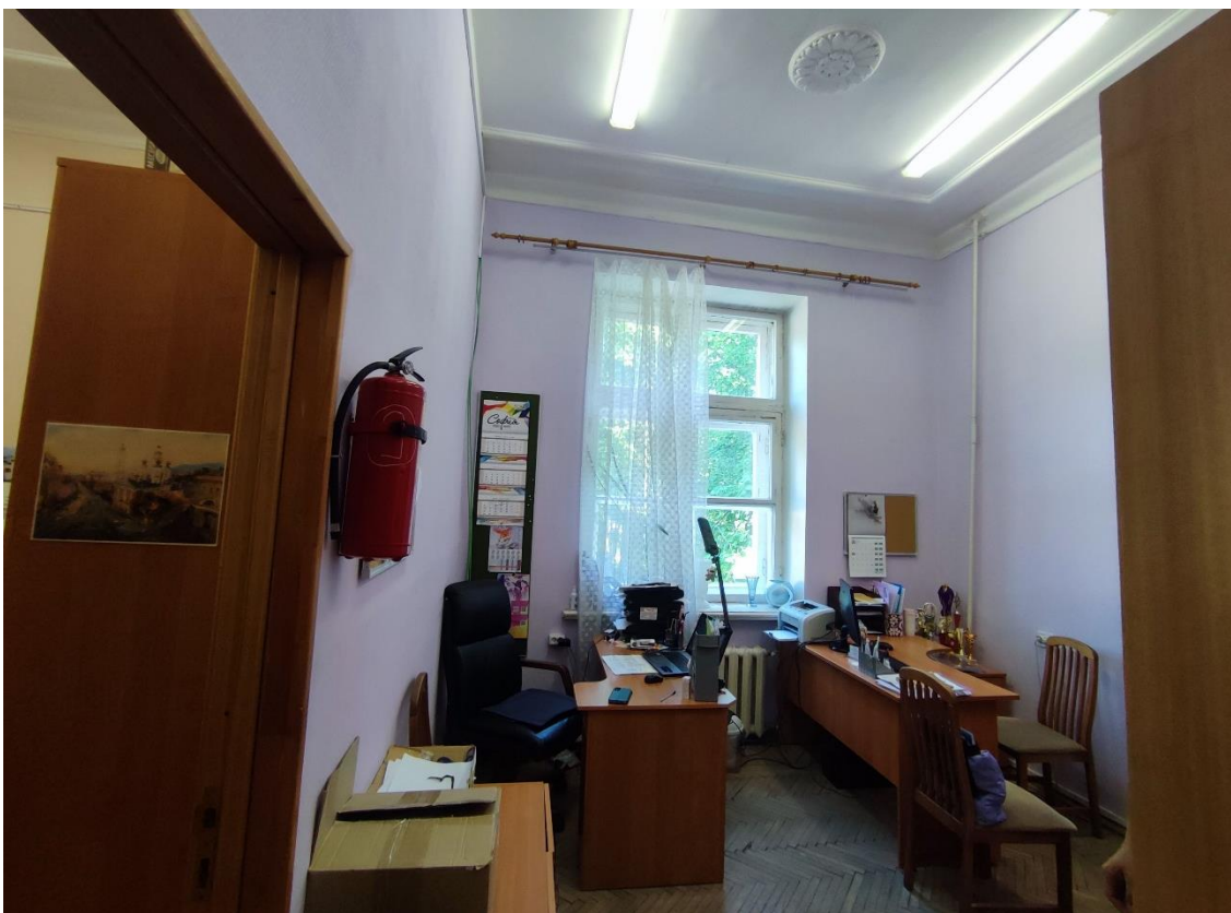
44. Объект культурного наследия регионального значения «Женская гимназия», по адресу: Санкт-Петербург, город Пушкин, Пушкинская улица, дом 28/21, литера А. Общий вид пом. 4-Н (26) в уровне 2-го этажа.
