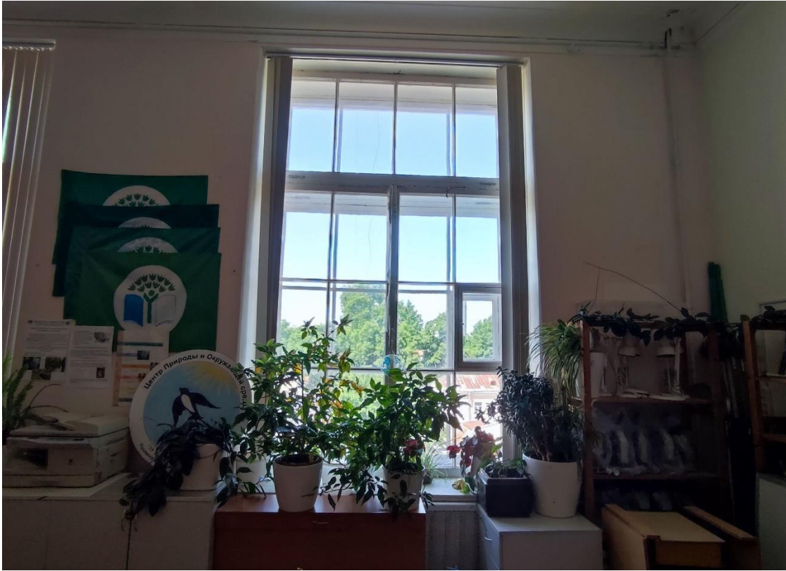
98. Объект культурного наследия регионального значения «Женская гимназия», по адресу: Санкт-Петербург, город Пушкин, Пушкинская улица, дом 28/21, литера А. Оконное заполнение в пом. 6-Н (13) в уровне 4-го этажа.
