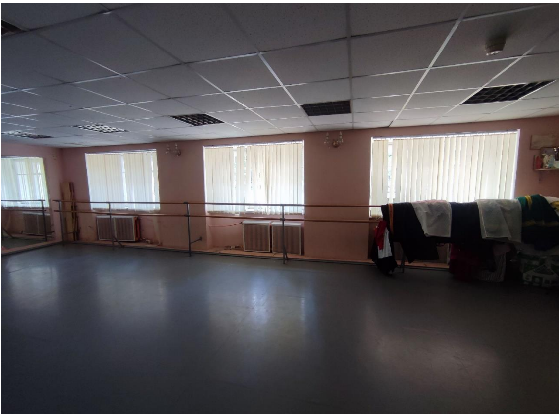
21. Объект культурного наследия регионального значения «Женская гимназия», по адресу: Санкт-Петербург, город Пушкин, Пушкинская улица, дом 28/21, литера А. Общий вид пом. 1-Н (19) в уровне 1-го этажа.
