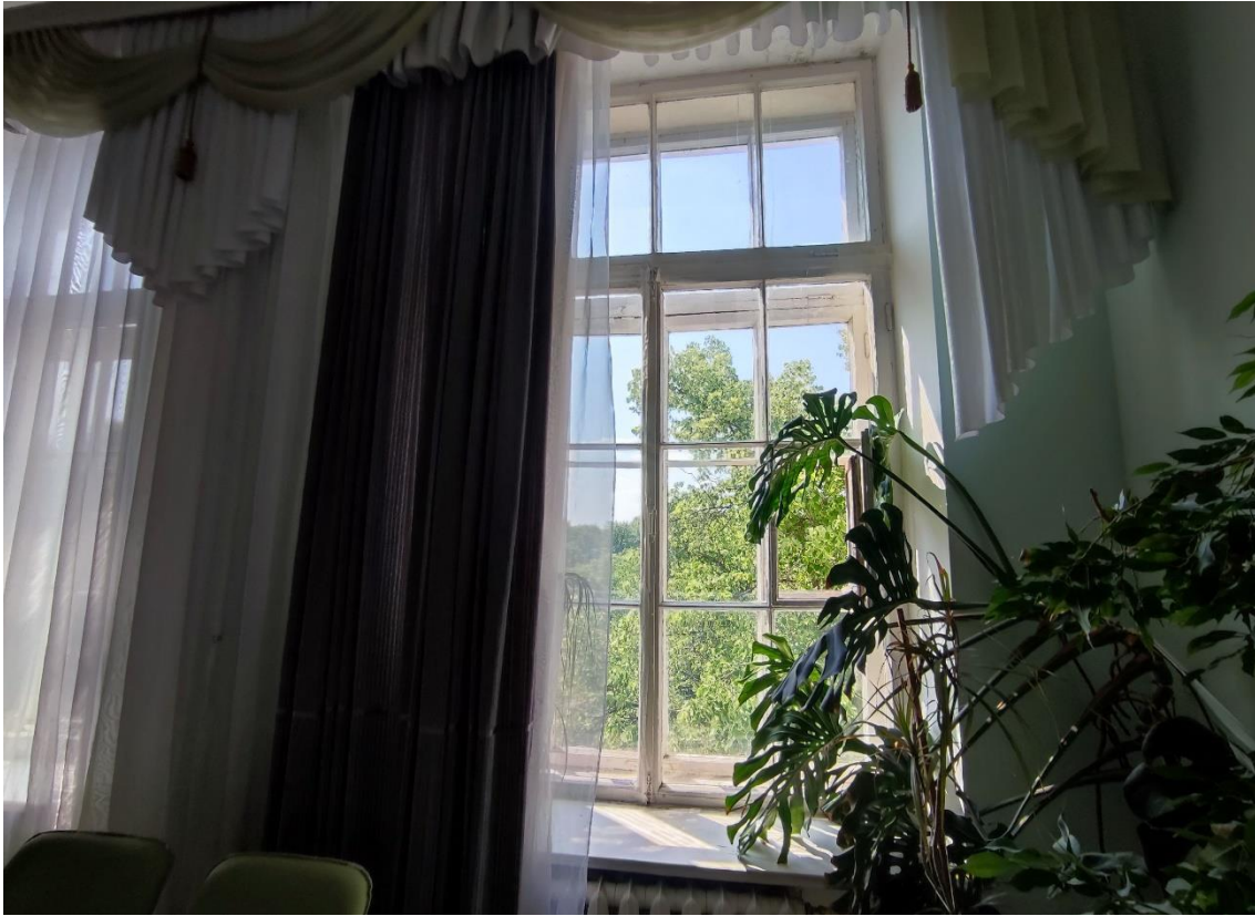
92. Объект культурного наследия регионального значения «Женская гимназия», по адресу: Санкт-Петербург, город Пушкин, Пушкинская улица, дом 28/21, литера А. Оконное заполнение в пом. 6-Н (10) в уровне 4-го этажа.
