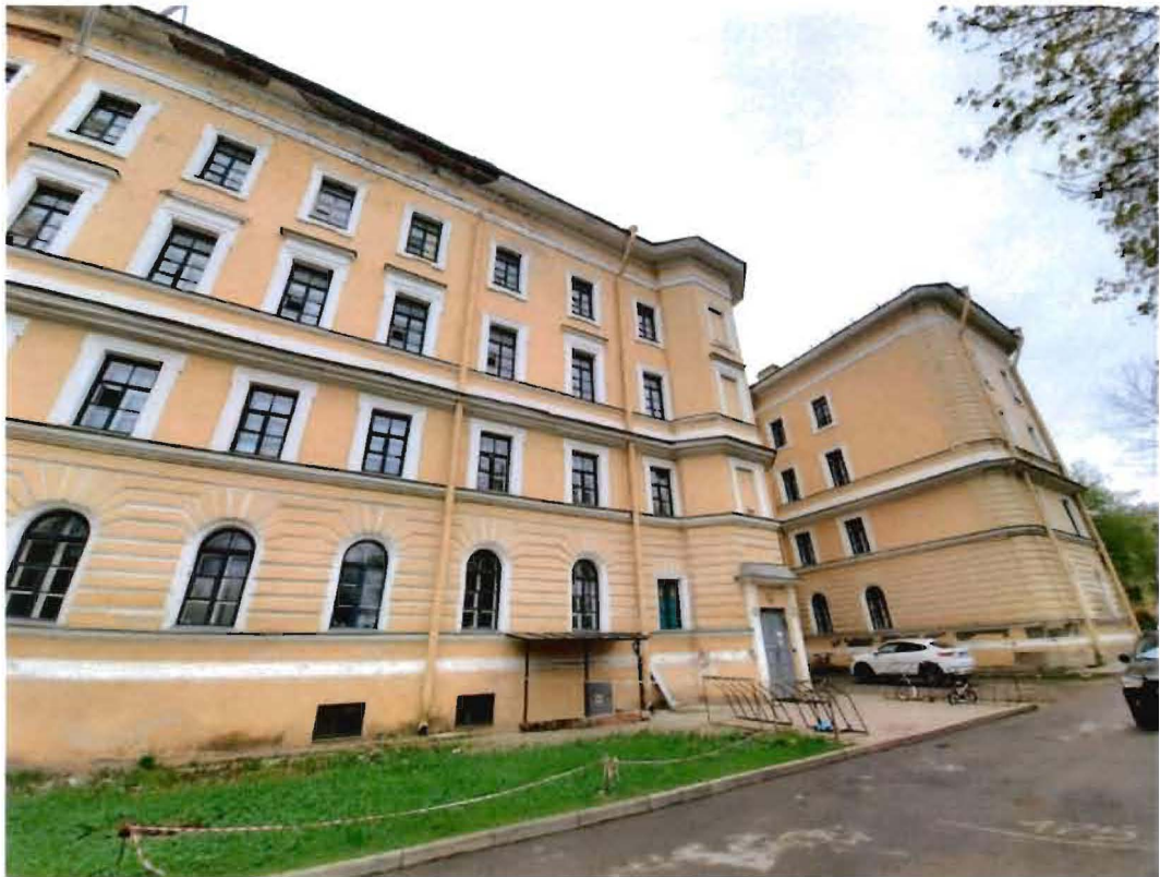
16. Фрагмент дворового фасада части объекта культурного наследия — здания, расположенного по адресу: Санкт-Петербург, город Пушкин, Пушкинская улица, дом 32/24, литера А
