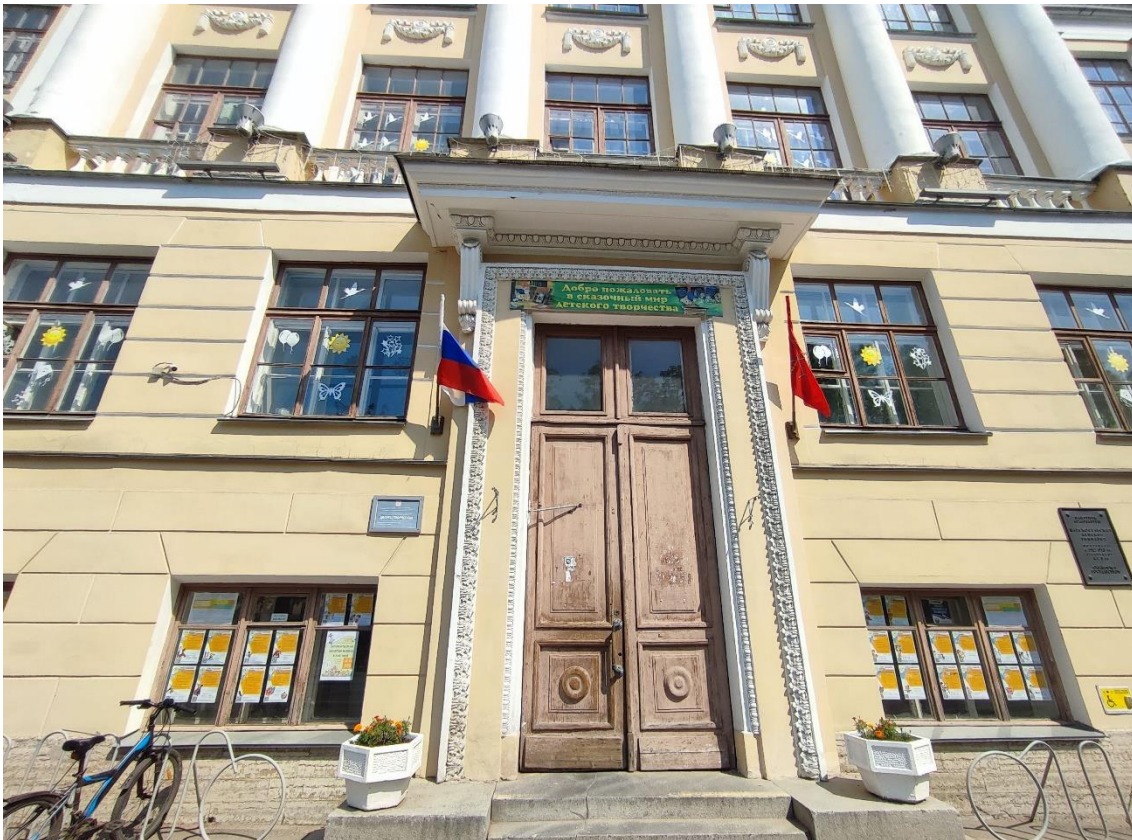
4. Объект культурного наследия регионального значения «Женская гимназия», по адресу: Санкт-Петербург, город Пушкин, Пушкинская улица, дом 28/21, литера А. Фрагмент центральной части юго-западного лицевого фасада по Пушкинской улице.
