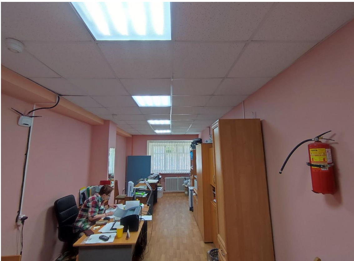
20. Объект культурного наследия регионального значения «Женская гимназия», по адресу: Санкт-Петербург, город Пушкин, Пушкинская улица, дом 28/21, литера А. Общий вид пом. 1-Н (18) в уровне 1-го этажа.
