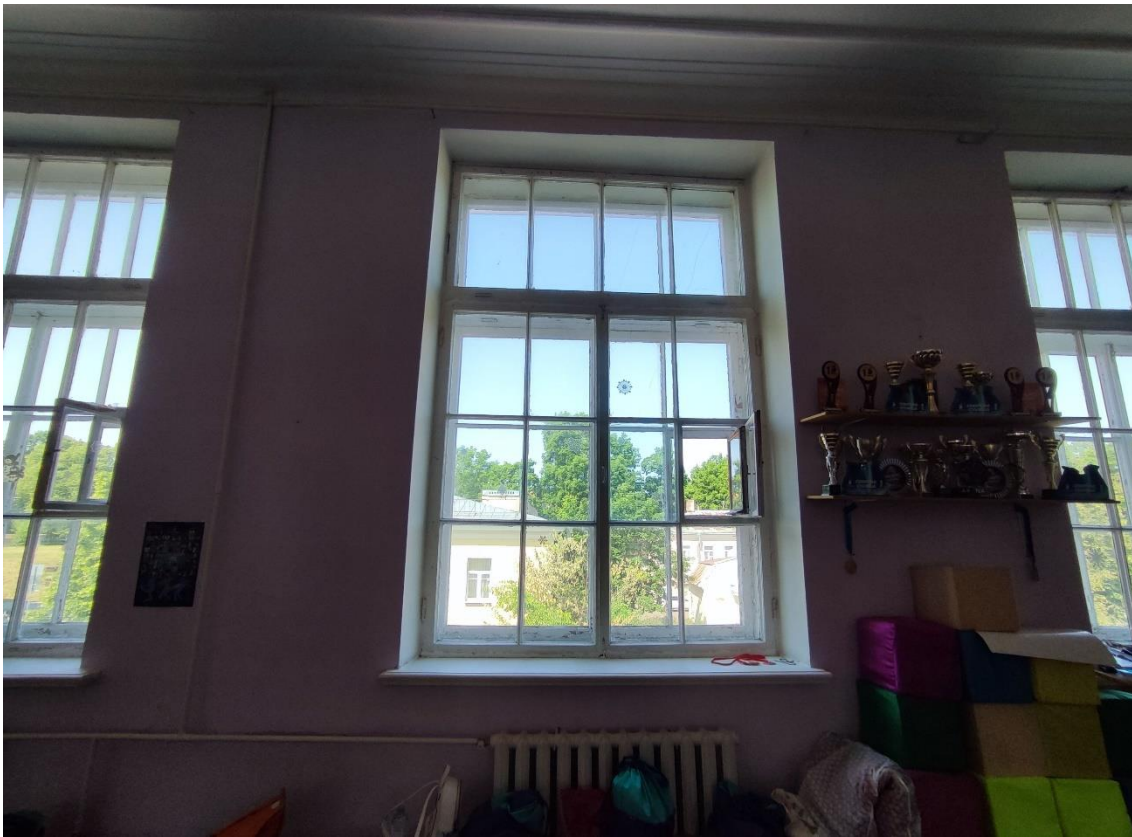
60. Объект культурного наследия регионального значения «Женская гимназия», по адресу: Санкт-Петербург, город Пушкин, Пушкинская улица, дом 28/21, литера А. Оконное заполнение в пом. 5-Н (10) в уровне 3-го этажа.
