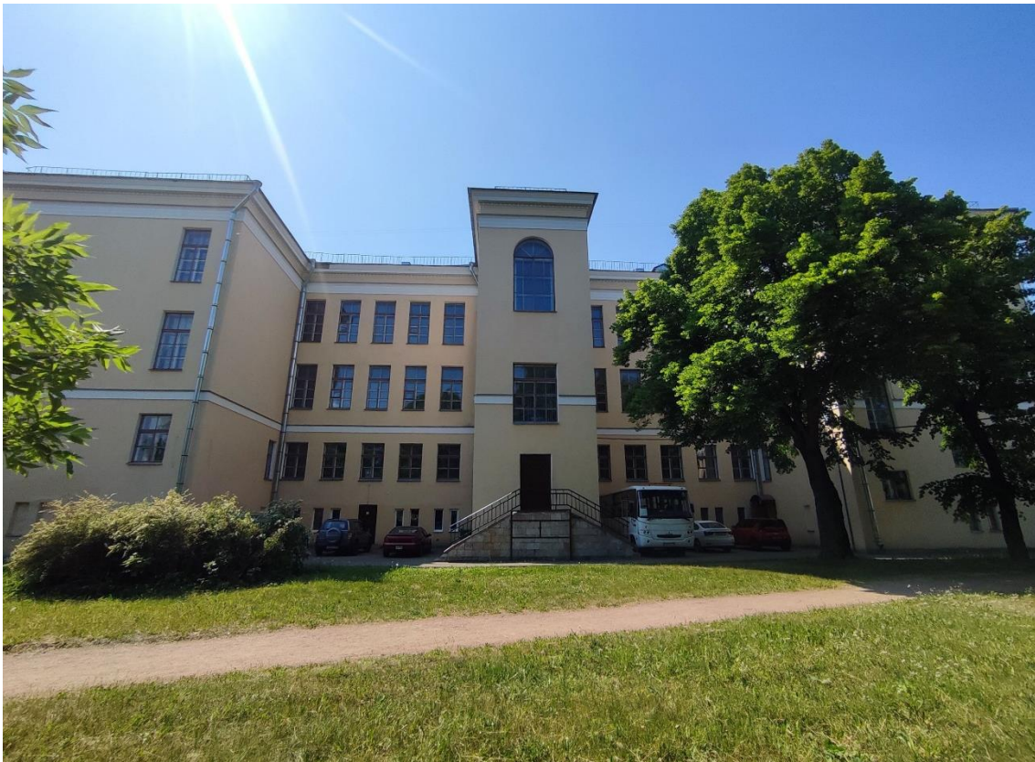
9. Объект культурного наследия регионального значения «Женская гимназия», по адресу: Санкт-Петербург, город Пушкин, Пушкинская улица, дом 28/21, литера А. Общий вид северо-восточного дворового фасада.
