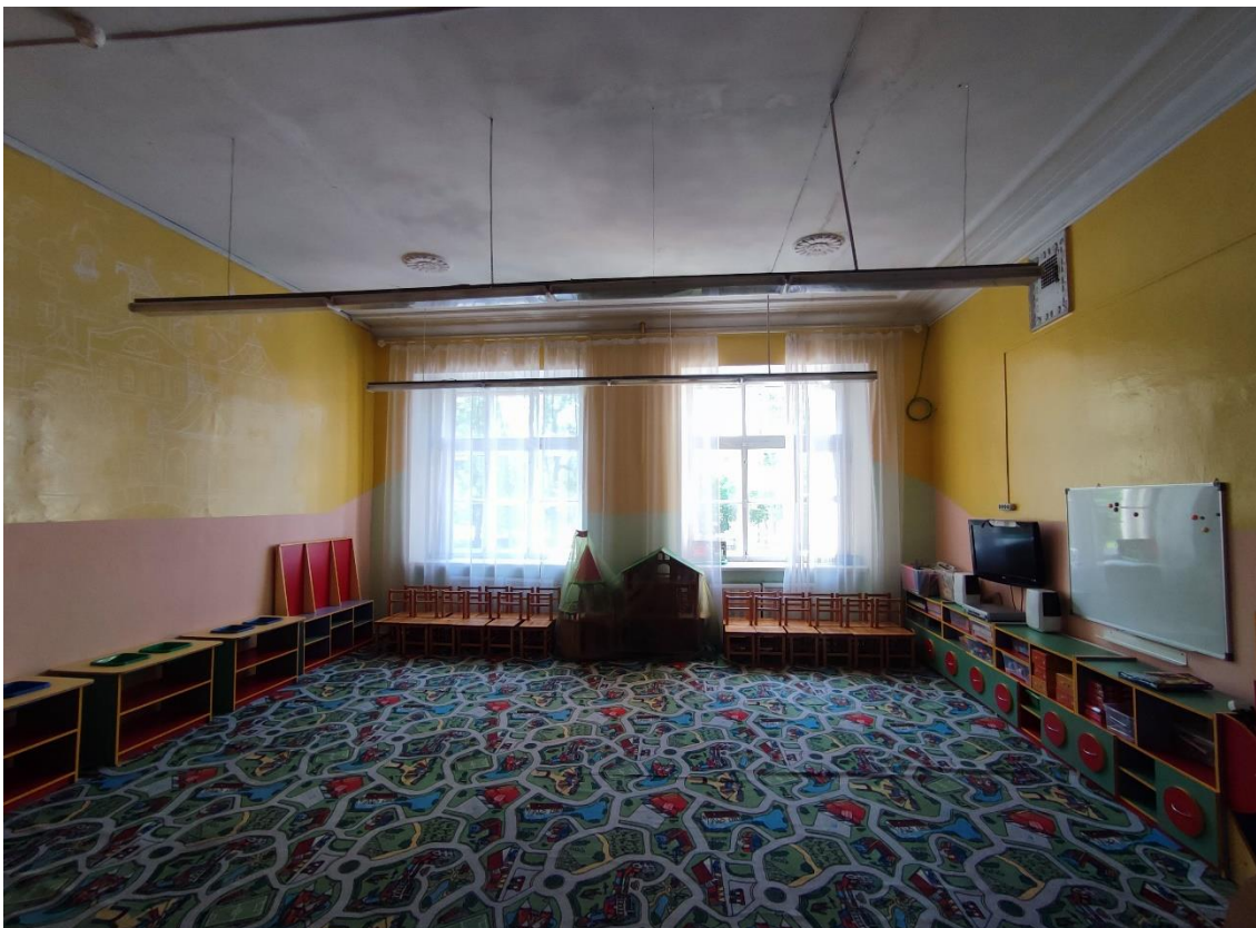
50. Объект культурного наследия регионального значения «Женская гимназия», по адресу: Санкт-Петербург, город Пушкин, Пушкинская улица, дом 28/21, литера А. Общий вид пом. 4-Н (6) в уровне 2-го этажа.
