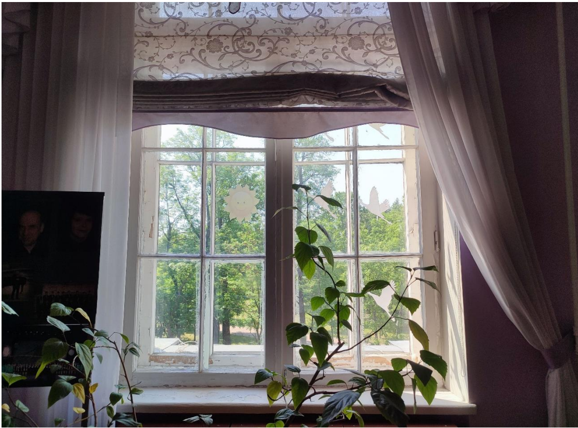
64. Объект культурного наследия регионального значения «Женская гимназия», по адресу: Санкт-Петербург, город Пушкин, Пушкинская улица, дом 28/21, литера А. Оконное заполнение в пом. 5-Н (8) в уровне 3-го этажа.
