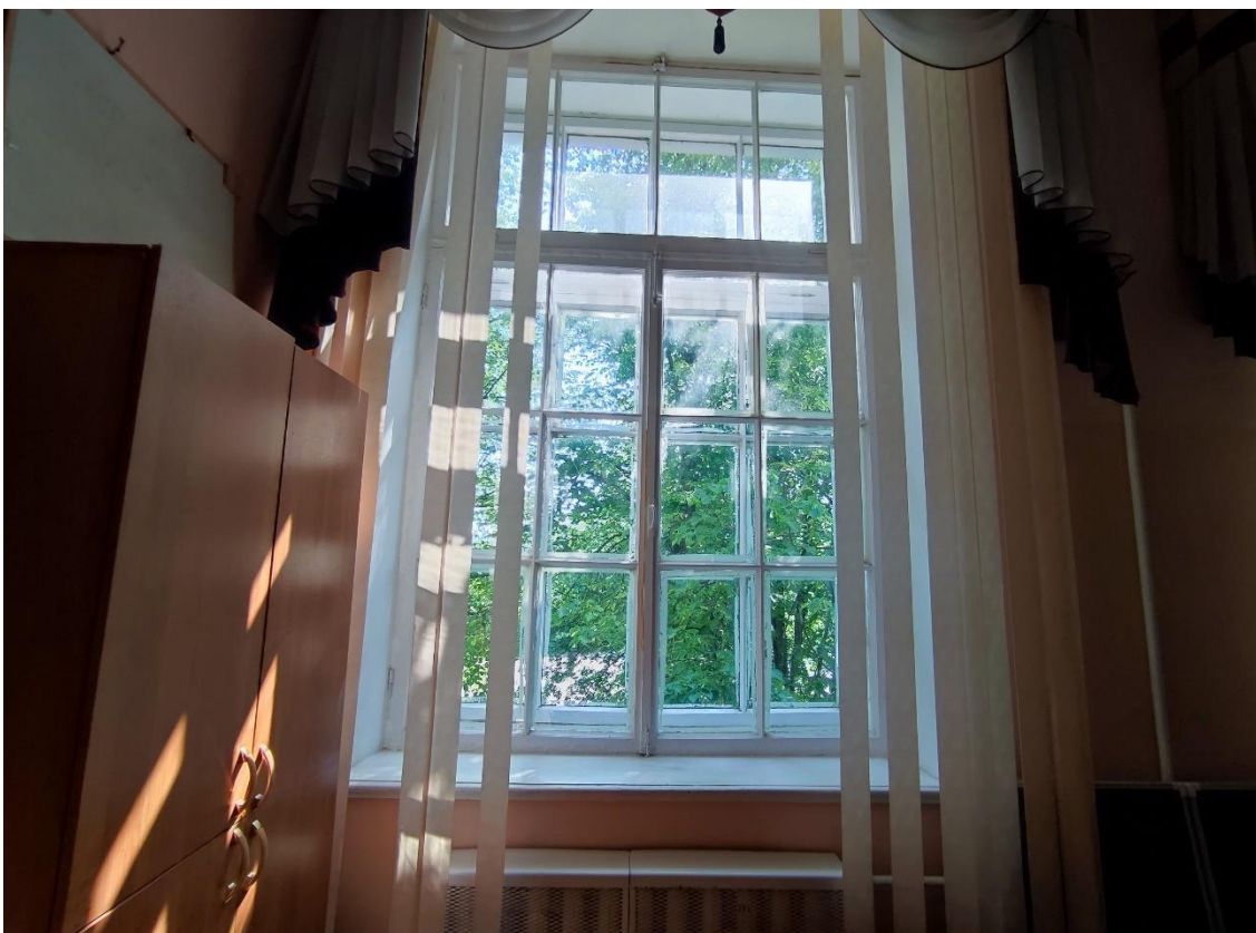
71. Объект культурного наследия регионального значения «Женская гимназия», по адресу: Санкт-Петербург, город Пушкин, Пушкинская улица, дом 28/21, литера А. Оконное заполнение в пом. 5-Н (5) в уровне 3-го этажа.
