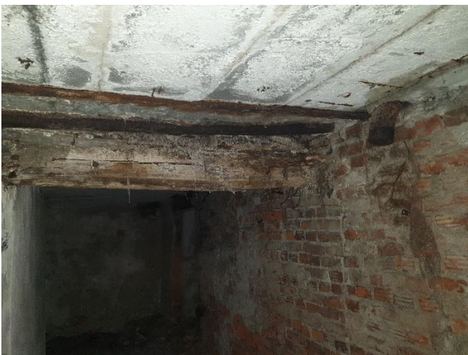
15. «Финская усадьба Заеца», Санкт-Петербург, город Зеленогорск, Приморское шоссе, дом 597, литера К. Подвал. Фрагмент. Фото 27.02.2023г.
