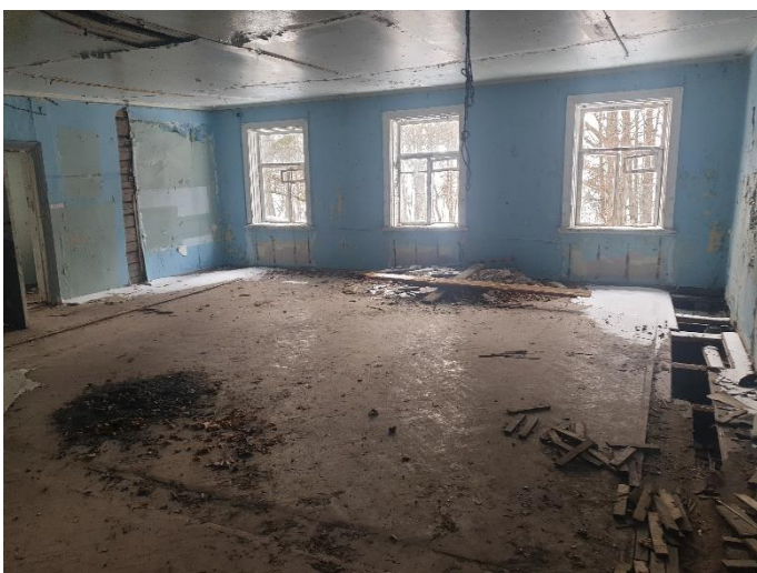
28. «Финская усадьба Заеца», Санкт-Петербург, город Зеленогорск, Приморское шоссе, дом 597, литера К. Помещение второго этажа. Общий вид. Фото 27.02.2023г.
