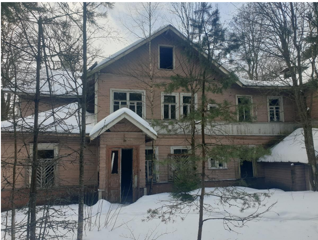
4. «Финская усадьба Заеца», Санкт-Петербург, город Зеленогорск, Приморское шоссе, дом 597, литера К. Северный фасад. Общий вид. Фото 27.02.2023г.
