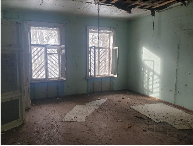
21. «Финская усадьба Заеца», Санкт-Петербург, город Зеленогорск, Приморское шоссе, дом 597, литера К. Помещение первого этажа. Общий вид. Фото 27.02.2023г.
