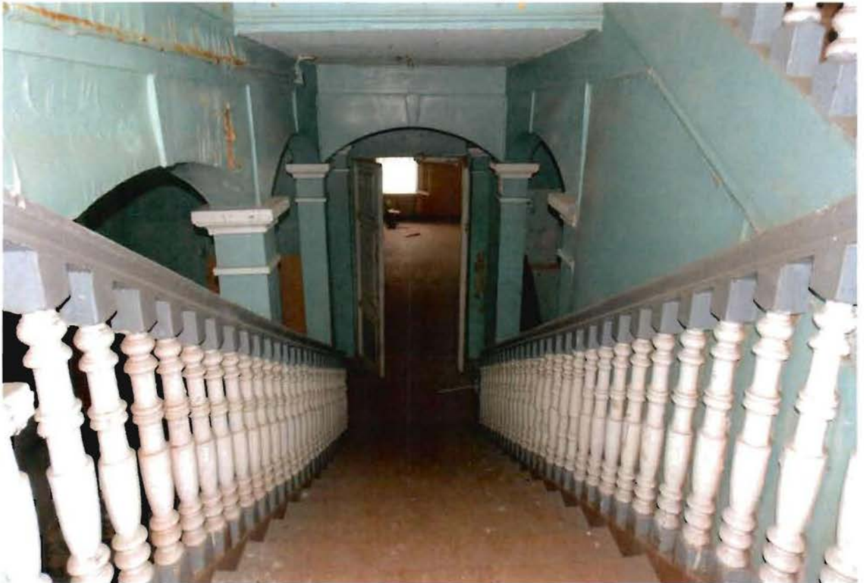
3. Главная парадная деревянная лестница. Фрагмент.
