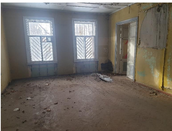
19. «Финская усадьба Заеца», Санкт-Петербург, город Зеленогорск, Приморское шоссе, дом 597, литера К. Помещение первого этажа. Общий вид. Фото 27.02.2023г.
