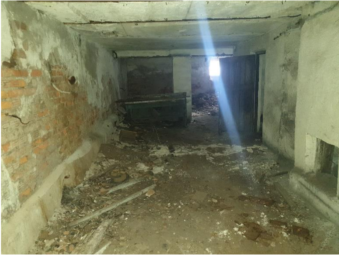
13. «Финская усадьба Заеца», Санкт-Петербург, город Зеленогорск, Приморское шоссе, дом 597, литера К. Подвал. Общий вид. Фото 27.02.2023г.
