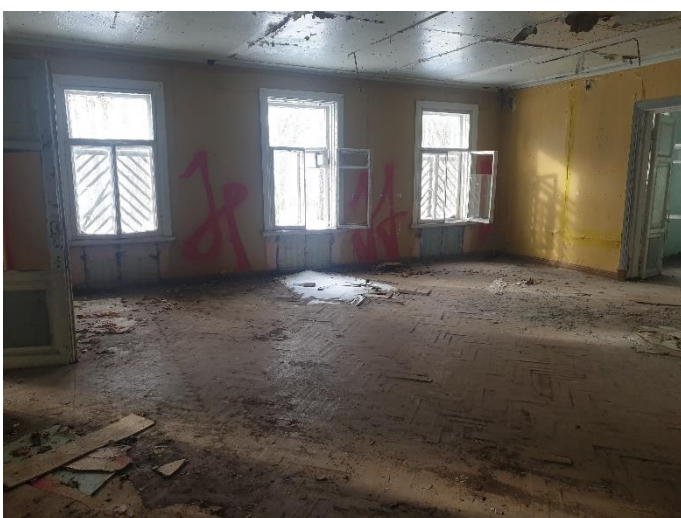
20. «Финская усадьба Заеца», Санкт-Петербург, город Зеленогорск, Приморское шоссе, дом 597, литера К. Помещение первого этажа. Общий вид. Фото 27.02.2023г.
