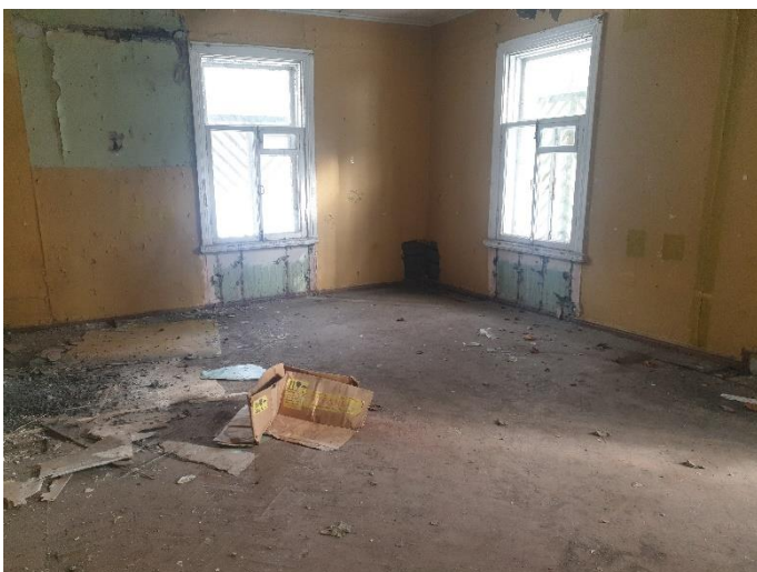
18. «Финская усадьба Заеца», Санкт-Петербург, город Зеленогорск, Приморское шоссе, дом 597, литера К. Помещение первого этажа. Общий вид. Фото 27.02.2023г.
