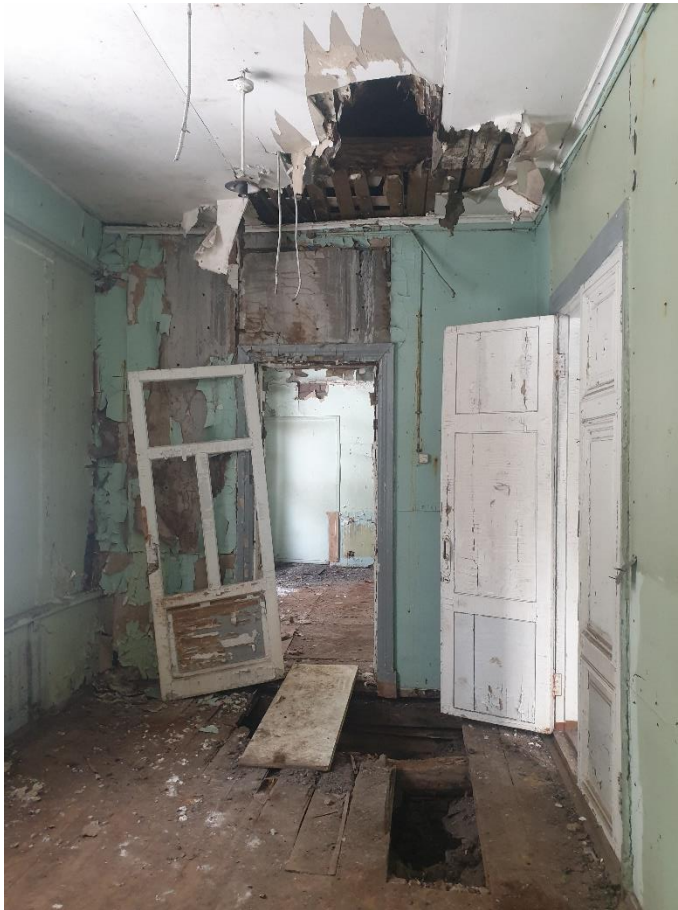
22. «Финская усадьба Заеца», Санкт-Петербург, город Зеленогорск, Приморское шоссе, дом 597, литера К. Помещение первого этажа. Общий вид. Фото 27.02.2023г.
