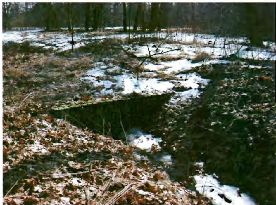
1,2. Юго-восточная часть объекта культурного наследия федерального значения «Парк». Мелиоративный канал, оголовок трубоперехода
