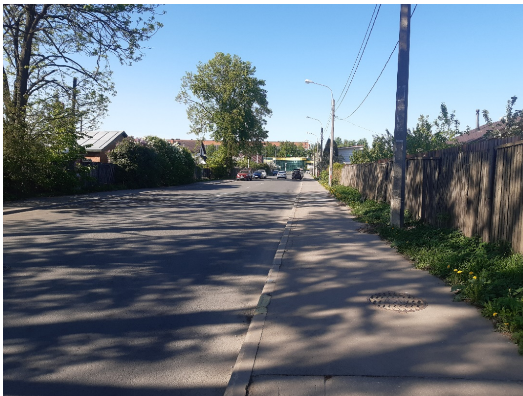
Рис. 35. «Газопровод среднего давления для подключения (технологического присоединения) объекта капитального строительства на земельном участке по адресу: Санкт-Петербург, город Колпино, садоводство Ижорский массив №1, участок 17». Общий вид трассы. Точка съёмки 12. Вид на север.
