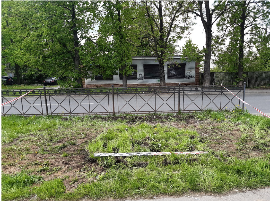
Рис.51. «Газопровод среднего давления для подключения (технологического присоединения) объекта капитального строительства на земельном участке по адресу: Санкт-Петербург, город Колпино, садоводство Ижорский массив №1, участок 17». Шурф 1. Фотофиксация после рекультивации. Вид на запад
