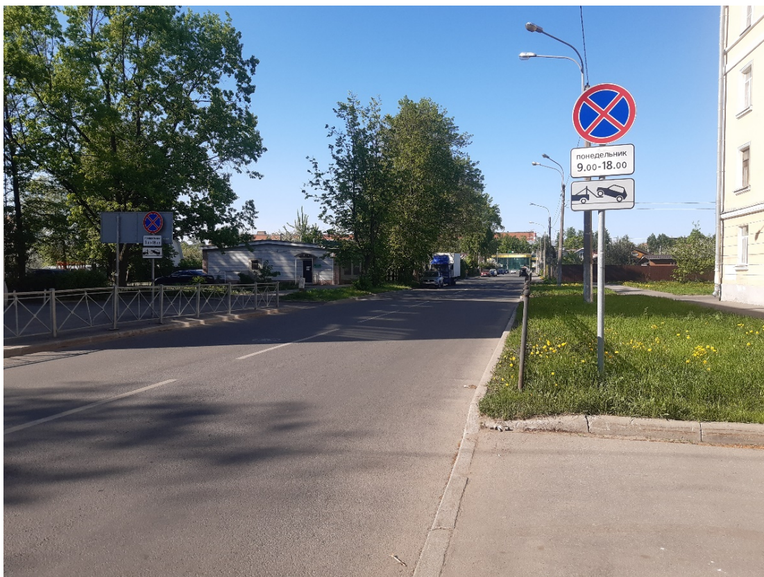
Рис.33. «Газопровод среднего давления для подключения (технологического присоединения) объекта капитального строительства на земельном участке по адресу: Санкт-Петербург, город Колпино, садоводство Ижорский массив №1, участок 17». Общий вид трассы. Точка съёмки 11. Вид на север.
