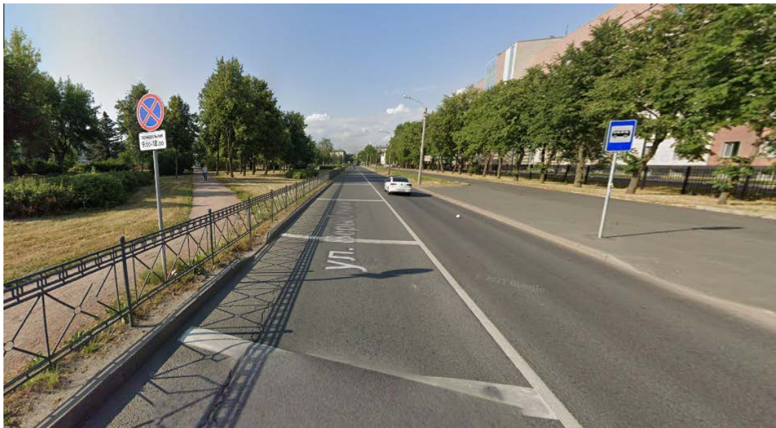
Рис.22. «Газопровод среднего давления для подключения (технологического присоединения) объекта капитального строительства на земельном участке по адресу: Санкт-Петербург, город Колпино, садоводство Ижорский массив №1, участок 17». Общий вид трассы. Точка съемки 1 Вид на север.
