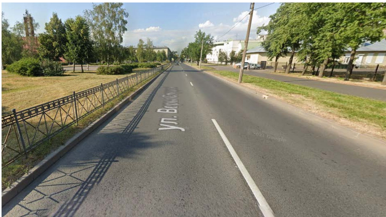
Рис.23. «Газопровод среднего давления для подключения (технологического присоединения) объекта капитального строительства на земельном участке по адресу: Санкт-Петербург, город Колпино, садоводство Ижорский массив №1, участок 17». Общий вид трассы. Точка съемки 2. Вид на север.
