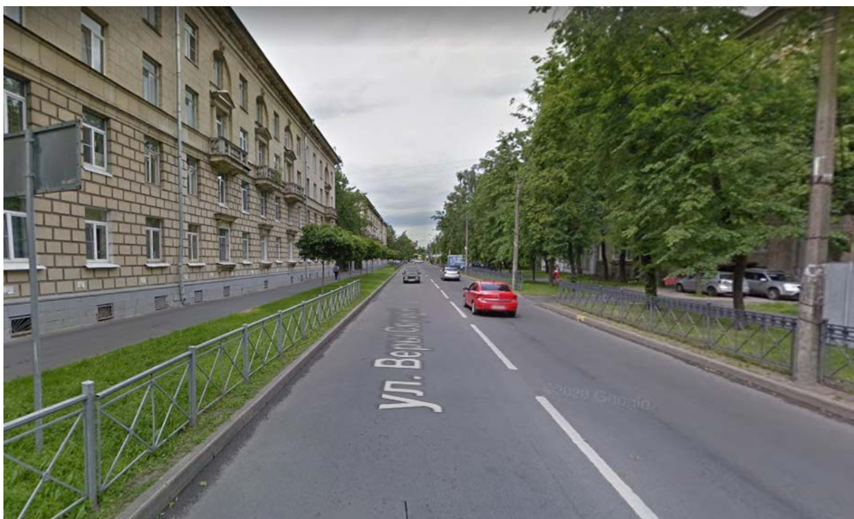
Рис. 26. «Газопровод среднего давления для подключения (технологического присоединения) объекта капитального строительства на земельном участке по адресу: Санкт-Петербург, город Колпино, садоводство Ижорский массив №1, участок 17». Общий вид трассы. Точка съемки 5. Вид на север.
