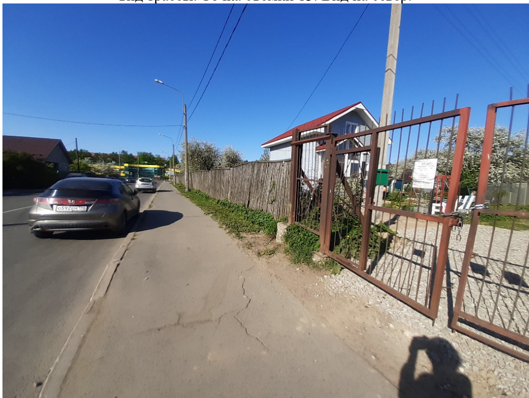
Рис.38. «Газопровод среднего давления для подключения (технологического присоединения) объекта капитального строительства на земельном участке по адресу: Санкт-Петербург, город Колпино, садоводство Ижорский массив №1, участок 17». Общий вид трассы. Точка съёмки 14. Вид на северо-восток.
