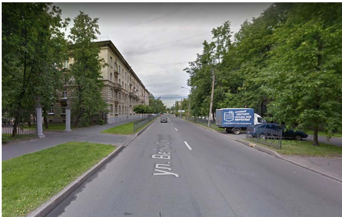
Рис.27. «Газопровод среднего давления для подключения (технологического присоединения) объекта капитального строительства на земельном участке по адресу: Санкт-Петербург, город Колпино, садоводство Ижорский массив №1, участок 17». Общий вид трассы. Точка съёмки 6. Вид на север.
