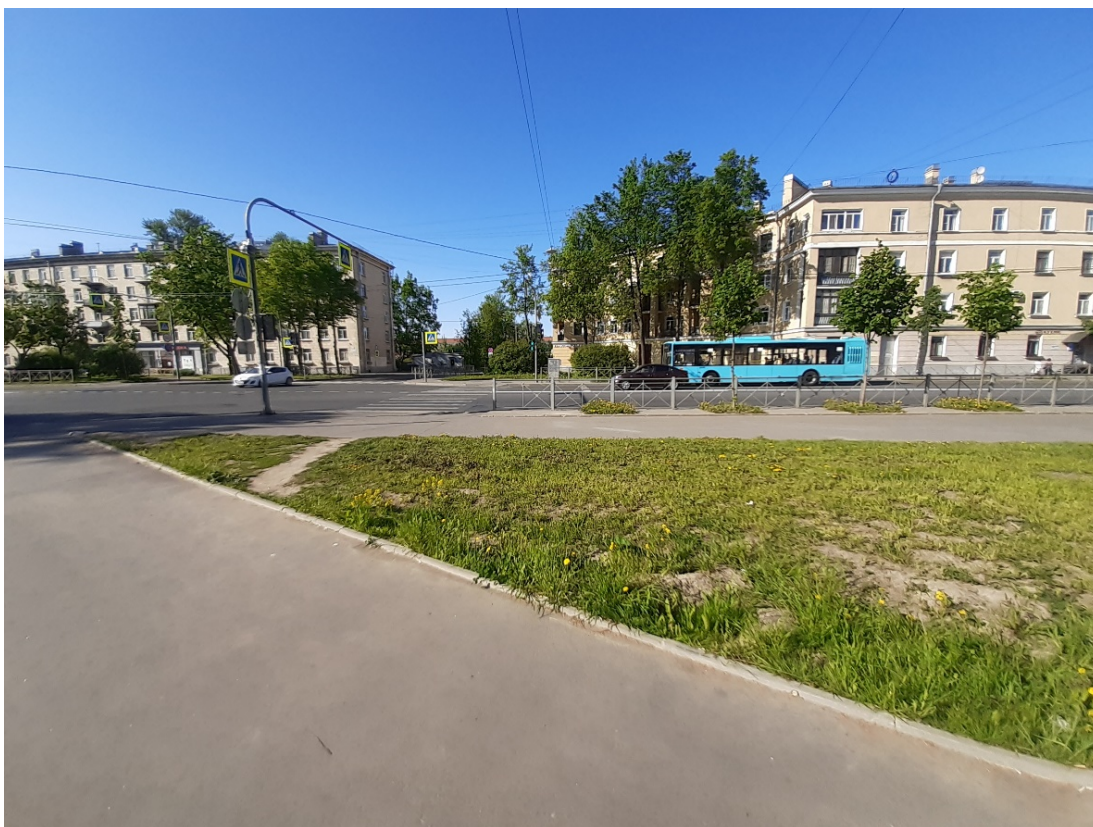
Рис.31. «Газопровод среднего давления для подключения (технологического присоединения) объекта капитального строительства на земельном участке по адресу: Санкт-Петербург, город Колпино, садоводство Ижорский массив №1, участок 17». Общий вид трассы. Точка съемки 9. Вид на север.
