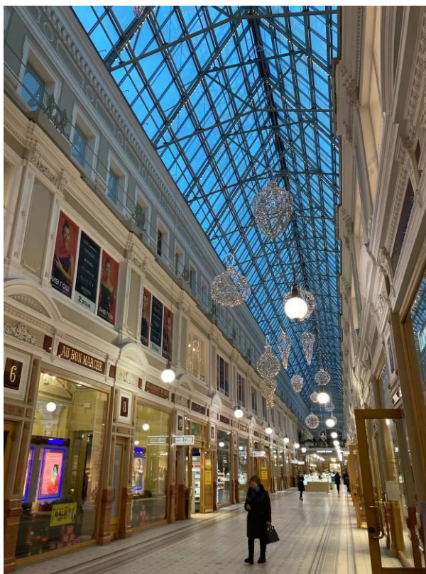
Фото 5. Фрагмент центральной галереи объекта культурного наследия регионального значения «Пассаж»
