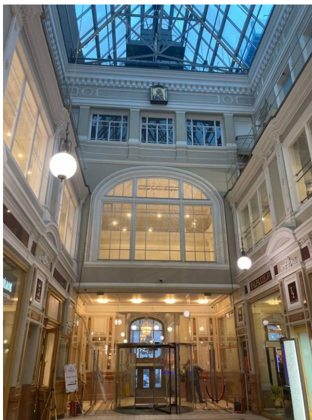
Фото 6. Фрагмент центральной галереи объекта культурного наследия регионального значения «Пассаж»
