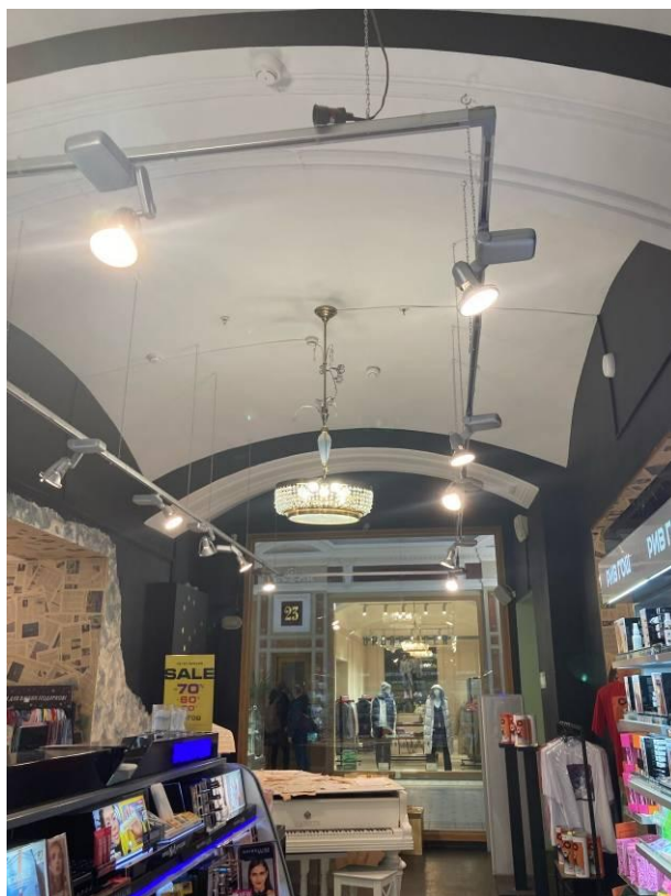
Фото 41. Интерьер помещений 1-Н (первый этаж) объекта культурного наследия регионального значения «Пасса́ж», ч.п. 10
