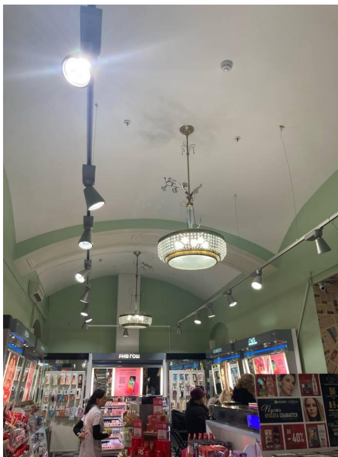
Фото 38. Интерьер помещений 1-Н (первый этаж) объекта культурного наследия регионального значения «Пасса́ж», ч.п. 10
