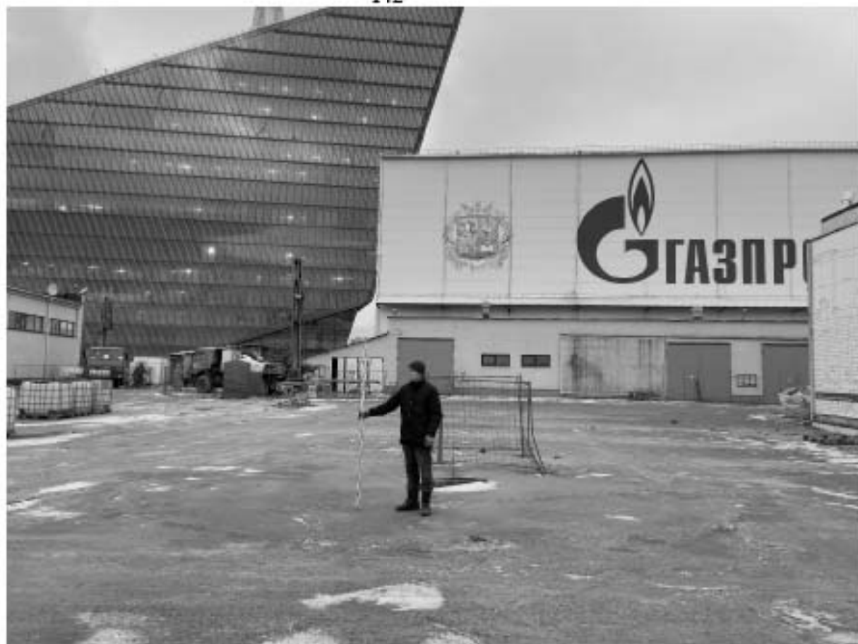
Рис. 44 Санкт-Петербург. Приморский район. Лахта. Общий вид участка обследования. Точка съемки №9 (южнее Береговой ул.). Вид на восток.
