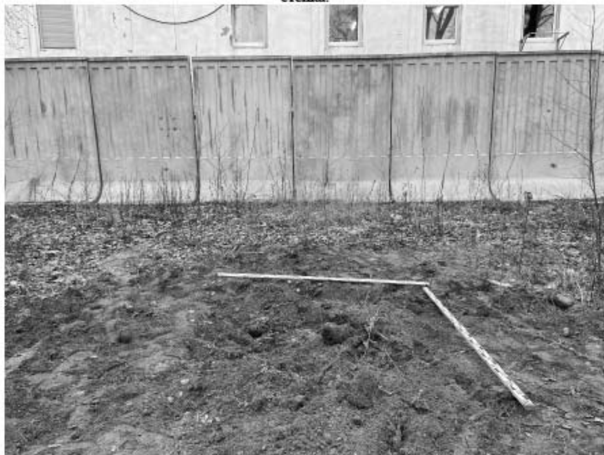
Рис. 139 Санкт-Петербург. Приморский район. Лахта. Шурф №9. Общий вид после рекультивации. Вид на север.
