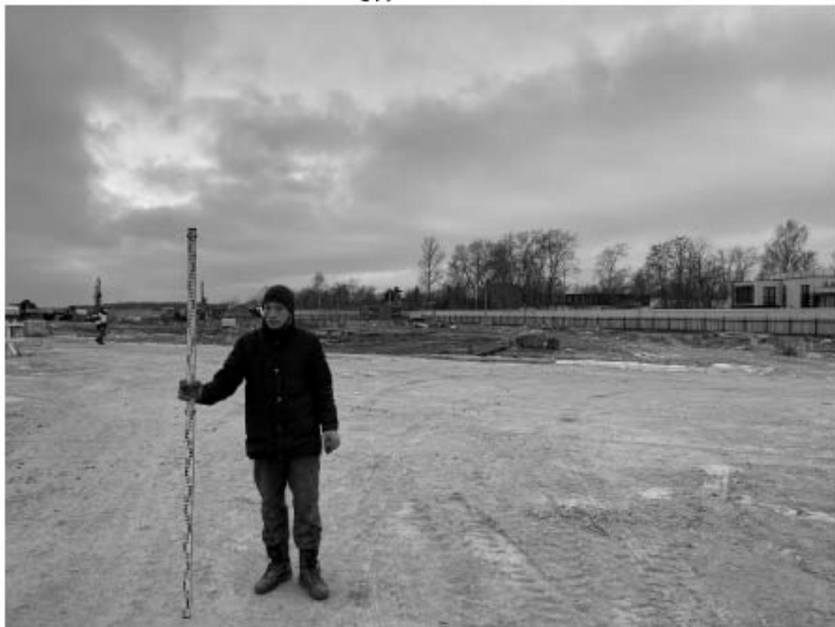
Рис. 48 Санкт-Петербург. Приморский район. Лахта. Общий вид участка обследования. Точка съемки №10 (южнее Береговой ул., территория строй площадки). Вид на северо-запад.
