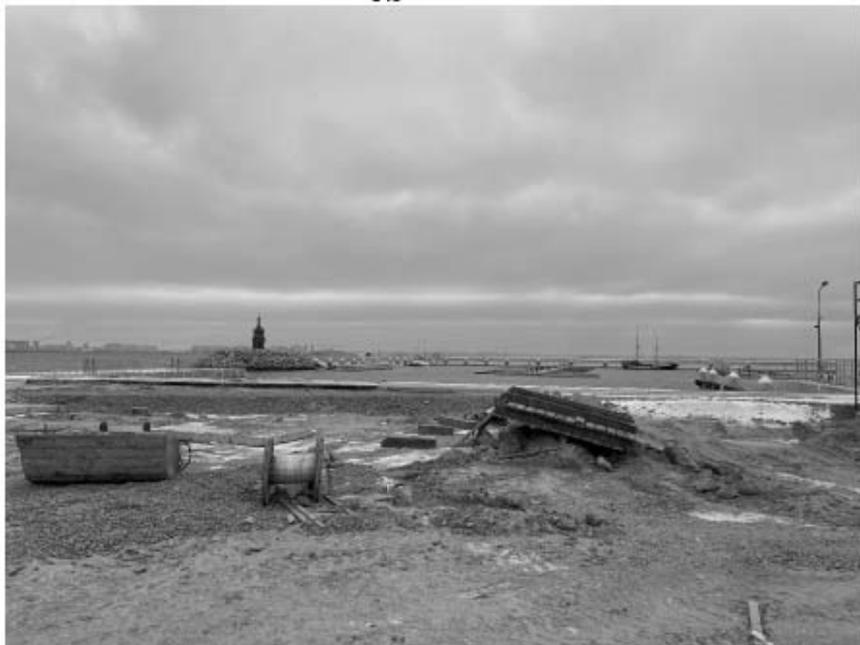
Рис. 50 Санкт-Петербург. Приморский район. Лахта. Общий вид участка обследования. Точка съемки №10 (южнее Береговой ул., территория строй площадки). Вид на юг.
