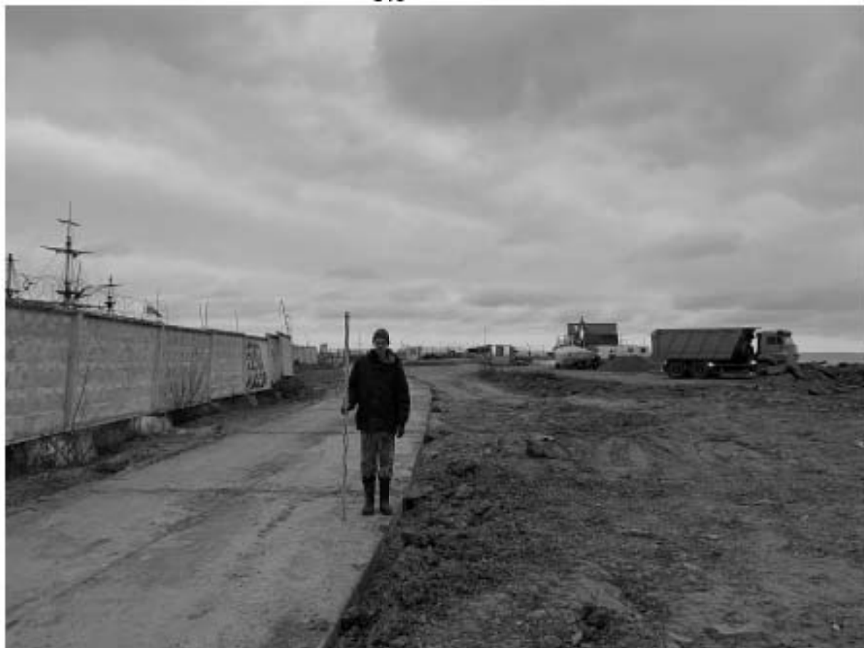
Рис. 52 Санкт-Петербург. Приморский район. Лахта. Общий вид участка обследования. Точка съемки №12 (южнее пересечения Береговой ул. и Полевого пер.). Вид на юг.
