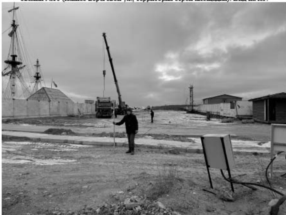
Рис. 51 Санкт-Петербург. Приморский район. Лахта. Общий вид участка обследования. Точка съемки №11 (южнее Береговой ул., территория строй площадки). Вид на юг.
