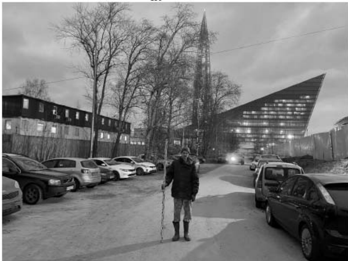
Рис. 38 Санкт-Петербург. Приморский район. Лахта. Общий вид участка обследования. Точка съемки №7 (пересечение Полевого пер. и Береговой ул.). Вид на восток.
