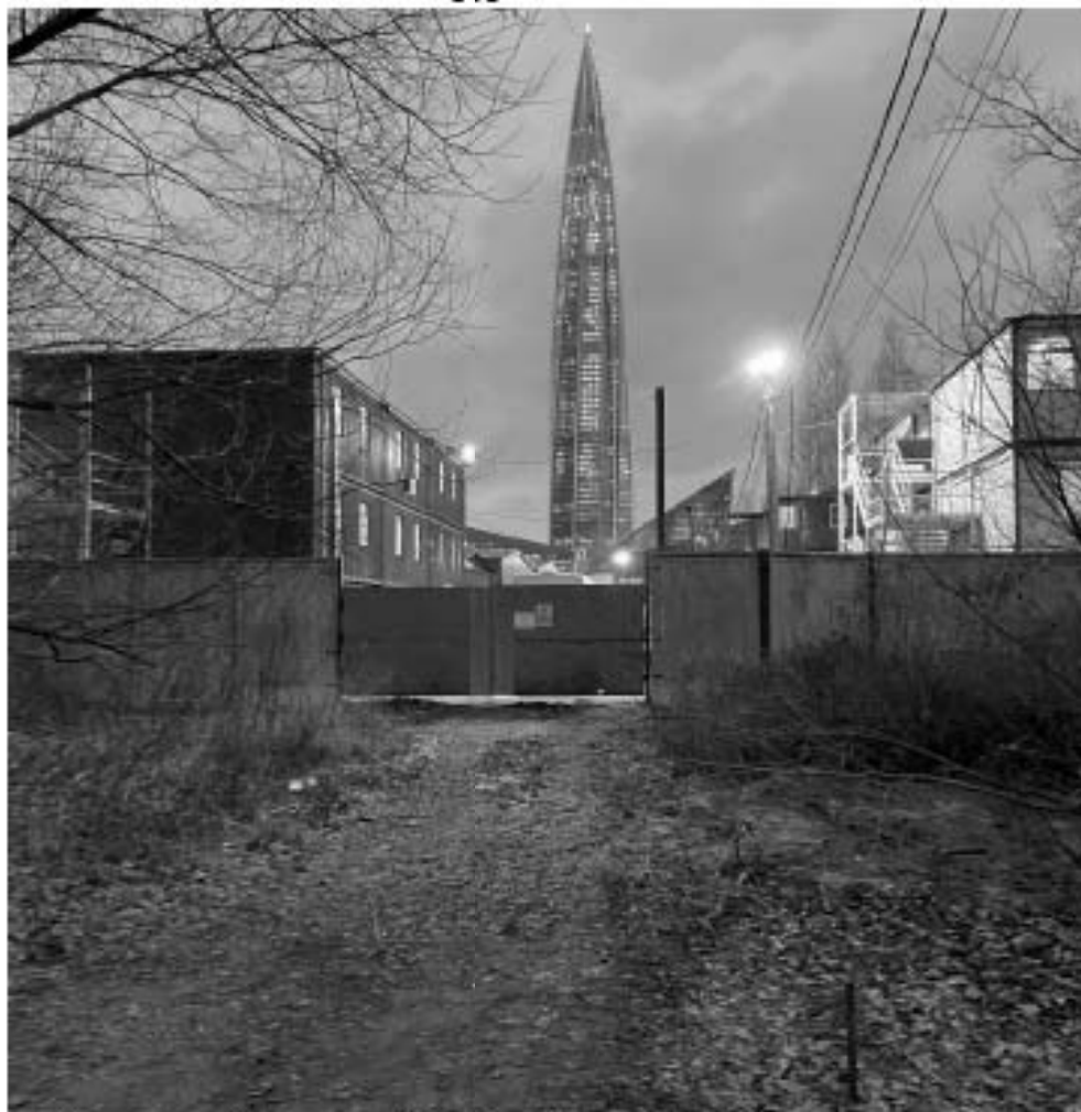
Рис. 42 Санкт-Петербург. Приморский район. Лахта. Общий вид участка обследования. Точка съемки №8 (пересечение Полевого пер. и Пляжевого пер.). Вид на восток.
