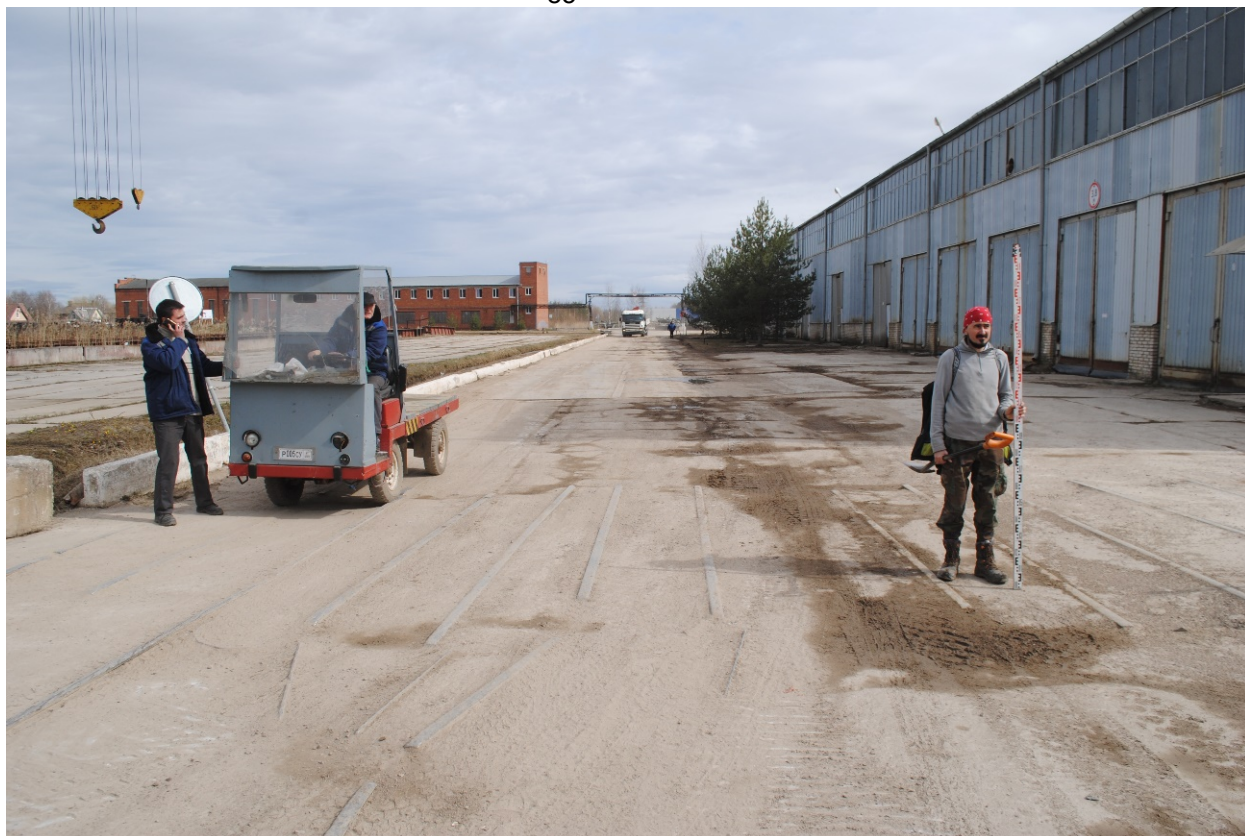
Рис.22. Санкт-Петербург, поселок Стрельна, Заводская дорога, дом 11, литера А. Общий вид трассы. Точка съемки 7. Вид на восток.
