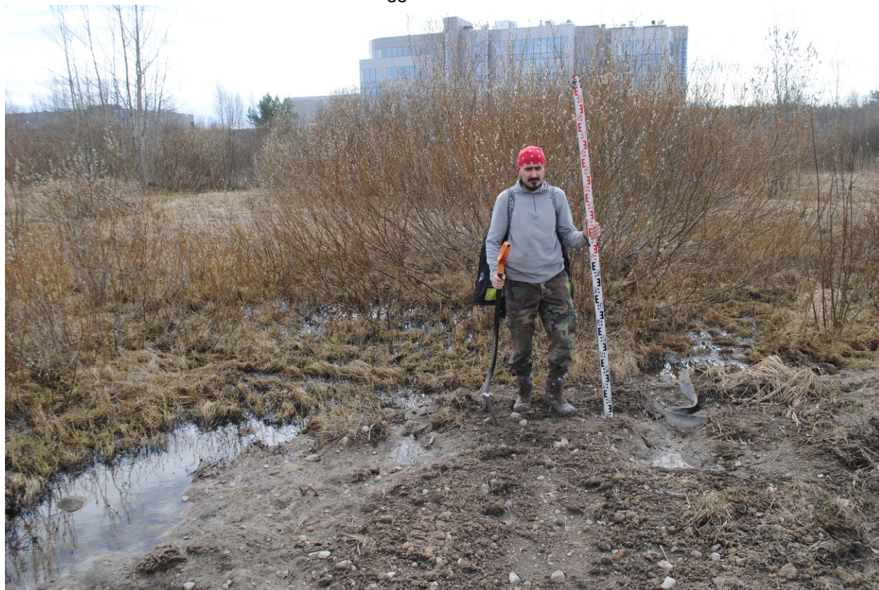
Рис.28. Санкт-Петербург, поселок Стрельна, Заводская дорога, дом 11, литера А. Общий вид трассы. Точка съемки 11 вид на юг.
