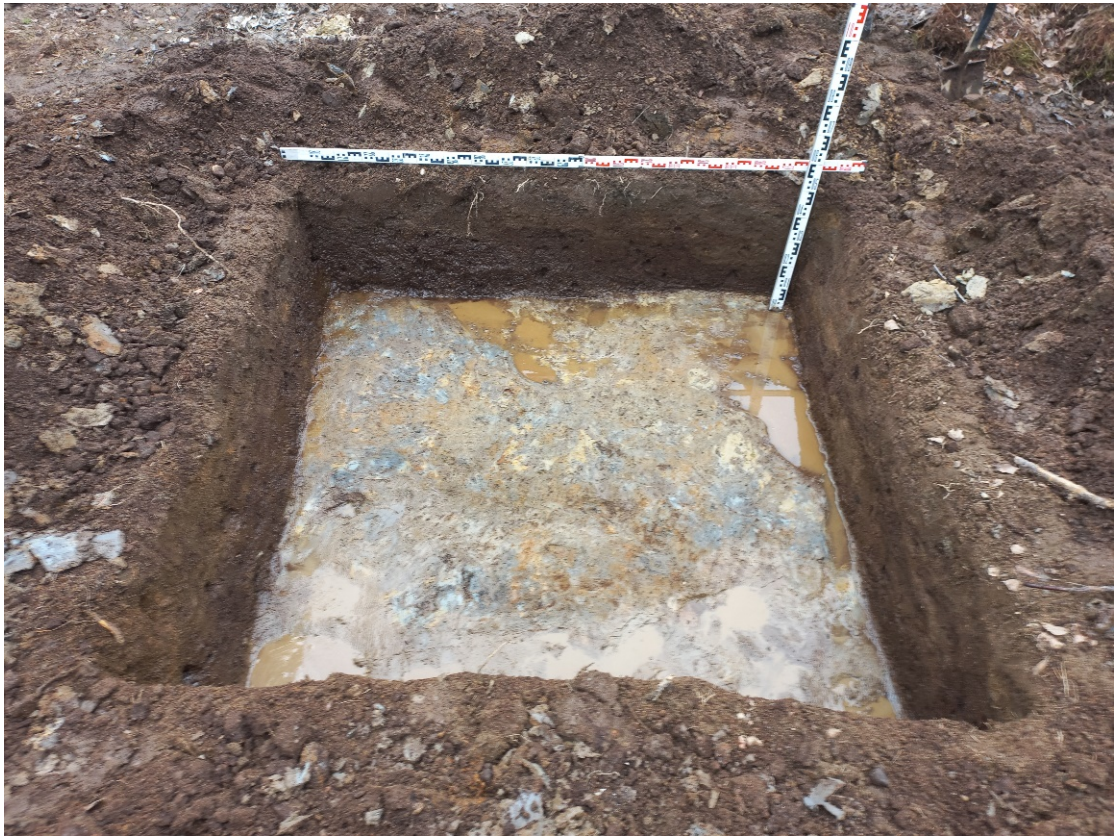
Рис.38. Санкт-Петербург, поселок Стрельна, Заводская дорога, дом 11, литера А. Шурф 2. Фотофиксация по уровню прекращения работ. Вид на восток.
