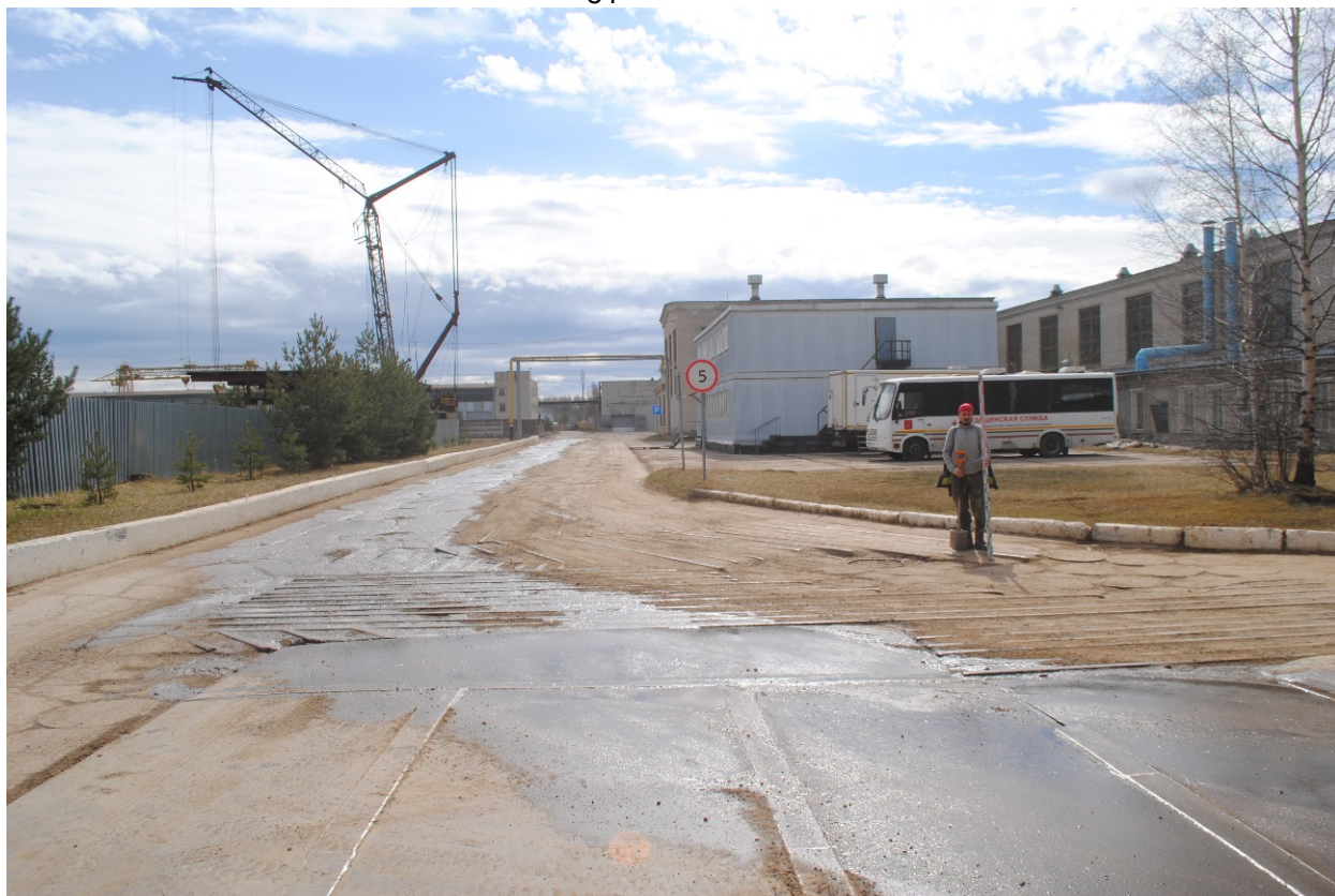
Рис.20. Санкт-Петербург, поселок Стрельна, Заводская дорога, дом 11, литера А. Общий вид трассы. Точка съемки 6. Вид на юг.
