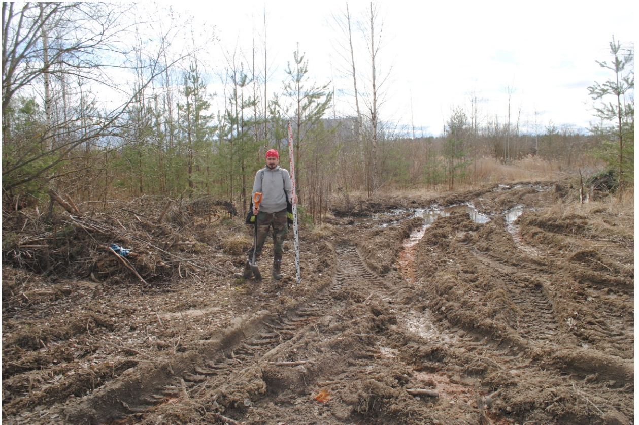
Рис.26. Санкт-Петербург, поселок Стрельна, Заводская дорога, дом 11, литера А. Общий вид трассы. Точка съемки 10 вид на юг.
