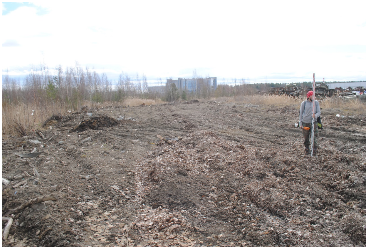
Рис.25. Санкт-Петербург, поселок Стрельна, Заводская дорога, дом 11, литера А. Общий вид трассы. Точка съемки 9 вид на юг.
