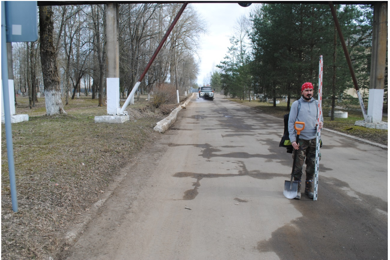
Рис.18. Санкт-Петербург, поселок Стрельна, Заводская дорога, дом 11, литера А. Общий вид трассы. Точка съемки 5. Вид на восток.
