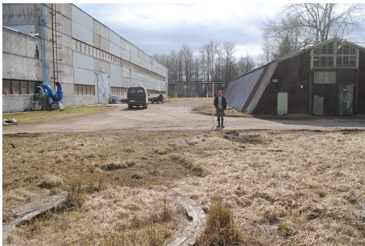
Рис.13. Санкт-Петербург, поселок Стрельна, Заводская дорога, дом 11, литера А. Общий вид трассы. Точка съемки 1. Вид на юг.
