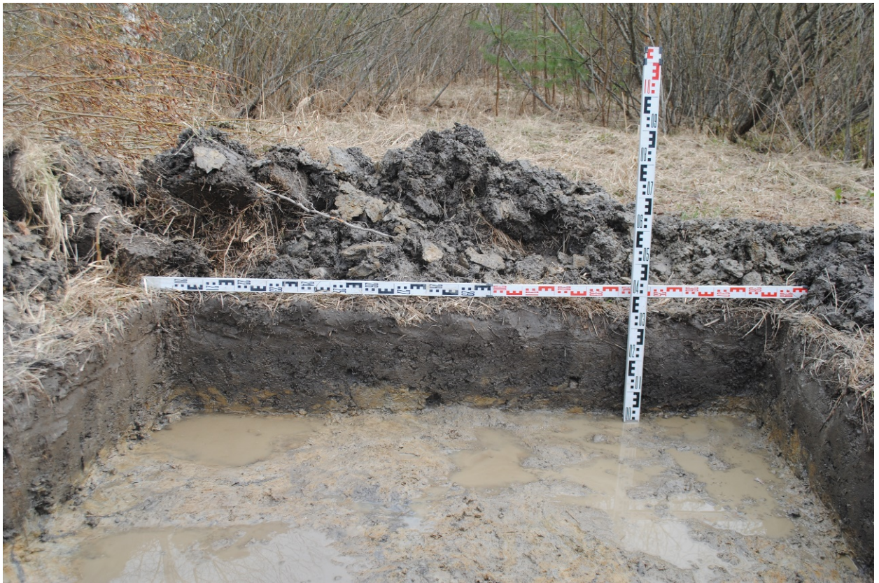
Рис.43. Санкт-Петербург, поселок Стрельна, Заводская дорога, дом 11, литера А. Шурф 3. Фотофиксация стратиграфии восточной стенки.
