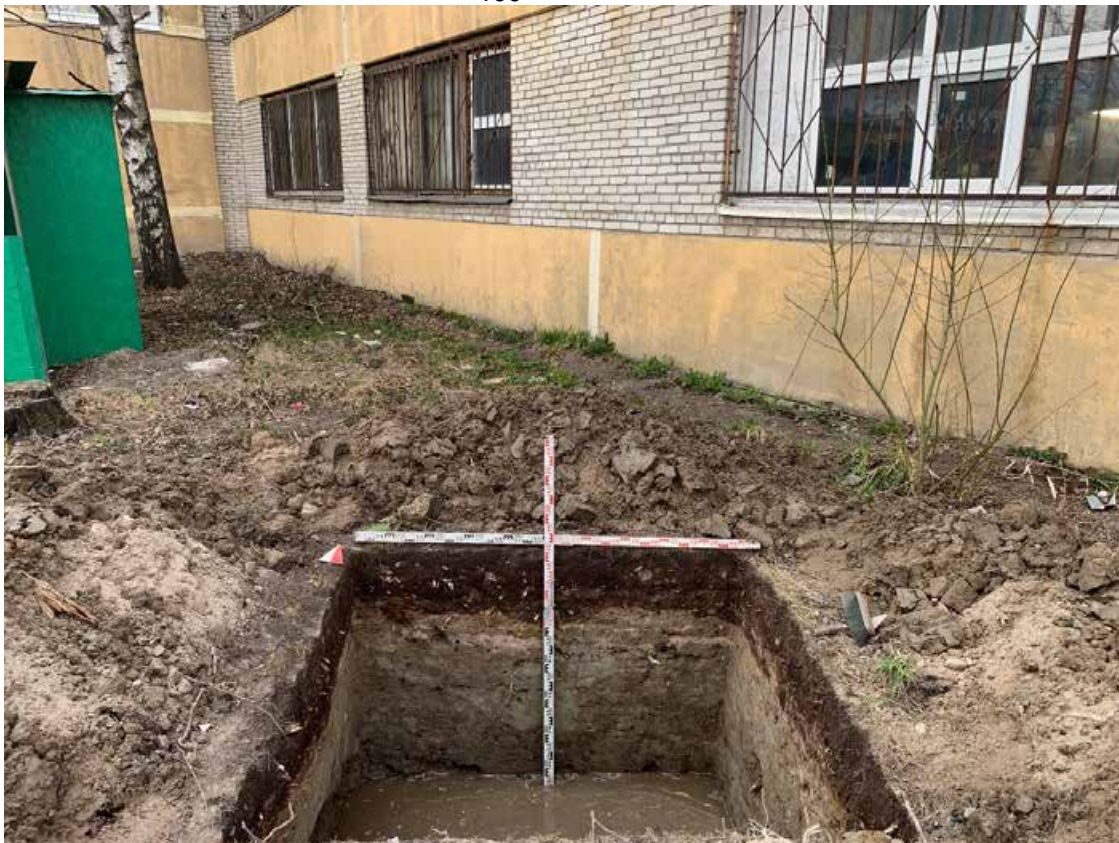
Рис. 46. СПб, Парголово, ул. Михаила Дудина, КН:78:36:0013101:20121-2023. Шурф 1. Фиксация по уровню окончания работ, вид на север.
