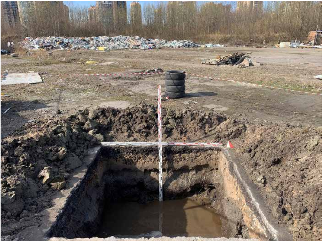
Рис. 70. СПб, Парголово, ул. Михаила Дудина, КН:78:36:0013101:20121-2023. Шурф 3. Фиксация по уровню окончания работ, вид на север.
