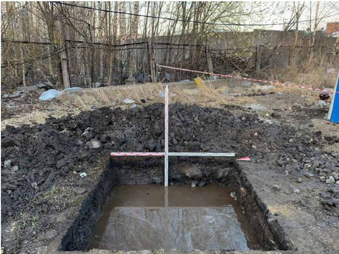
Рис. 65. СПб, Парголово, ул. Михаила Дудина, КН:78:36:0013101:20121-2023. Шурф 2. Фиксация по уровню окончания работ, вид на запад.
