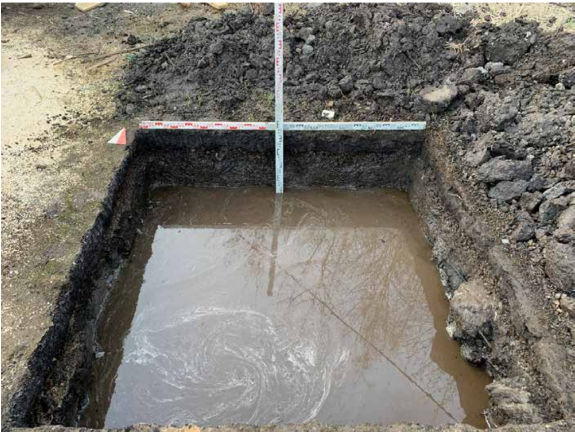
Рис. 59. СПб, Парголово, ул. Михаила Дудина, КН:78:36:0013101:20121-2023. Шурф 2. Фиксация по уровню окончания работ, вид на север.
