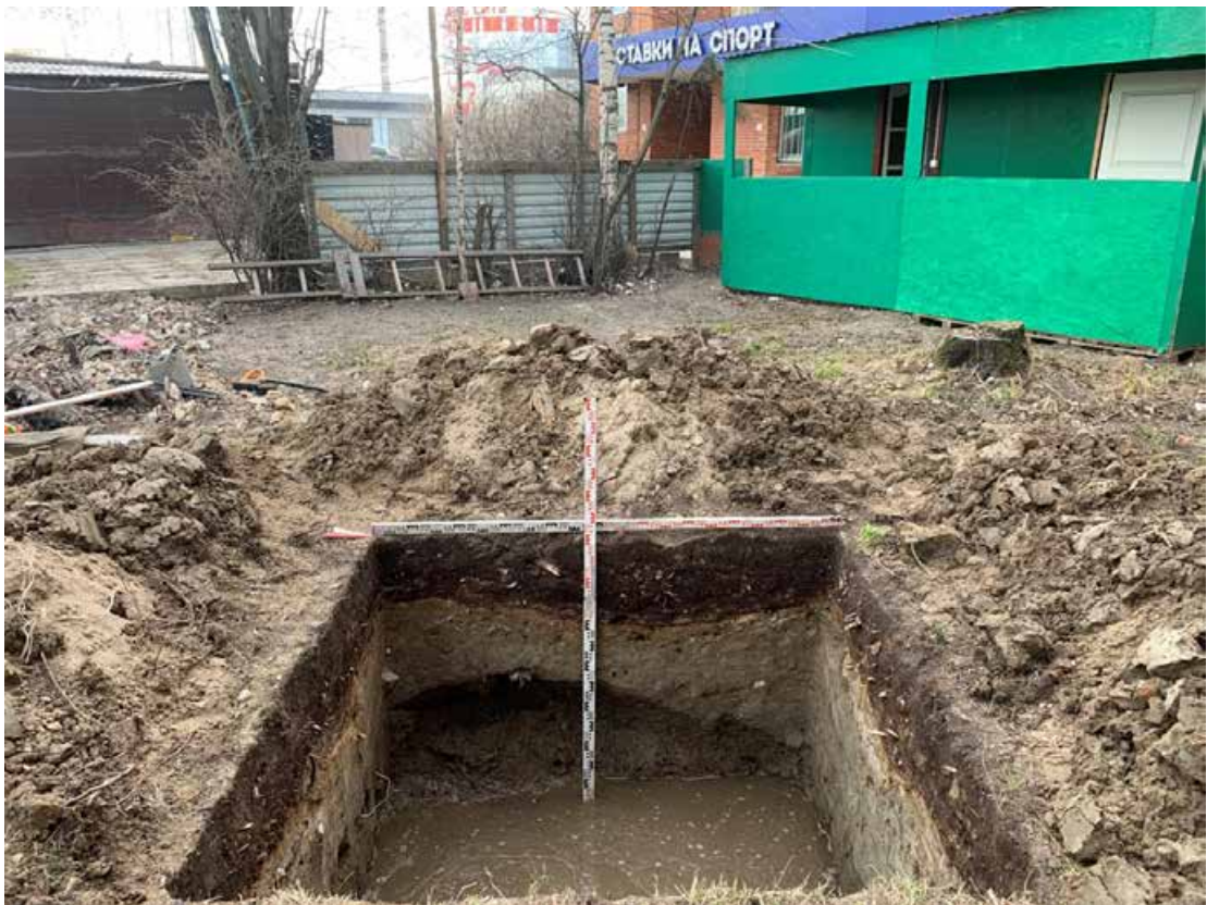
Рис. 53. СПб, Парголово, ул. Михаила Дудина, КН:78:36:0013101:20121-2023. Шурф 1. Фиксация по уровню окончания работ, вид на запад.
