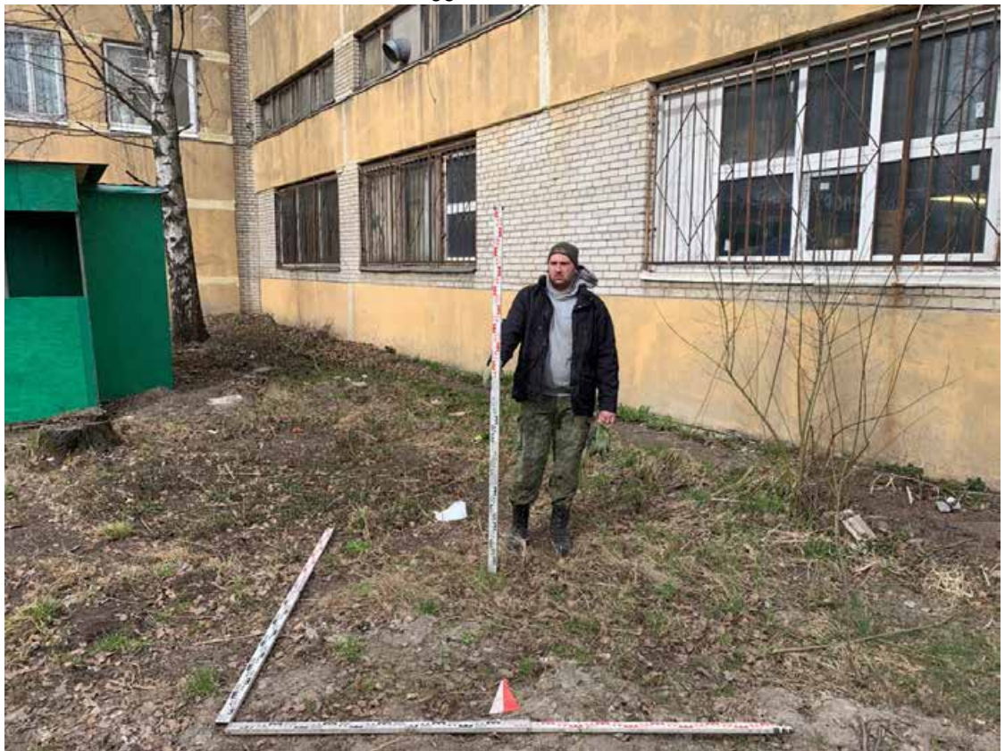
Рис. 44. СПб, Парголово, ул. Михаила Дудина, КН:78:36:0013101:20121-2023. Местоположение и дневная поверхность шурфа 1 до начала работ, вид на север.
