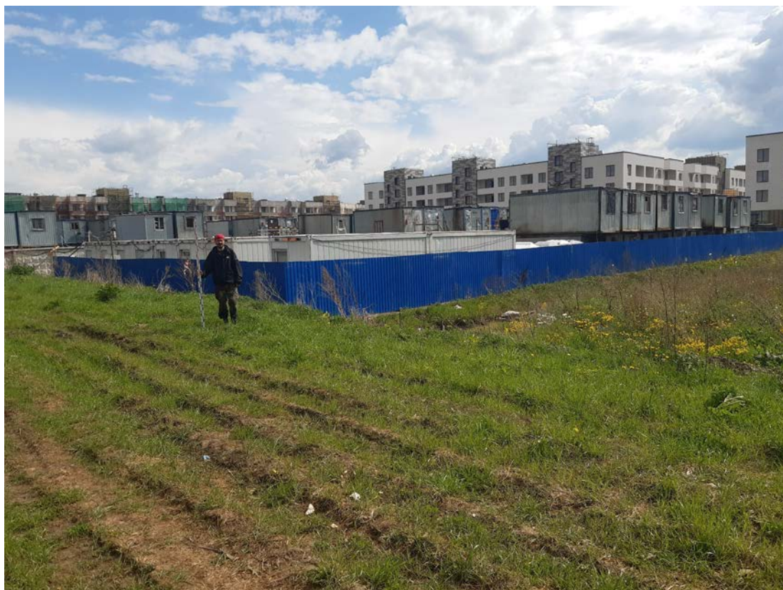
Рис.22. Санкт-Петербург (кадастровый номер: 78:40:0008501:10799). Общий вид участка. Точка съёмки 7. Вид на юг.
