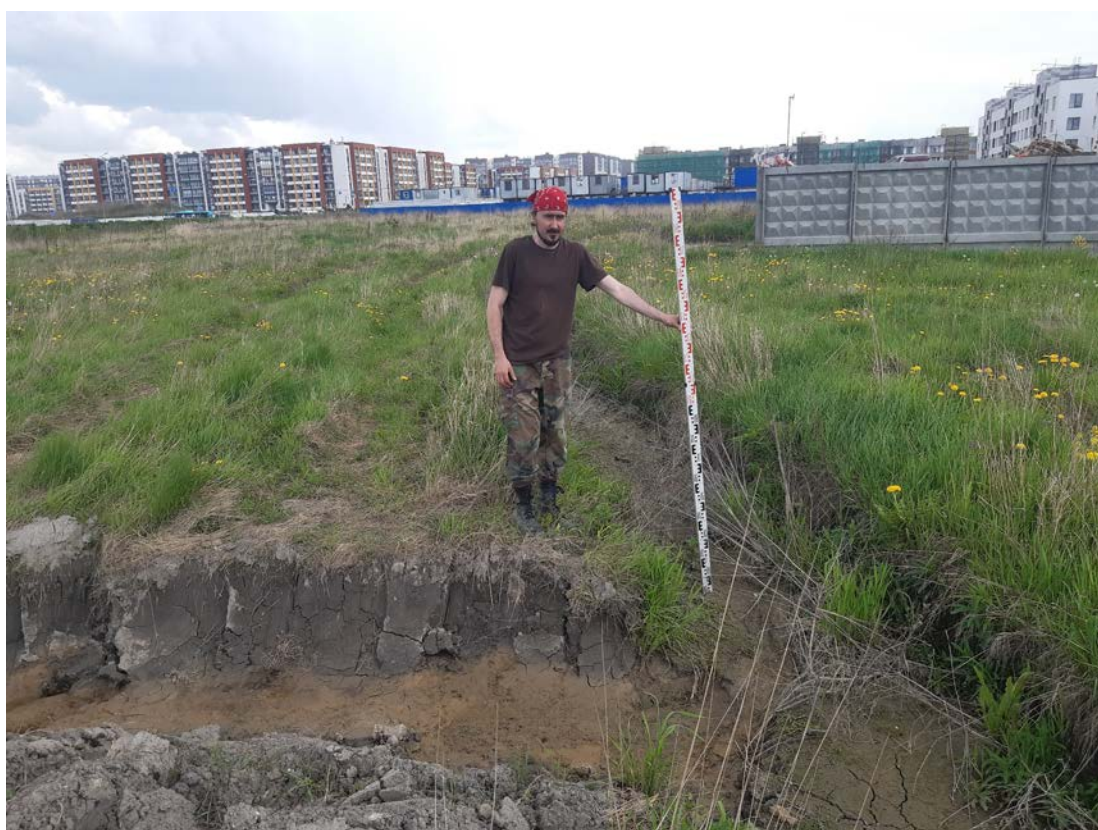
Рис. 16. Санкт-Петербург (кадастровый номер: 78:40:0008501:10799). Общий вид участка. Точка съемки 4. Вид на восток.
