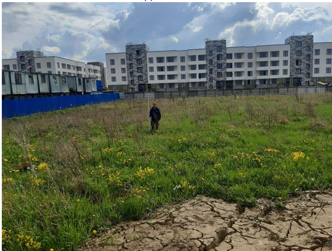
Рис.21. Санкт-Петербург (кадастровый номер: 78:40:0008501:10799). Общий вид участка. Точка съёмки 6. Вид на юго-запад.
