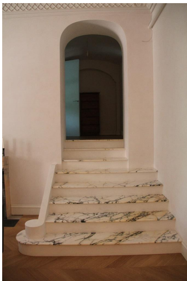
Фото 19. Вид на лестницу между помещениями №№ 1 и 7.
