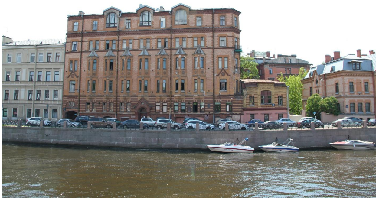
Фото 1. Вид на здание № 112 с противоположного берега р. Мойки.
