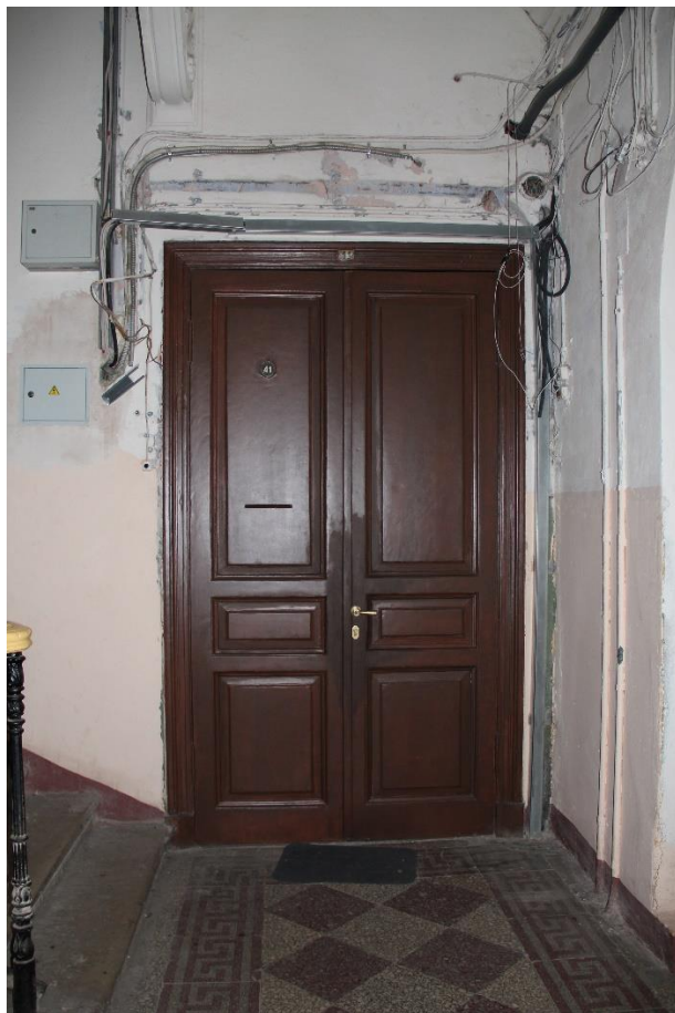
Фото 1. Вид на входную дверь в квартиру № 41.
