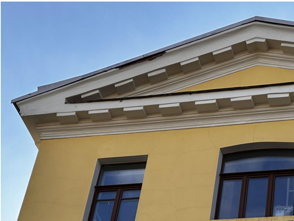
Фото 24. «Контора заводская», входящий в состав объекта культурного наследия федерального значения «Заводы ижорские адмиралтейские», Санкт-Петербург, г. Колпино, бульвар Победы, д. 1, литера АВ. Фрагмент дворового восточного фасада аттика здания. Дата съемки: 26.04.2023 г. Автор съемки: Куваева Ю.П.
