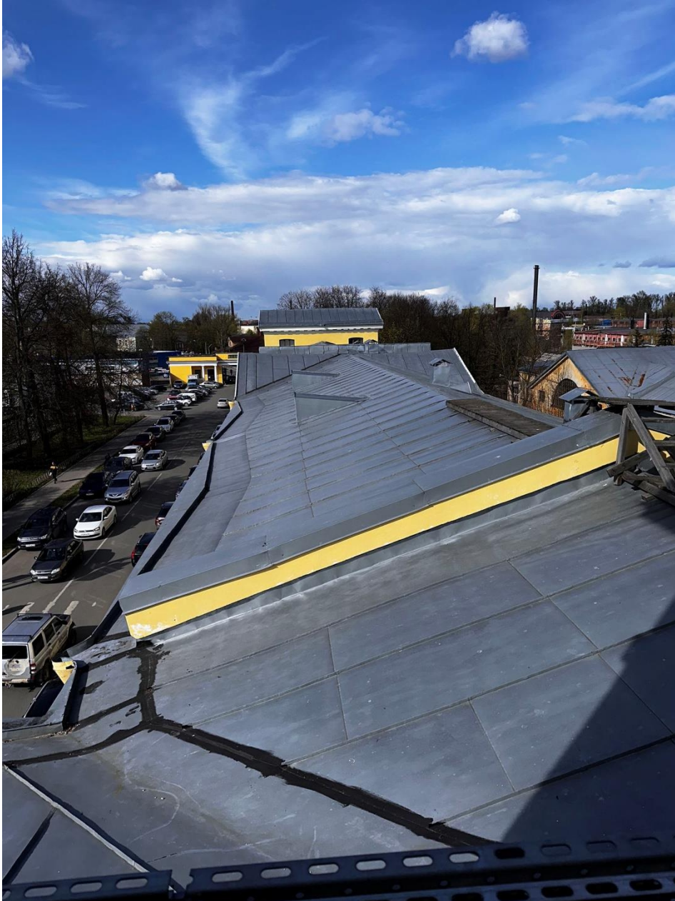
Фото 35. «Контора заводская», входящий в состав объекта культурного наследия федерального значения «Заводы ижорские адмиралтейские», Санкт-Петербург, г. Колпино, бульвар Победы, д. 1, литера АВ. Вид на северную часть крыши с центральной башни с юга. Дата съемки: 26.04.2023 г. Автор съемки: Куваева Ю.П.
