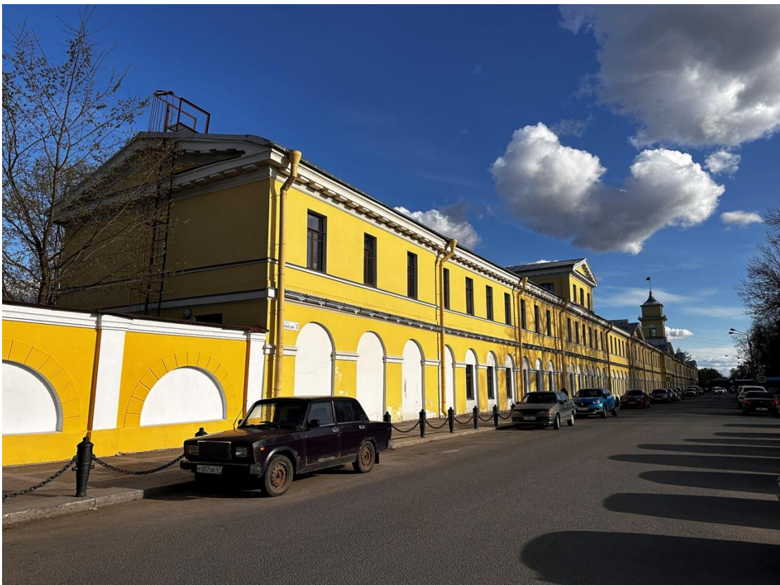
Фото 2. «Контора заводская», входящий в состав объекта культурного наследия федерального значения «Заводы ижорские адмиралтейские», Санкт-Петербург, г. Колпино, бульвар Победы, д. 1, литера АВ. Общий вид здания с северо-запада. Дата съемки: 26.04.2023 г. Автор съемки: Куваева Ю.П.
