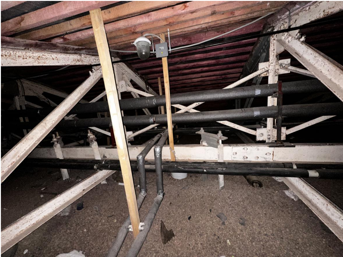
Фото 64. «Контора заводская», входящий в состав объекта культурного наследия федерального значения «Заводы ижорские адмиралтейские», Санкт-Петербург, г. Колпино, бульвар Победы, д. 1, литера АВ. Средняя часть помещения чердака между осями 2-9 и В-Г. Фото с запада. Дата съемки: 26.04.2023 г. Автор съемки: Куваева Ю.П.
