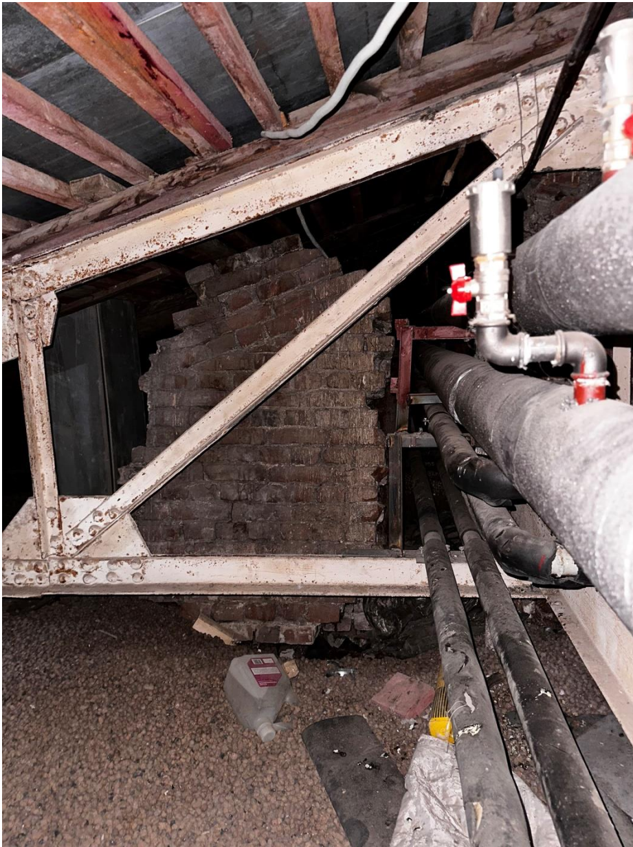
Фото 65. «Контора заводская», входящий в состав объекта культурного наследия федерального значения «Заводы ижорские адмиралтейские», Санкт-Петербург, г. Колпино, бульвар Победы, д. 1, литера АВ. Южная часть помещения чердака между осями 2-9 и В-Г. Восточный скат. Фото с севера. Дата съемки: 26.04.2023 г. Автор съемки: Куваева Ю.П.
