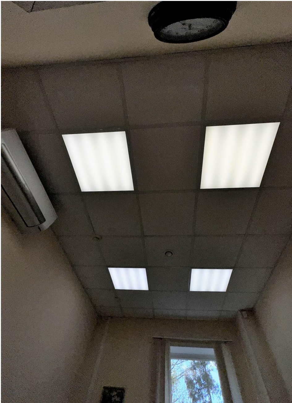
Фото 41. «Контора заводская», входящий в состав объекта культурного наследия федерального значения «Заводы ижорские адмиралтейские», Санкт-Петербург, г. Колпино, бульвар Победы, д. 1, литера АВ. 2-ой этаж. Помещение кабинета между осями 1-2 и А-Б. Дата съемки: 26.04.2023 г. Автор съемки: Куваева Ю.П.
