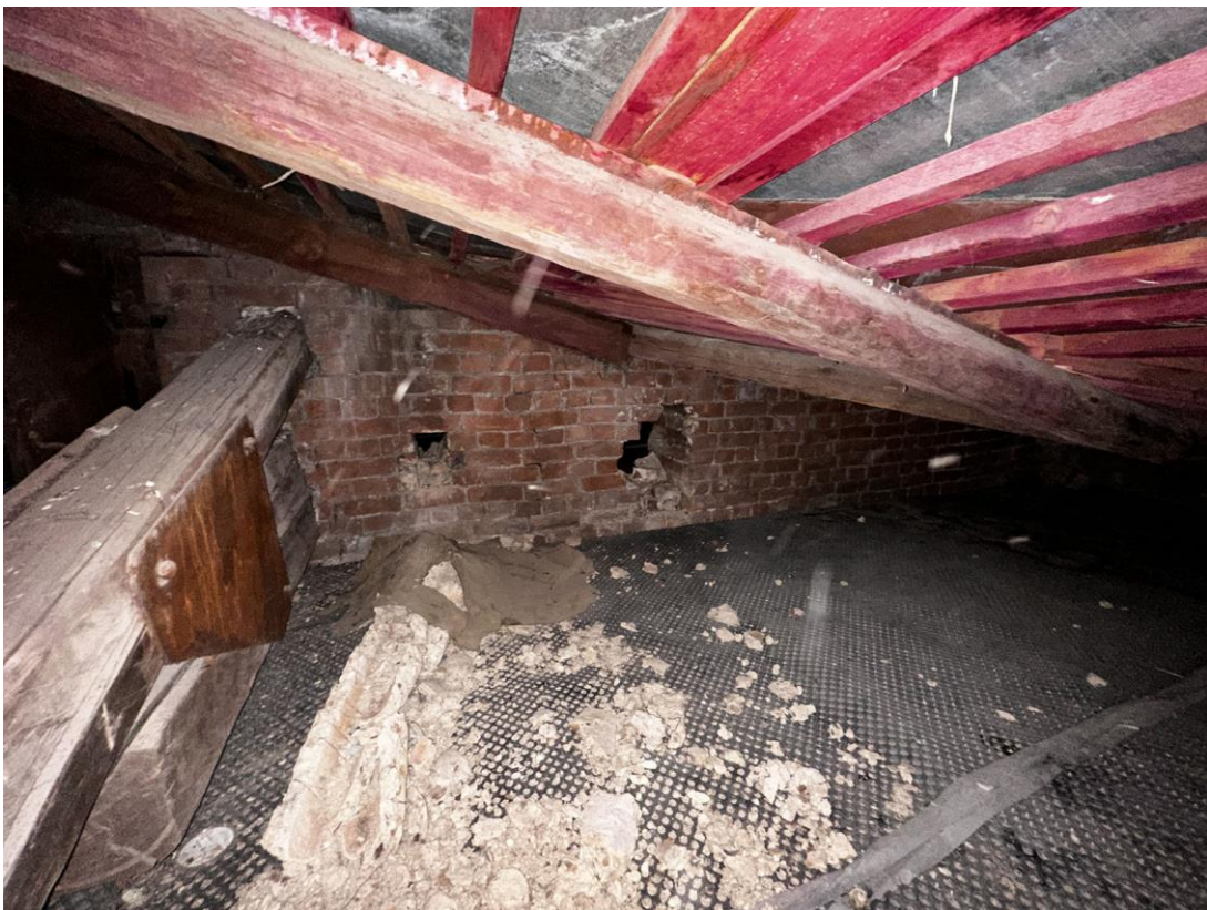
Фото 92. «Контора заводская», входящий в состав объекта культурного наследия федерального значения «Заводы ижорские адмиралтейские», Санкт-Петербург, г. Колпино, бульвар Победы, д. 1, литера АВ. Южная часть помещения чердака между осями 18-20 и В-Г. Западный скат. Вид на поперечную стену по оси 18 с севера. Дата съемки: 26.04.2023 г. Автор съемки: Куваева Ю.П.
