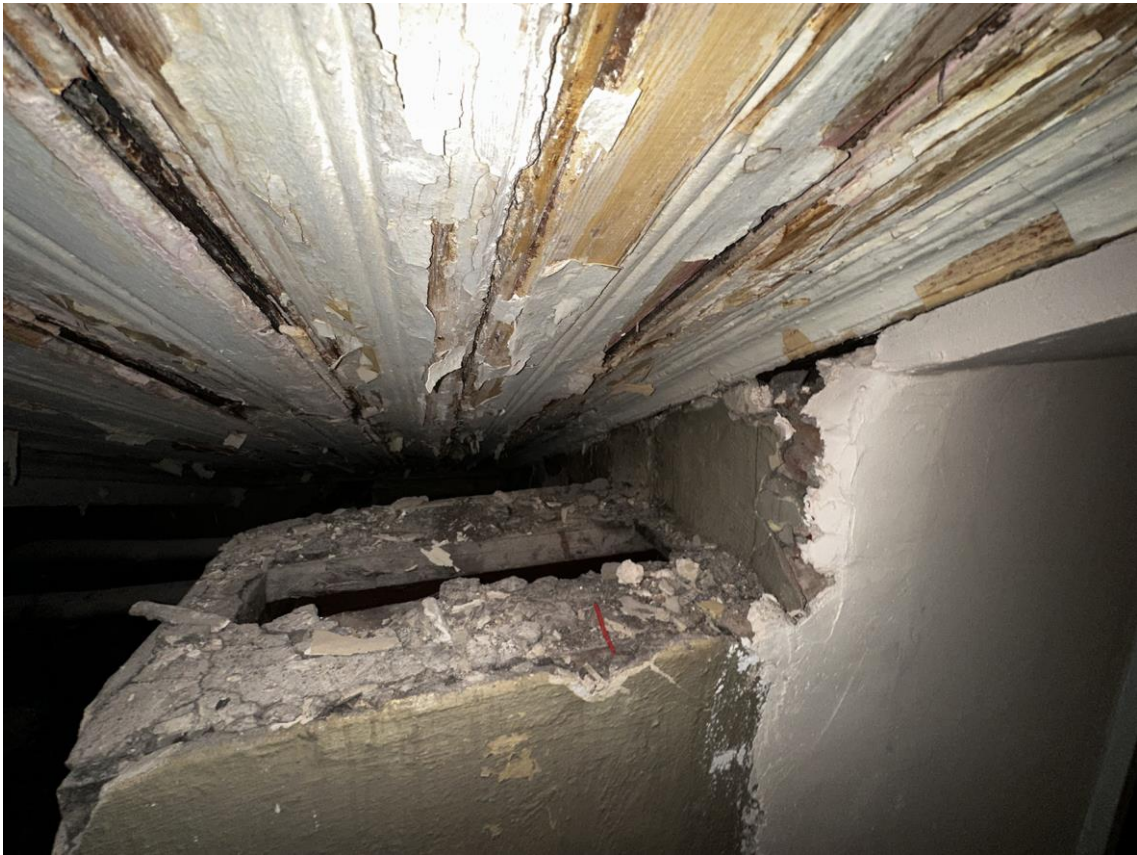
Фото 60. «Контора заводская», входящий в состав объекта культурного наследия федерального значения «Заводы ижорские адмиралтейские», Санкт-Петербург, г. Колпино, бульвар Победы, д. 1, литера АВ. Помещение чердака между осями 1-2 и Б-Г. Стена по оси Б. Вентиляционная шахта. Дата съемки: 26.04.2023 г. Автор съемки: Куваева Ю.П.
