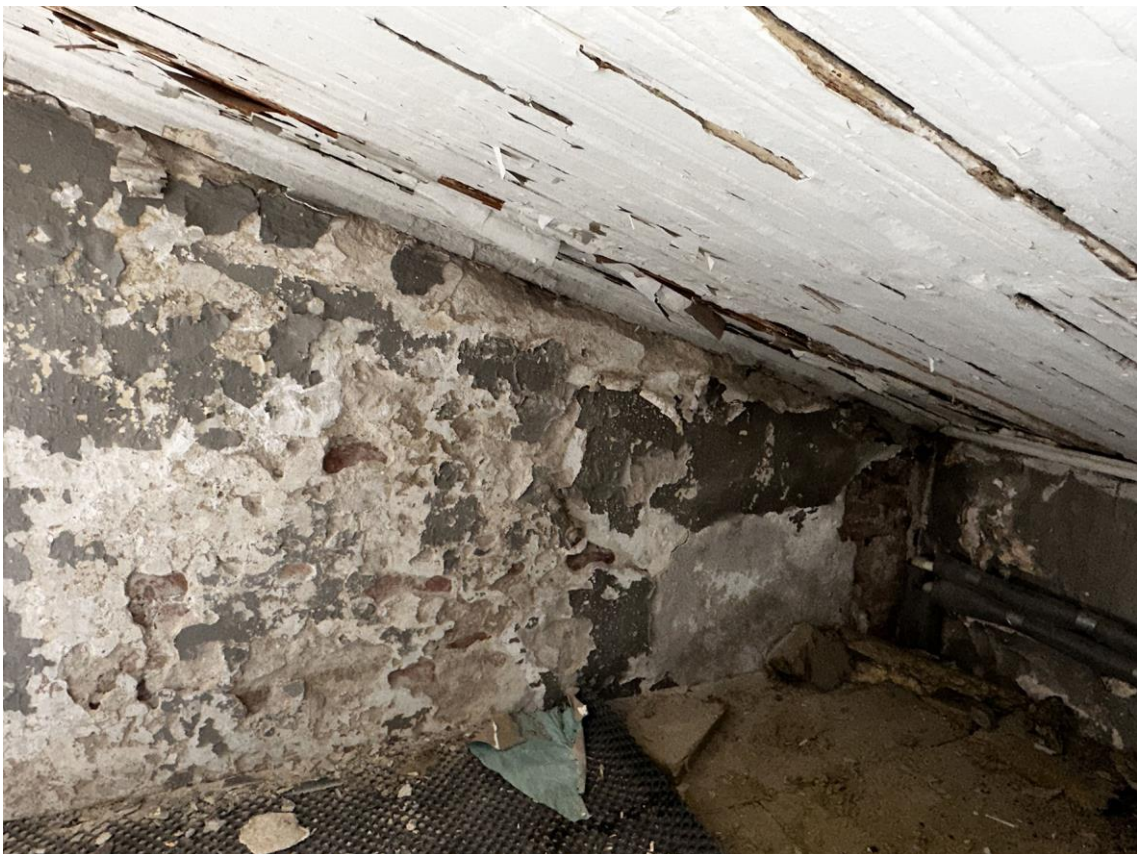
Фото 57. «Контора заводская», входящий в состав объекта культурного наследия федерального значения «Заводы ижорские адмиралтейские», Санкт-Петербург, г. Колпино, бульвар Победы, д. 1, литера АВ. Помещение чердака между осями 1-2 и Б-Г. Наружная (западная) стена по оси Г. Фото с юго-востока. Дата съемки: 26.04.2023 г. Автор съемки: Куваева Ю.П.
