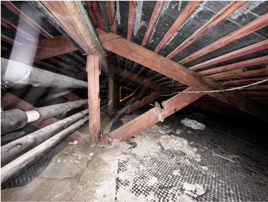
Фото 77. «Контора заводская», входящий в состав объекта культурного наследия федерального значения «Заводы ижорские адмиралтейские», Санкт-Петербург, г. Колпино, бульвар Победы, д. 1, литера АВ. Средняя часть помещения чердака между осями 10-14 и В-Г. Западный скат. Фото с севера. Дата съемки: 26.04.2023 г. Автор съемки: Куваева Ю.П.
