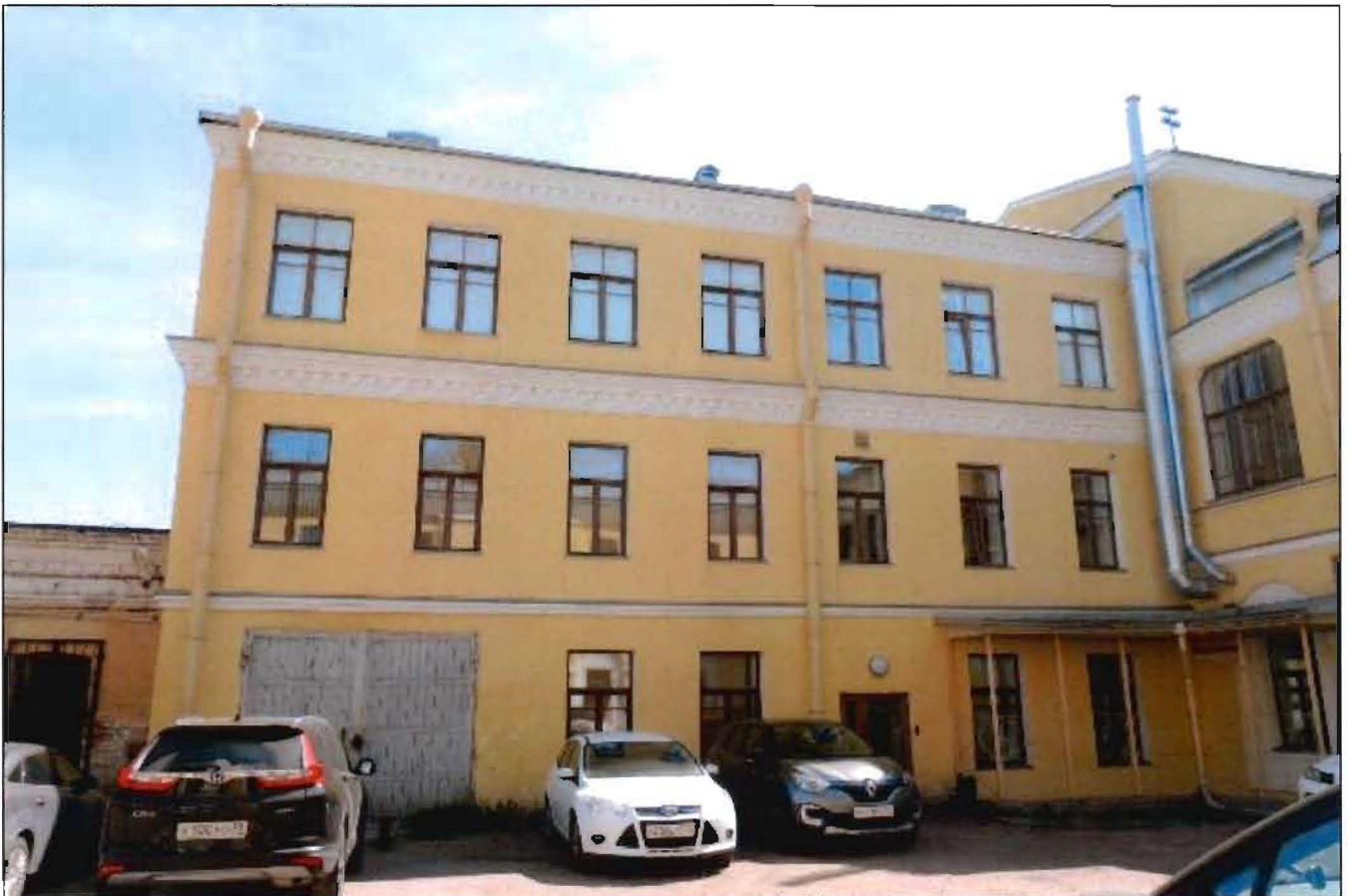
7. Западный дворовый фасад объекта культурного наследия.
