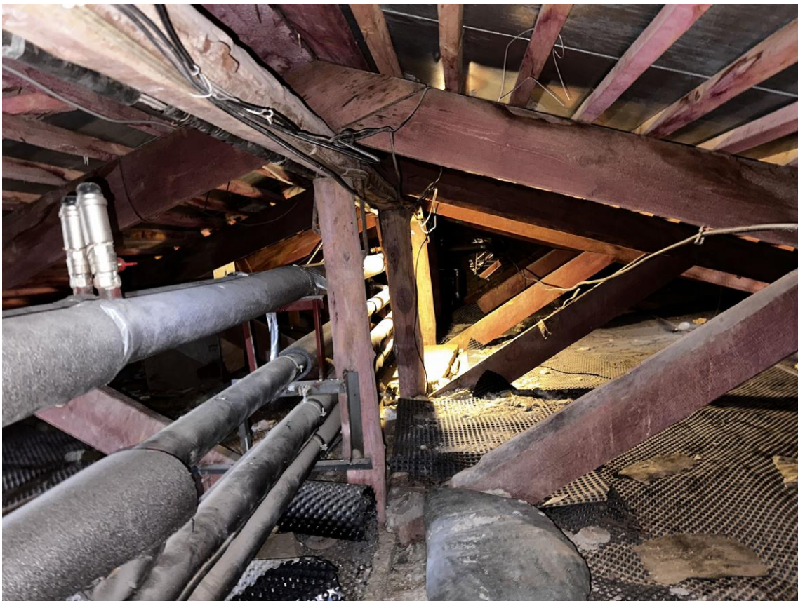
Фото 78. «Контора заводская», входящий в состав объекта культурного наследия федерального значения «Заводы ижорские адмиралтейские», Санкт-Петербург, г. Колпино, бульвар Победы, д. 1, литера АВ. Южная часть помещения чердака между осями 10-14 и В-Г. Общий вид с севера. Дата съемки: 26.04.2023 г. Автор съемки: Куваева Ю.П.
