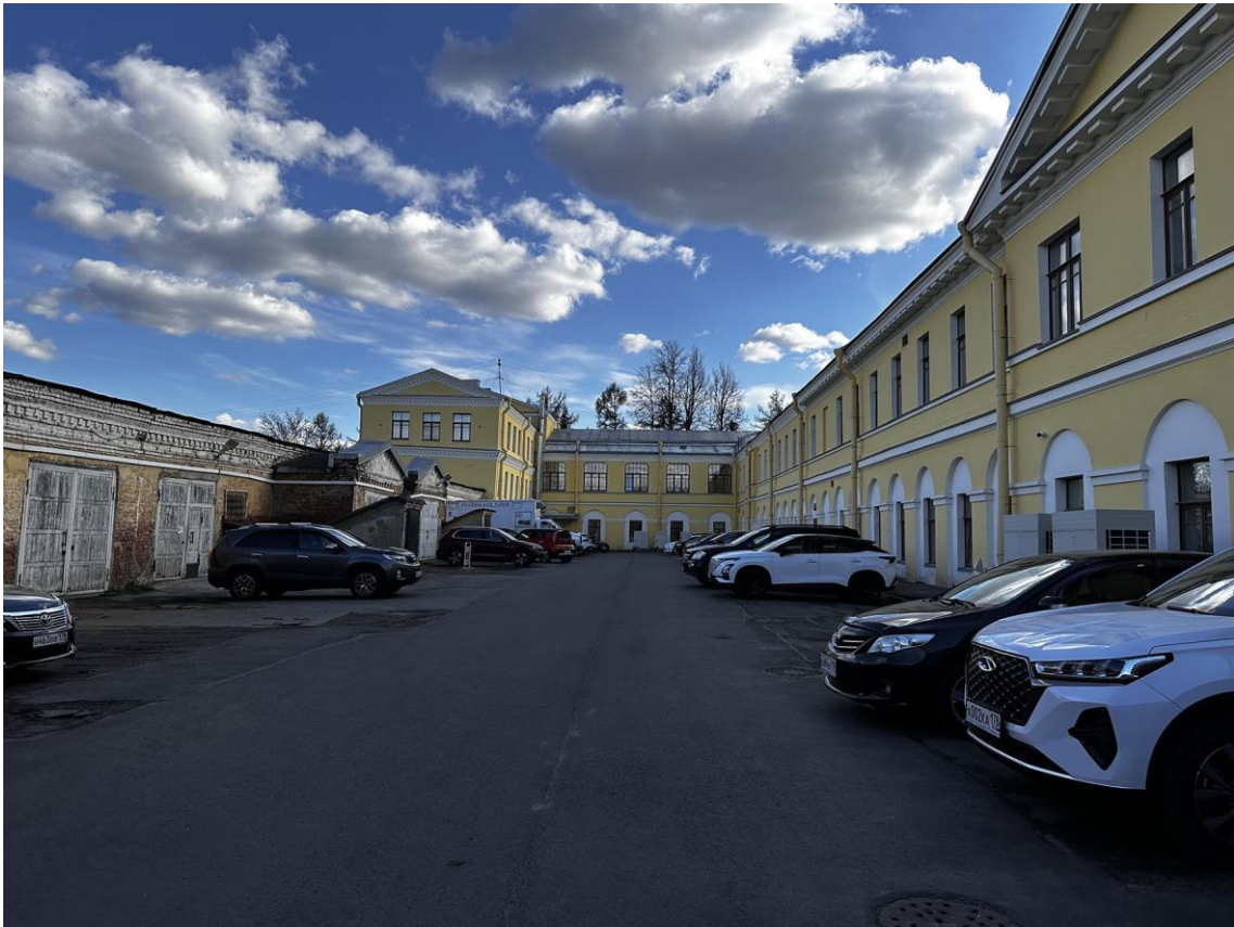
Фото 6. «Контора заводская», входящий в состав объекта культурного наследия федерального значения «Заводы ижорские адмиралтейские», Санкт-Петербург, г. Колпино, бульвар Победы, д. 1, литера АВ. Общий вид дворовых фасадов здания с севера. Дата съемки: 26.04.2023 г. Автор съемки: Куваева Ю.П.
