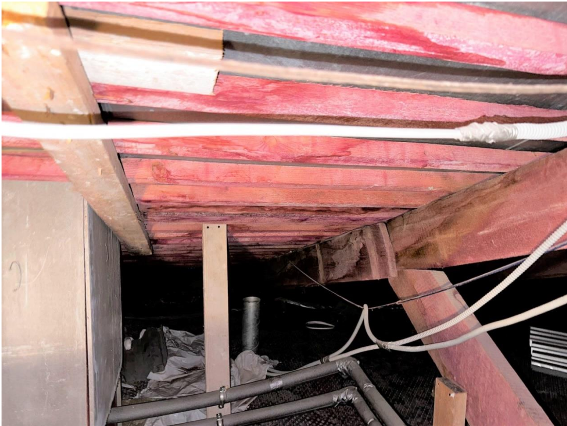
Фото 79. «Контора заводская», входящий в состав объекта культурного наследия федерального значения «Заводы ижорские адмиралтейские», Санкт-Петербург, г. Колпино, бульвар Победы, д. 1, литера АВ. Южная часть помещения чердака между осями 10-14 и В-Г. Восточный скат. Фото с запада. Дата съемки: 26.04.2023 г. Автор съемки: Куваева Ю.П.
