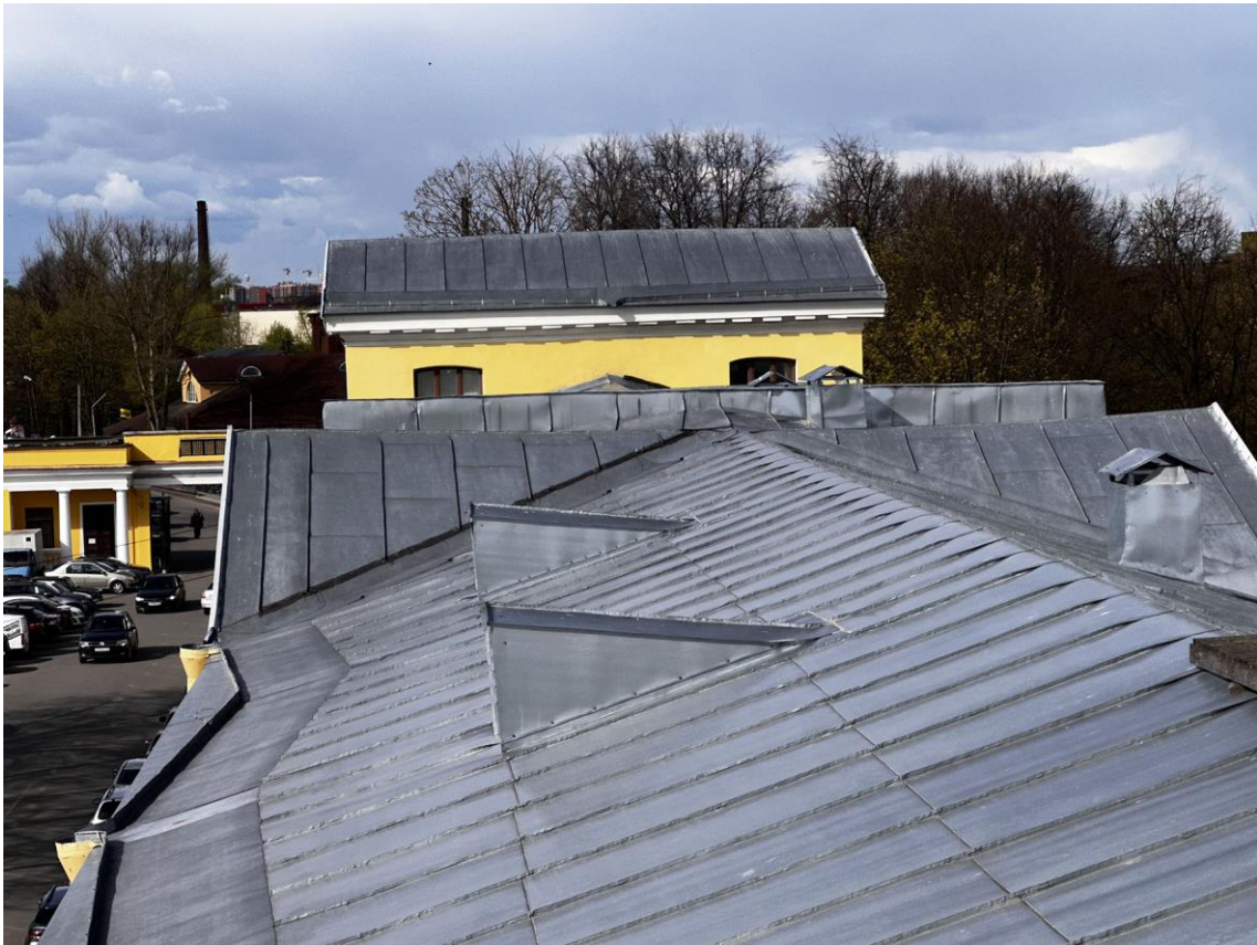
Фото 36. «Контора заводская», входящий в состав объекта культурного наследия федерального значения «Заводы ижорские адмиралтейские», Санкт-Петербург, г. Колпино, бульвар Победы, д. 1, литера АВ. Вид на северную часть крыши с центральной башни с юга. Фрагмент. Дата съемки: 26.04.2023 г. Автор съемки: Куваева Ю.П.
