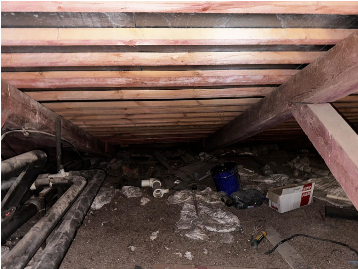
Фото 70. «Контора заводская», входящий в состав объекта культурного наследия федерального значения «Заводы ижорские адмиралтейские», Санкт-Петербург, г. Колпино, бульвар Победы, д. 1, литера АВ. Помещение чердака между осями 9-10 и В-Г. Западный скат. Фото с востока. Дата съемки: 26.04.2023 г. Автор съемки: Куваева Ю.П.
