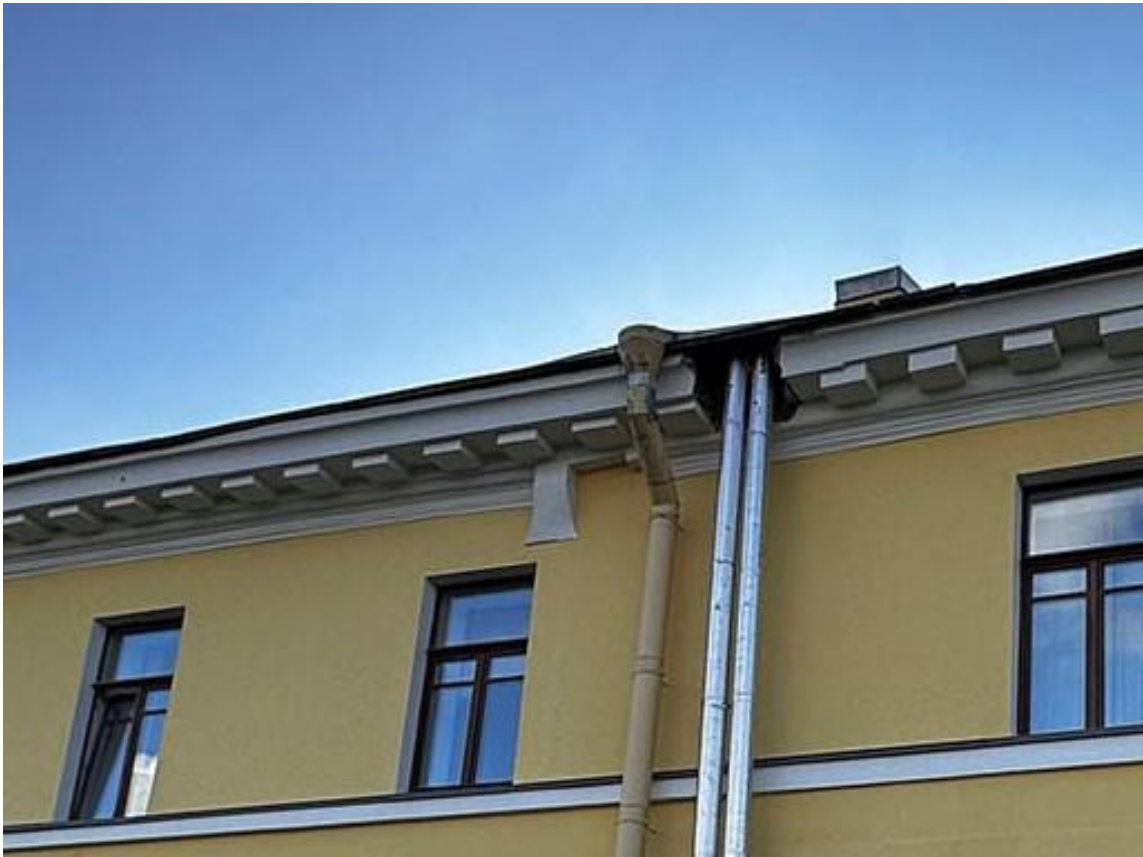
Фото 31. «Контора заводская», входящий в состав объекта культурного наследия федерального значения «Заводы ижорские адмиралтейские», Санкт-Петербург, г. Колпино, бульвар Победы, д. 1, литера АВ. Фрагмент дворового восточного фасада здания. Дата съемки: 26.04.2023 г. Автор съемки: Куваева Ю.П.
