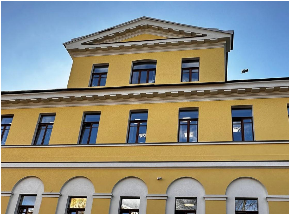
Фото 23. «Контора заводская», входящий в состав объекта культурного наследия федерального значения «Заводы ижорские адмиралтейские», Санкт-Петербург, г. Колпино, бульвар Победы, д. 1, литера АВ. Фрагмент дворового восточного фасада здания. Дата съемки: 26.04.2023 г. Автор съемки: Куваева Ю.П.
