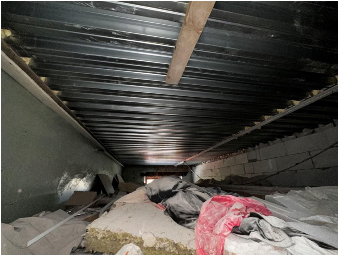
Фото 50. «Контора заводская», входящий в состав объекта культурного наследия федерального значения «Заводы ижорские адмиралтейские», Санкт-Петербург, г. Колпино, бульвар Победы, д. 1, литера АВ. Общий вид существующего перекрытия над лестничной клеткой между осями 1-2 и А-Б. Фото с запада. Дата съемки: 26.04.2023 г. Автор съемки: Куваева Ю.П.
