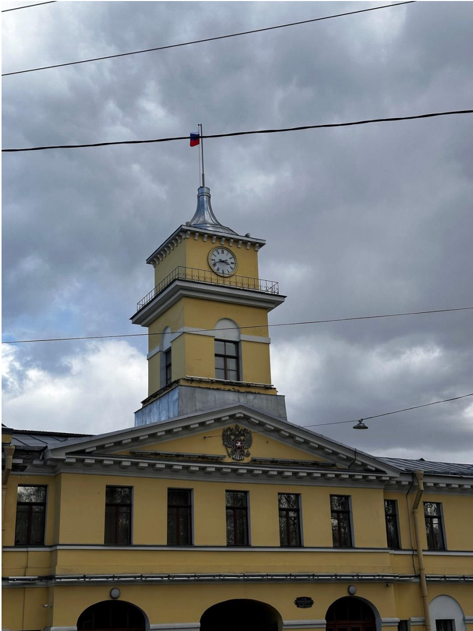
Фото 16. «Контора заводская», входящий в состав объекта культурного наследия федерального значения «Заводы ижорские адмиралтейские», Санкт-Петербург, г. Колпино, бульвар Победы, д. 1, литера АВ. Фрагмент лицевого западного фасада здания с центральной башней. Фото с северо-запада. Дата съемки: 26.04.2023 г. Автор съемки: Куваева Ю.П.
