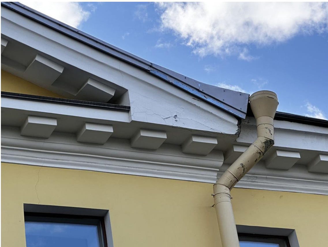
Фото 32. «Контора заводская», входящий в состав объекта культурного наследия федерального значения «Заводы ижорские адмиралтейские», Санкт-Петербург, г. Колпино, бульвар Победы, д. 1, литера АВ. Фрагмент дворового восточного фасада здания. Дата съемки: 26.04.2023 г. Автор съемки: Куваева Ю.П.
