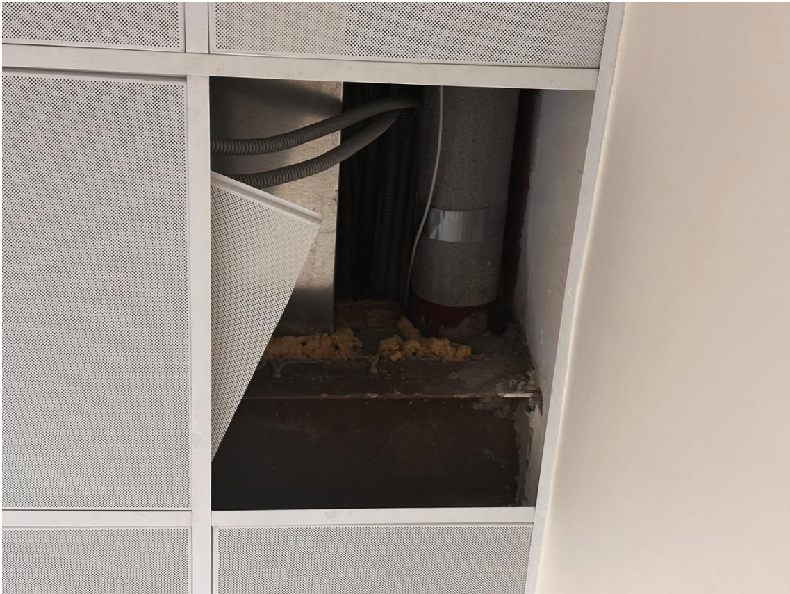
Фото 47. «Контора заводская», входящий в состав объекта культурного наследия федерального значения «Заводы ижорские адмиралтейские», Санкт-Петербург, г. Колпино, бульвар Победы, д. 1, литера АВ. 2-ой этаж. Фрагмент металлической балки перекрытия в коридоре между осями 9-20. Дата съемки: 26.04.2023 г. Автор съемки: Куваева Ю.П.
