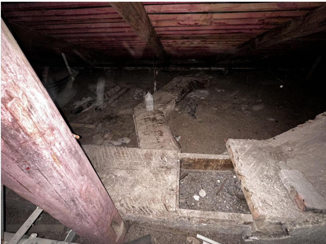
Фото 67. «Контора заводская», входящий в состав объекта культурного наследия федерального значения «Заводы ижорские адмиралтейские», Санкт-Петербург, г. Колпино, бульвар Победы, д. 1, литера АВ. Южная часть помещения чердака между осями 2-9 и В-Г. Западный скат. Фото с востока. Дата съемки: 26.04.2023 г. Автор съемки: Куваева Ю.П.
