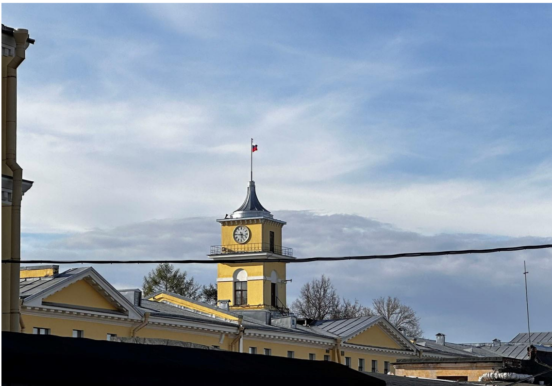
Фото 39. «Контора заводская», входящий в состав объекта культурного наследия федерального значения «Заводы ижорские адмиралтейские», Санкт-Петербург, г. Колпино, бульвар Победы, д. 1, литера АВ. Вид на дворовые скаты крыши основного корпуса и центральную башню здания с юго-востока. Дата съемки: 26.04.2023 г. Автор съемки: Куваева Ю.П.
