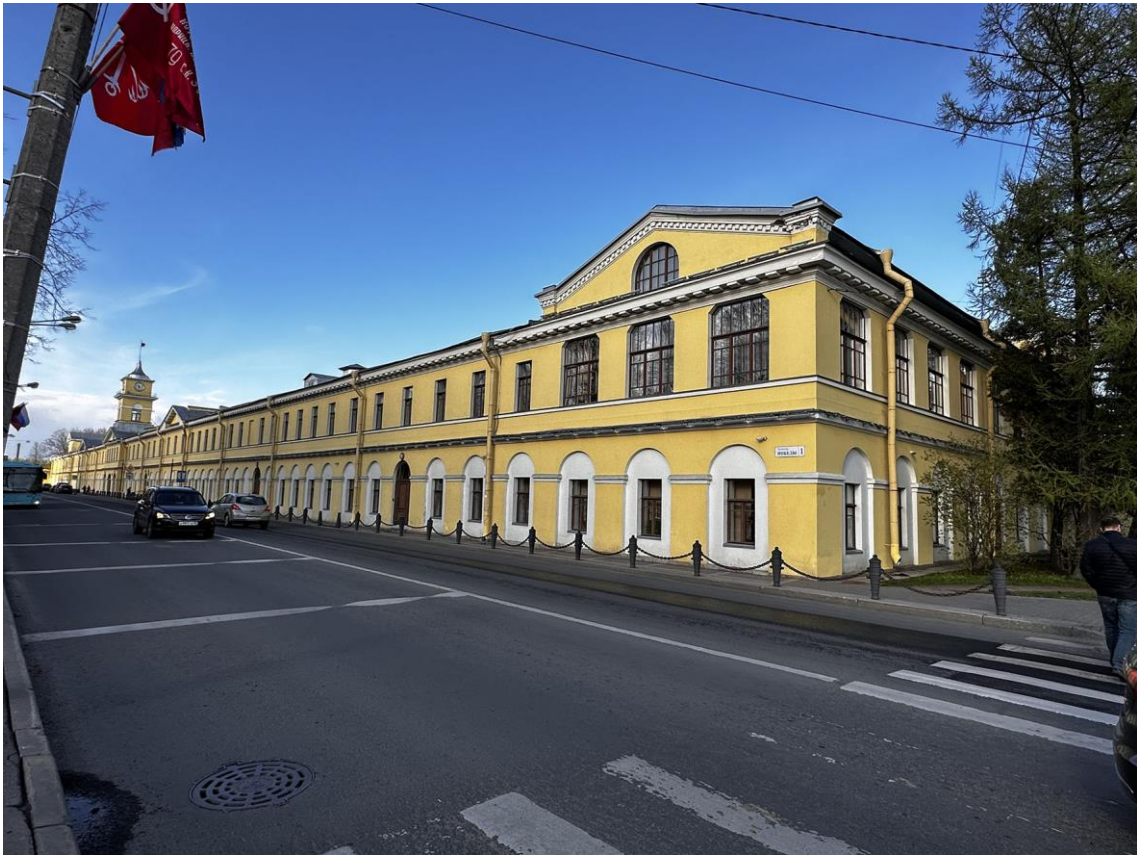
Фото 1. «Контора заводская», входящий в состав объекта культурного наследия федерального значения «Заводы ижорские адмиралтейские», Санкт-Петербург, г. Колпино, бульвар Победы, д. 1, литера АВ. Общий вид здания с юго-запада. Дата съемки: 26.04.2023 г. Автор съемки: Куваева Ю.П.
