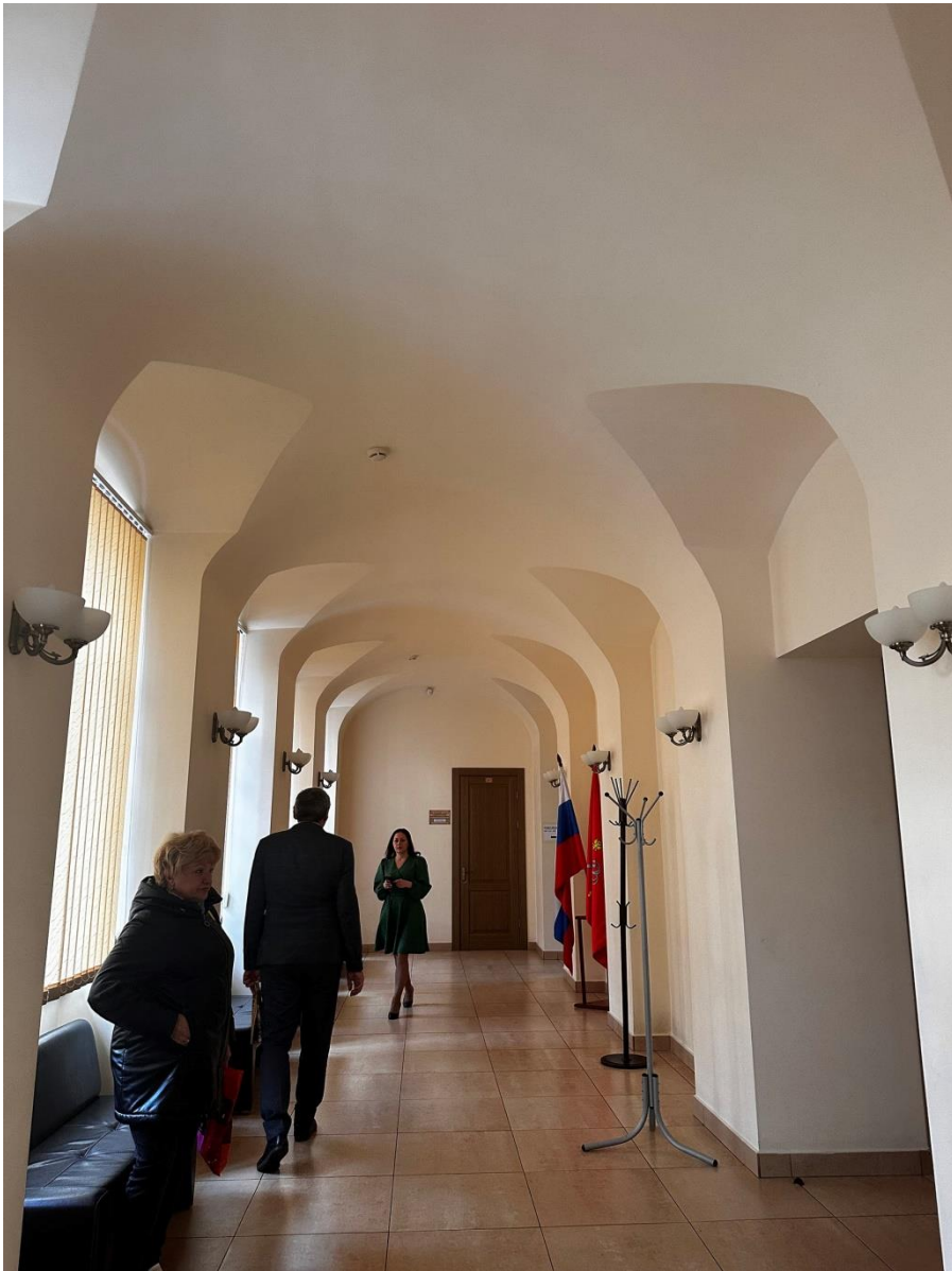
Фото 42. «Контора заводская», входящий в состав объекта культурного наследия федерального значения «Заводы ижорские адмиралтейские», Санкт-Петербург, г. Колпино, бульвар Победы, д. 1, литера АВ. 2-ой этаж. Коридор со сводчатым перекрытием с распалубками между осями 10-14.
