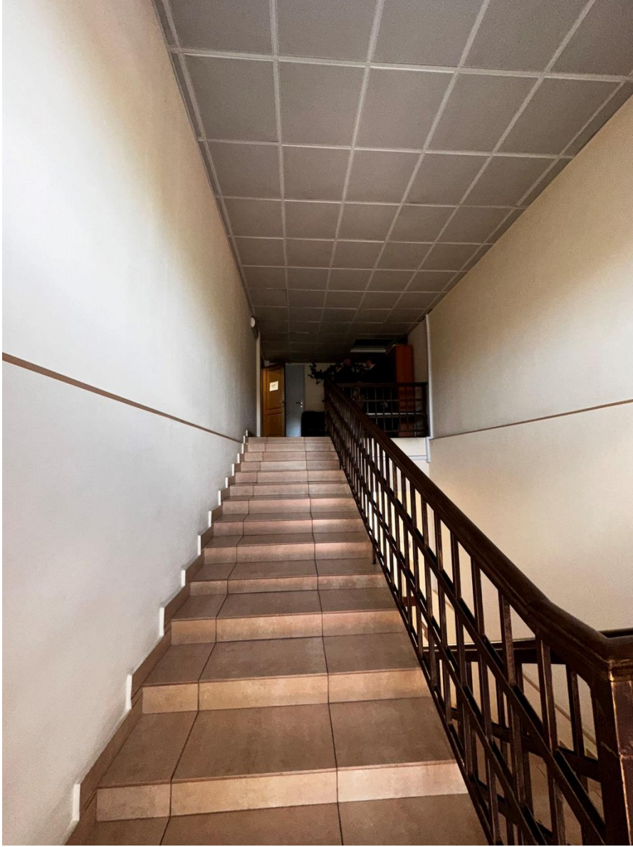
Фото 40. «Контора заводская», входящий в состав объекта культурного наследия федерального значения «Заводы ижорские адмиралтейские», Санкт-Петербург, г. Колпино, бульвар Победы, д. 1, литера АВ. 2-ой этаж. Лестничная клетка между осями 1-2 и А-Б. Дата съемки: 26.04.2023 г. Автор съемки: Куваева Ю.П.
