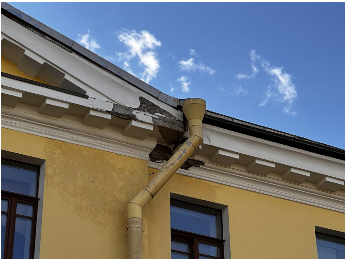
Фото 27. «Контора заводская», входящий в состав объекта культурного наследия федерального значения «Заводы ижорские адмиралтейские», Санкт-Петербург, г. Колпино, бульвар Победы, д. 1, литера АВ. Фрагмент дворового восточного фасада здания. Дата съемки: 26.04.2023 г. Автор съемки: Куваева Ю.П.
