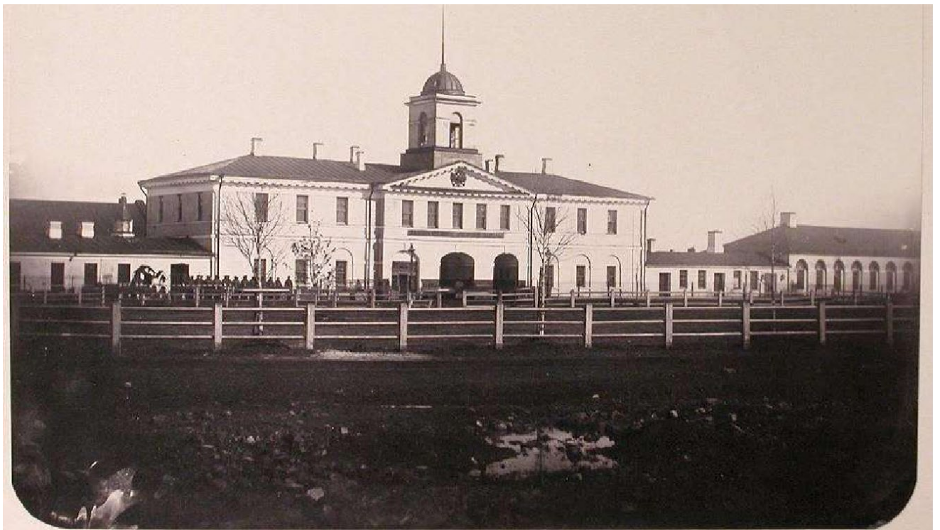
17 Архивная фотофиксация. Здание до реконструкции. Фото 1866г. (источник - https://telegra.ph/Izhorskij-Zavod-Kolpino-Foto-03-24 )
