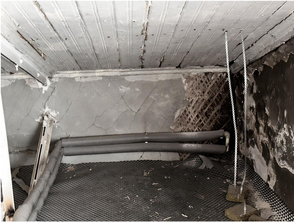
Фото 58. «Контора заводская», входящий в состав объекта культурного наследия федерального значения «Заводы ижорские адмиралтейские», Санкт-Петербург, г. Колпино, бульвар Победы, д. 1, литера АВ. Юго-западный угол помещения чердака между осями 1-2 и Б-Г. Наружная (южная) стена по оси 1. Фото с севера. Дата съемки: 26.04.2023 г. Автор съемки: Куваева Ю.П.
