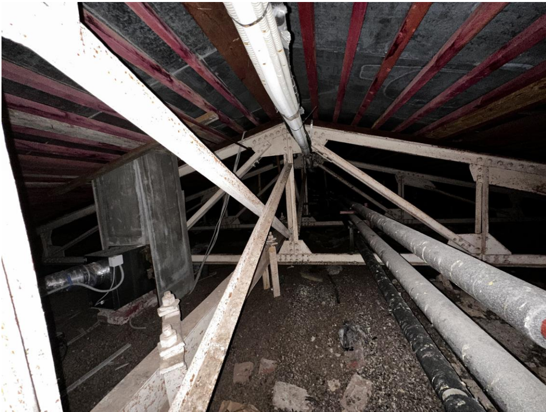
Фото 90. «Контора заводская», входящий в состав объекта культурного наследия федерального значения «Заводы ижорские адмиралтейские», Санкт-Петербург, г. Колпино, бульвар Победы, д. 1, литера АВ. Средняя часть помещения чердака между осями 18-20 и В-Г. Общий вид с севера. Дата съемки: 26.04.2023 г. Автор съемки: Куваева Ю.П.
