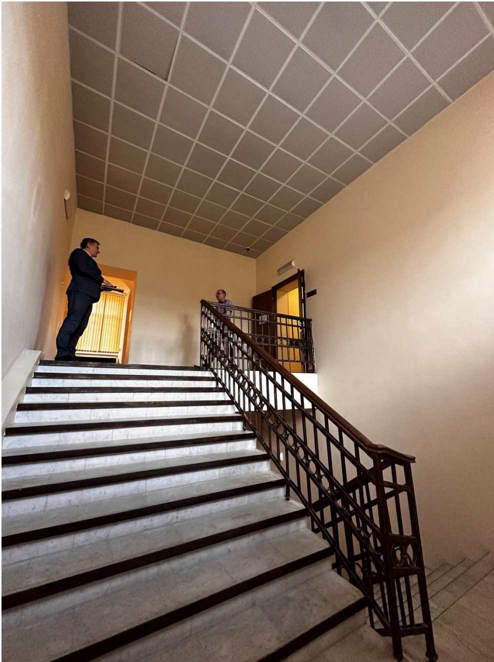
Фото 43. «Контора заводская», входящий в состав объекта культурного наследия федерального значения «Заводы ижорские адмиралтейские», Санкт-Петербург, г. Колпино, бульвар Победы, д. 1, литера АВ. 2-ой этаж. Лестничная клетка между осями 9-20. Дата съемки: 26.04.2023 г. Автор съемки: Куваева Ю.П.
