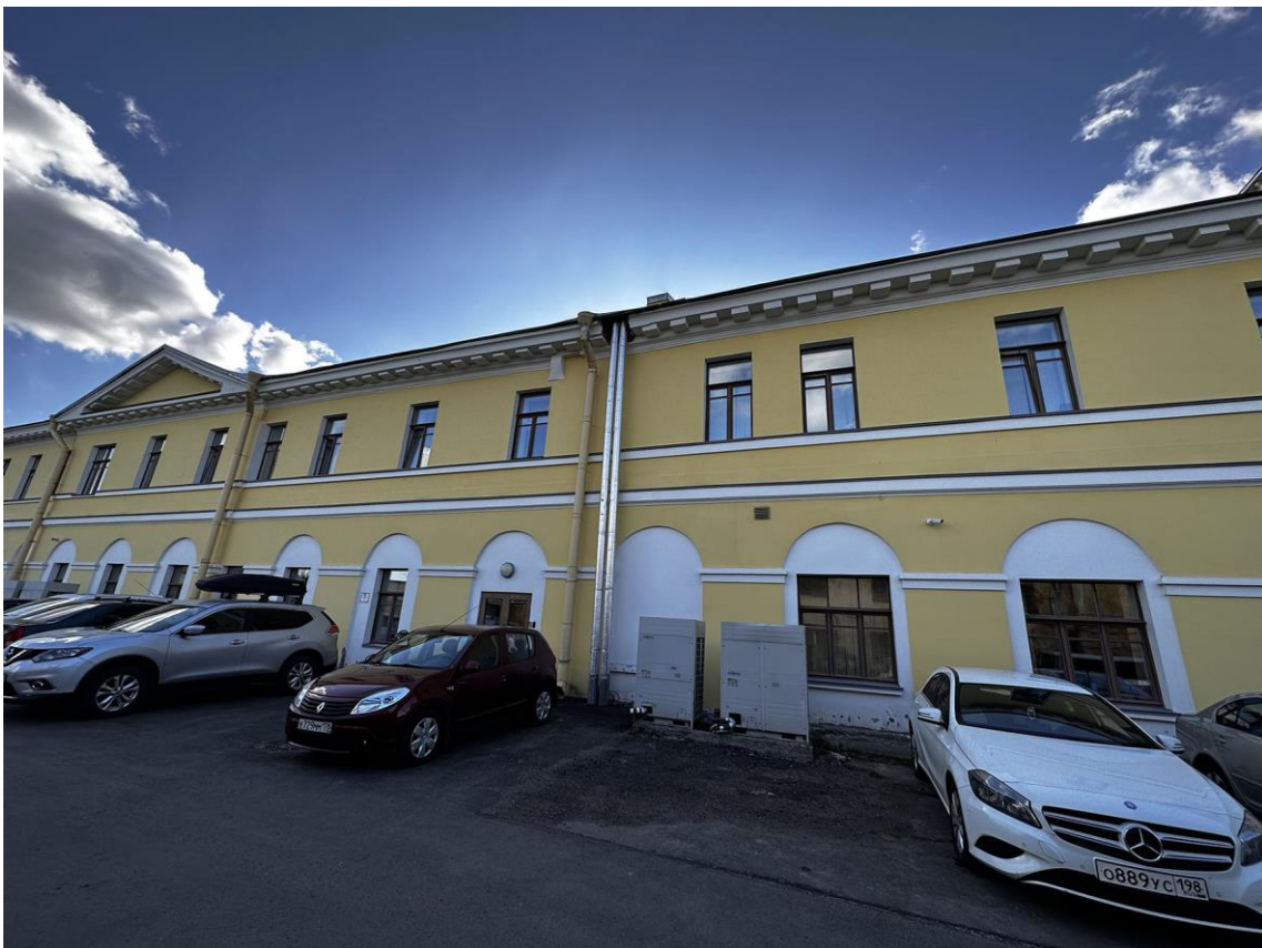
Фото 30. «Контора заводская», входящий в состав объекта культурного наследия федерального значения «Заводы ижорские адмиралтейские», Санкт-Петербург, г. Колпино, бульвар Победы, д. 1, литера АВ. Фрагмент дворового восточного фасада здания. Дата съемки: 26.04.2023 г. Автор съемки: Куваева Ю.П.
