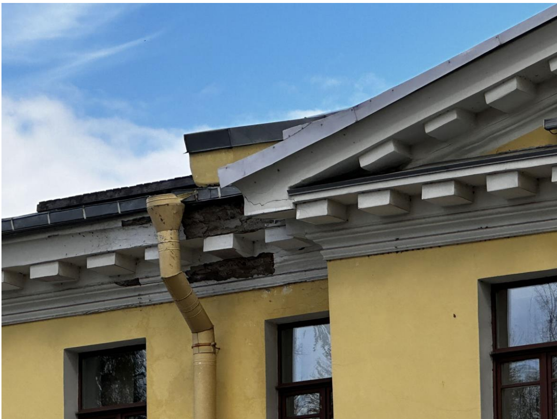
Фото 19. «Контора заводская», входящий в состав объекта культурного наследия федерального значения «Заводы ижорские адмиралтейские», Санкт-Петербург, г. Колпино, бульвар Победы, д. 1, литера АВ. Фрагмент центрального фронтона лицевого западного фасада здания. Дата съемки: 26.04.2023 г. Автор съемки: Куваева Ю.П.
