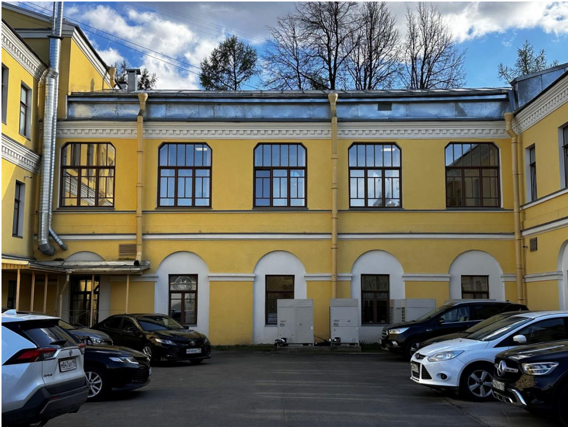
Фото 8. «Контора заводская», входящий в состав объекта культурного наследия федерального значения «Заводы ижорские адмиралтейские», Санкт-Петербург, г. Колпино, бульвар Победы, д. 1, литера АВ. Общий вид дворового северного фасада восточного крыла здания с севера. Дата съемки: 26.04.2023 г. Автор съемки: Куваева Ю.П.
