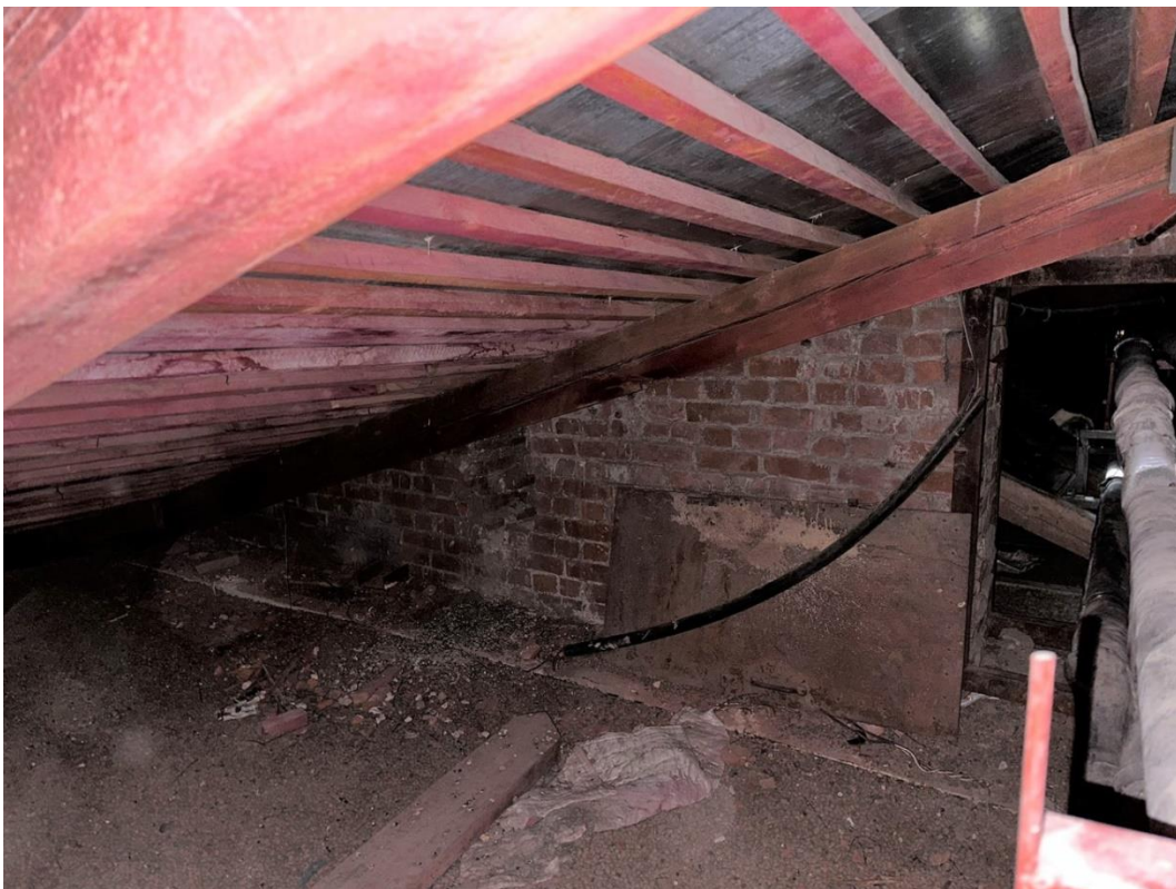
Фото 86. «Контора заводская», входящий в состав объекта культурного наследия федерального значения «Заводы ижорские адмиралтейские», Санкт-Петербург, г. Колпино, бульвар Победы, д. 1, литера АВ. Южная часть помещения чердака между осями 14-18. Восточный скат. Поперечная стена по оси 14. Фото с северо-запада. Дата съемки: 26.04.2023 г. Автор съемки: Куваева Ю.П.
