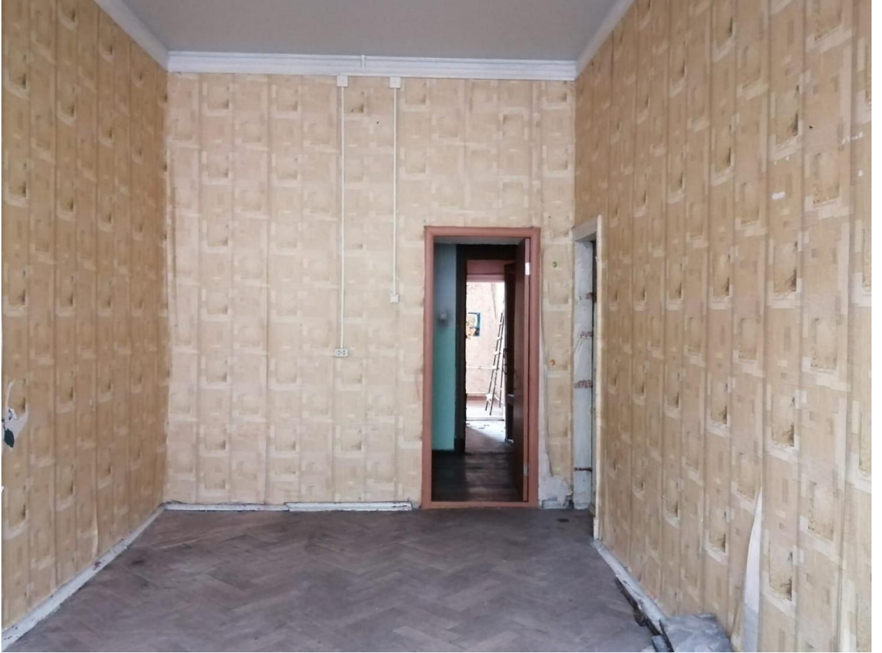
Фото 21. Объект культурного наследия регионального значения «Здание второй гимназии императора Александра I с жилым домом», Санкт-Петербург, Казанская улица, дом 27, литера А. Квартира 3, помещение 13.
