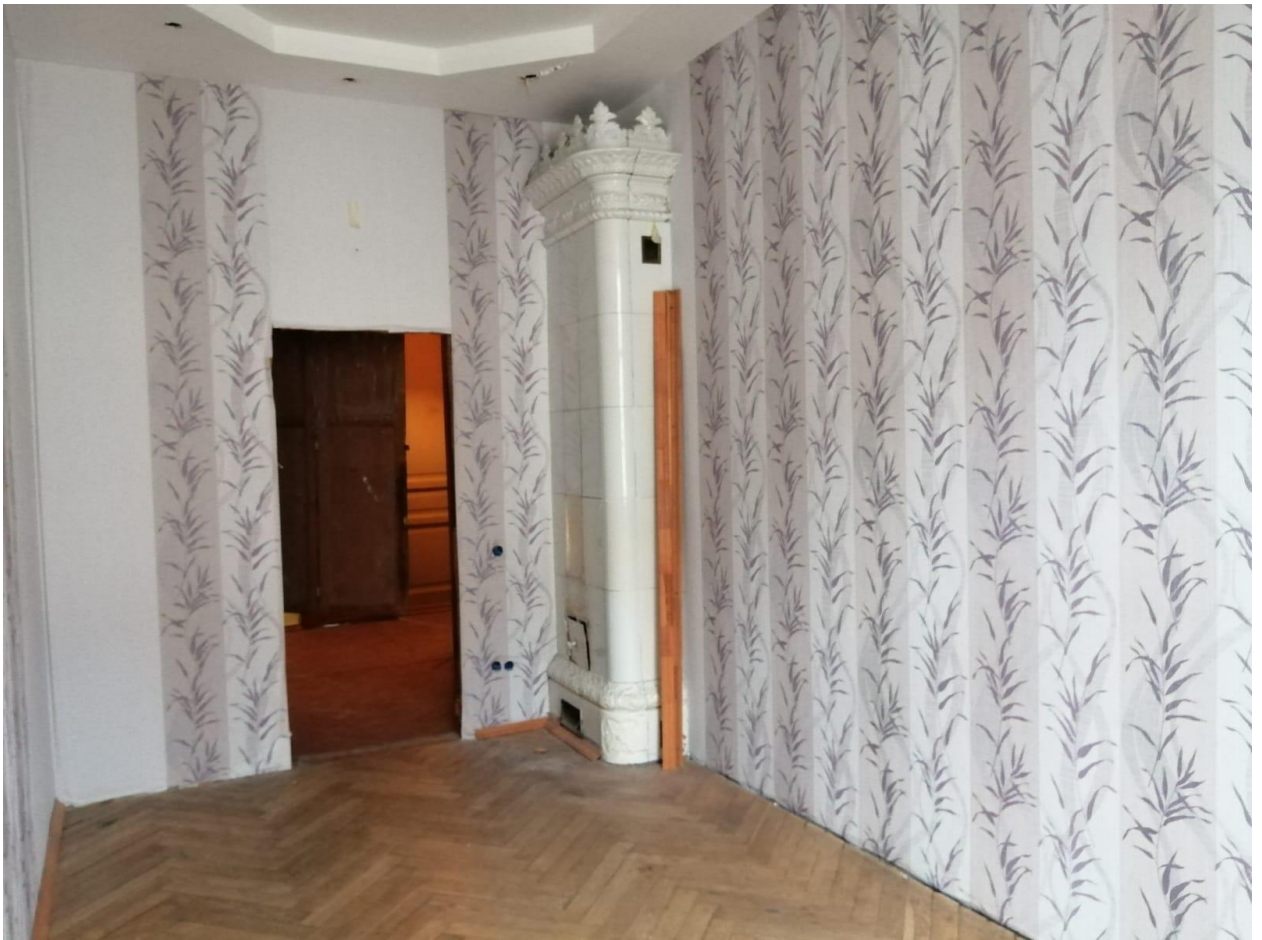
Фото 17. Объект культурного наследия регионального значения «Здание второй гимназии императора Александра I с жилым домом», Санкт-Петербург, Казанская улица, дом 27, литера А. Квартира 3, помещение 11. Печь (междустенная, одноярусная, на два помещения): облицовка – глазурованный белый изразец; плинт и навершие – рельефный изразец; плинт с растительным орнаментом, волнитообразными завитками, пальметтами; навершие – в виде фризов из плетенки, розовых гирлянд, профилированного карниза с пальметтами и волнитообразными завитками; аттик – в виде фриза из волнитообразных завитков с пальметтами; дверца топки – латунная.
