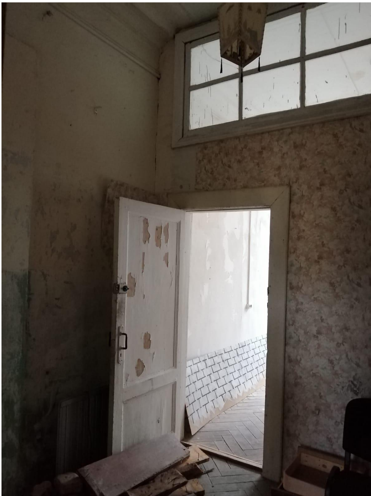
Фото 22. Объект культурного наследия регионального значения «Здание второй гимназии императора Александра I с жилым домом», Санкт-Петербург, Казанская улица, дом 27, литера А. Квартира 3, помещение 14.
