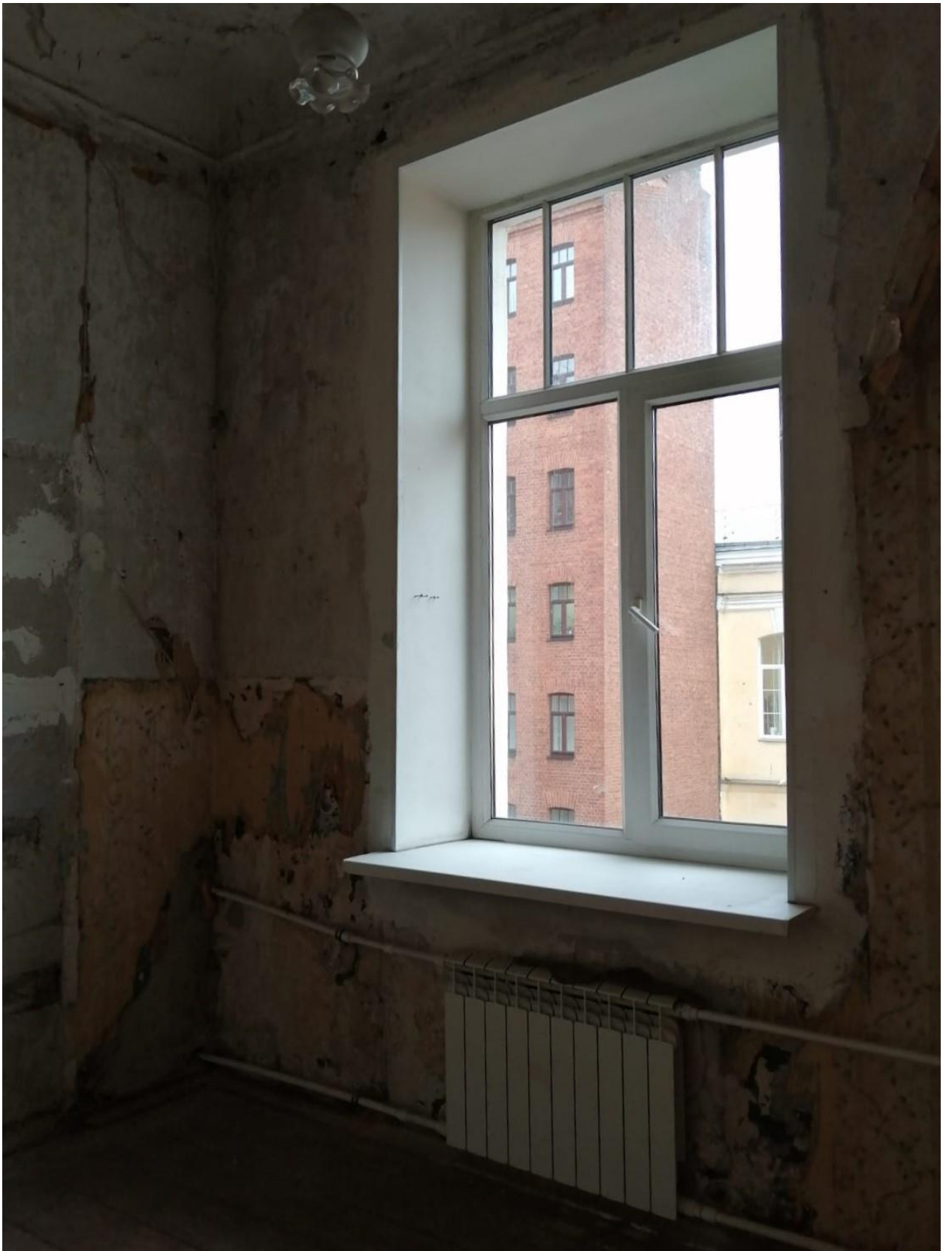
Фото 9. Объект культурного наследия регионального значения «Здание второй гимназии императора Александра I с жилым домом», Санкт-Петербург, Казанская улица, дом 27, литера А. Квартира 3, помещение 5. Заполнение оконного проема.
