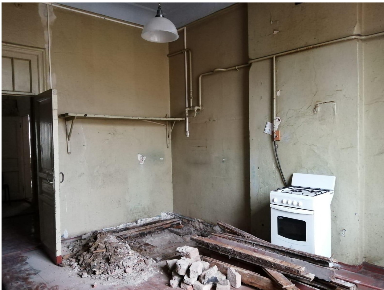
Фото 7. Объект культурного наследия регионального значения «Здание второй гимназии императора Александра I с жилым домом», Санкт-Петербург, Казанская улица, дом 27, литера А. Квартира 3, помещение 2.
