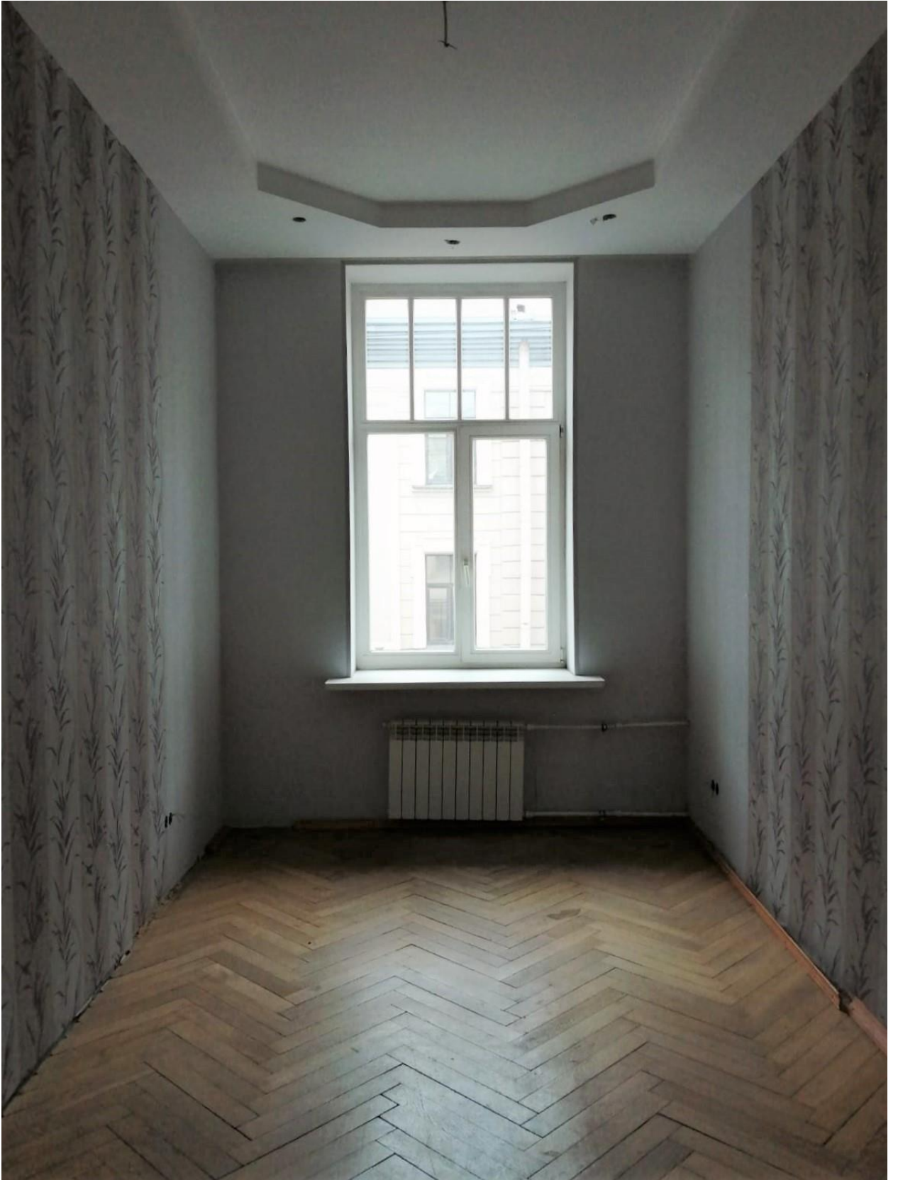
Фото 16. Объект культурного наследия регионального значения «Здание второй гимназии императора Александра I с жилым домом», Санкт-Петербург, Казанская улица, дом 27, литера А. Квартира 3, помещение 11. Заполнение оконного проема.
