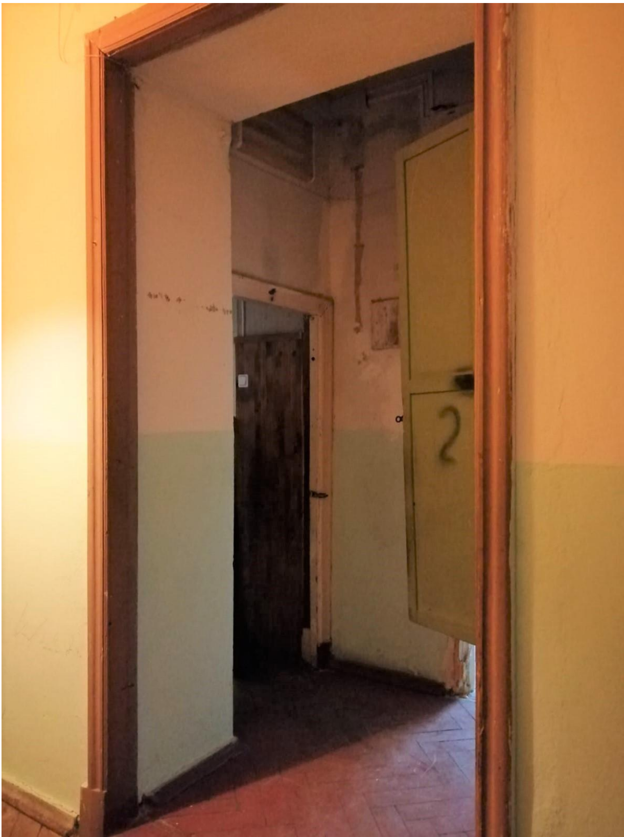
Фото 13. Объект культурного наследия регионального значения «Здание второй гимназии императора Александра I с жилым домом», Санкт-Петербург, Казанская улица, дом 27, литера А. Квартира 3, помещение 7.
