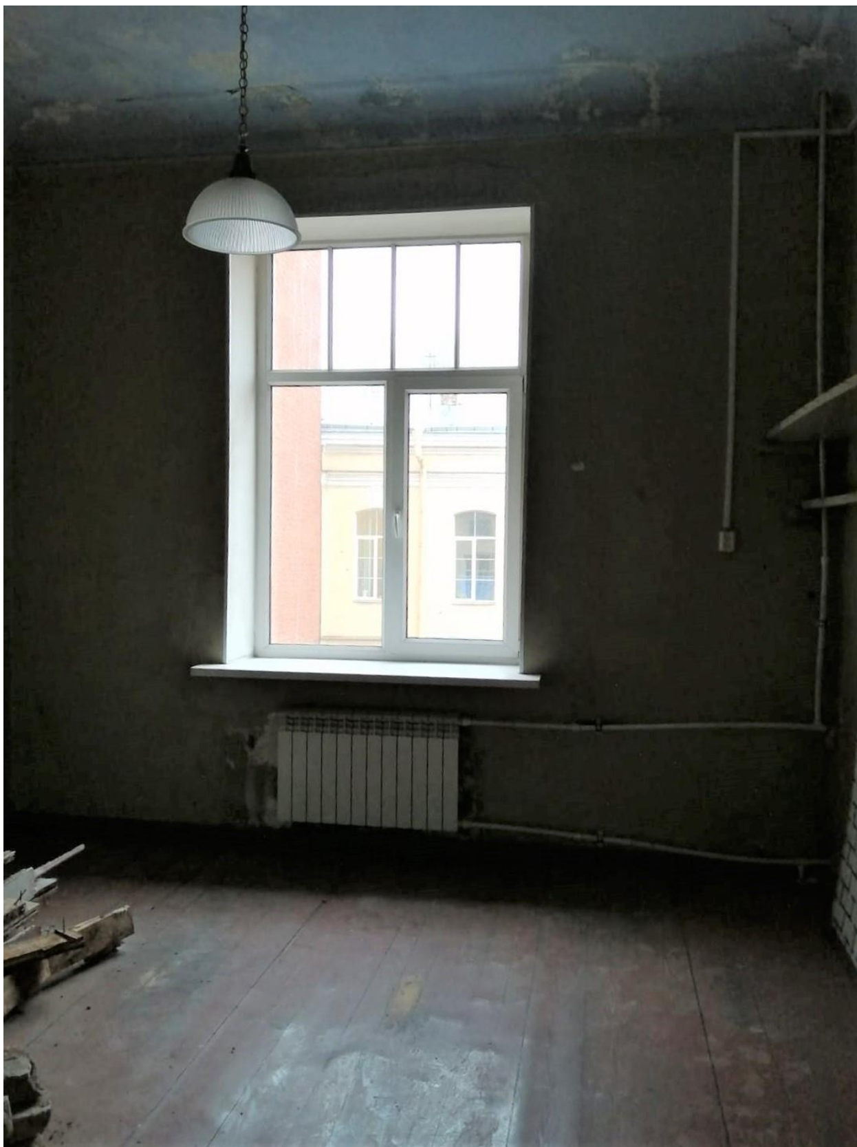
Фото 8. Объект культурного наследия регионального значения «Здание второй гимназии императора Александра I с жилым домом», Санкт-Петербург, Казанская улица, дом 27, литера А. Квартира 3, помещение 2. Заполнение оконного проема.
