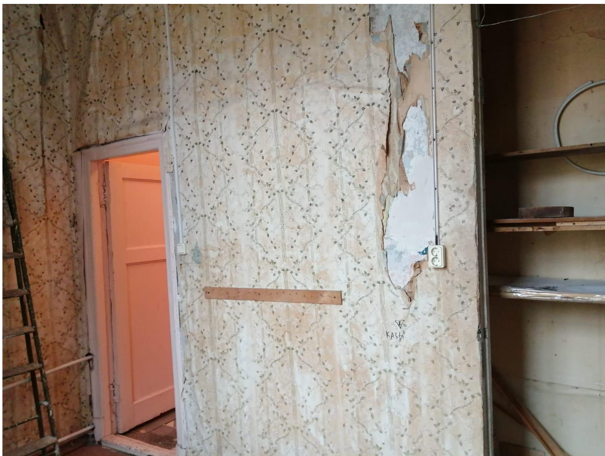
Фото 10. Объект культурного наследия регионального значения «Здание второй гимназии императора Александра I с жилым домом», Санкт-Петербург, Казанская улица, дом 27, литера А. Квартира 3, помещение 5.
