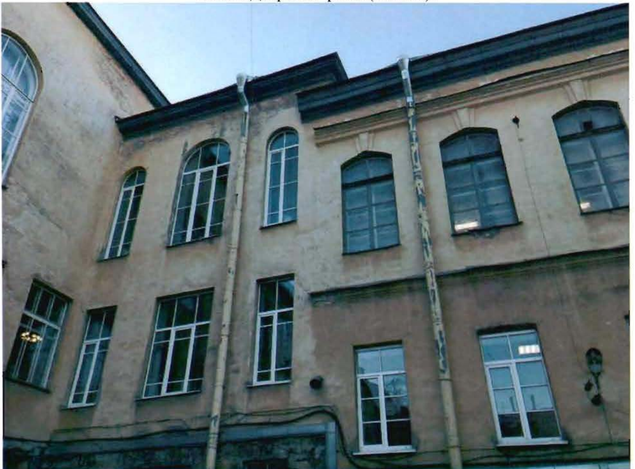
Фото 10. Часть дворового фасада (западный).
