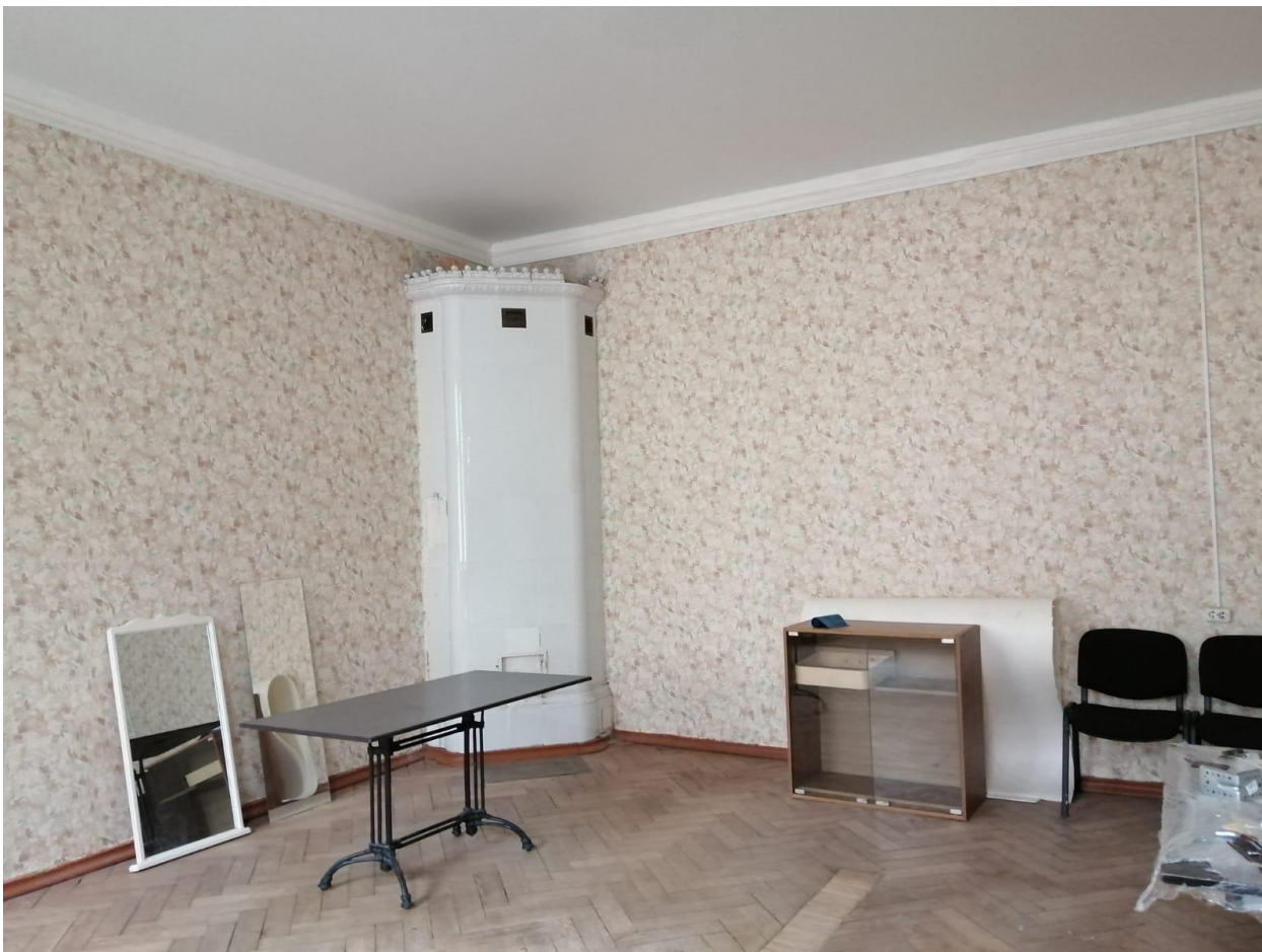
Фото 24. Объект культурного наследия регионального значения «Здание второй гимназии императора Александра I с жилым домом», Санкт-Петербург, Казанская улица, дом 27, литера А. Квартира 3, помещение 16. Печь (угловая, одноярусная): облицовка – глазурованный белый изразец; плинт и навершие – профилированные; навершие – из рельефного изразца с фризом из ионика; аттик – в виде фриза растительного орнамента (часть фриза утрачена); дверца топки – латунная.
