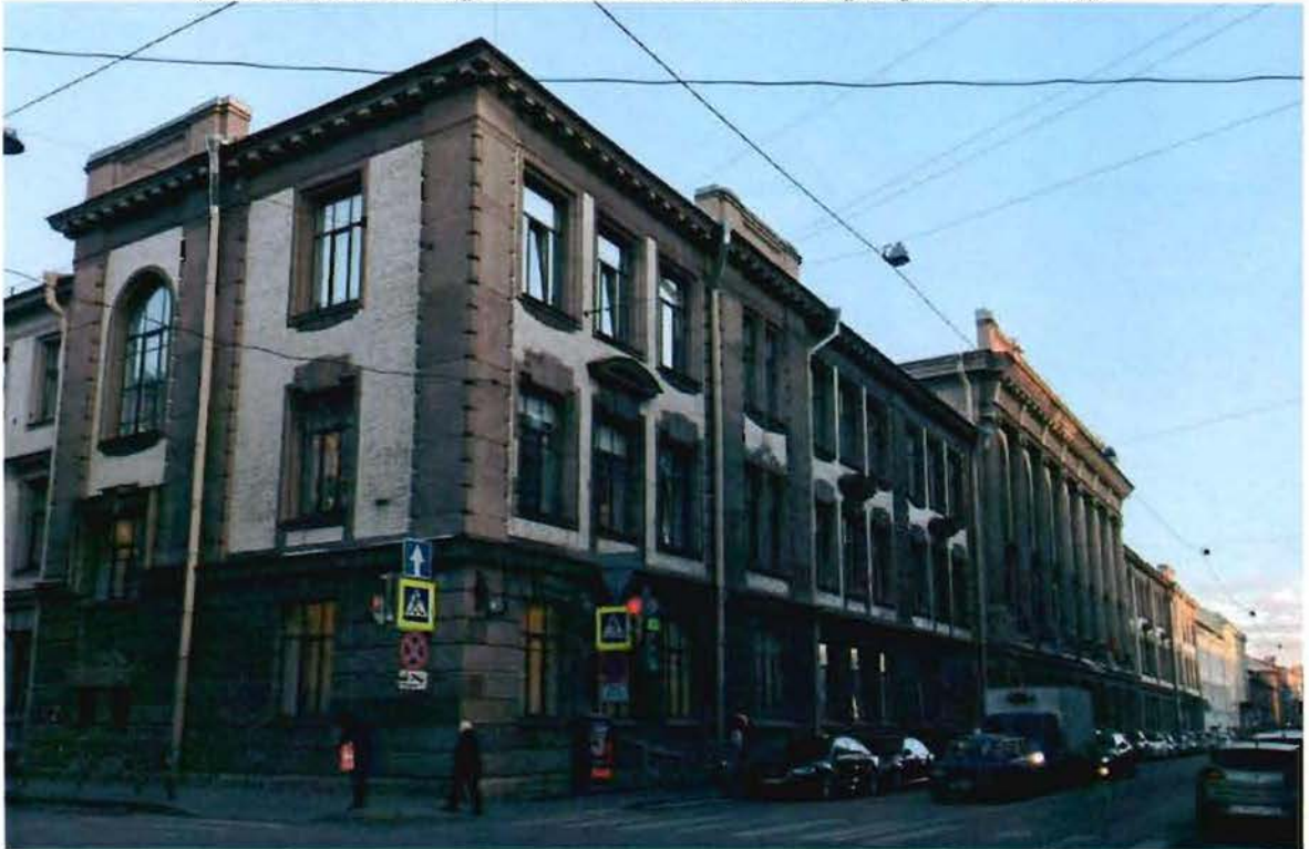
Фото 1. Южный фасад и часть западного фасада.
