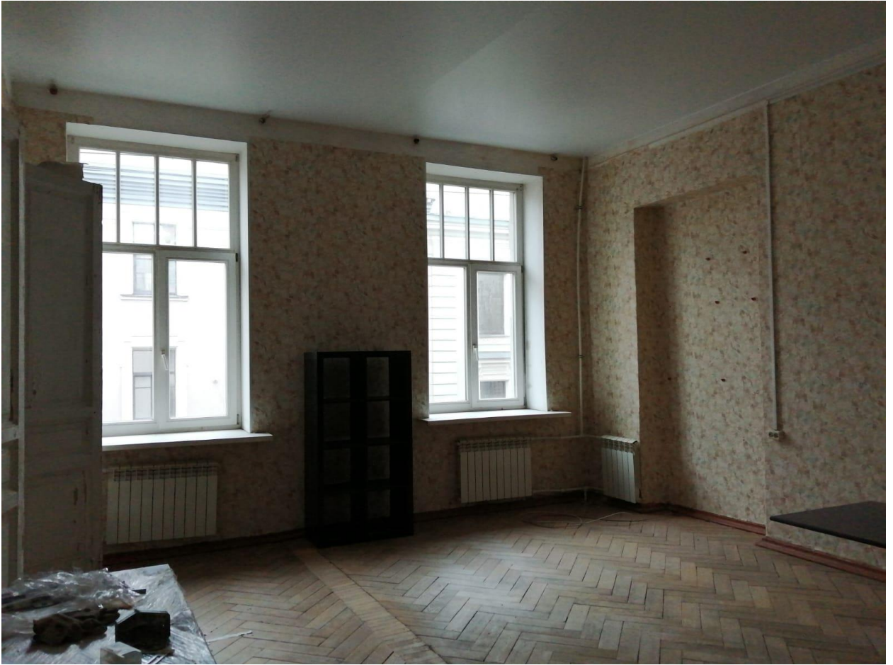
Фото 23. Объект культурного наследия регионального значения «Здание второй гимназии императора Александра I с жилым домом», Санкт-Петербург, Казанская улица, дом 27, литера А. Квартира 3, помещение 16. Заполнение оконного проема.
