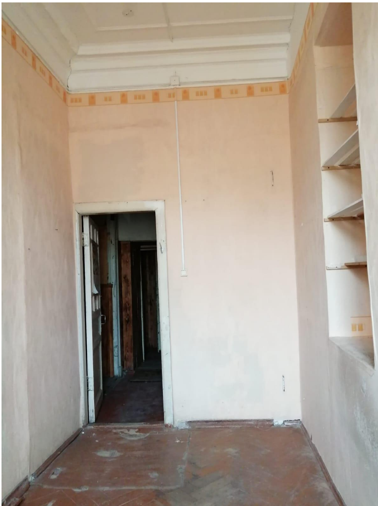
Фото 15. Объект культурного наследия регионального значения «Здание второй гимназии императора Александра I с жилым домом», Санкт-Петербург, Казанская улица, дом 27, литера А. Квартира 3, помещение 10.
