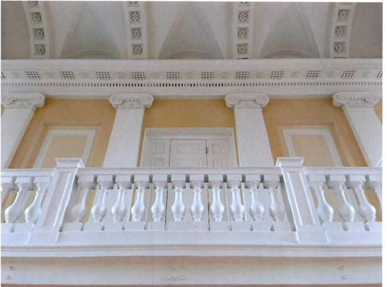
Фото 13. Интерьер. 3-й этаж.
