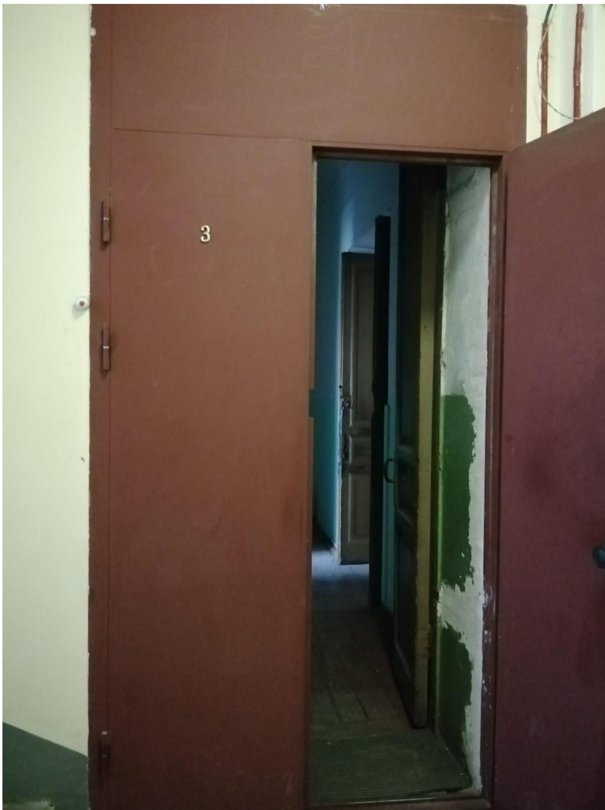
Фото 5. Объект культурного наследия регионального значения «Здание второй гимназии императора Александра I с жилым домом», Санкт-Петербург, Казанская улица, дом 27, литера А. Позднее заполнение дверного проема (в квартиру 3).
