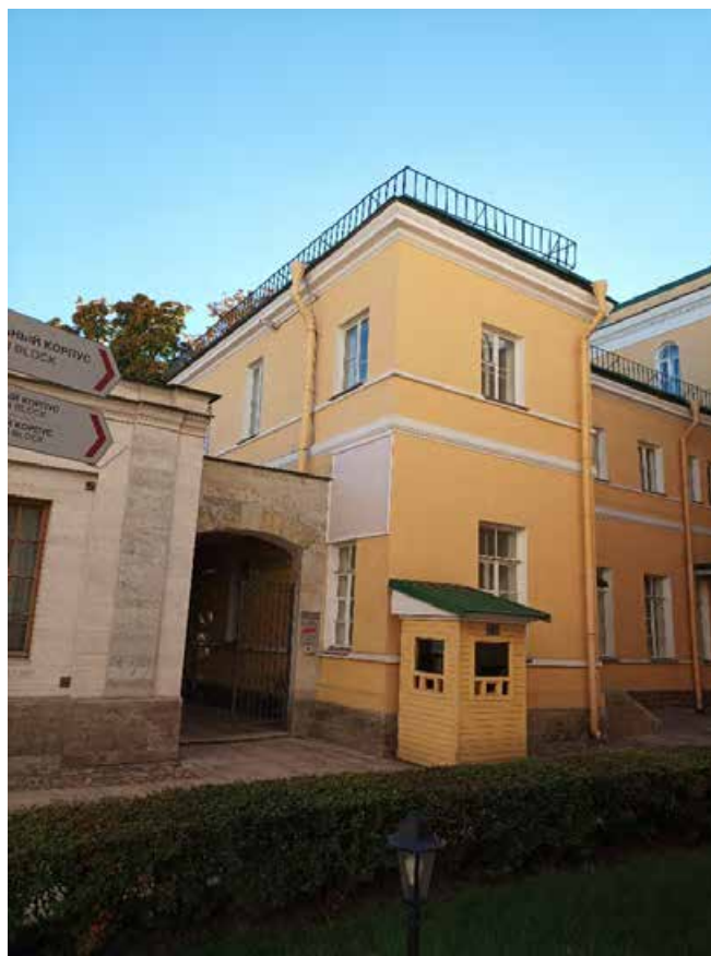
9. Объект культурного наследия федерального значения «Усадьба Державина Г.Р.», по адресу: Санкт-Петербург, наб. реки Фонтанки, д. 118. Главный дом (Центральный корпус). Фрагмент фасада. Дата съемки: 10.10.2022г.
