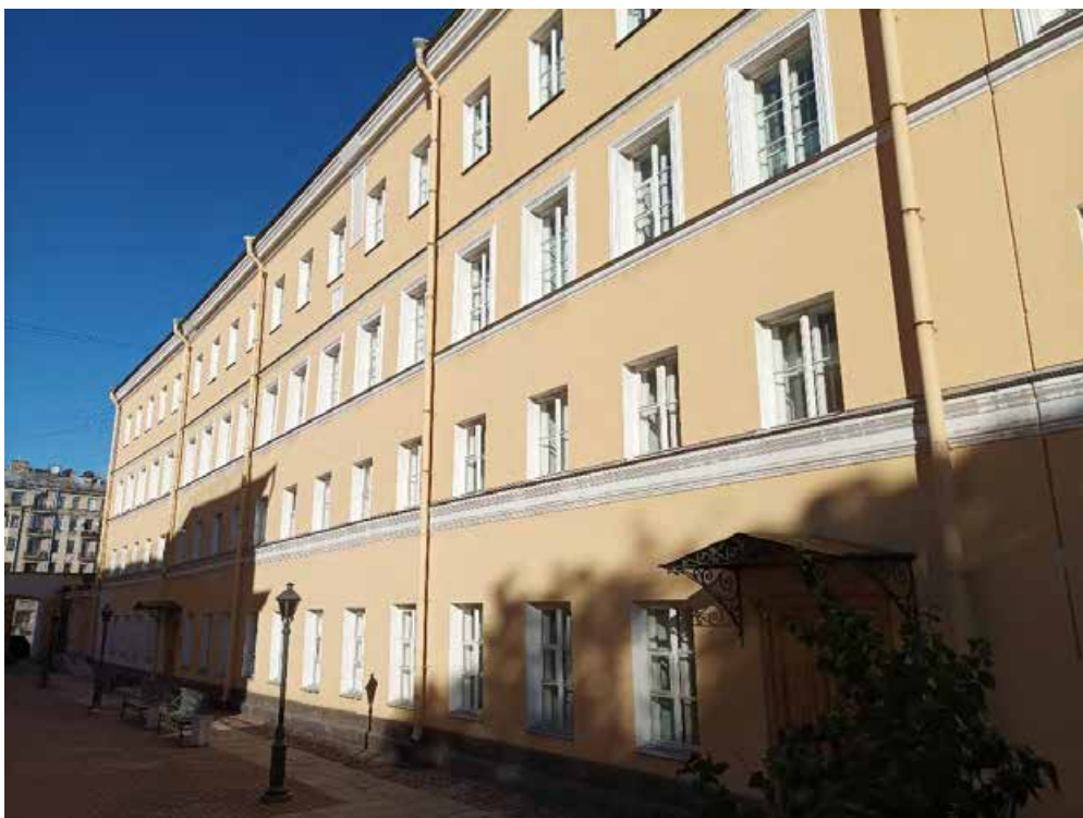
13. Объект культурного наследия федерального значения «Усадьба Державина Г.Р.», по адресу: Санкт-Петербург, наб. реки Фонтанки, д. 118. Флигель (Гостевой корпус). Фрагмент фасада. Дата съемки: 10.10.2022г.
