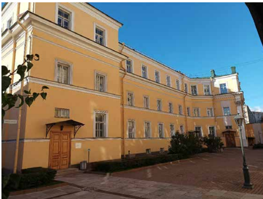
7. Объект культурного наследия федерального значения «Усадьба Державина Г.Р.», по адресу: Санкт-Петербург, наб. реки Фонтанки, д. 118. Главный дом (Восточный корпус). Фрагмент фасада. Дата съемки: 10.10.2022г.
