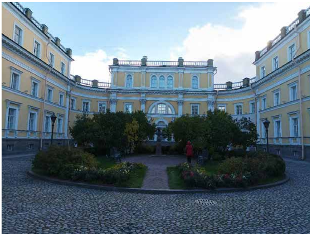
1. Объект культурного наследия федерального значения «Усадьба Державина Г.Р.», по адресу: Санкт-Петербург, наб. реки Фонтанки, д. 118. Главный дом. Общий вид. Дата съемки: 10.10.2022г.
