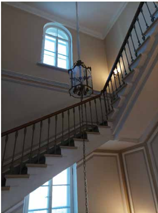
27. Объект культурного наследия федерального значения «Усадьба Державина Г.Р.», по адресу: Санкт-Петербург, наб. реки Фонтанки, д. 118. Главный дом (Центральный корпус). Лестница. Дата съемки: 10.10.2022г.
