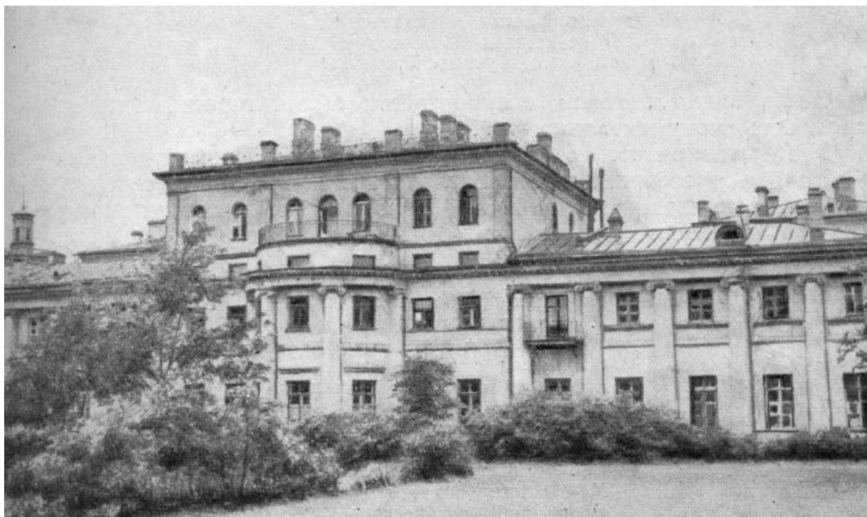
15. «Усадьба Державина Г.Р.», по адресу: Санкт-Петербург, наб. реки Фонтанки, д. 118. Фасад со стороны сада. Фото 1965 г. Источник: Литературные памятные места Ленинграда. Сборник. Изд. 2-е, доп. Л., Лениздат, 1968
