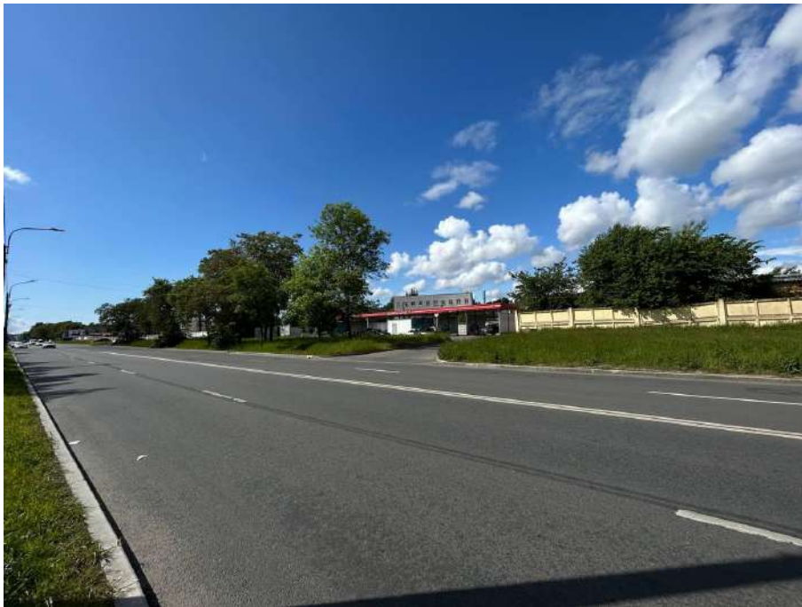
Фото №8. Вид на восточную границу территории проведения работ в направлении с востока на запад.
