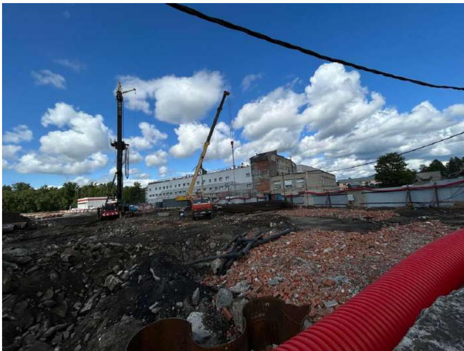
Фото №10. Вид на восточную границу территории проведения работ в направлении с запада на восток.
