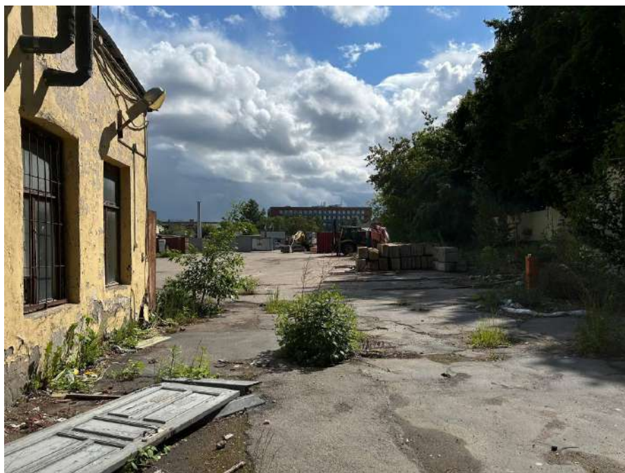
Фото №15. Территория проведения работ со стороны Партизанской улицы, вид с севера на юг.
