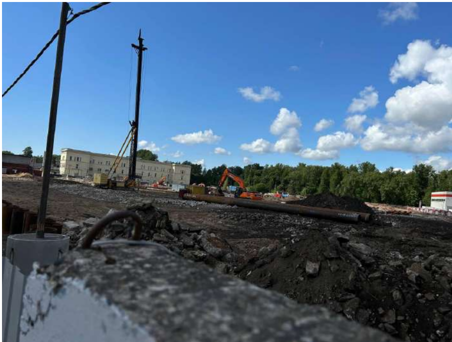
Фото №9. Вид на территорию проведения работ в направлении с востока на северо-запад.
