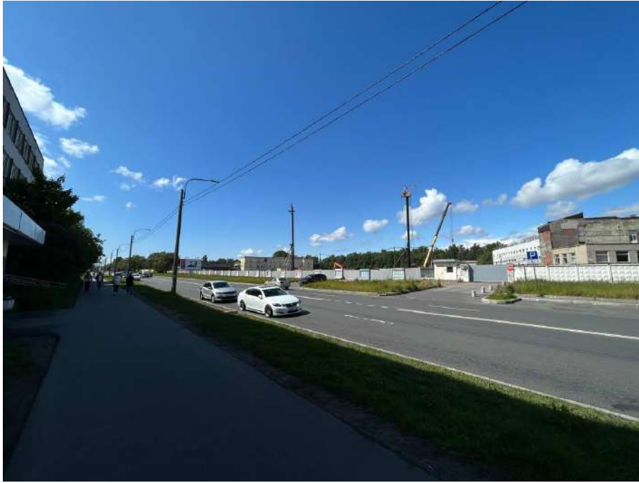
Фото №7. Общий вид на улицу Якорную и территорию проведения работ в направлении на запад.
