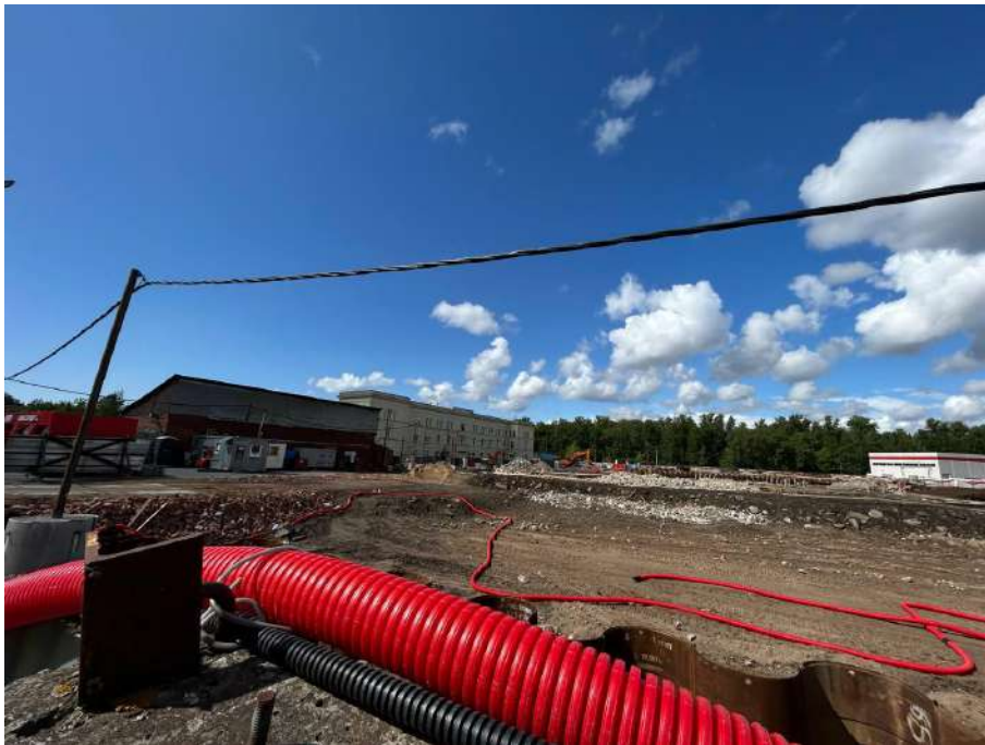
Фото №1. Территория проведения работ, вид с юга на север.
