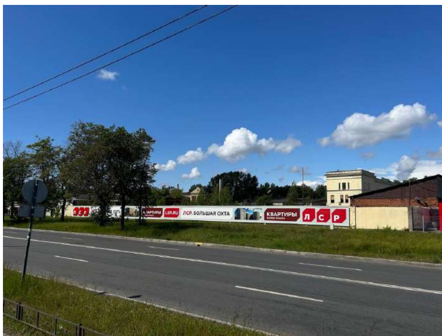
Фото №6. Общий вид на территорию проведения работ с улицы Якорной в направлении на северо-запад.
