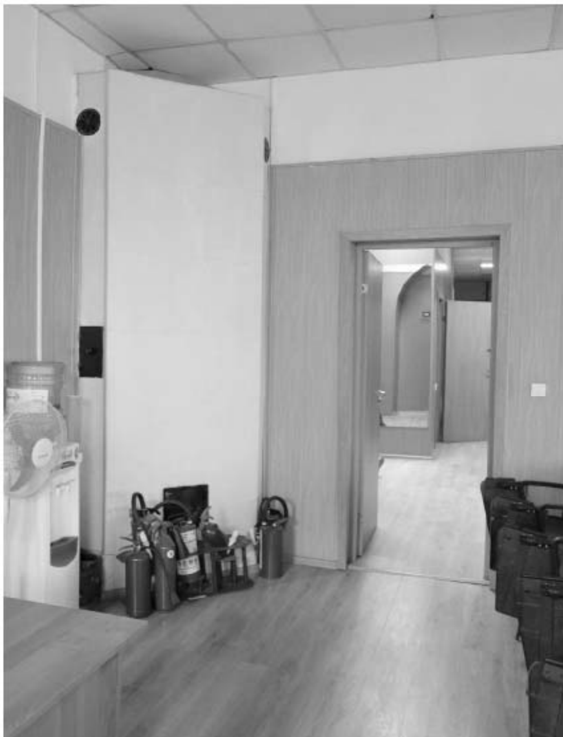
192. «Дом Н.Я. и Ф.Я. Колобовых». Санкт-Петербург, Большой пр. П.С., 16-18; Красного курсанта ул., д.1; Пионерская ул., д.6, литера А. Большой пр. П.С., 18. 4-й этаж. Фрагмент помещения 18-Н. Печь угловая. Фото: 21.03. 2023.
