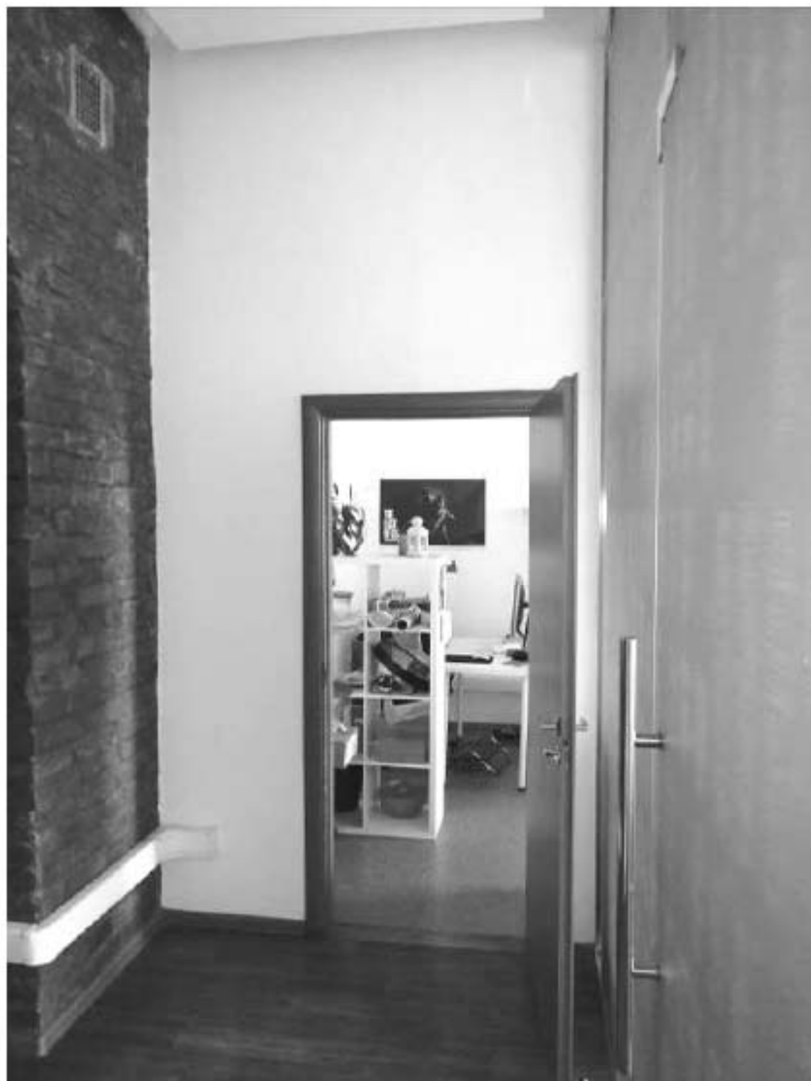
269. «Дом Н.Я. и Ф.Я. Колобовых». Санкт-Петербург, Большой пр. П.С., 16-18; Красного курсанта ул., д.1; Пионерская ул., д.6, литера А. Большой пр. П.С., 18. 5-й этаж. Фрагмент помещения 26-Н. Коридор. Фото: 21.03. 2023.
