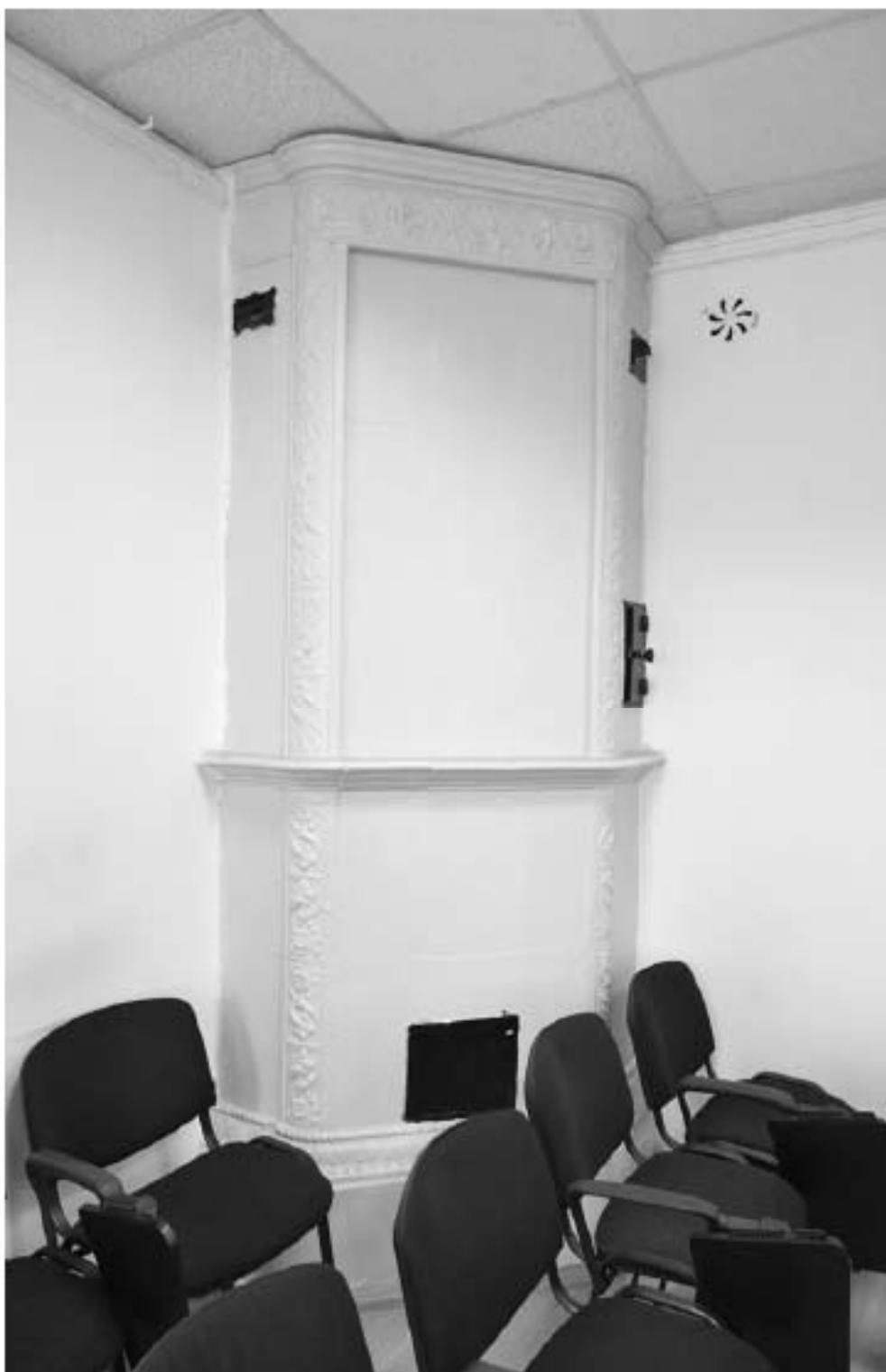
199. «Дом Н.Я. и Ф.Я. Колобовых». Санкт-Петербург, Большой пр. П.С., 16-18; Красного курсанта ул., д.1; Пионерская ул., д.6, литера А. Большой пр. П.С., 18. 4-й этаж. Фрагмент помещения 18-Н. Печь угловая двухъярусная. Фото: 21.03. 2023.
