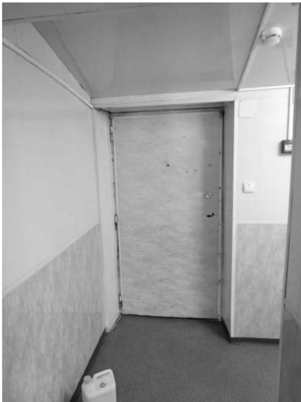
307. «Дом Н.Я. и Ф.Я. Колобовых». Санкт-Петербург, Большой пр. П.С., 16-18; Красного курсанта ул., д.1; Пионерская ул., д.6, литера А. Большой пр. П.С., 18. 6-й этаж. Вход в помещение 11-Н. Коридор. Фото: 21.03. 2023.
