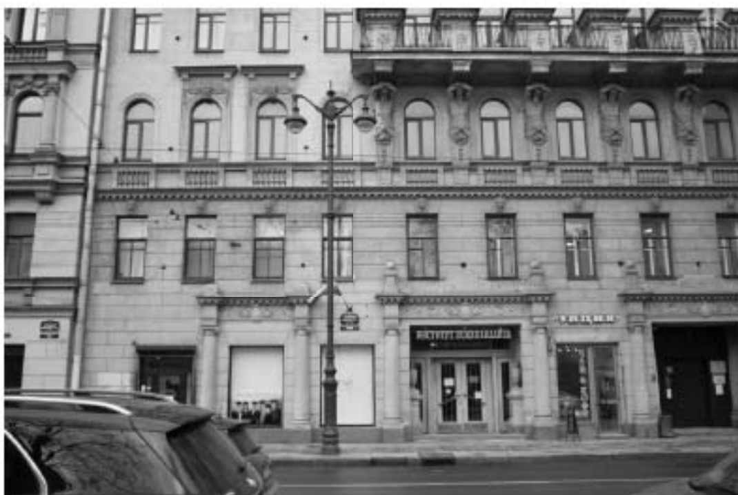
8. «Дом Н.Я. и Ф.Я. Колобовых». Санкт-Петербург, Большой пр. П.С., 16-18; Красно го курсанта ул., д.1; Пионерская ул., д.6, литера А. Лицевой фасад по Большому пр., П.С. Фрагмент. Фото: 21.03.2023.
