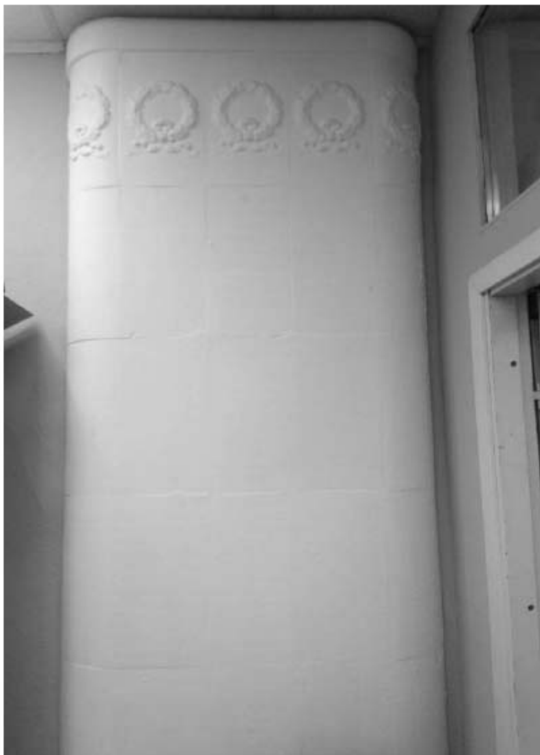
153. «Дом Н.Я. и Ф.Я. Колобовых». Санкт-Петербург, Большой пр. П.С., 16-18; Красного курсанта ул., д.1; Пионерская ул., д.6, литера А. Большой пр. П.С., 18. 4-й этаж. Фрагмент помещения 7-Н. Печь. Фото: 21.03. 2023.
