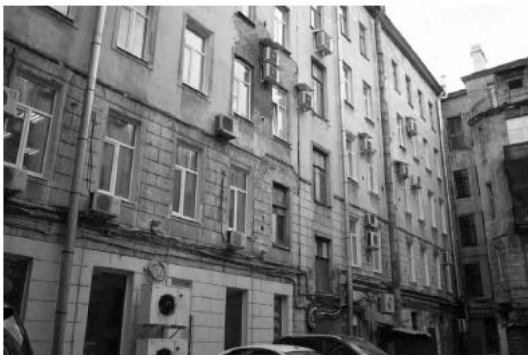
35. «Дом Н.Я. и Ф.Я. Колобовых». Санкт-Петербург, Большой пр. П.С., 16-18; Красного курсанта ул., д.1; Пионерская ул., д.6, литера А. Фасад лицевого корпуса по Большому пр. П.С. со стороны двора. Фрагмент. Фото: 21.03. 2023.
