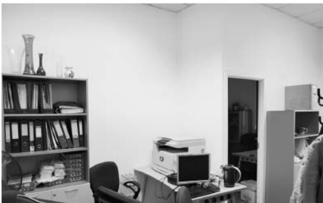
47. «Дом Н.Я. и Ф.Я. Колбозыло». Санкт-Петербург, Большой пр. П.С., 16-18; Красного курсанта ул., д.1; Пионерская ул., д.6, литера А. Большой пр. П.С., 18. 2-й этаж. Фрагмент помещения 6-Н. Фото: 21.03. 2023.
