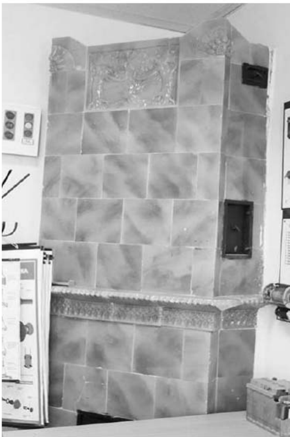
194. «Дом Н.Я. и Ф.Я. Колобовых». Санкт-Петербург, Большой пр. П.С., 16-18; Красного курсанта ул., д.1; Пионерская ул., д.6, литера А. Большой пр. П.С., 18. 4-й этаж. Фрагмент помещения 18-Н. Печь угловая двухъярусная. Фото: 21.03. 2023.
