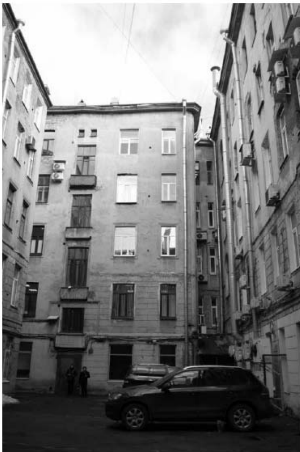
37. «Дом Н.Я. и Ф.Я. Колобовых». Санкт-Петербург, Большой пр. П.С., 16-18; Красного курсанта ул., д.1; Пионерская ул., д.6, литера А. Фрагмент фасадов дворовых корпусов. Фото: 21.03. 2023.
