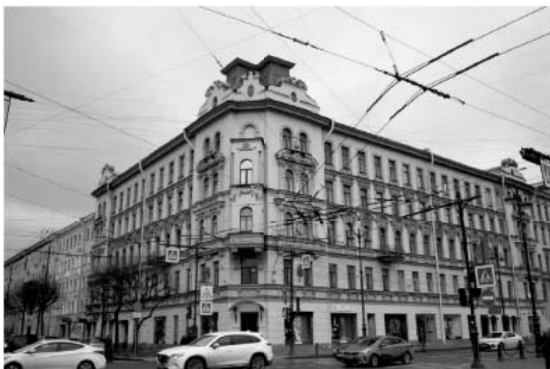
1. «Дом Н.Я. и Ф.Я. Колобовых». Санкт-Петербург, Большой пр. П.С., 16-18; Красного курсанта ул., д.1; Пионерская ул., д.6, литера А. Вид на лицевые фасады по Большому пр., П.С. и ул. Красного курсанта. Фото: 21.03.2023.
