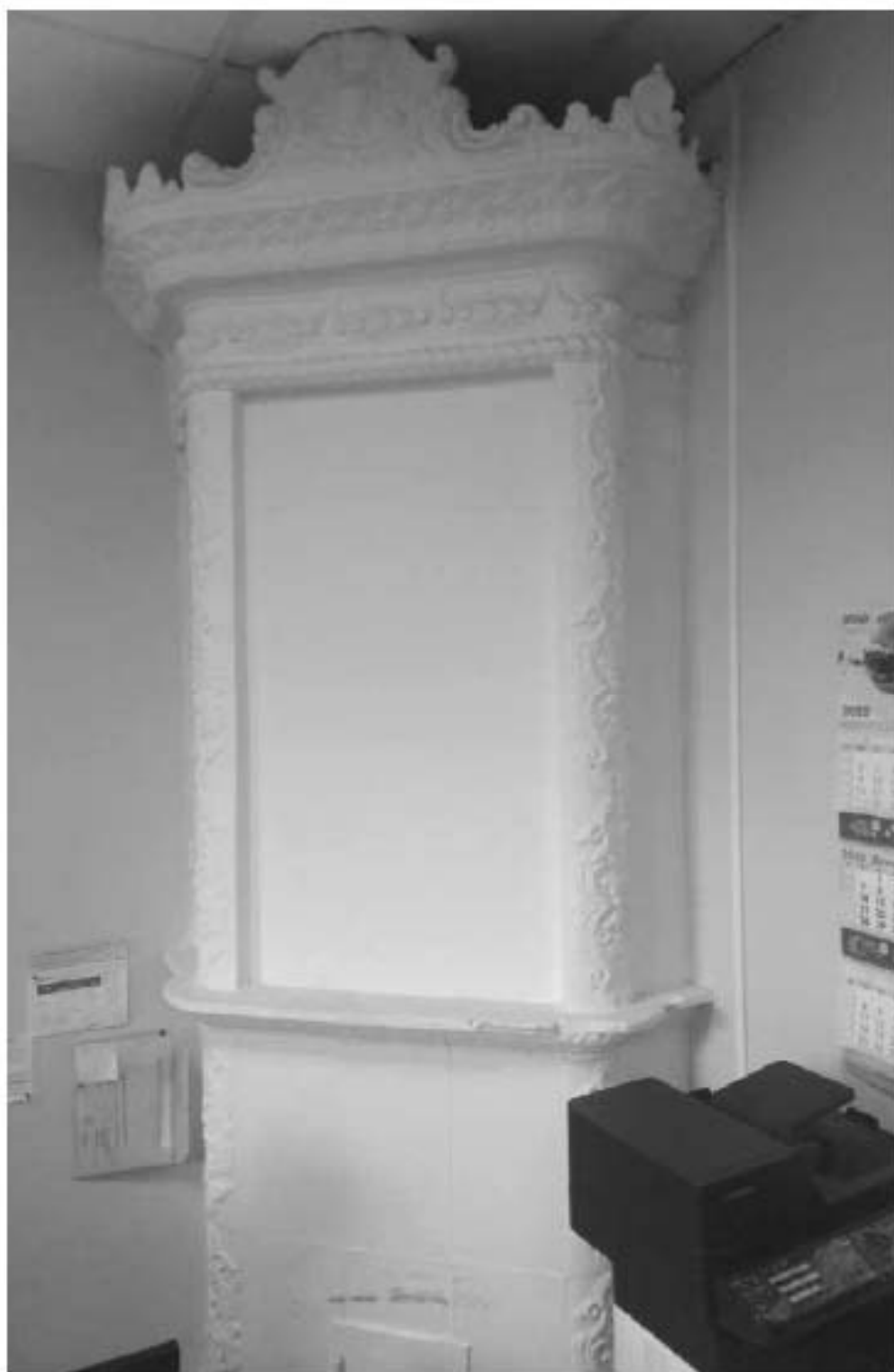
139. «Дом Н.Я. и Ф.Я. Колобовых». Санкт-Петербург, Большой пр. П.С., 16-18; Красного курсанта ул., д.1; Пионерская ул., д.6, литера А. Большой пр. П.С., 18. 4-й этаж. Фрагмент помещения 7-Н. Печь угловая двухъярусная. Фото: 21.03. 2023.
