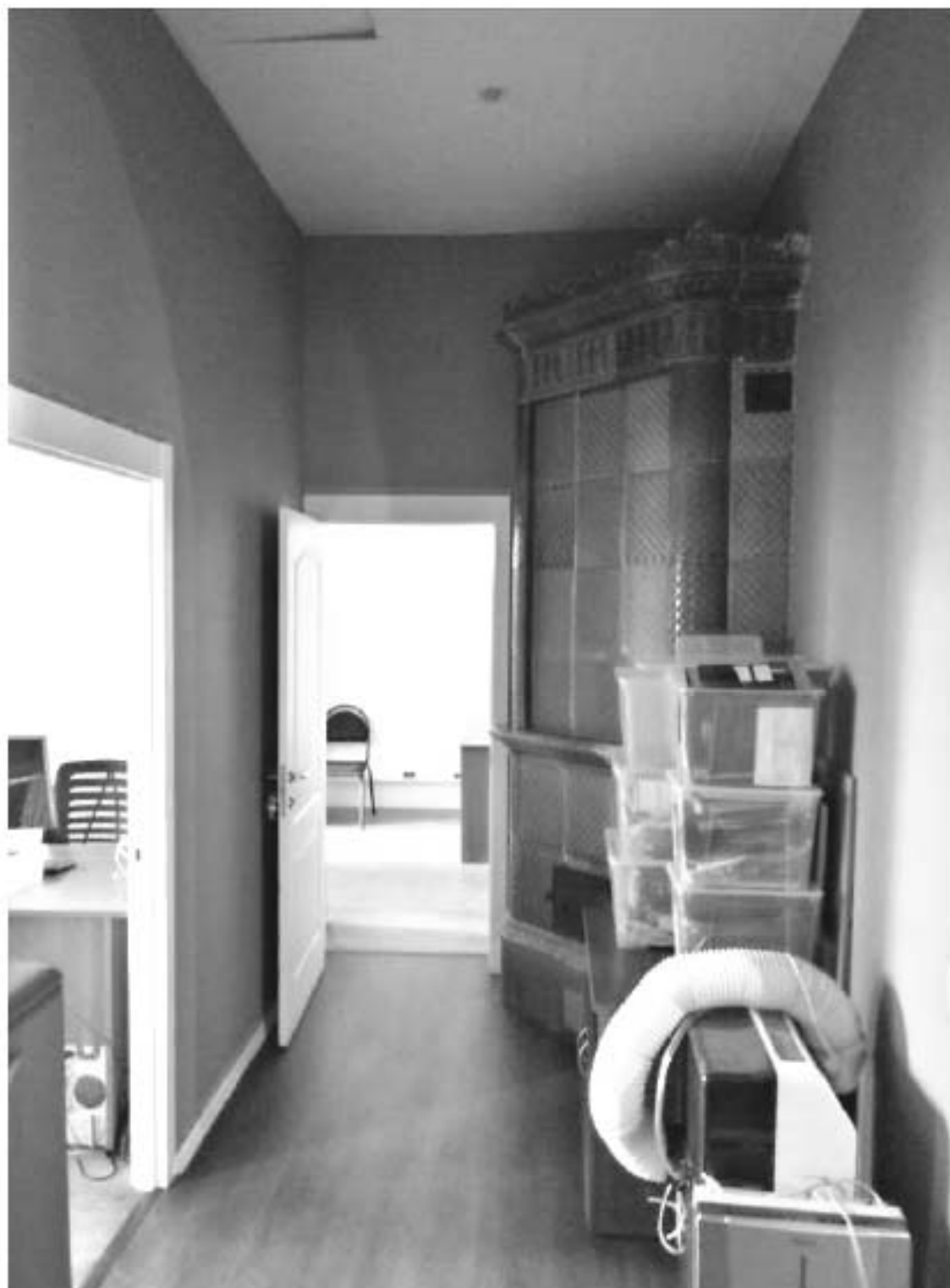
224. «Дом Н.Я. и Ф.Я. Колобовых». Санкт-Петербург, Большой пр. П.С., 16-18; Красного курсанта ул., д.1; Пионерская ул., д.6, литера А. Большой пр. П.С., 18. 5-й этаж. Фрагмент помещения 8-Н. Печь угловая двухъярусная. Фото: 21.03. 2023.
