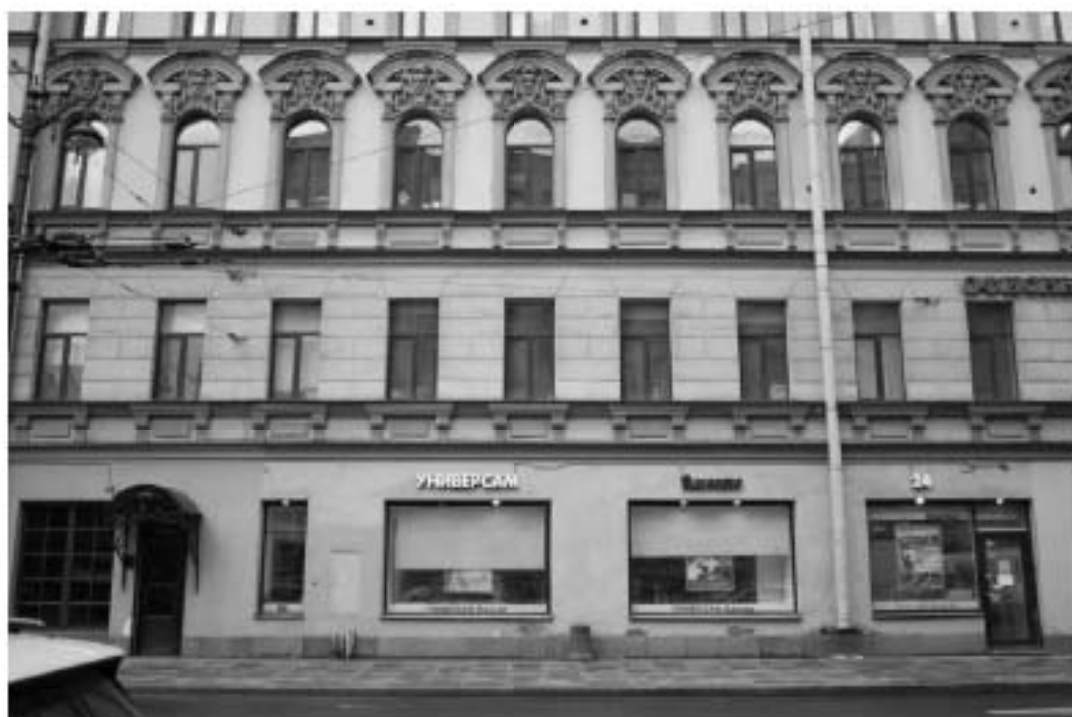
12. «Дом Н.Я. и Ф.Я. Колобовых». Санкт-Петербург, Большой пр. П.С., 16-18; Красно го курсанта ул., д.1; Пионерская ул., д.6, литера А. Лицевой фасад по Большому пр., П.С. Фрагмент. Фото: 21.03.2023.
