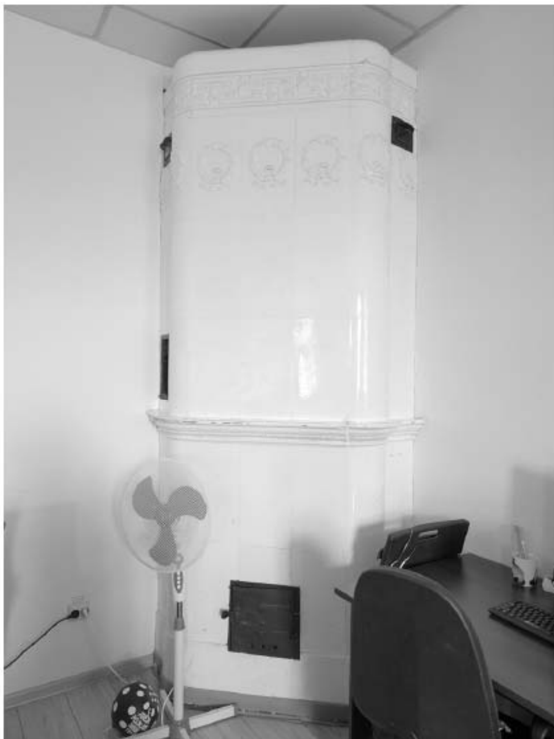
242. «Дом Н.Я. и Ф.Я. Колобовых». Санкт-Петербург, Большой пр. П.С., 16-18; Красного курсанта ул., д.1; Пионерская ул., д.6, литера А. Большой пр. П.С., 18. 5-й этаж. Фрагмент помещения 8-Н. Печь угловая двухъярусная. Фото: 21.03. 2023.
