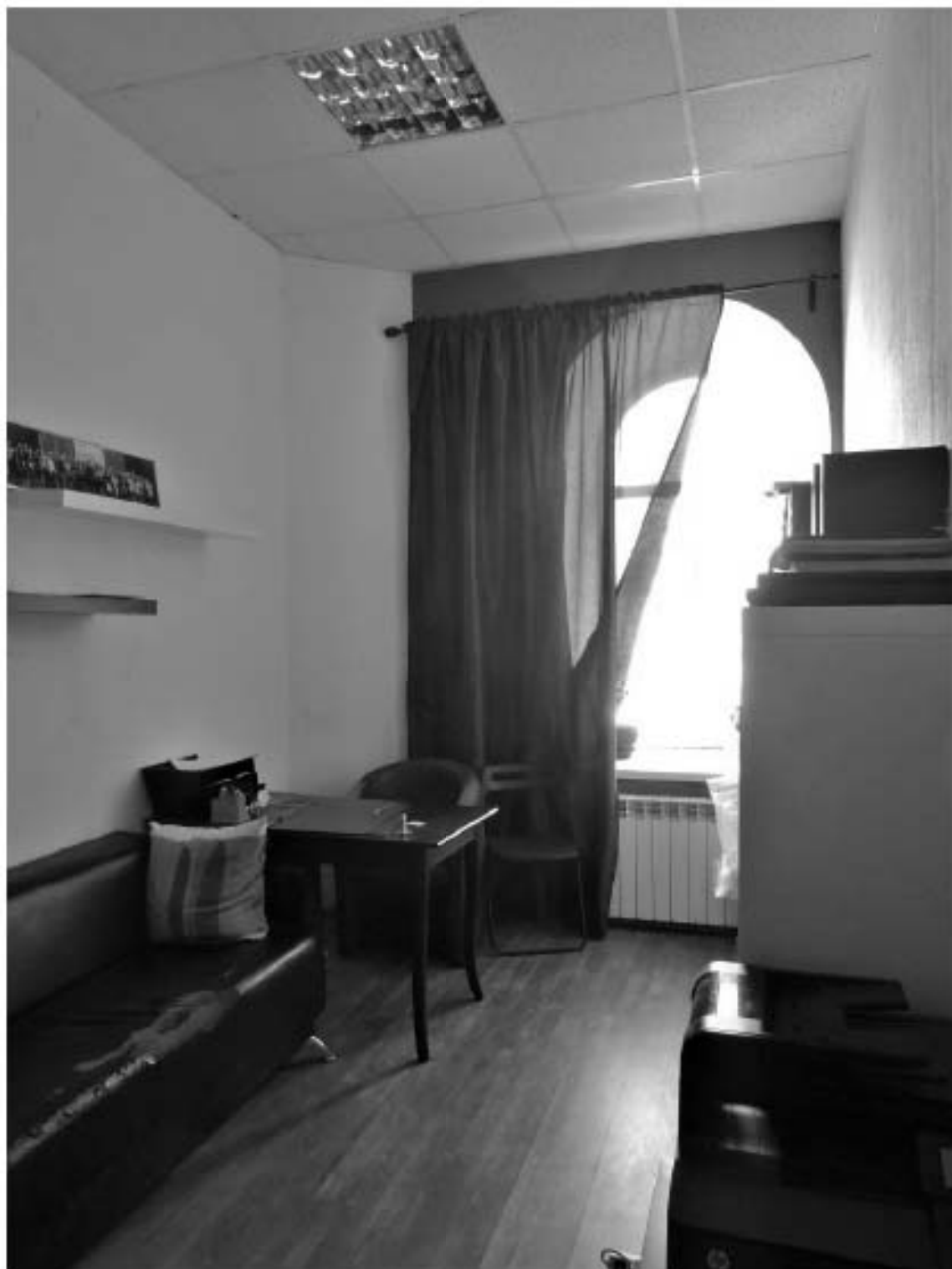
114. «Дом Н.Я. и Ф.Я. Колобовых». Санкт-Петербург, Большой пр. П.С., 16-18; Красного курсанта ул., д.1; Пионерская ул., д.6, литера А. Большой пр. П.С., 18. 3-й этаж. Фрагмент помещения 17-Н. Фото: 21.03. 2023.
