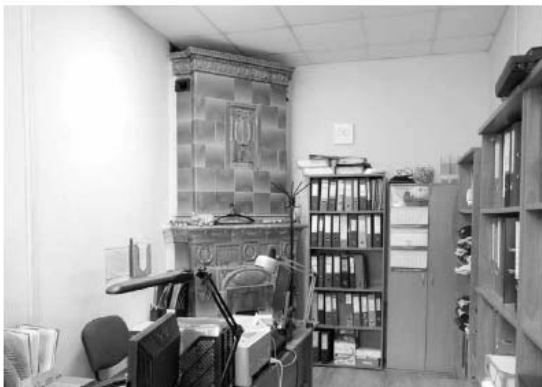
197. «Дом Н.Я. и Ф.Я. Колобовых». Санкт-Петербург; Большой пр. П.С., 16-18; Красного курсанта ул., д.1; Пионерская ул., д.6, литера А. Большой пр. П.С., 18. 4-й этаж. Фрагмент помещения 18-Н. Печь угловая двухъярусная. Фото: 21.03. 2023.
