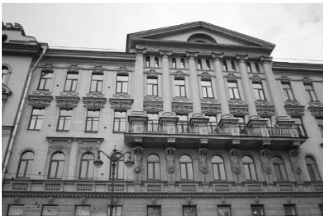
11. «Дом Н.Я. и Ф.Я. Колобовых». Санкт-Петербург, Большой пр. П.С., 16-18; Красно го курсанта ул., д.1; Пионерская ул., д.6, литера А. Лицевой фасад по Большому пр., П.С. Фрагмент. Фото: 21.03.2023.
