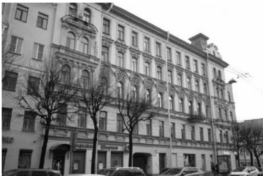
23. «Дом Н.Я. и Ф.Я. Колобовых». Санкт-Петербург, Большой пр. П. С., 16-18; Красного курсанта ул., д.1; Пионерская ул., д.6, литера А. Общий вид на лицевой фасад по ул. Красного курсанта. Фото: 21.03. 2023.
