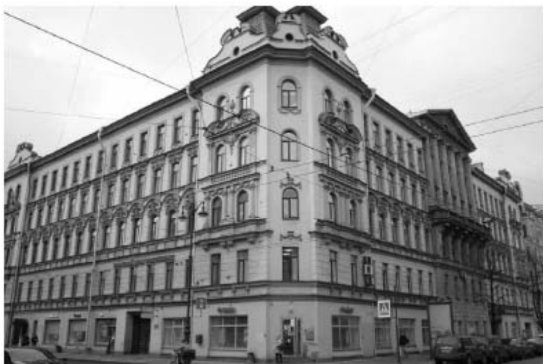
16. «Дом Н.Я. и Ф.Я. Колобовых». Санкт-Петербург, Большой пр. П.С., 16-18; Красногурская ул., д.1; Пионерская ул., д.6, литера А. Лицевые фасады по Большому пр., П.С. и Пионерской ул. Фото: 21.03.2023.
