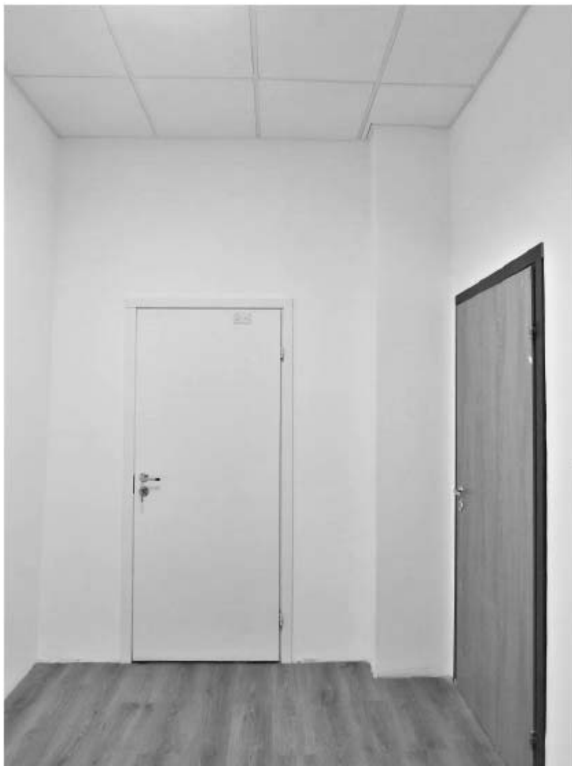
101. «Дом Н.Я. и Ф.Я. Колобовых». Санкт-Петербург, Большой пр. П.С., 16-18; Красного курсанта ул., д.1; Пионерская ул., д.6, литера А. Большой пр. П.С., 18. 3-й этаж. Фрагмент помещения 17-Н. Фото: 21.03. 2023.
