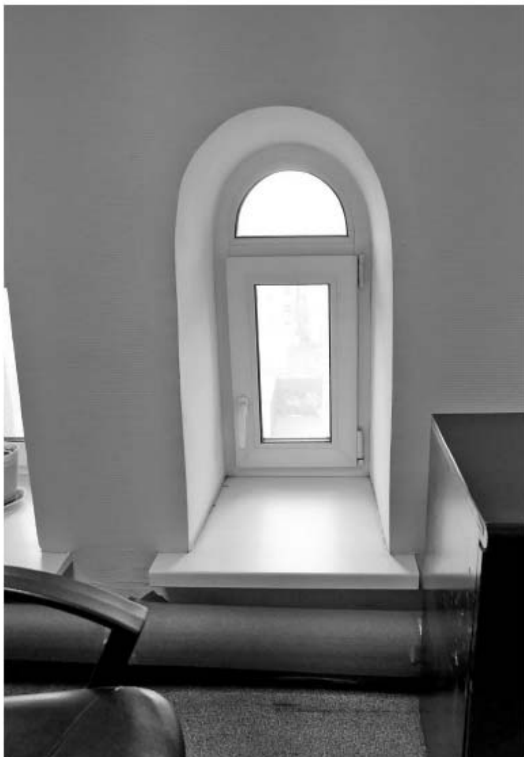
312. «Дом Н.Я. и Ф.Я. Колобовых». Санкт-Петербург, Большой пр. П.С., 16-18; Красного курсанта ул., д.1; Пионерская ул., д.6, литера А. Большой пр. П.С., 18. 6-й этаж. Фрагмент помещения 11-Н. Оконный проем. Фото: 21.03. 2023.
