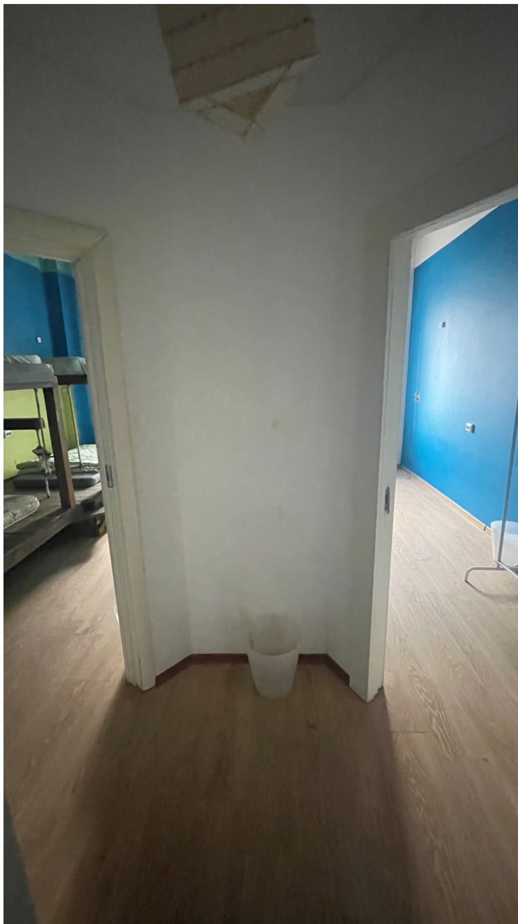
19. Фрагмент интеръера коридора (помещение №14/2.4);
