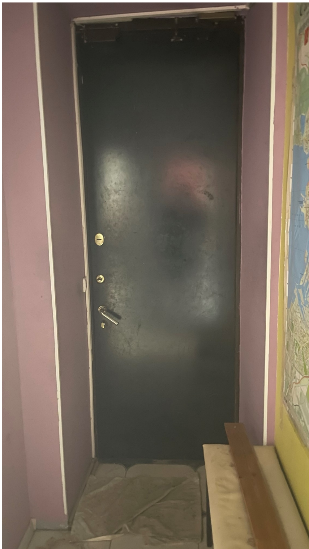
4. Вид на входную дверь в квартире;
