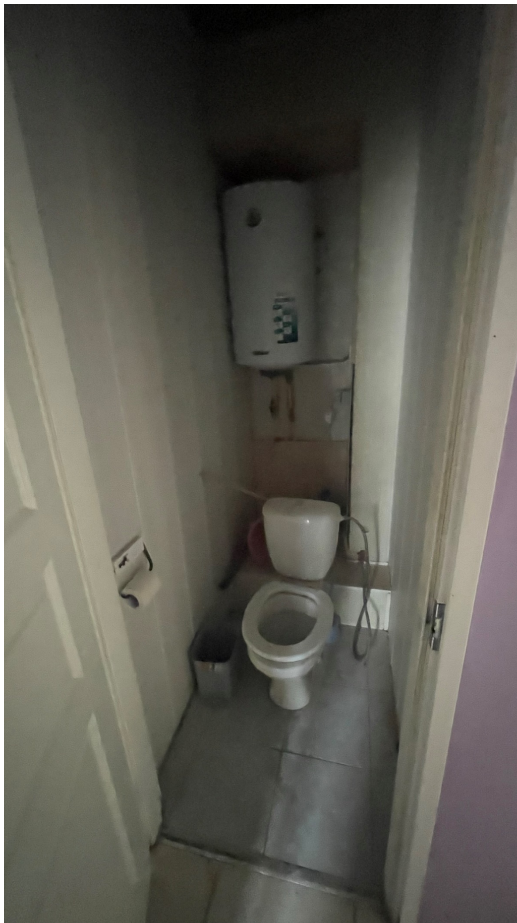
39.Фрагмент интерьера туалета (помещение №26/1.3);
