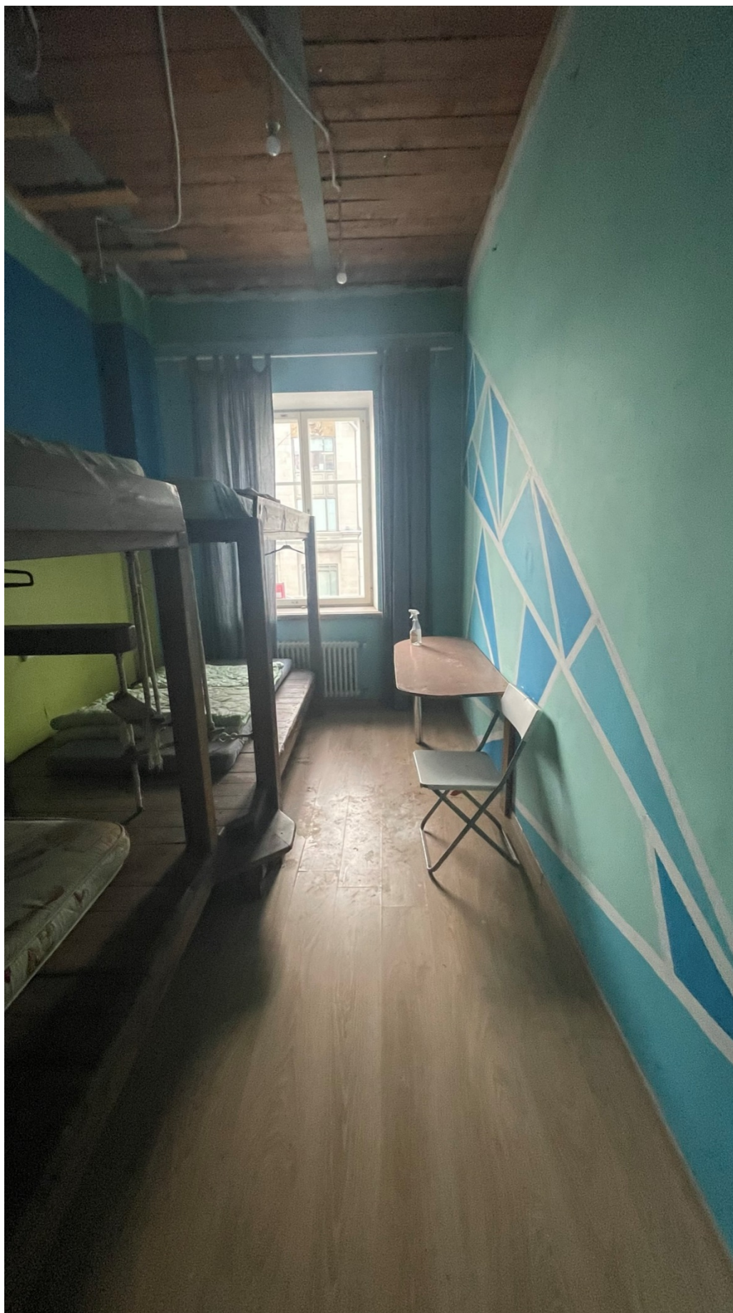
22. Фрагмент интерьера комнаты (помещение №15/13.2);
