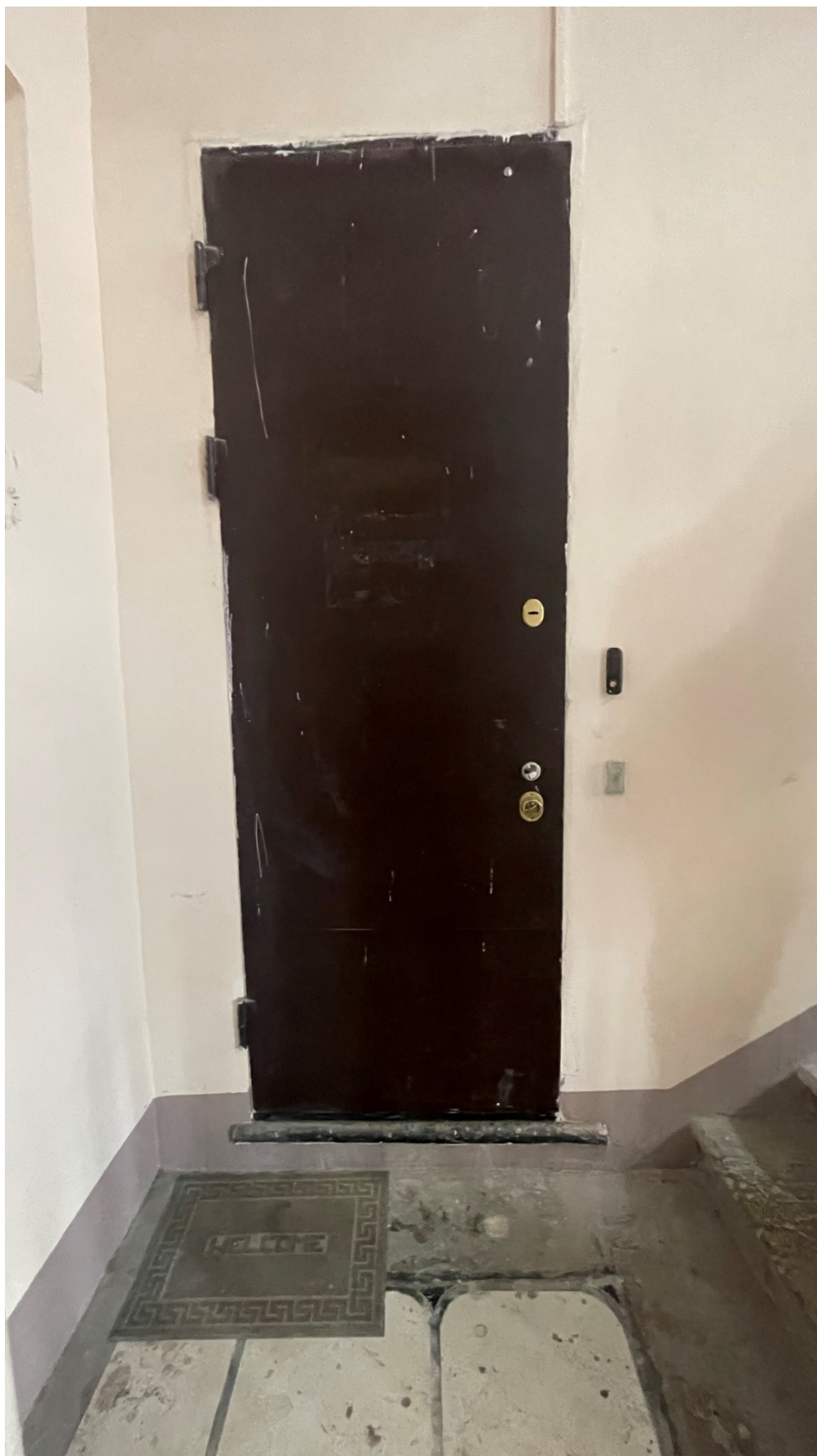
3. Вид на входную дверь в квартиру;
