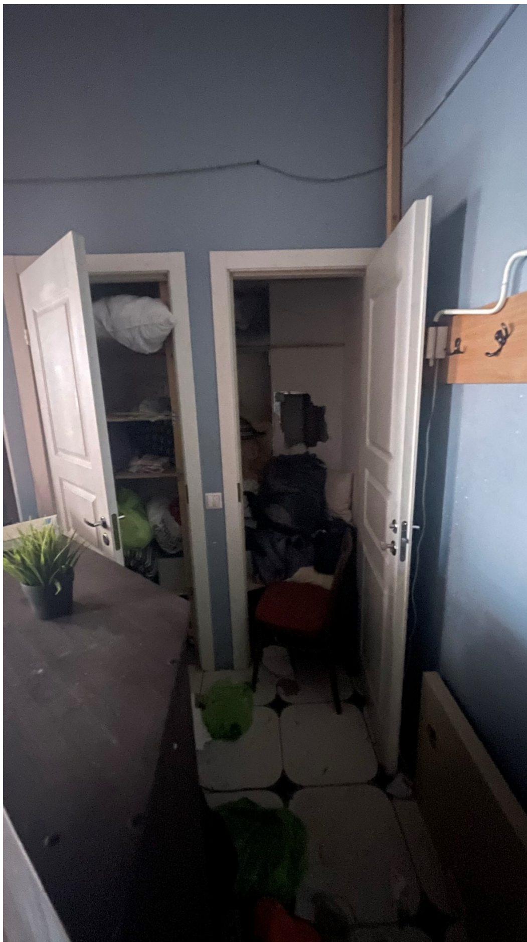
16. Вид на кладовую (помещение №10/1.7);
