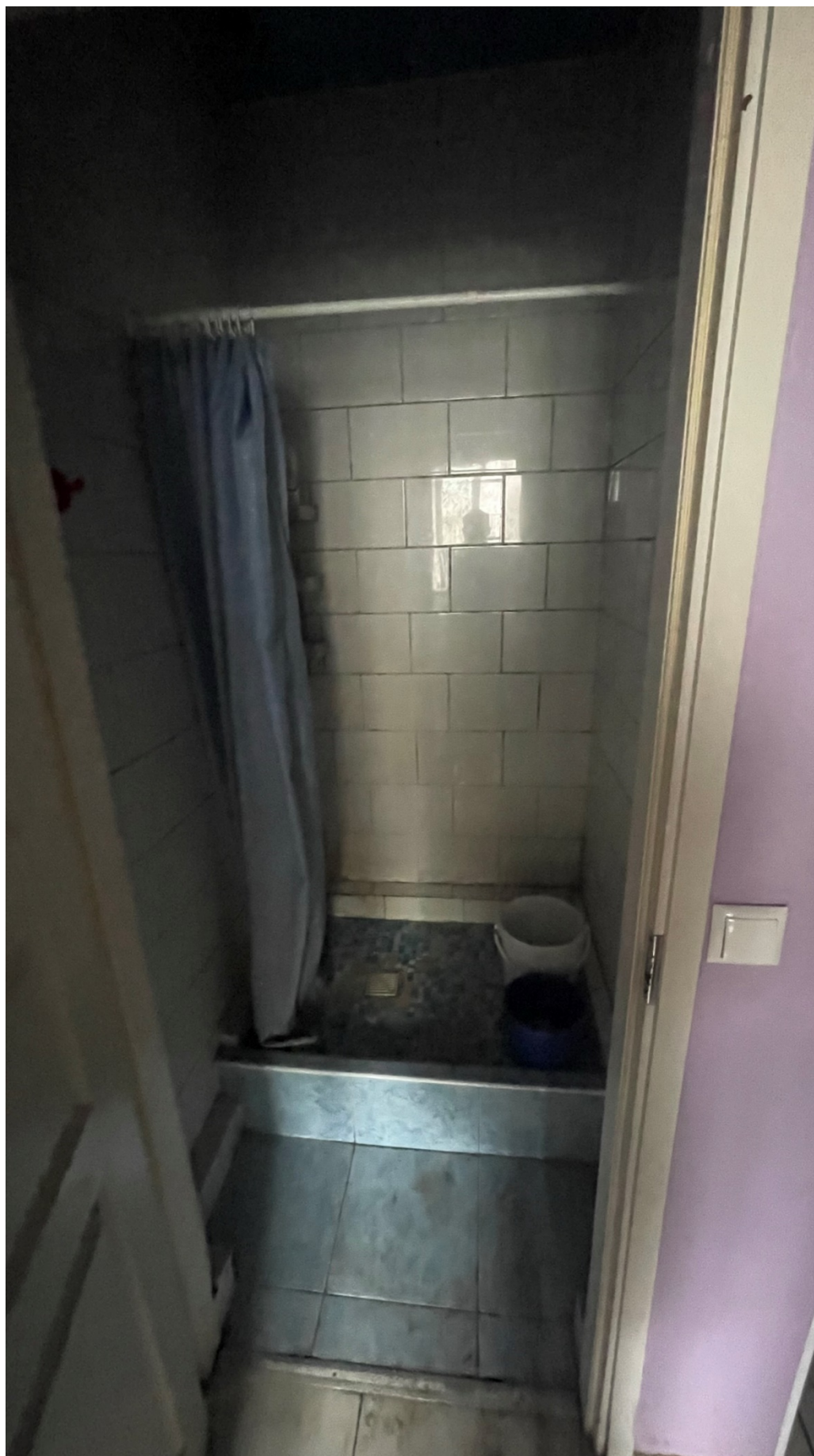
35.Фрагмент интерьера душевой (помещение №22/1.3);
