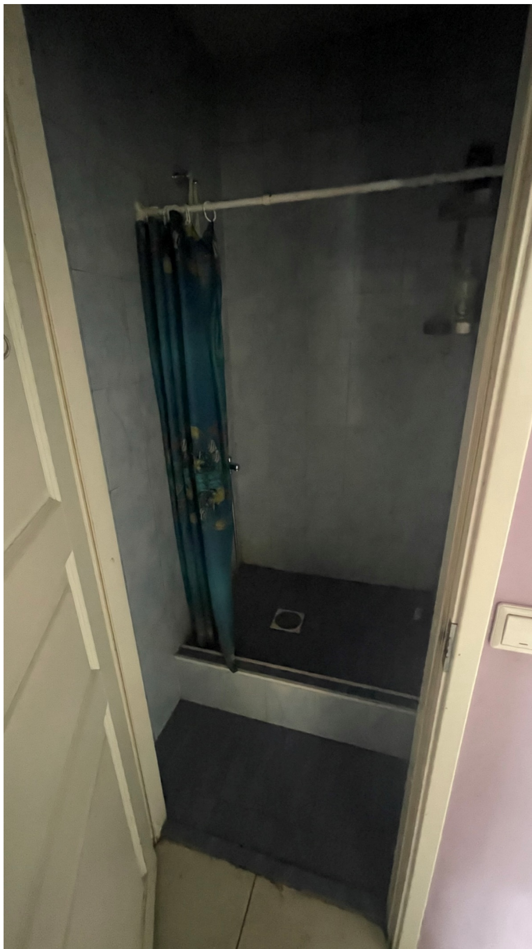
38. Фрагмент интерьера душевой (помещение №25/1.5);
