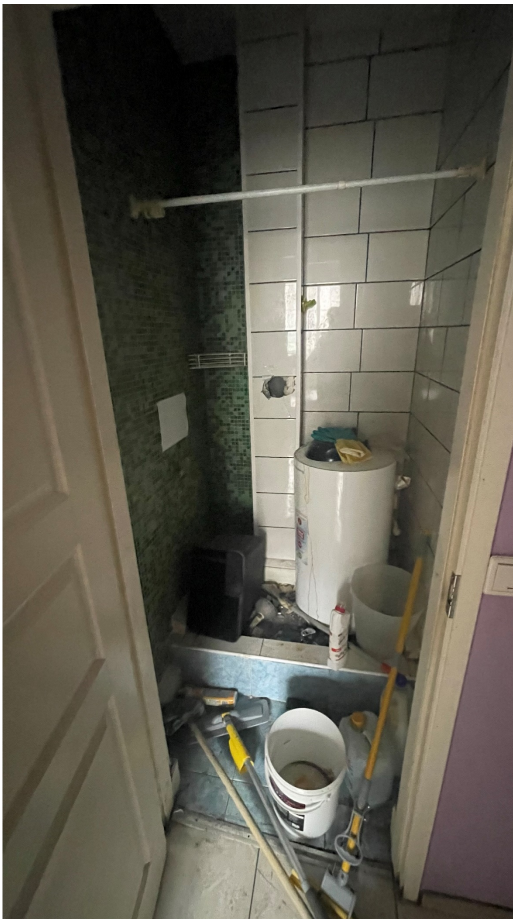
37.Фрагмент интерьера душевой (помещение №24/1.2);
