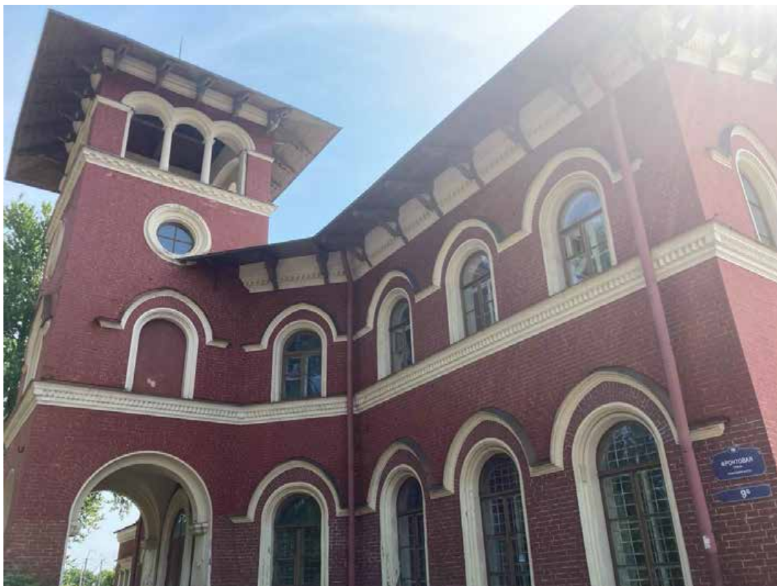
Фото 13. Объект культурного наследия регионального значения «Вокзал железнодорожной станции Стрельна». Северный фасад. Фрагмент. Съемка 08.06.2023 г. Трушковский В.Э.
