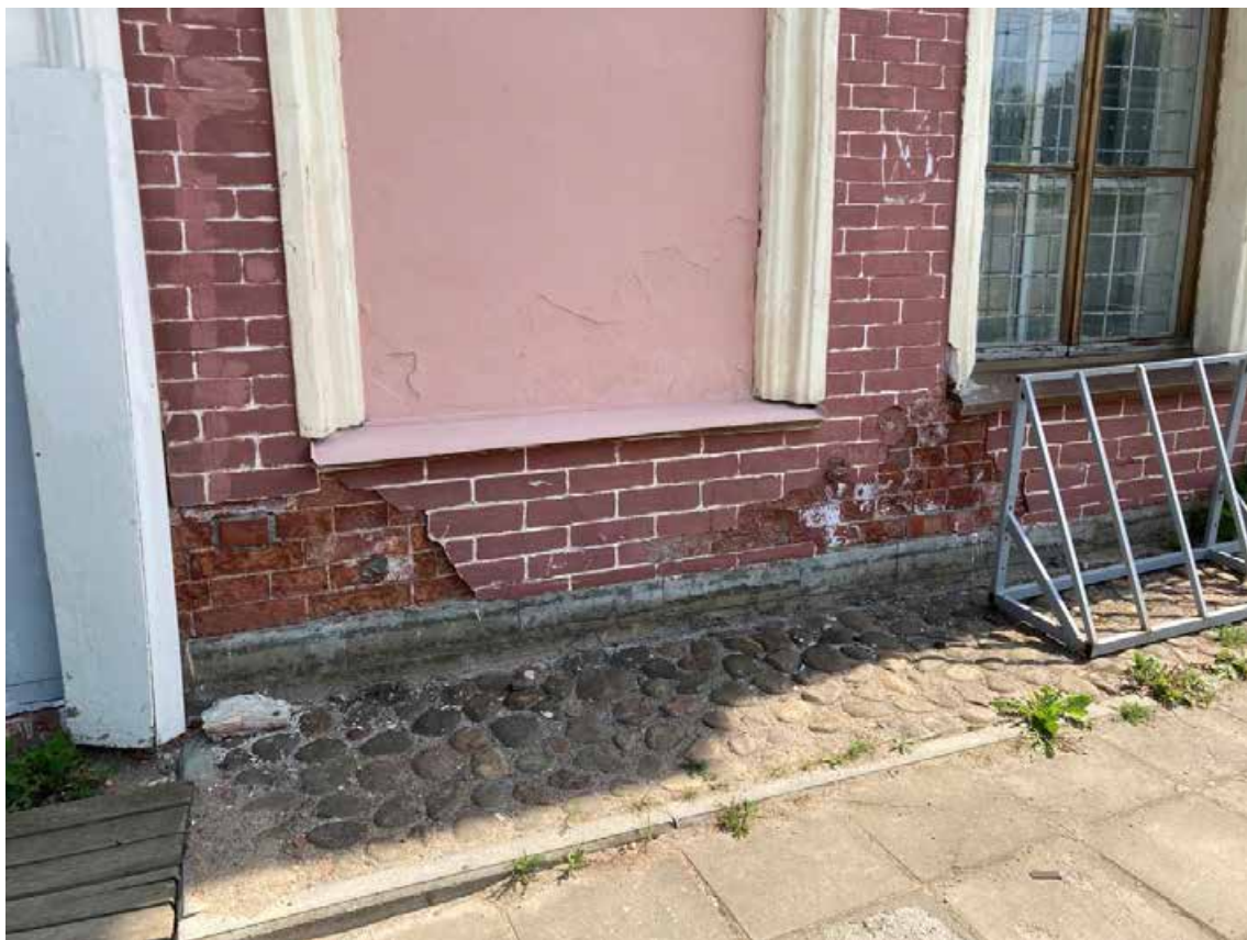
Фото 11. Объект культурного наследия регионального значения «Вокзал железнодорожной станции Стрельна». Западный фасад. Фрагмент. Съемка 08.06.2023 г. Трушковский В.Э.
