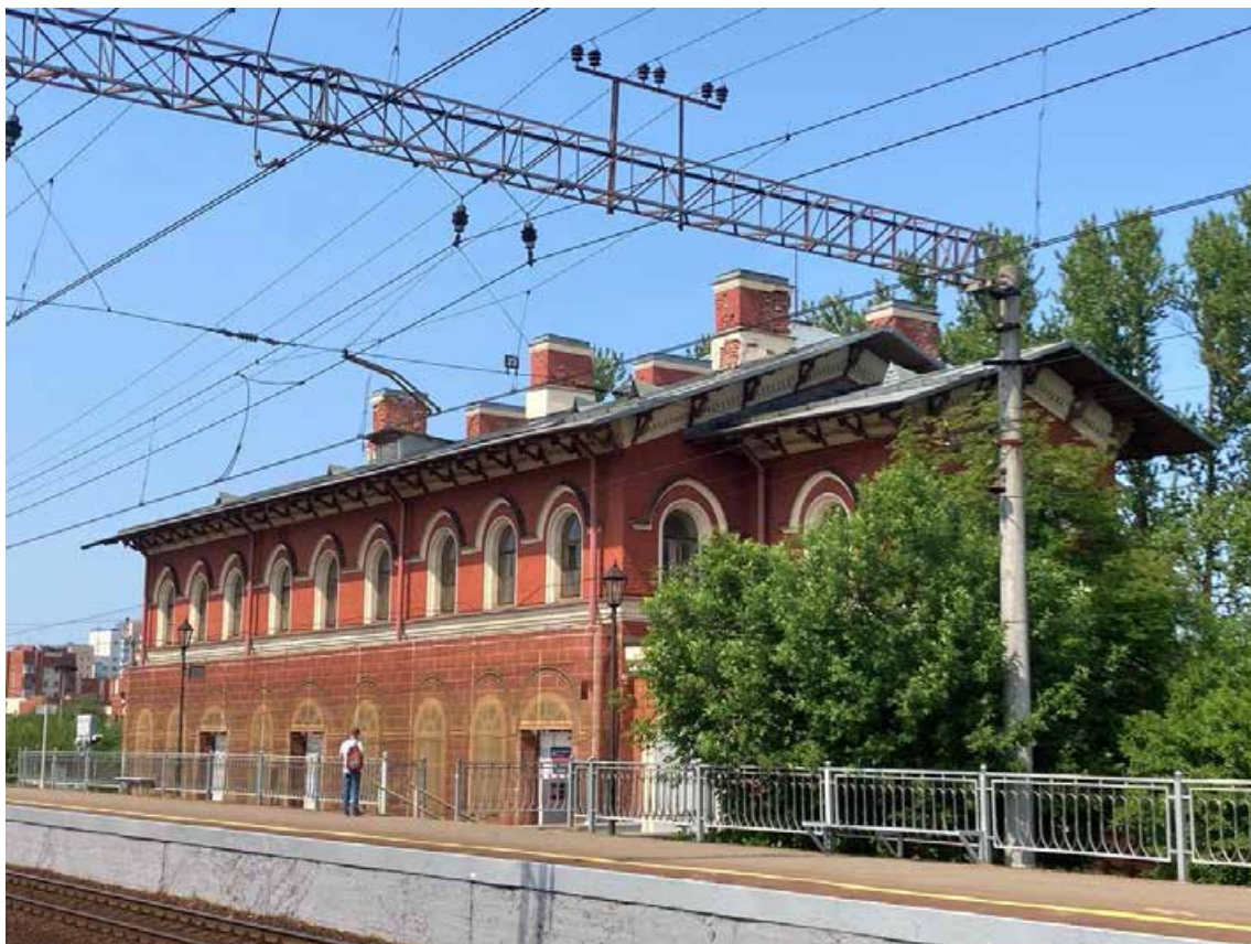
Фото 2. Объект культурного наследия регионального значения «Вокзал железнодорожной станции Стрельна». Южный фасад. Восточный фасад. Фрагмент. Съемка 08.06.2023 г. Трушковский В.Э.
