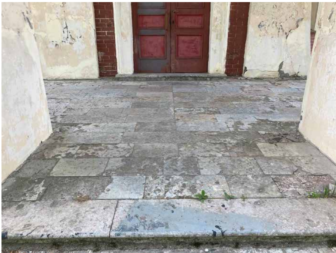
Фото 16. Объект культурного наследия регионального значения «Вокзал железнодорожной станции Стрельна». Северный фасад. Фрагмент. Башня. Покрытие пола известняковыми плитами. Съемка 08.06.2023 г. Трушковский В.Э.
