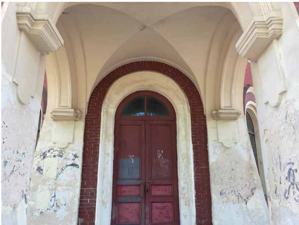
Фото 17. Объект культурного наследия регионального значения «Вокзал железнодорожной станции Стрельна». Северный фасад. Фрагмент. Башня. Столбы основания башни. Крестовый свод. Съемка 08.06.2023 г. Трушковский В.Э.
