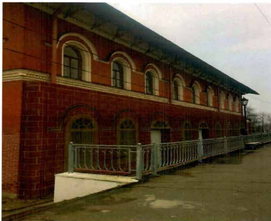
3. Общий вид. Южный фасад.
