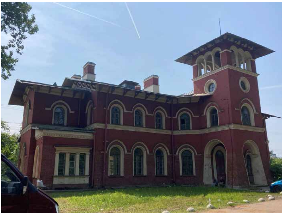
Фото 20. Объект культурного наследия регионального значения «Вокзал железнодорожной станции Стрельна». Северный фасад. Фрагмент. Съемка 08.06.2023 г. Трушковский В.Э.
