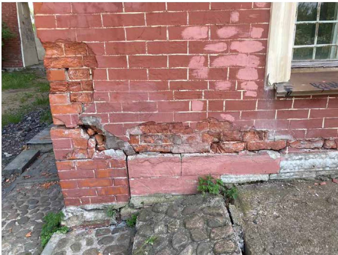
Фото 10. Объект культурного наследия регионального значения «Вокзал железнодорожной станции Стрельна». Западный фасад. Фрагмент. Съемка 08.06.2023 г. Трушковский В.Э.
