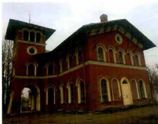
4. Общий вид. Западный фасад.
