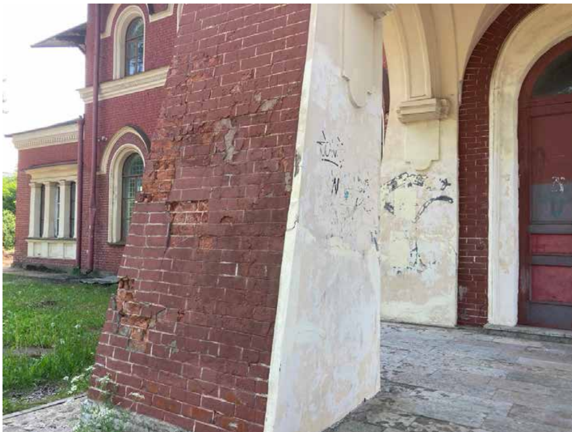
Фото 19. Объект культурного наследия регионального значения «Вокзал железнодорожной станции Стрельна». Северный фасад. Фрагмент. Башня. Восточный столб основания башни. Съемка 08.06.2023 г. Трушковский В.Э.
