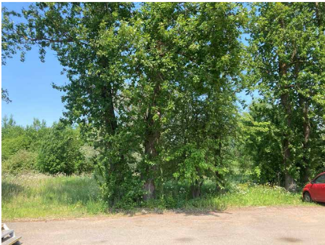
Фото 27. Территория объекта культурного наследия регионального значения «Вокзал железнодорожной станции Стрельна». Вид на северную часть территории. Съемка 08.06.2023 г. Трушковский В.Э.
