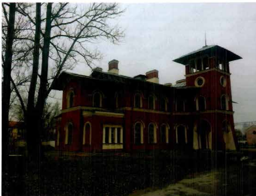
2. Общий вид. Северный и восточный фасады.
