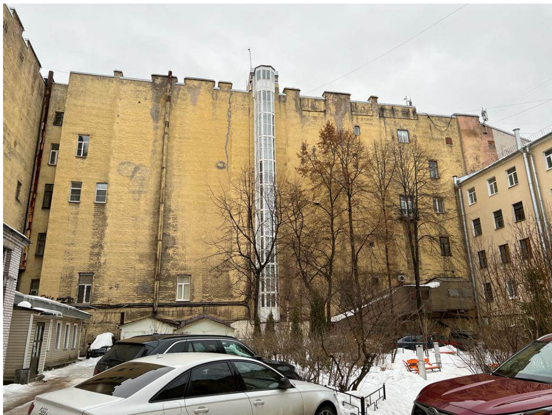
9. Выявленный объект культурного наследия «Дом А.Д.и Н.К.Чижовых». Брандмауэрная стена здания. Окно квартиры №37.
