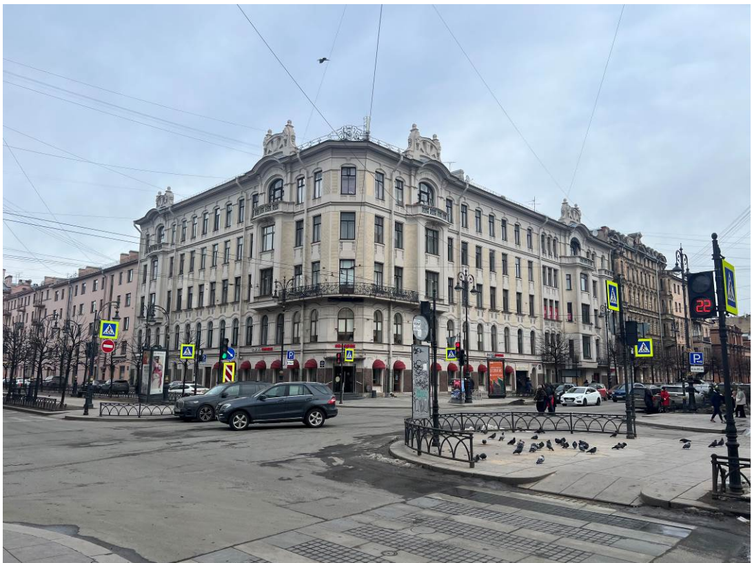
3. Выявленный объект культурного наследия «Дом А.Д.и Н.К.Чижовых». Общий вид здания с юго-запада.
