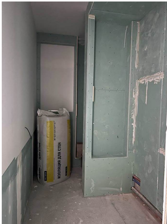
20. Выявленный объект культурного наследия «Дом А.Д.и Н.К.Чижовых». Интерьер парадной лестницы (вход с ул. Чайковского). Квартира №37. Помещения 5, 6.
