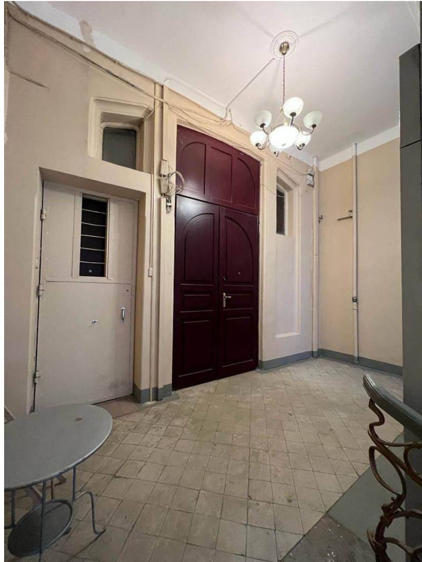
15. Выявленный объект культурного наследия «Дом А.Д.и Н.К.Чижовых». Интерьер парадной лестницы (вход с ул. Чайковского). Площадка 3-го этажа.
