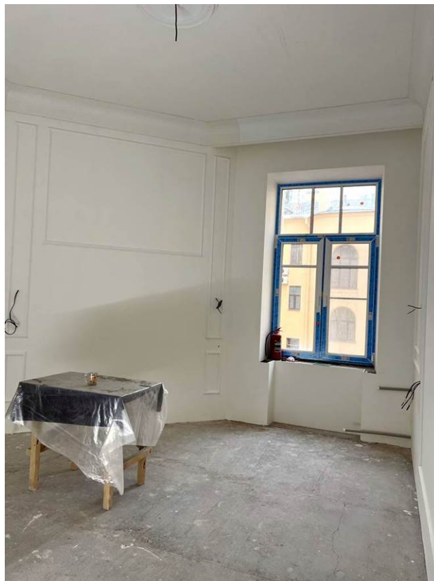
25. Выявленный объект культурного наследия «Дом А.Д.и Н.К.Чижовых». Интерьер парадной лестницы (вход с ул. Чайковского). Квартира №37. Помещение 9.
