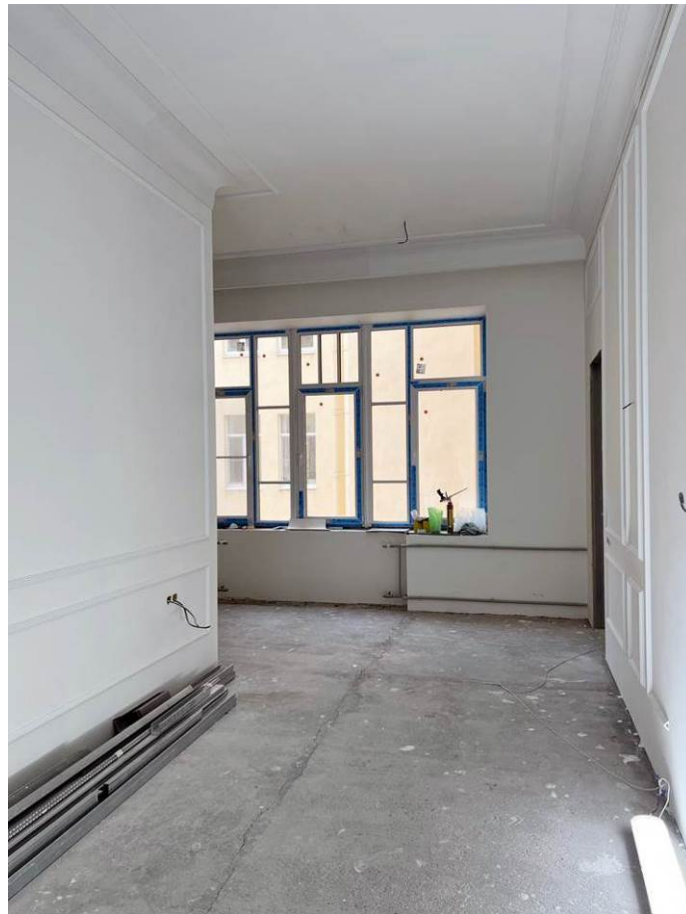
19. Выявленный объект культурного наследия «Дом А.Д.и Н.К.Чижовых». Интерьер парадной лестницы (вход с ул. Чайковского). Квартира №37. Помещение 3.
