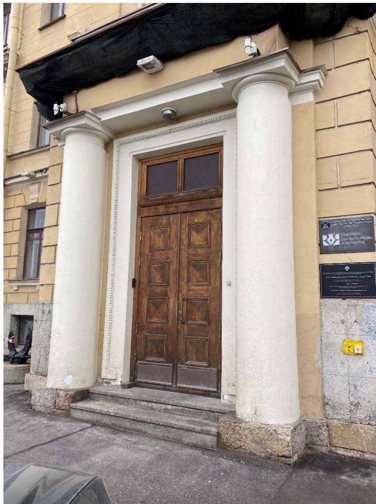
Фото №6. Юго-западный фасад, главный вход в здание.
