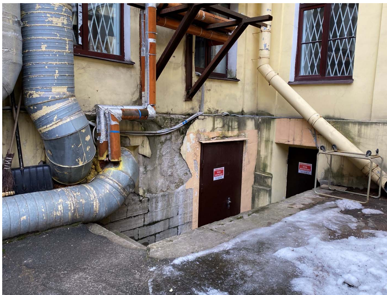
Фото №15. Северо-западный дворовый фасад, приямок.
