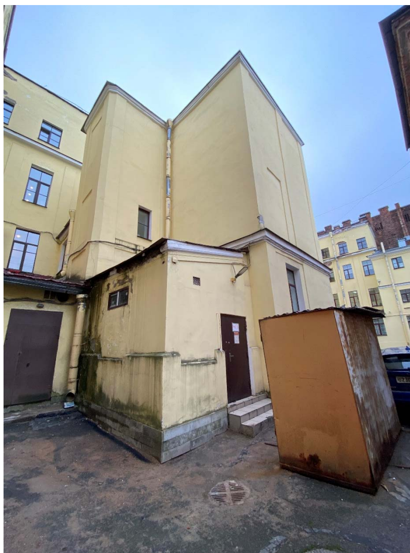
Фото №17. Северо-западный дворовый фасад, трехэтажный объем здания.
