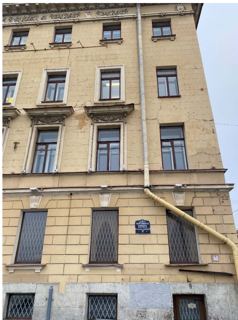
Фото №3. Юго-западный фасад, фрагмент.
