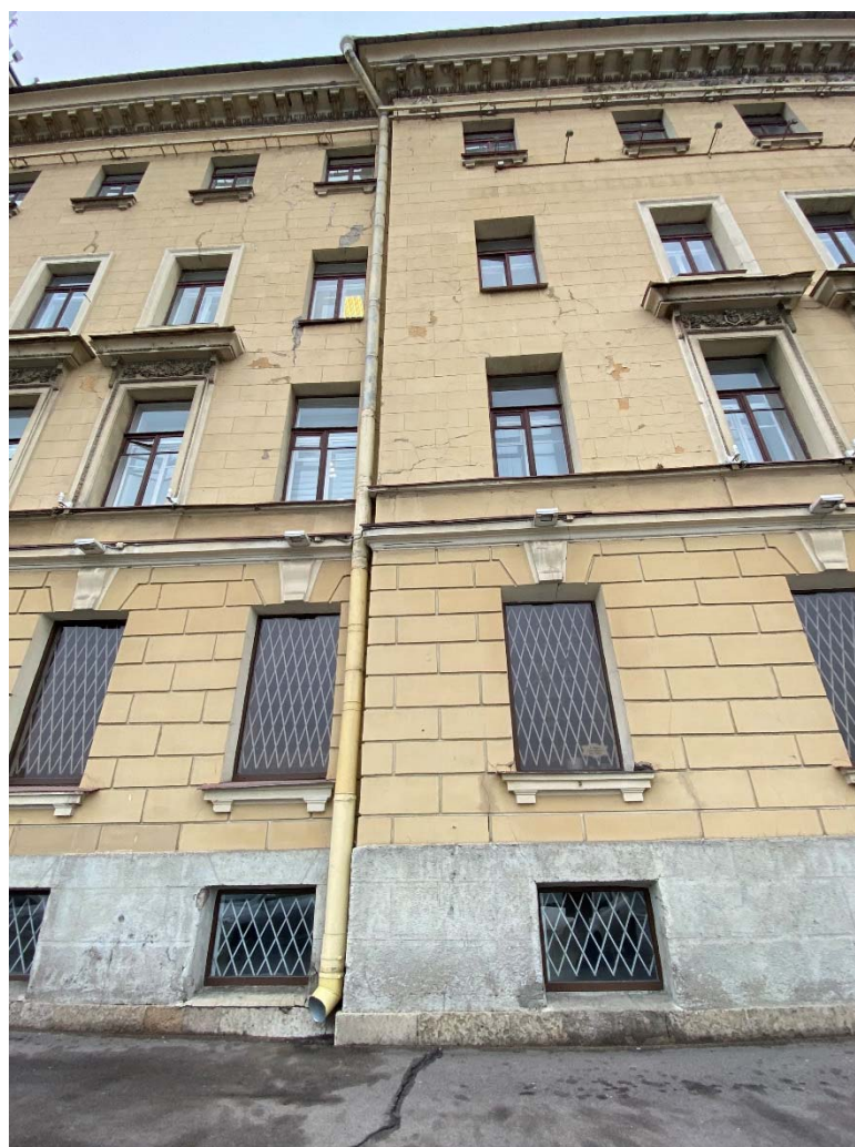
Фото №4. Юго-западный фасад, фрагмент.
