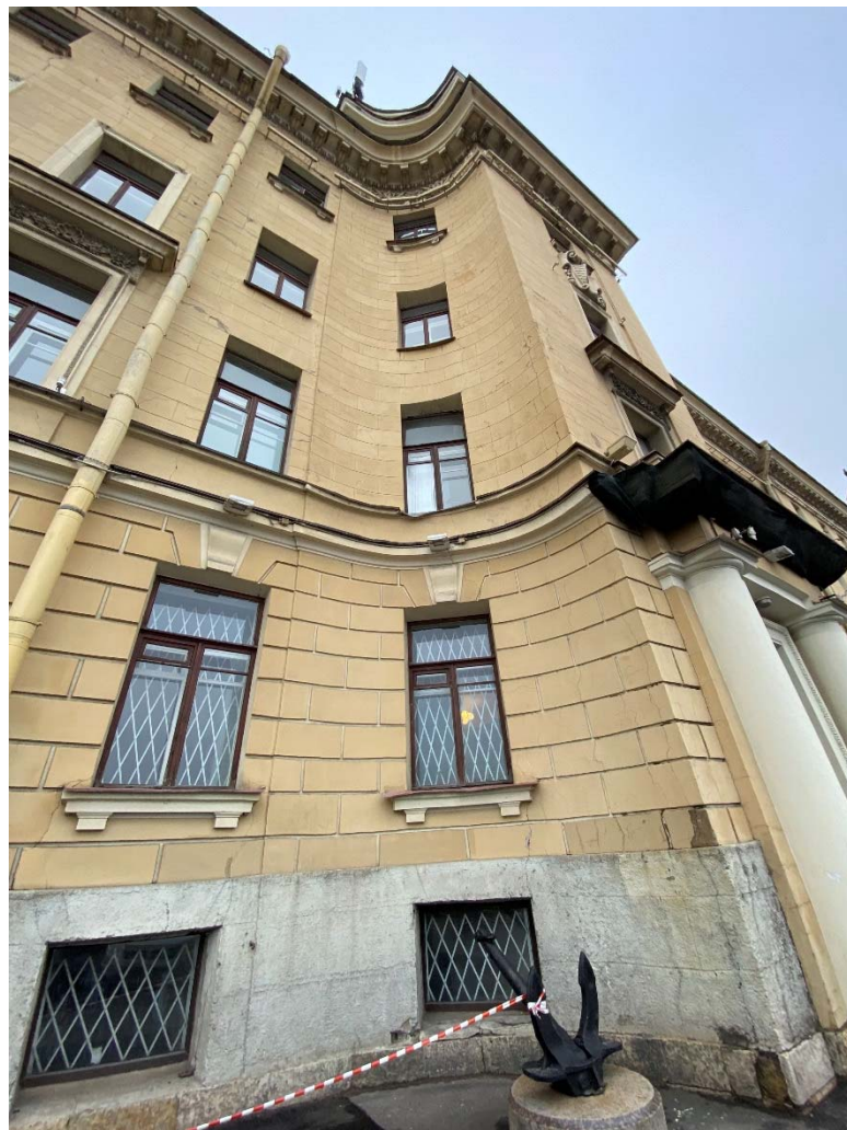
Фото №7. Юго-западный фасад, фрагмент.
