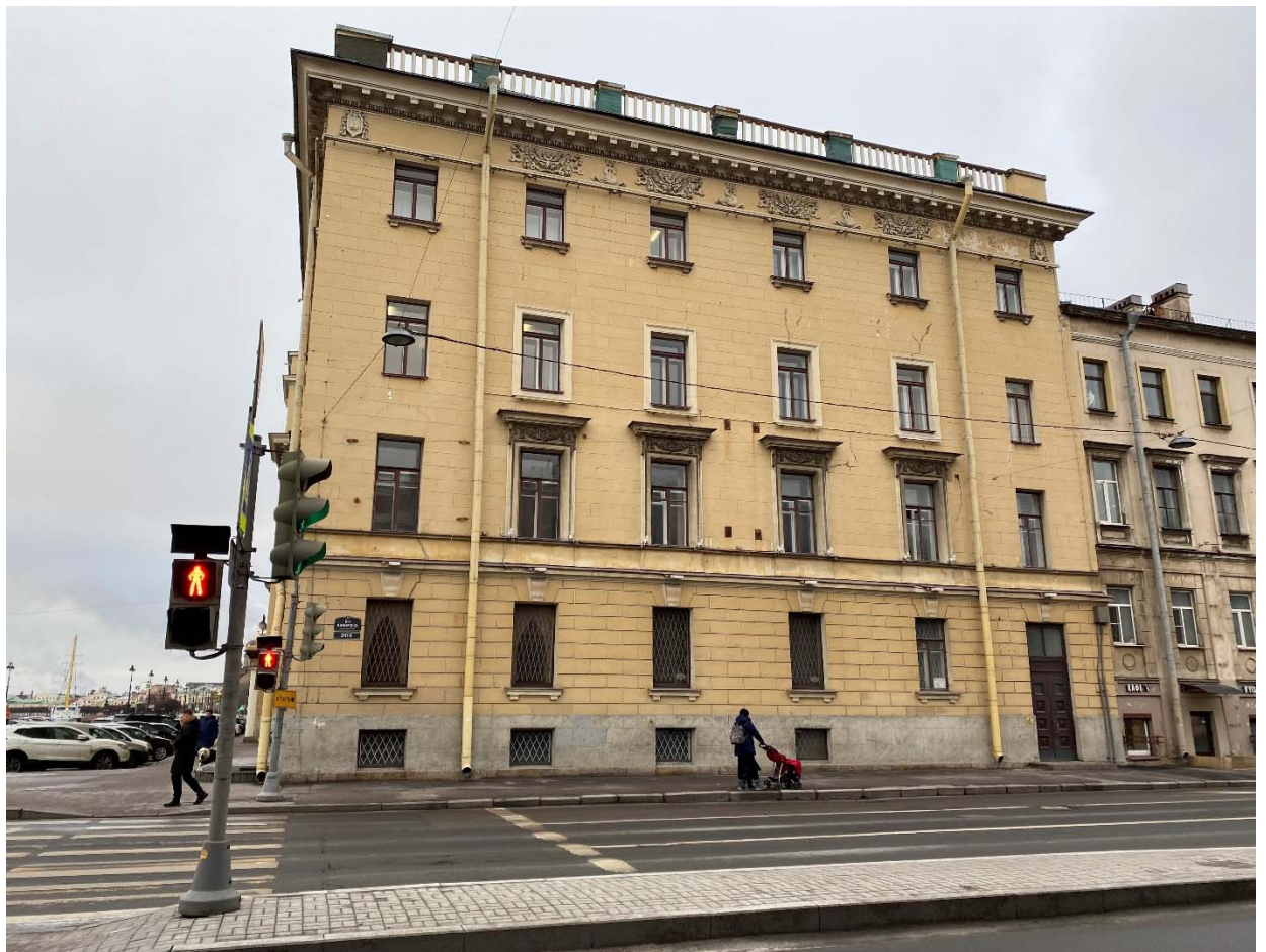
Фото №9. Северо-восточный фасад, общий вид.
