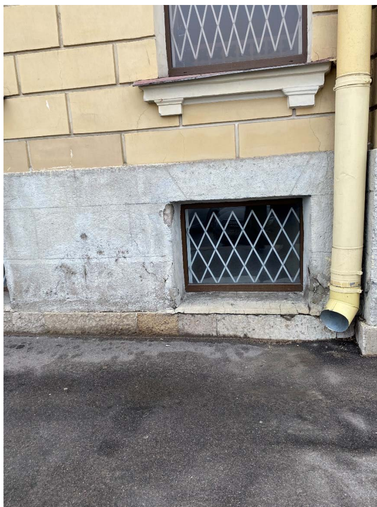
Фото №5. Юго-западный фасад, фрагмент.
