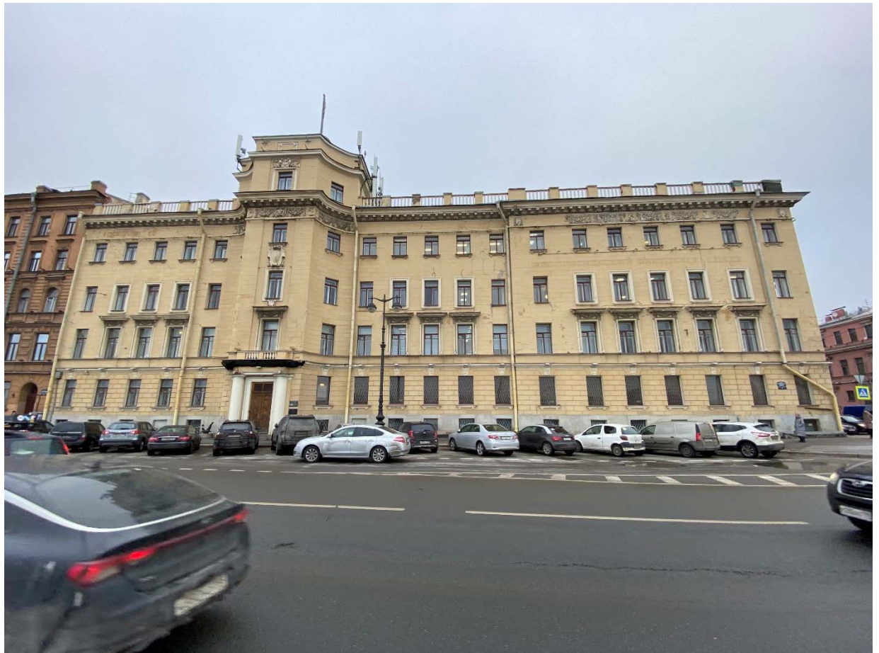
Фото №1. Юго-западный фасад, общий вид.
