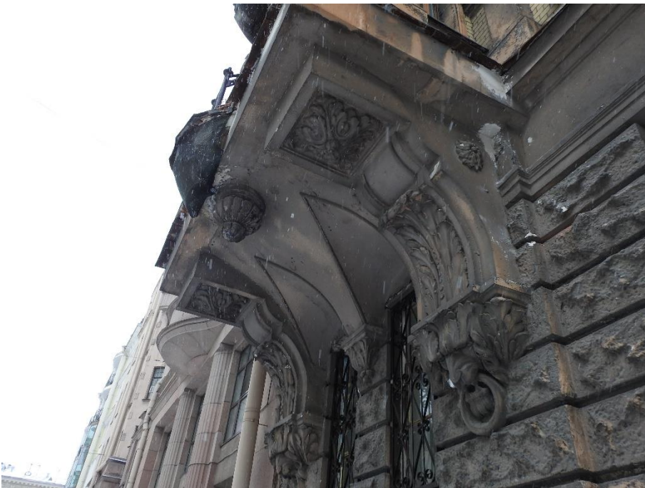
14. «Дом М.В. Захарова», Большой Казачий переулок, д.6, лит. А. Северо-западный фасад. Фрагмент. Фото 06.02.2023г.
