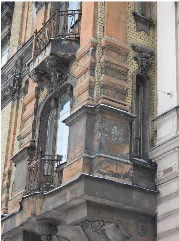
16. «Дом М.В. Захарова», Большой Казачий переулок, д.6, лит. А. Северо-западный фасад. Фрагмент. Фото 06.02.2023г.
