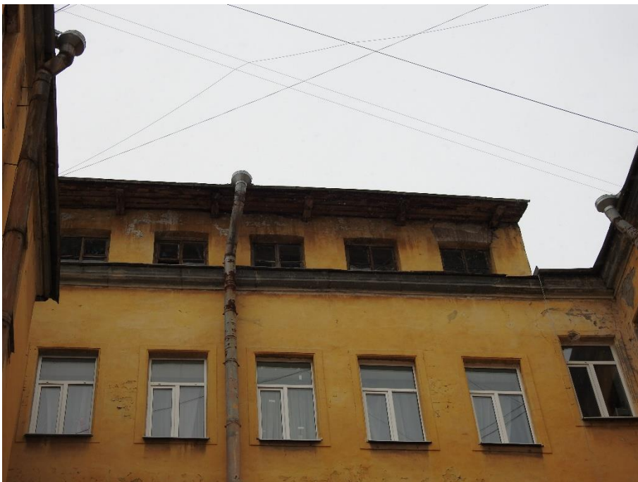
33. «Дом М.В. Захарова», Большой Казачий переулок, д.6, лит. А. Юго-восточный фасад внутреннего двора. Фрагмент. Фото 06.02.2023г.
