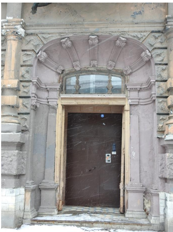
8. «Дом М.В. Захарова», Большой Казачий переулок, д.6, лит. А. Северо-западный фасад. Фрагмент. Фото 06.02.2023г.
