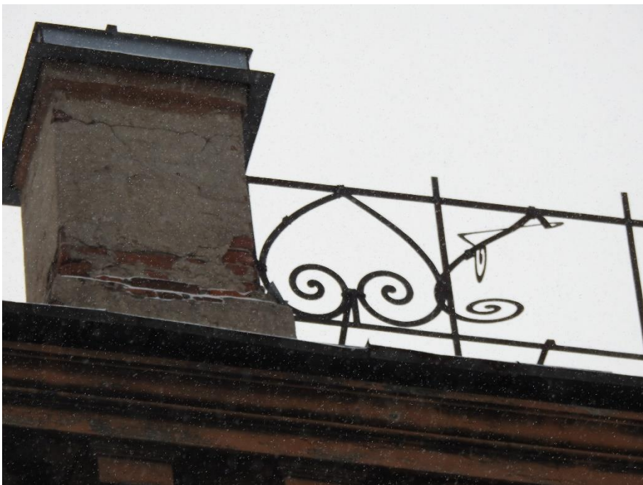
30. «Дом М.В. Захарова», Большой Казачий переулок, д.6, лит. А. Северо-западный фасад. Фрагмент. Фото 06.02.2023г.
