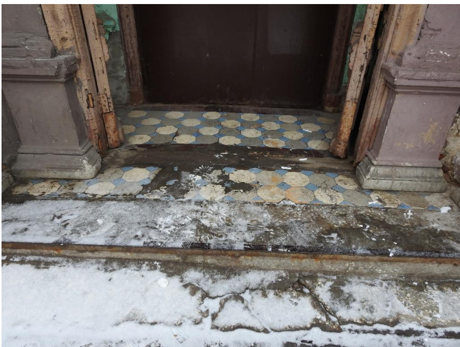
9. «Дом М.В. Захарова», Большой Казачий переулок, д.6, лит. А. Северо-западный фасад. Фрагмент. Фото 06.02.2023г.
