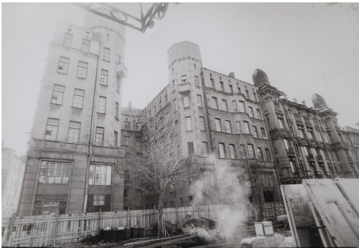
Илл. 48. Доходные дома Н.П. Семенова и М.В. Захарова (справа). Вид главного фасада во время ремонта инженерных сетей. 1988 г. Архив КГИОП
