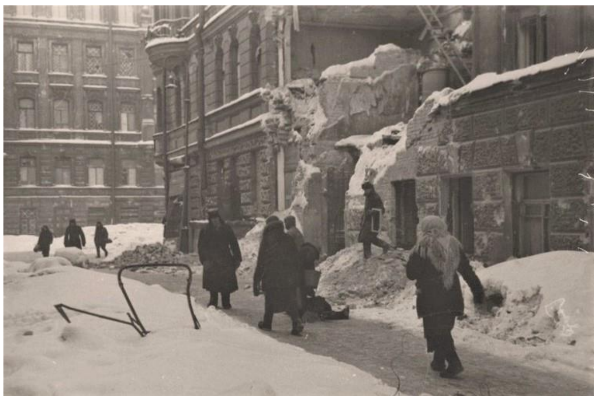
Илл. 38. Разрушения жилого флигеля дома Ф.И. Кривдина по Малому Казачьему переулку. Фотография Федосеева Ф.Г. 1942 г. ГМИ СПб
