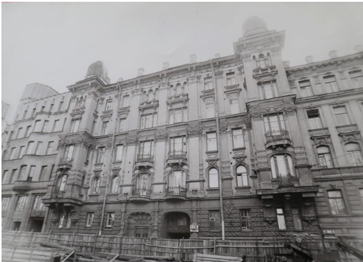
Илл. 47. Доходный дом М.В. Захарова. Вид главного фасада во время ремонта инженерных сетей. 1988 г. Архив КГИОП
