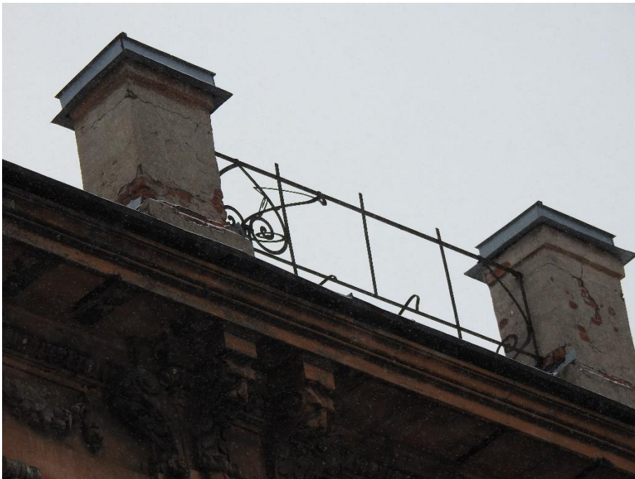
29. «Дом М.В. Захарова», Большой Казачий переулок, д.6, лит. А. Северо-западный фасад. Фрагмент. Фото 06.02.2023г.
