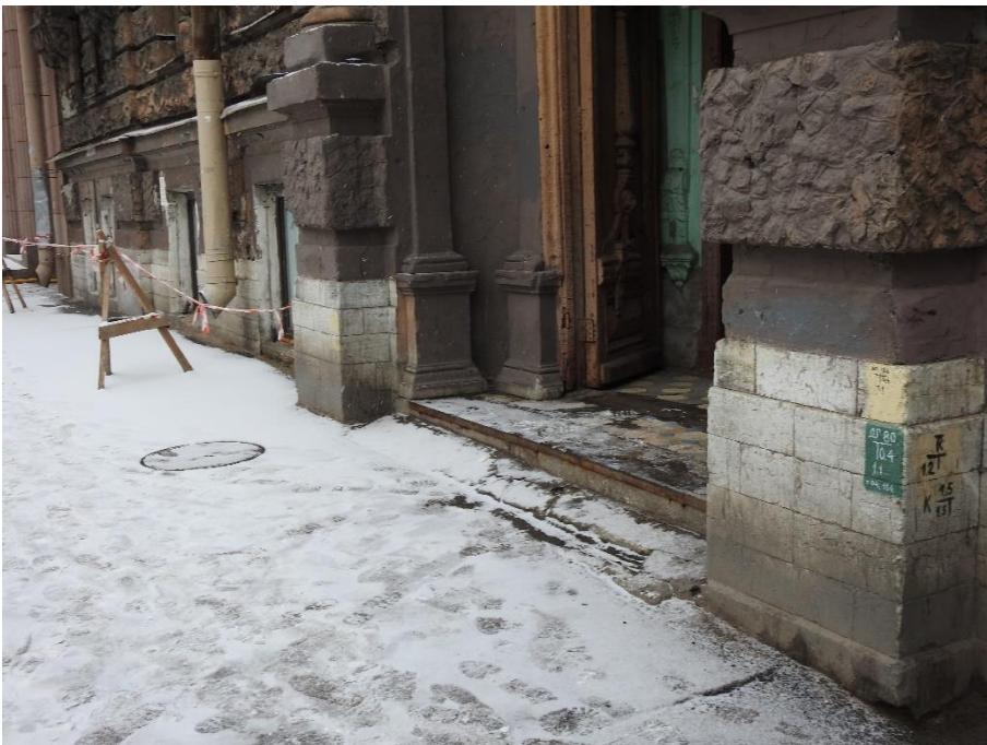
6. «Дом М.В. Захарова», Большой Казачий переулок, д.6, лит. А. Северо-западный фасад. Фрагмент. Фото 06.02.2023г.
