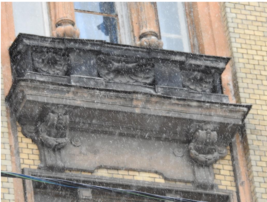
24. «Дом М.В. Захарова», Большой Казачий переулок, д.6, лит. А. Северо-западный фасад. Фрагмент. Фото 06.02.2023г.
