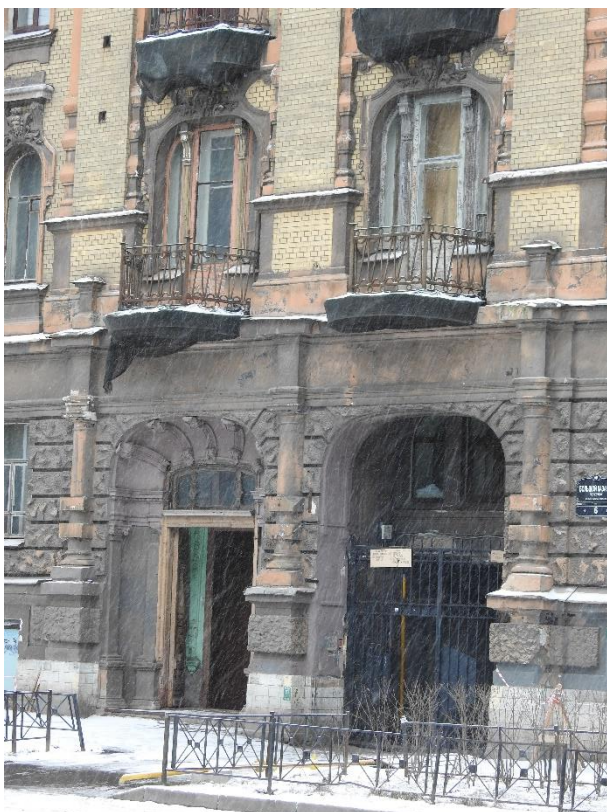
7. «Дом М.В. Захарова», Большой Казачий переулок, д.6, лит. А. Северо-западный фасад. Фрагмент. Фото 06.02.2023г.
