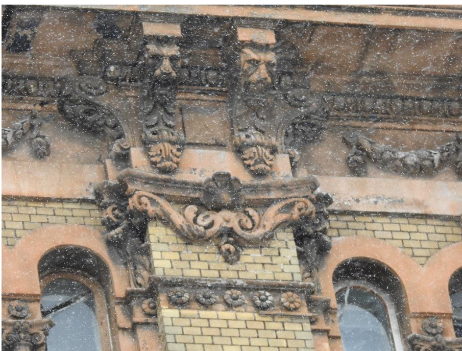
28. «Дом М.В. Захарова», Большой Казачий переулок, д.6, лит. А. Северо-западный фасад. Фрагмент. Фото 06.02.2023г.
