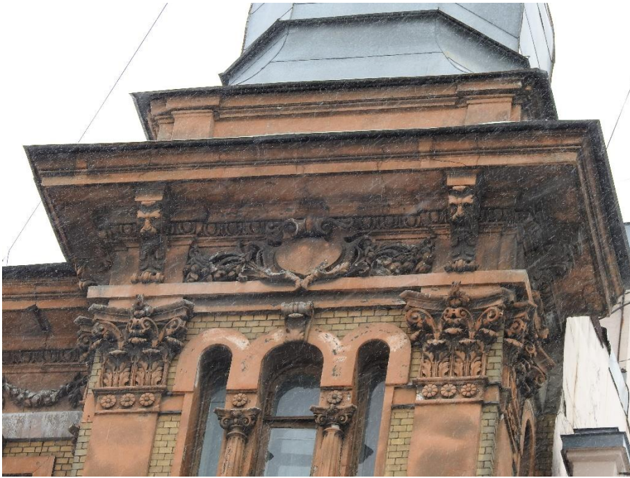
25. «Дом М.В. Захарова», Большой Казачий переулок, д.6, лит. А. Северо-западный фасад. Фрагмент. Фото 06.02.2023г.
