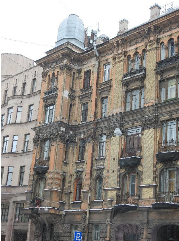
18. «Дом М.В. Захарова», Большой Казачий переулок, д.6, лит. А. Северо-западный фасад. Фрагмент. Фото 06.02.2023г.
