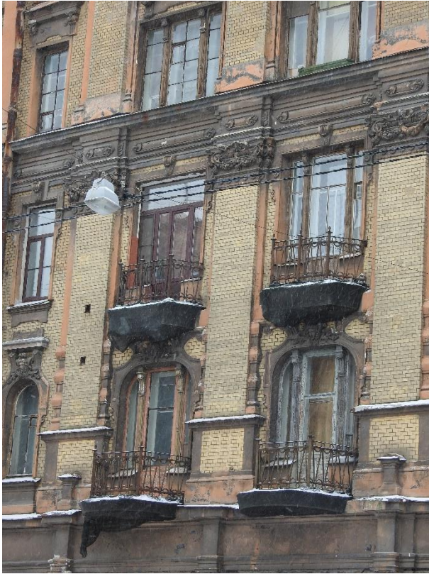
19. «Дом М.В. Захарова», Большой Казачий переулок, д.6, лит. А. Северо-западный фасад. Фрагмент. Фото 06.02.2023г.
