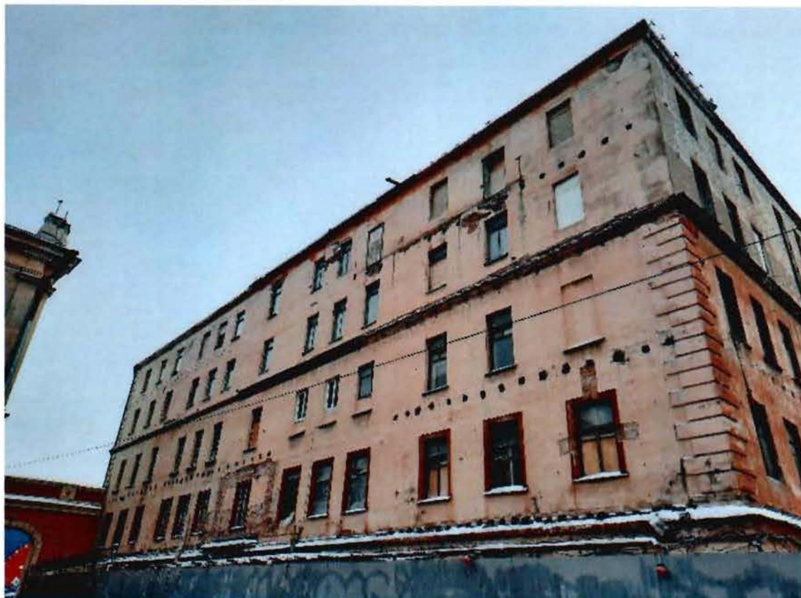
2. Вид на западный фасад объекта культурного наследия
