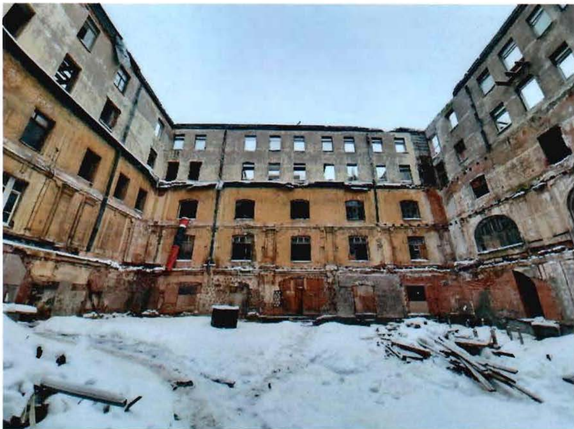
4. Вид на дворовые фасады объекта культурного наследия и территорию внутреннего двора
