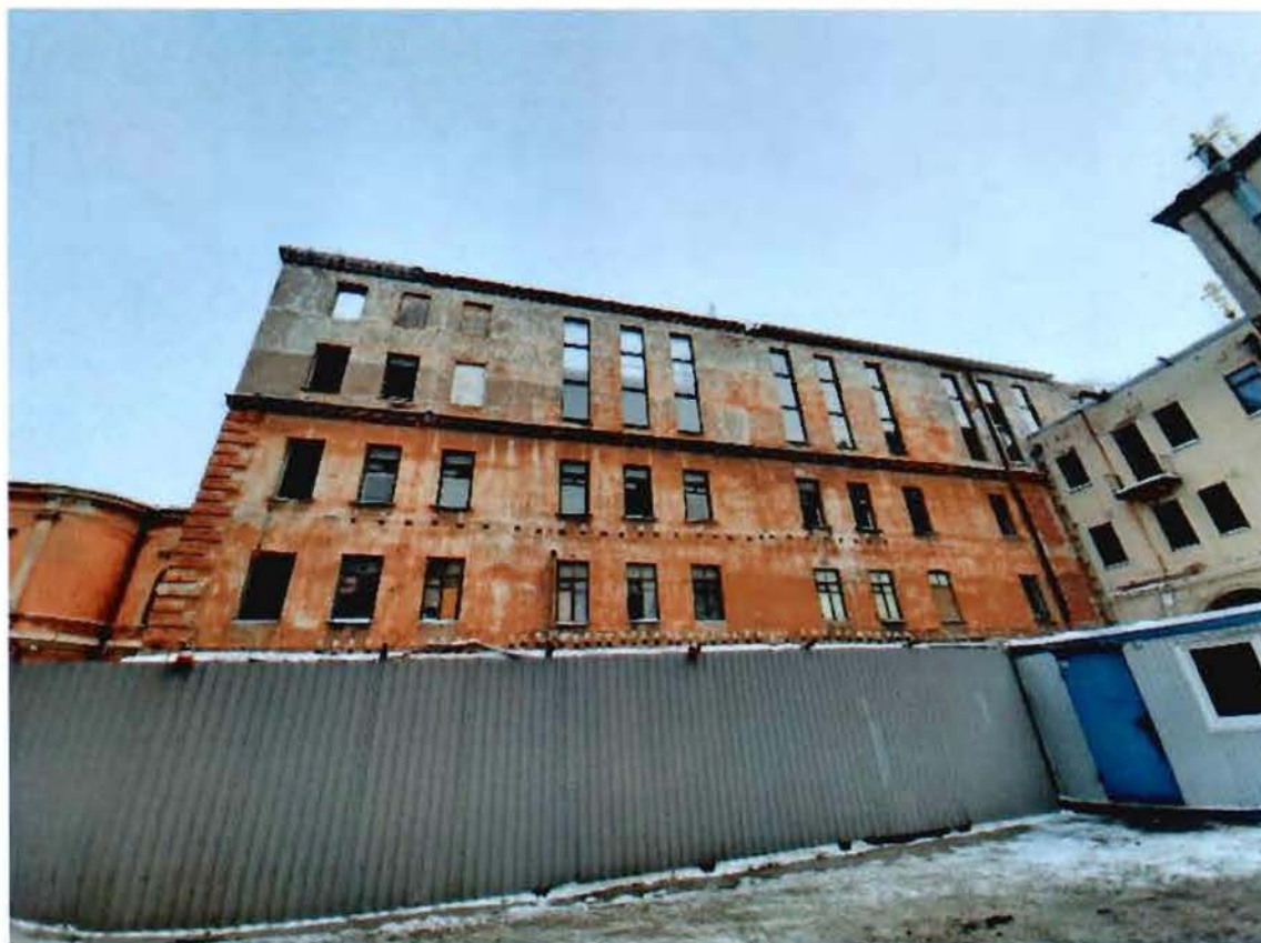
3. Вид на южный фасад объекта культурного наследия
