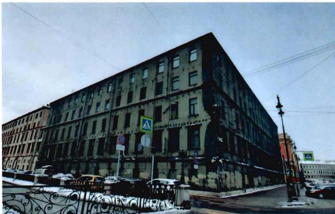
1. Общий вид на объект культурного наследия
