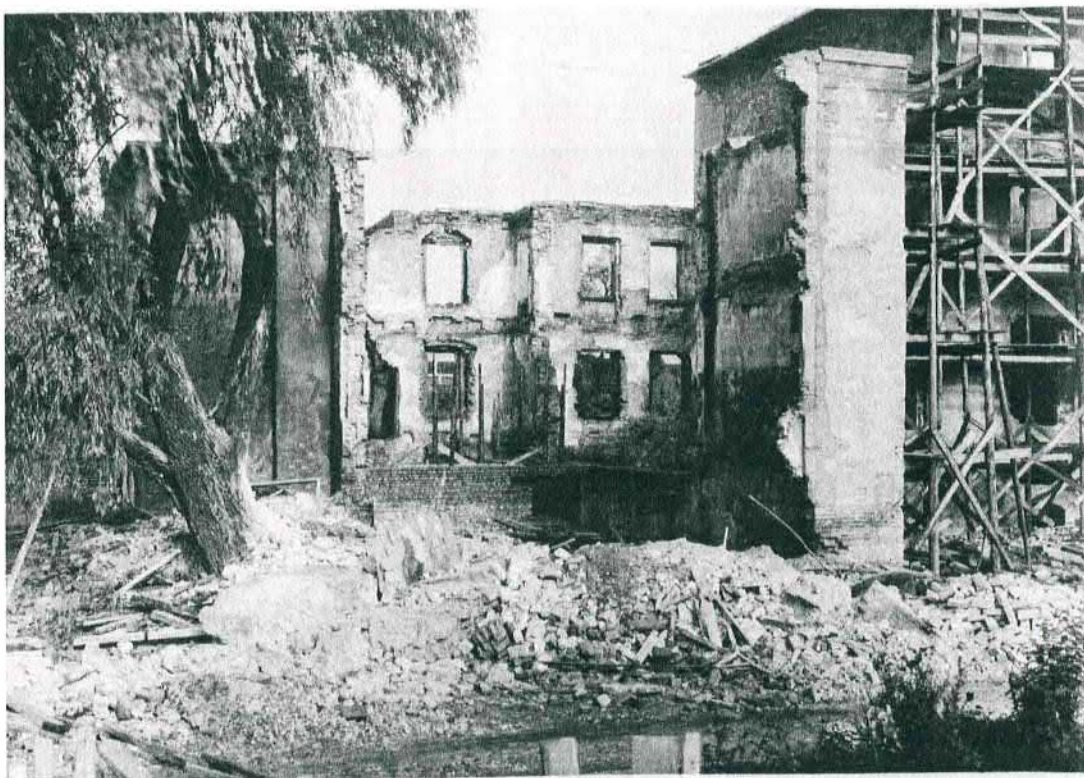
Илл. 27. После обрушения южных ризалитов. Архив КГИОП 1952 г. фото Григорьева А.К.
