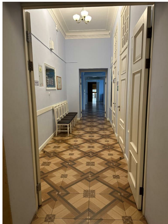
Фото 8. Коридор 1-ого этажа (Пом. 038)
