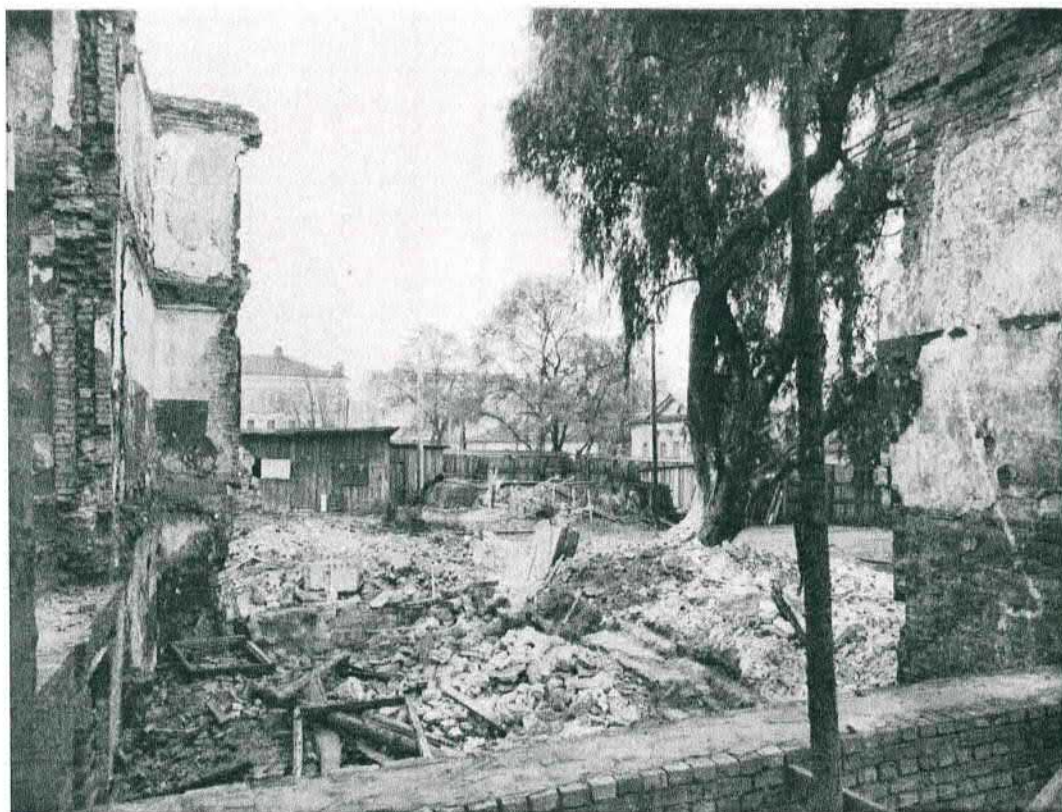
Илл. 28. После обрушения южных ризалитов. Архив КГИОП 1952 г. фото Григорьева А.К.
