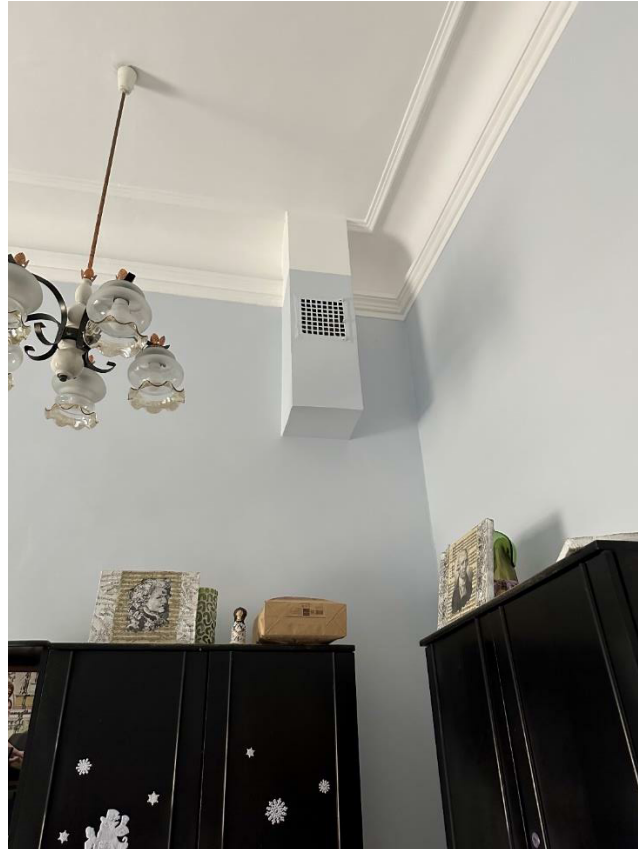
Фото 14. Вентиляционная шахта в помещении 2 этажа (Пом. 25)
