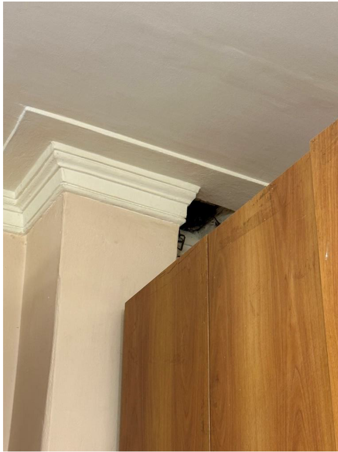
Фото 13. Вентиляционная шахта в помещении 3 этажа (Пом. 33)
