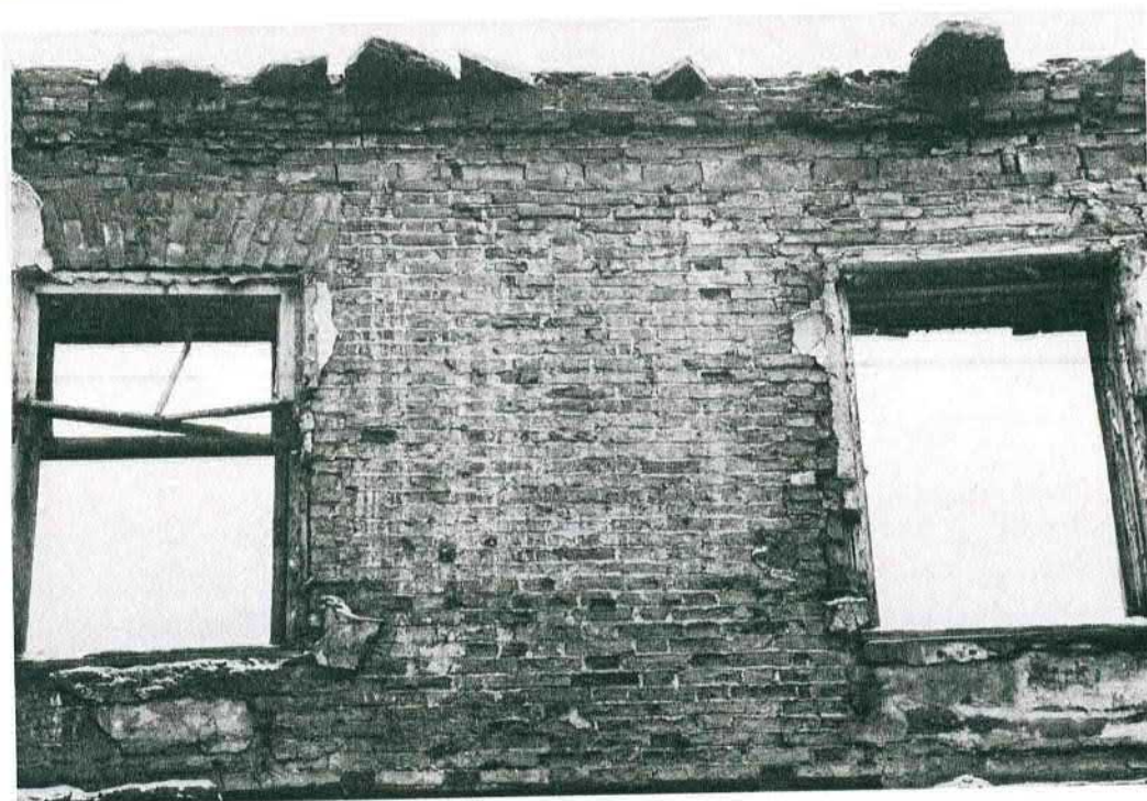
Илл. 22. 1949 г. Деталь торцевого фасада. Фото А.Н. Петрова из Исторической справки по зданию Кикиных палат
