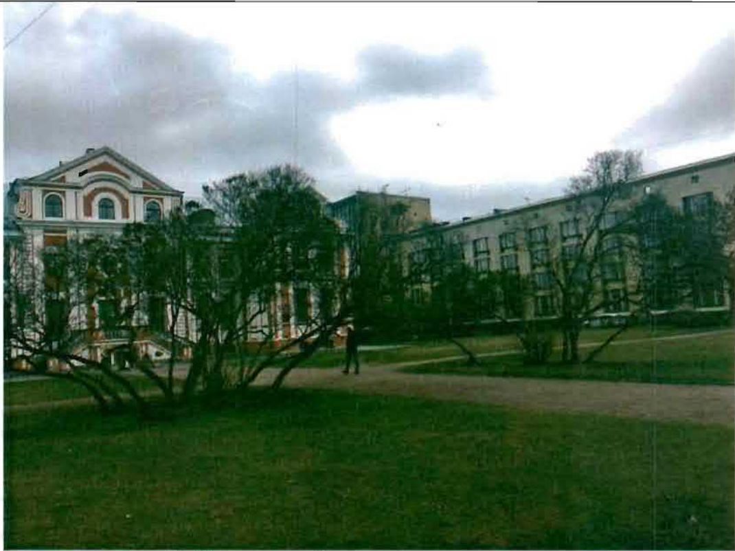
11. Территория объекта культурного наследия (вид с юго-запада)
