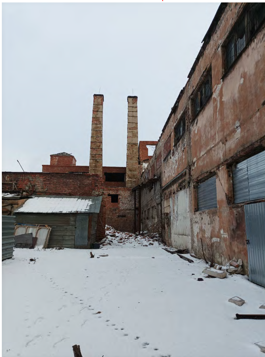
2. Объект культурного наследия регионального значения «Ушаковские бани «Гигант», по адресу: Санкт-Петербург, ул. Зои Космодемьянской, дом 7, литера А. Дворовый фасад. Дата съемки: 01.03.2023г.
