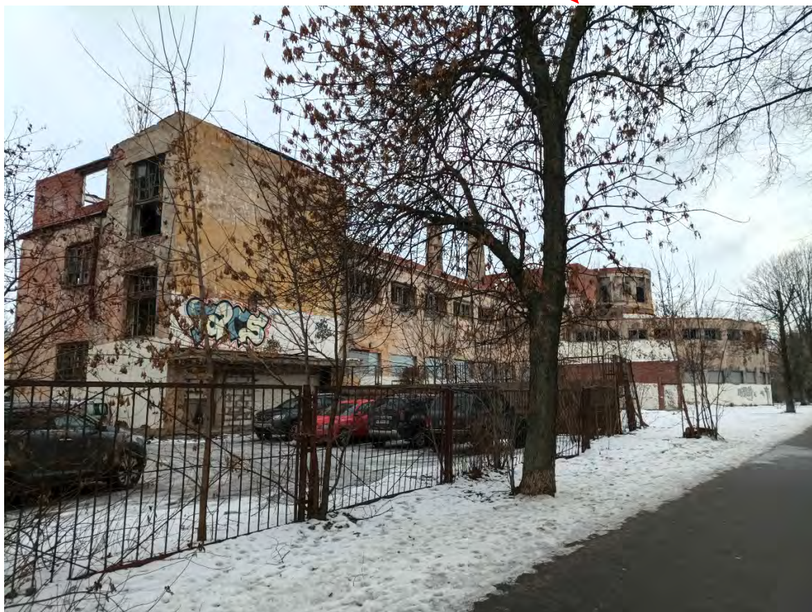
5. Объект культурного наследия регионального значения «Ушаковские бани «Гигант», по адресу: Санкт-Петербург, ул. Зои Космодемьянской, дом 7, литера А. Восточный фасад. Дата съемки: 01.03.2023г.
