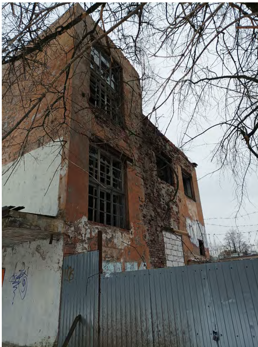
12. Объект культурного наследия регионального значения «Ушаковские бани «Гигант», по адресу: Санкт-Петербург, ул. Зои Космодемьянской, дом 7, литера А. Фрагмент западного фасада. Дата съемки: 01.03.2023г.
