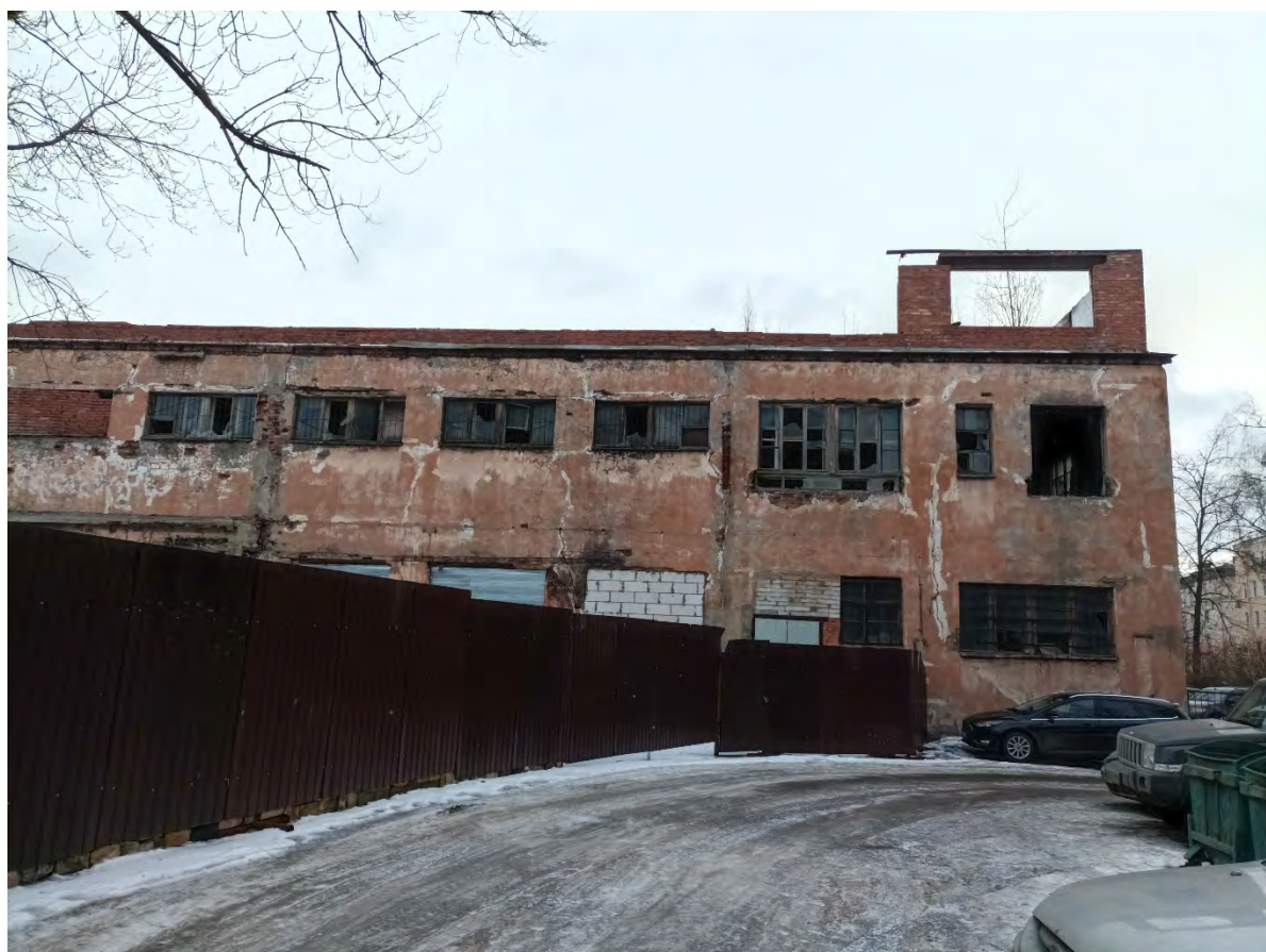
3. Объект культурного наследия регионального значения «Ушаковские бани «Гигант», по адресу: Санкт-Петербург, ул. Зои Космодемьянской, дом 7, литера А. Дворовый фасад. Дата съемки: 01.03.2023г.
