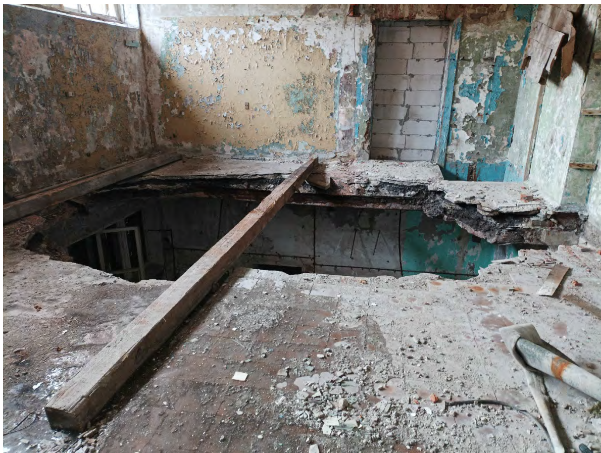
27. Объект культурного наследия регионального значения «Ушаковские бани «Гигант», по адресу: Санкт-Петербург, ул. Зои Космодемьянской, дом 7, литера А. Фрагмент перекрытий первого этажа. Дата съемки: 01.03.2023г.
