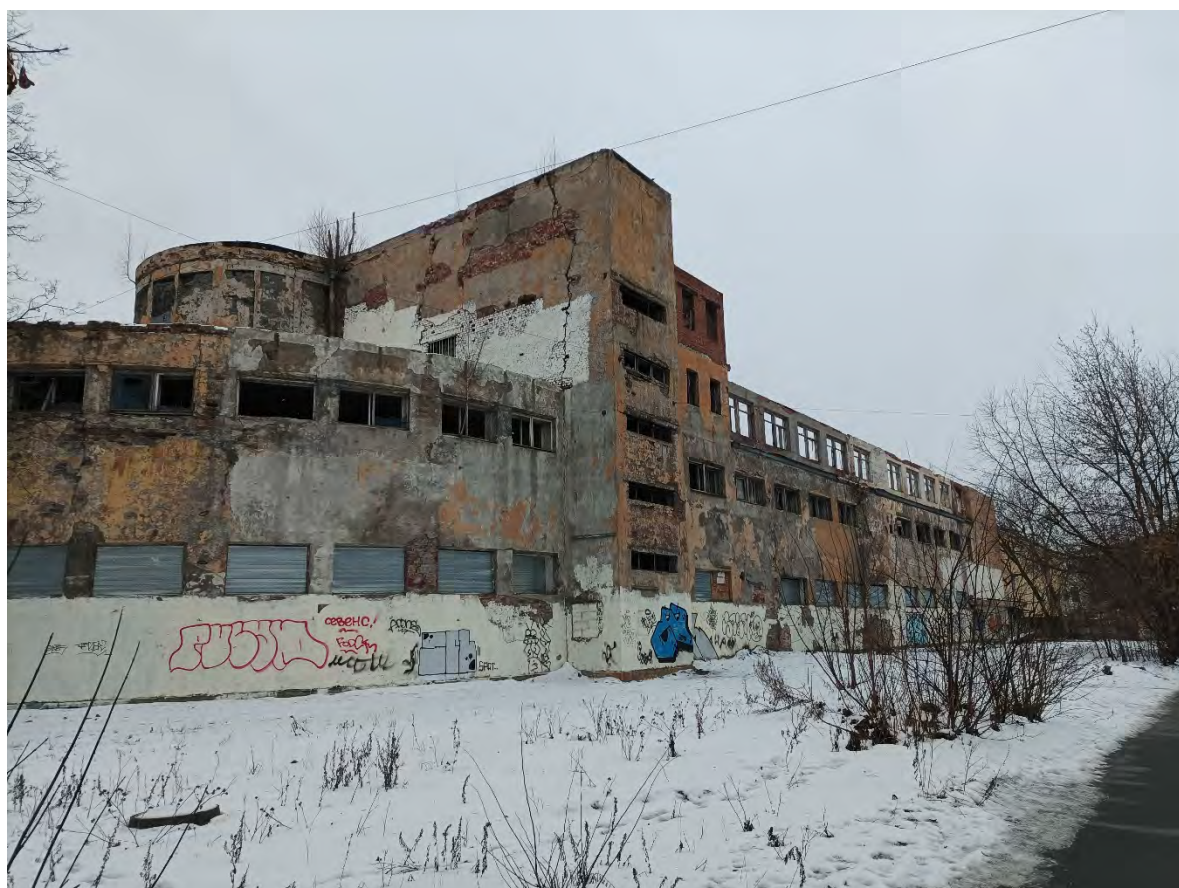
9. Объект культурного наследия регионального значения «Ушаковские бани «Гигант», по адресу: Санкт-Петербург, ул. Зои Космодемьянской, дом 7, литера А. Северный фасад. Дата съемки: 01.03.2023г.
