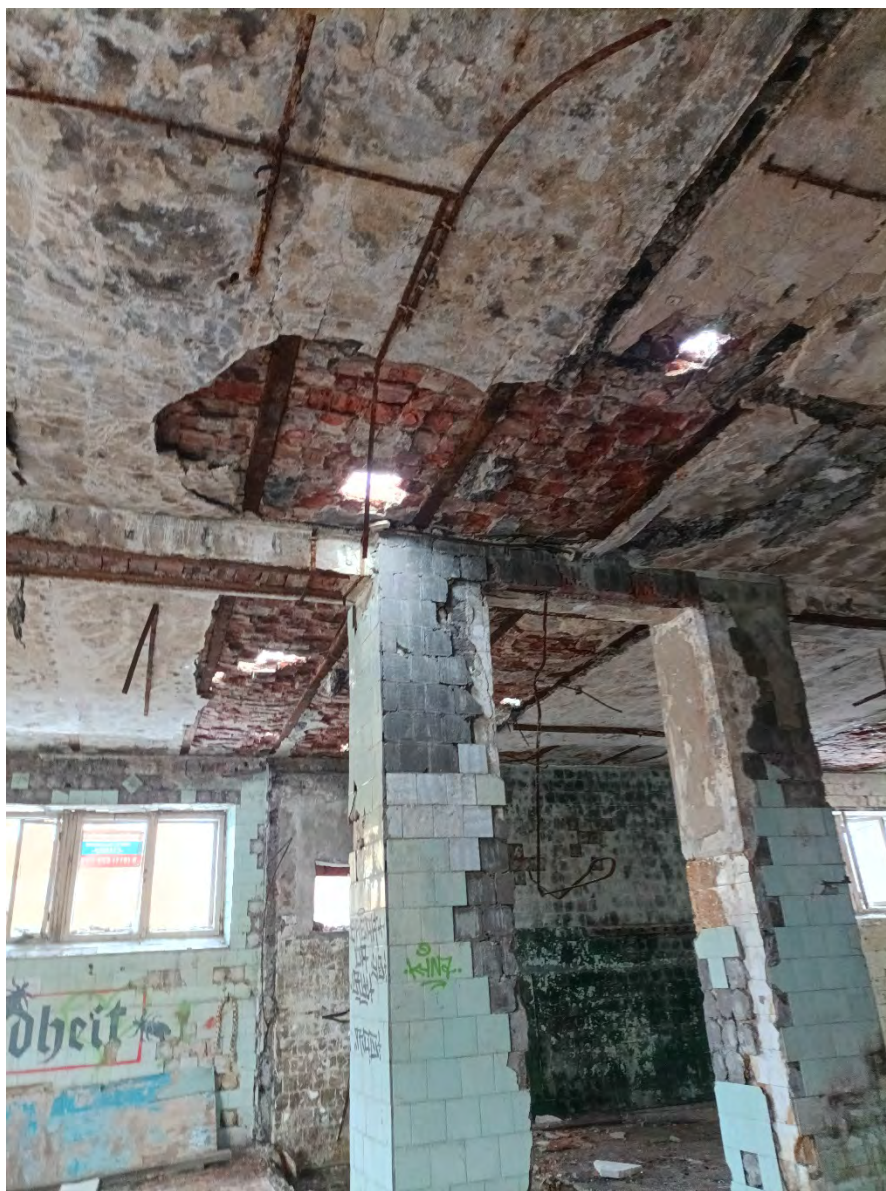
25. Объект культурного наследия регионального значения «Ушаковские бани «Гигант», по адресу: Санкт-Петербург, ул. Зои Космодемьянской, дом 7, литера А. Фрагмент помещения второго этажа. Дата съемки: 01.03.2023г.
