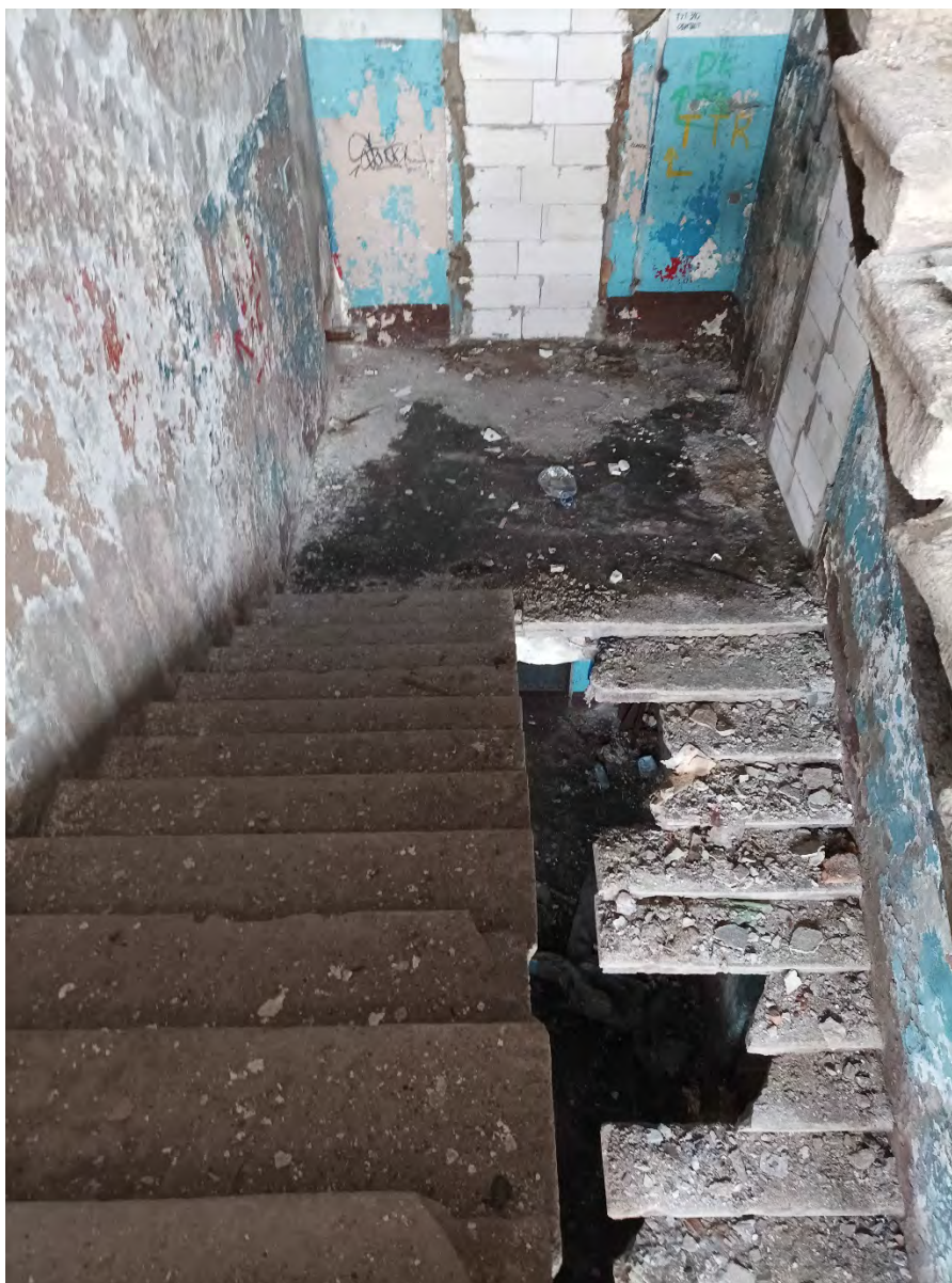
19. Объект культурного наследия регионального значения «Ушаковские бани «Гигант», по адресу: Санкт-Петербург, ул. Зои Космодемьянской, дом 7, литера А. Фрагмент лестницы в северной части объекта. Дата съемки: 01.03.2023г.
